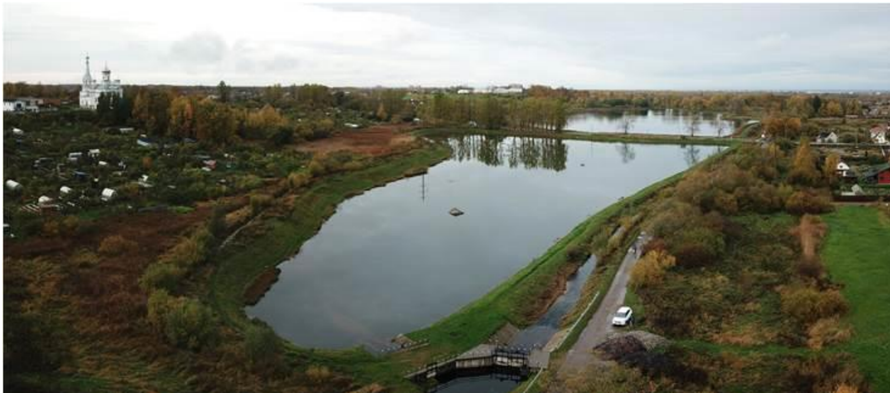
Фото 1. Объект культурного наследия федерального значения «Парк Луговой (Озерковый)», начало XVIII - XX вв., по адресу: Санкт-Петербург, город Петергоф, между линией Балтийской железной дороги и Шинкарским прудом. Аэрофотосъемка объектов культурного наследия в северном направлении в районе деревни Низино. Вид на Старопетергофский канал и Церковный пруд. Октябрь 2020 года. Автор фотографии: Лащенко А.А.
