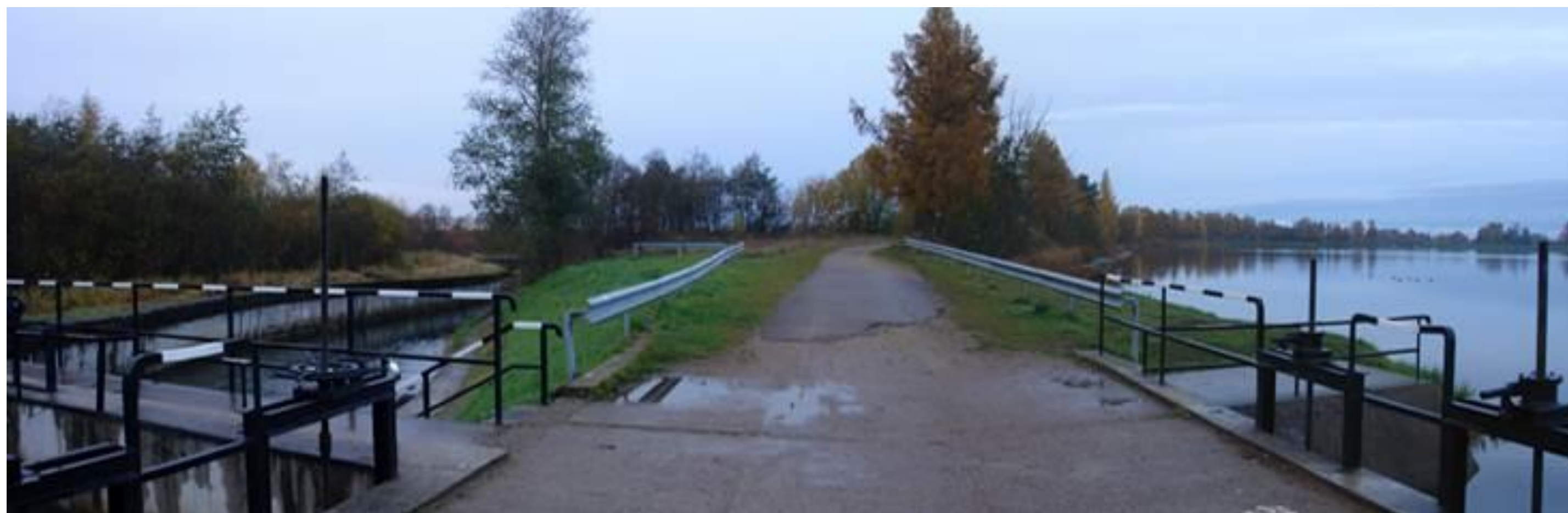
Фото 7. Объект культурного наследия федерального значения «Водоподводящая система Петергофа», 1720-1721 гг., 2-я пол. XVIII в., 1944-1948 гг., 1970-е гг. (реставрация), по адресу: г. Санкт-Петербург, город Петергоф, Ленинградская область, Ломоносовский район. Общий вид аллеи в юго-восточном направлении между рекой Шингарка и Шинкарским прудом. Октябрь 2020 года. Автор фотографии: Лащенко А.А.
