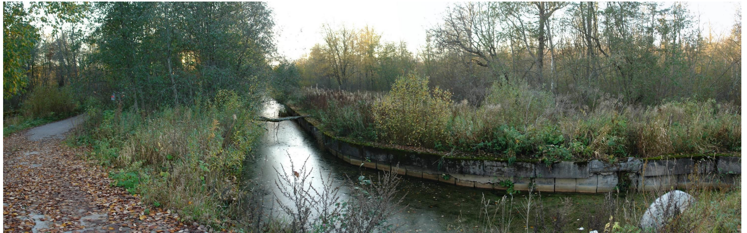
Фото 15. Объект культурного наследия федерального значения «Водоподводящая система Петергофа», 1720-1721 гг., 2-я пол. XVIII в., 1944-1948 гг., 1970-е гг. (реставрация), по адресу: г. Санкт-Петербург, город Петергоф, Ленинградская область, Ломоносовский район. Общий вид Новопетергофского канала в юго-западном направлении. Октябрь 2020 года. Автор фотографии: Лашенко А.А.
