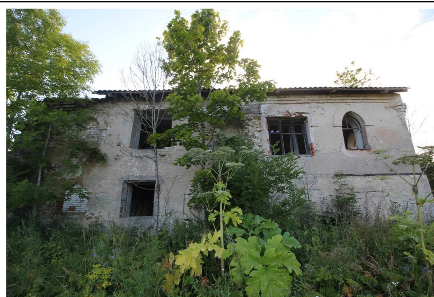
Фото 55. Объект культурного наследия регионального значения «Мыза Лапинская: господский дом, гостевой флигель, хозяйственная постройка дворового каре, фрагмент ограды дворового каре, южная ограда переднего въезда во дворовое каре, плодовый усадебный сад 5 га, природный ландшафт, оформленный при усадебном строительстве (склон ложбины и шлейф глинта, посадки декоративного кустарника, аллеи, руины мельницы на роднике 40 га)», по адресу: Ленинградская область, Ломоносовский муниципальный район, д. Вильповицы. Общий вид объекта культурного наследия «Хозяйственная постройка дворового каре» в западном направлении. Двухскатная крыша. Сложнопрофилированный венчающий карниз с углами, выложенными бутовым камнем. Оформление оконных проемов: резьба в виде стрельчатых полуналичников. Август 2020 года. Автор фотографии: Союров И.В.
