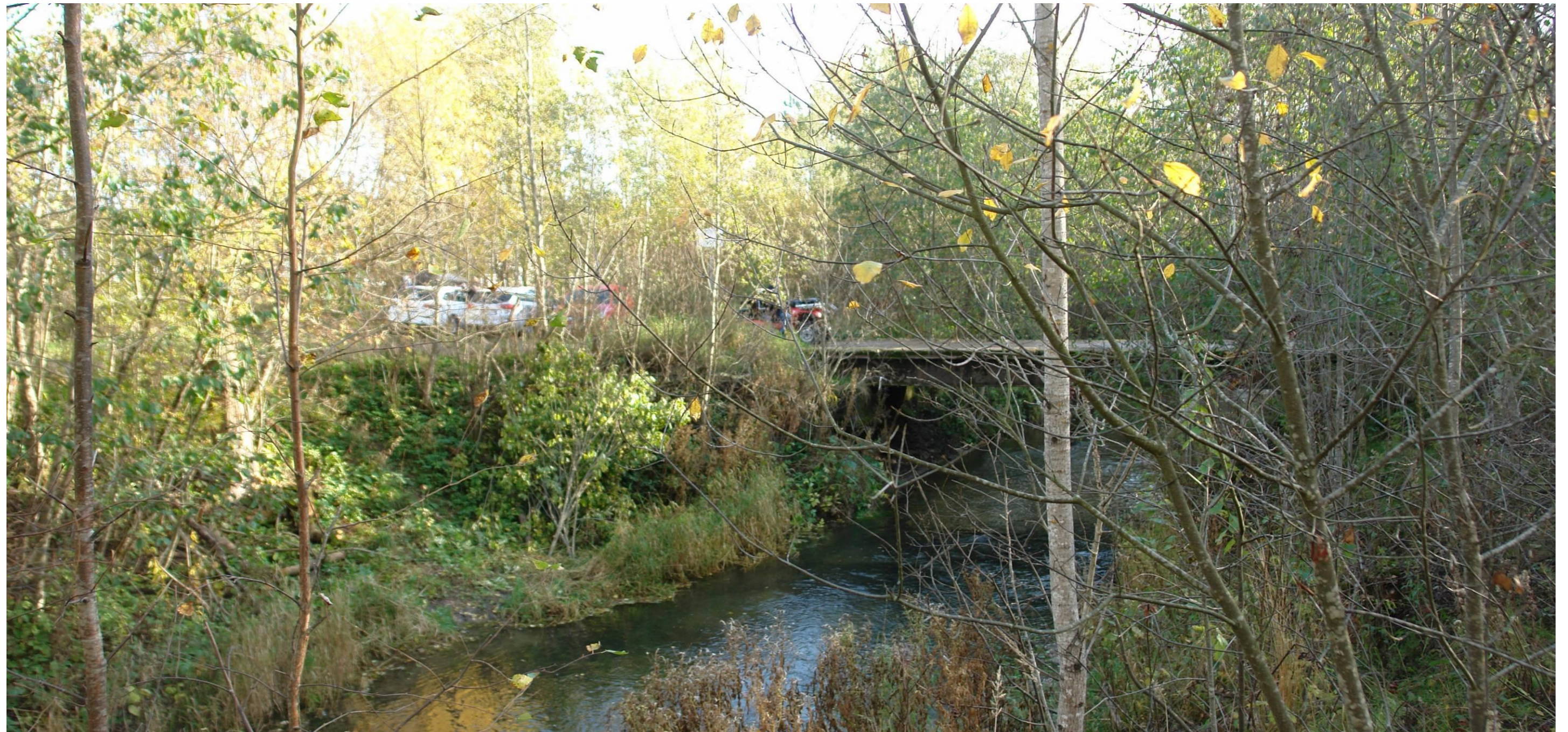
Фото 12. Объект культурного наследия федерального значения «Водоподводящая система Петергофа», 1720-1721 гг., 2-я пол. XVIII в., 1944-1948 гг., 1970-е гг. (реставрация), по адресу: г. Санкт-Петербург, город Петергоф, Ленинградская область, Ломоносовский район. Общий вид реки Шингарка в южном направлении в районе деревни Узигонты. Октябрь 2020 года. Автор фотографии: Лашенко А.А.
