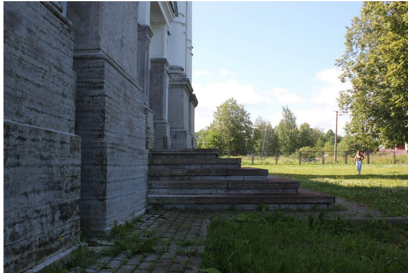
Фото 30. Объект культурного наследия регионального значения «Церковь Александры», 1854 г., по адресу: Ленинградская область, МО Ломоносовский муниципальный район, МО Низинское сельское поселение, д. Низино, ул. Центральная, д. 59. Общий вид объекта культурного наследия в западном направлении. Ярусное оформление цокольной части здания. Отмостка из брусчатки. Август 2020 года. Автор фотографии: Союров И.В.
