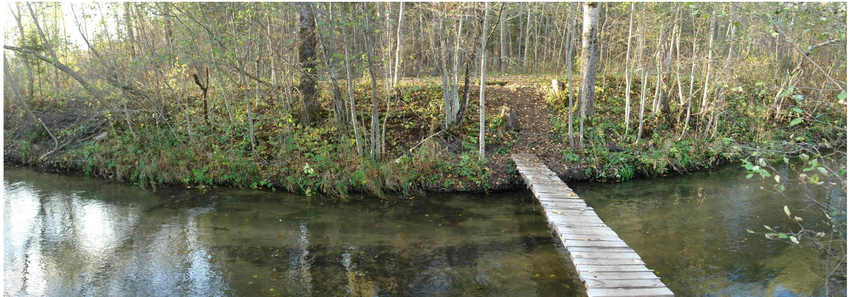
Фото 13. Объект культурного наследия федерального значения «Водоподводящая система Петергофа», 1720-1721 гг., 2-я пол. XVIII в., 1944-1948 гг., 1970-е гг. (реставрация), по адресу: г. Санкт-Петербург, город Петергоф, Ленинградская область, Ломоносовский район. Общий вид реки Шингарка в западном направлении в районе Зеленой Долины. Октябрь 2020 года. Автор фотографии: Лашенко А.А.
