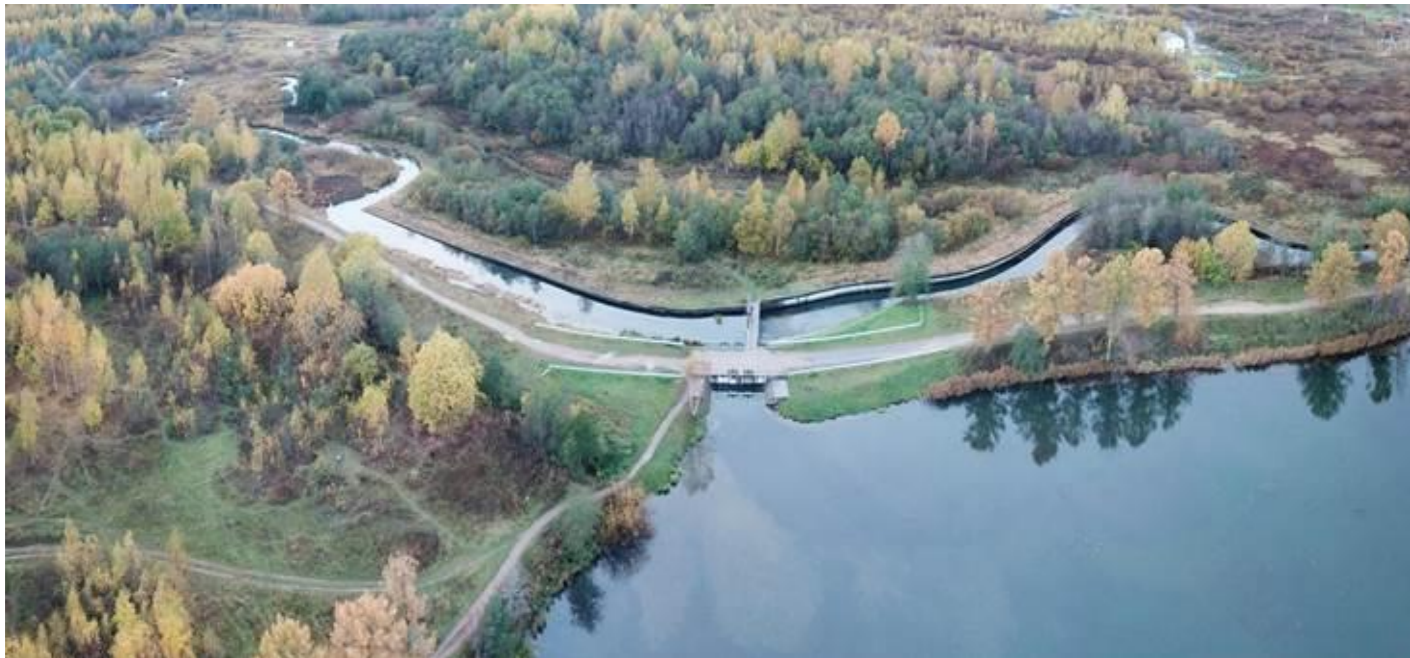
Фото 6. Объект культурного наследия федерального значения «Водоподводящая система Петергофа», 1720-1721 гг., 2-я пол. XVIII в., 1944-1948 гг., 1970-е гг. (реставрация), по адресу: г. Санкт-Петербург, город Петергоф, Ленинградская область, Ломоносовский район. Аэрофотосъемка объектов культурного наследия в восточном направлении в районе деревни Возрождение. Вид на шлюз Шинкарского пруда, Старопетергофского канала и реки Шингарка. Октябрь 2020 года. Автор фотографии: Лащенко А.А.
