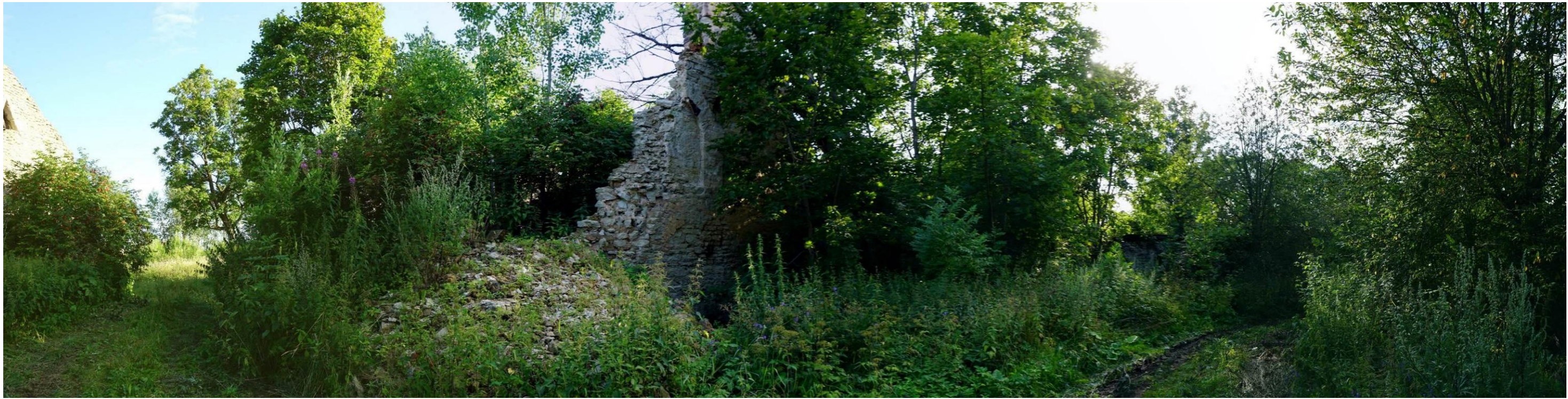
Фото 86. Объект культурного наследия регионального значения «Мыза Лапинская: господский дом, гостевой флигель, хозяйственная постройка дворового каре, фрагмент ограды дворового каре, южная ограда переднего въезда во дворовое каре, плодовый усадебный сад 5 га, природный ландшафт, оформленный при усадебном строительстве (склон ложбины и шлейф глинта, посадки декоративного кустарника, аллеи, руины мельницы на роднике 40 га)», по адресу: Ленинградская область, Ломоносовский муниципальный район, д. Вильповицы. Общий вид объекта культурного наследия «Молочный дом с коровником» и «Скотный двор» в юго-западном восточном направлении. Оконный проем треугольной формы. Август 2020 года. Автор фотографии: Союров И.В.
