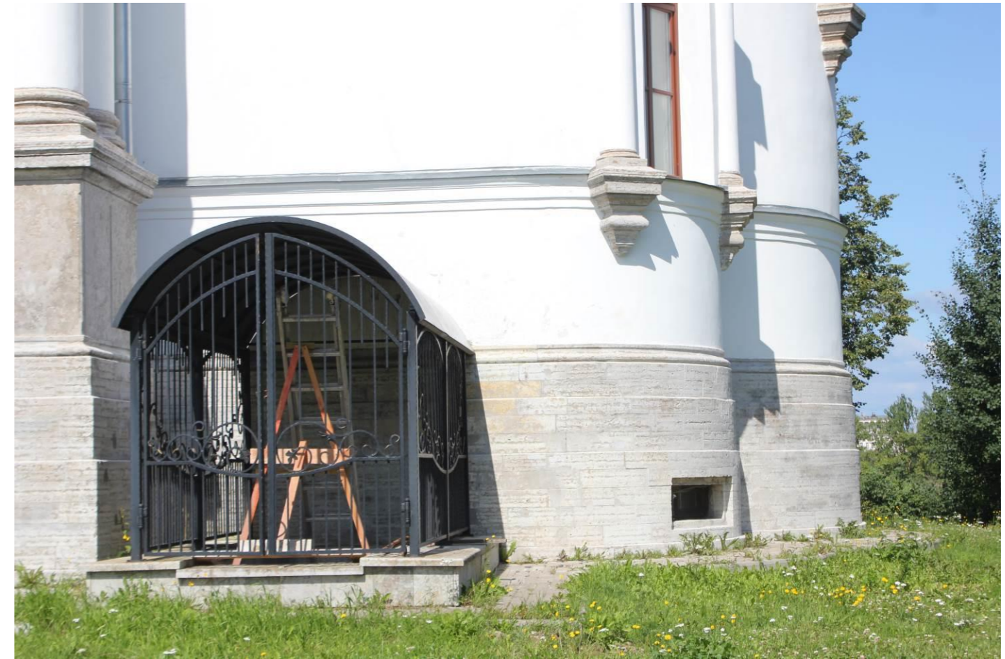
Фото 25. Объект культурного наследия регионального значения «Церковь Александры», 1854 г., по адресу: Ленинградская область, МО Ломоносовский муниципальный район, МО Низинское сельское поселение, д. Низино, ул. Центральная, д. 59. Фрагмент объекта культурного наследия в северном направлении. Гурт. Оконные проемы в цокольной части. Приставные колонны на постаментах. Металлический вход с полукруглым козырьком в цоколь. Август 2020 года. Автор фотографии: Союров И.В.
