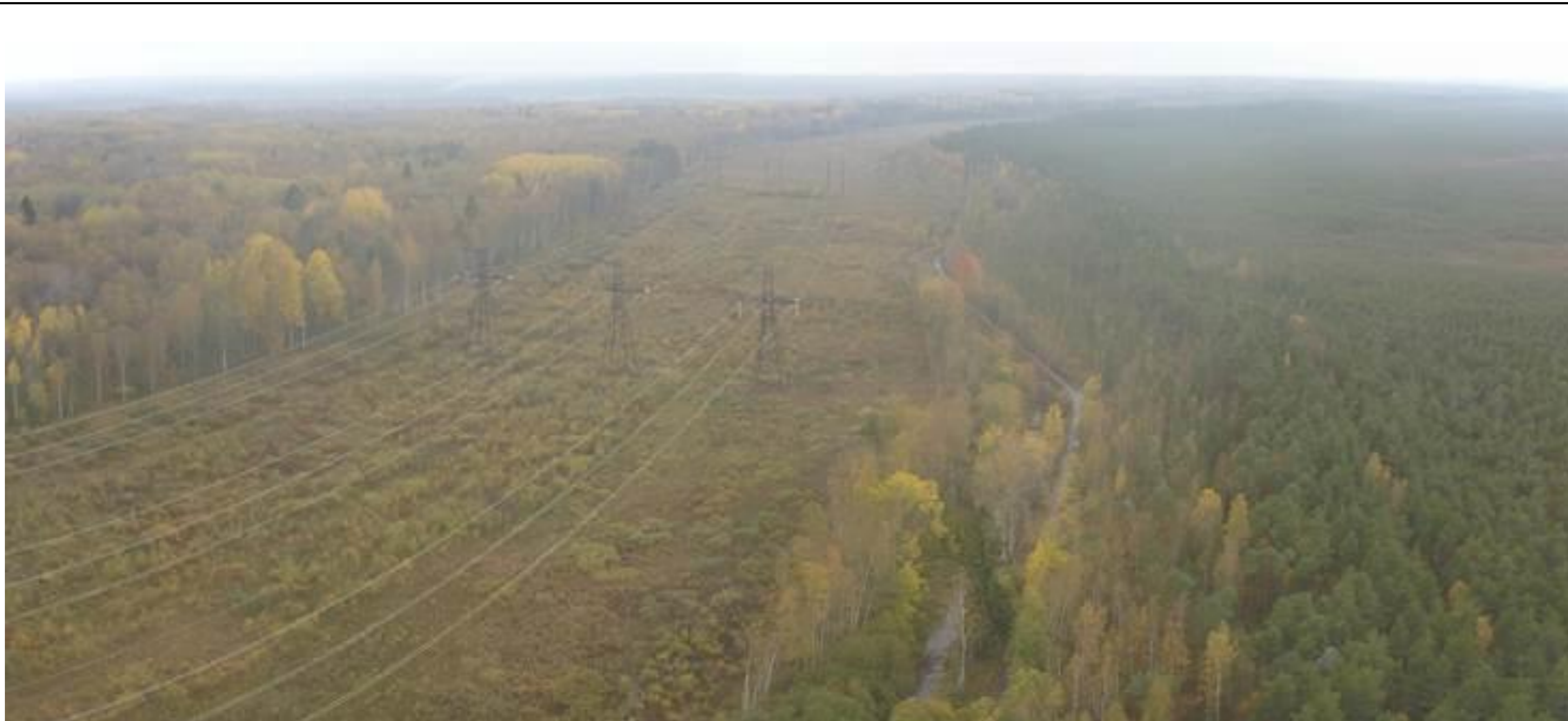
Фото 1. Объект культурного наследия федерального значения «Водопроводящая система Петергофа», 1720-1721 гг., 2-я пол. XVIII в., 1944-1948 гг., 1970-е гг. (реставрация), по адресу г. Санкт-Петербург, город Петергоф, Ленинградская область, Ломоносовский район. Аэрофотосъемка объектов культурного наследия в северо-западном направлении в районе деревни Новая Ропша. Вид на Новопетергофский канал. Октябрь 2020 года. Автор фотографии: Лащенко А.А.
