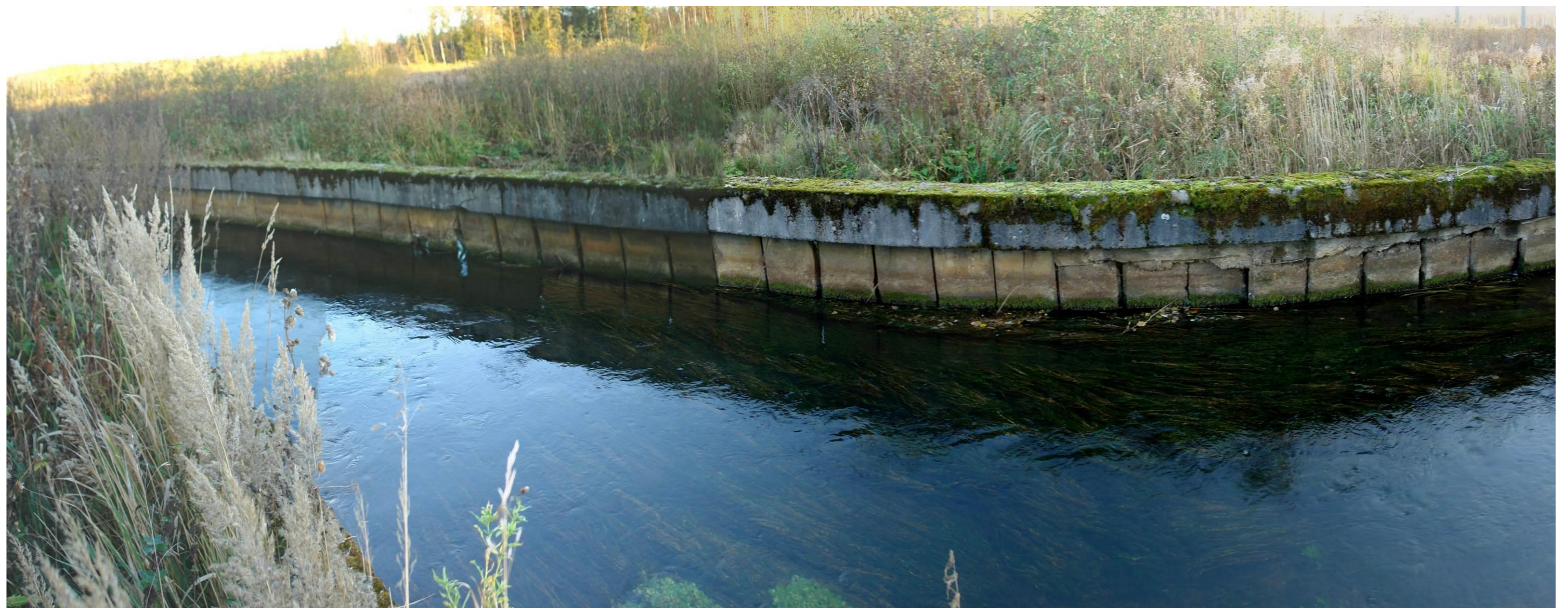
Фото 14. Объект культурного наследия федерального значения «Водоподводящая система Петергофа», 1720-1721 гг., 2-я пол. XVIII в., 1944-1948 гг., 1970-е гг. (реставрация), по адресу: г. Санкт-Петербург, город Петергоф, Ленинградская область, Ломоносовский район. Общий вид реки Шингарка в северо-западном направлении. Октябрь 2020 года. Автор фотографии: Лашенко А.А.
