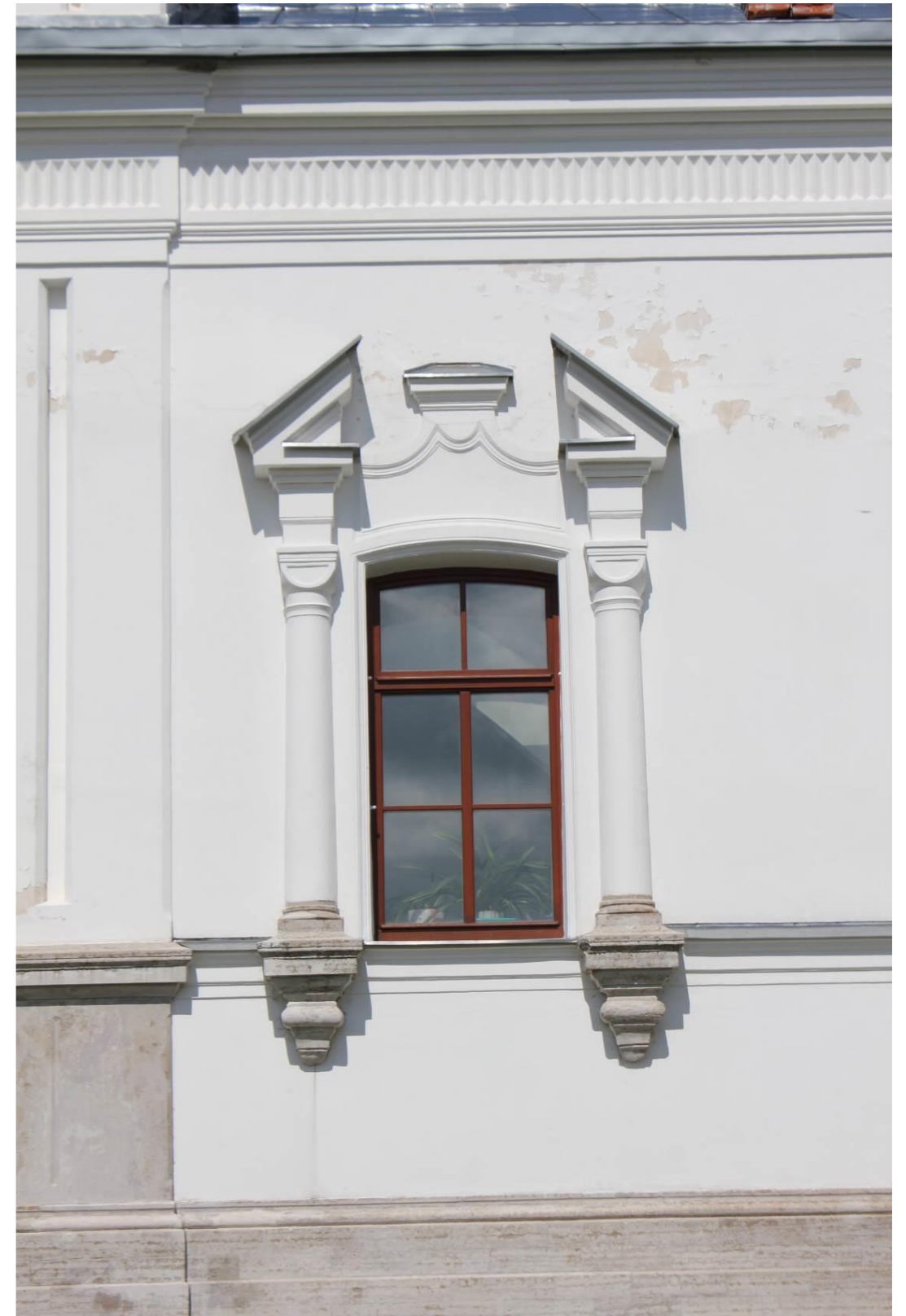
Фото 21. Объект культурного наследия регионального значения «Церковь Александры», 1854 г., по адресу: Ленинградская область, МО Ломоносовский муниципальный район, МО Низинское сельское поселение, д. Низино, ул. Центральная, д. 59. Фрагмент объекта культурного наследия в северном направлении. Оконный проем с наличником. Приставные колонны. Разорванный фронтон. Пилястра на постаменте. Август 2020 года. Автор фотографии: Союров И.В.
