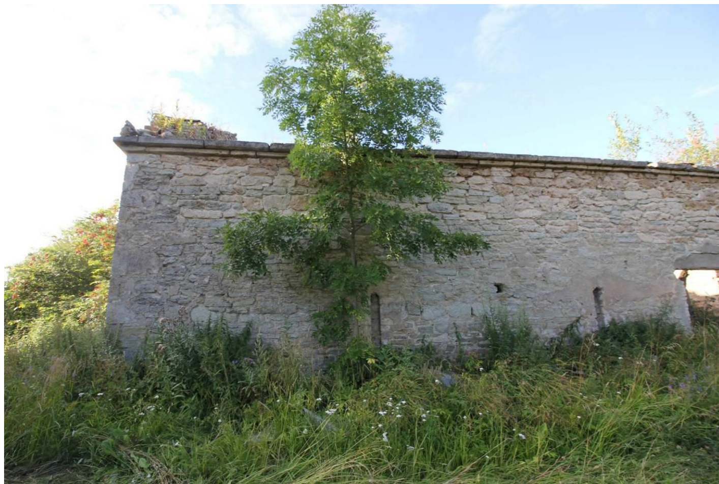
Фото 62. Объект культурного наследия регионального значения «Мыза Лапинская: господский дом, гостевой флигель, хозяйственная постройка дворового каре, фрагмент ограды дворового каре, южная ограда переднего въезда во дворовое каре, плодовый усадебный сад 5 га, природный ландшафт, оформленный при усадебном строительстве (склон ложбины и шлейф глинта, посадки декоративного кустарника, аллеи, руины мельницы на роднике 40 га)», по адресу: Ленинградская область, Ломоносовский муниципальный район, д. Вильповицы. Общий вид объекта культурного наследия «Скотный двор» в северном направлении. Двухскатная крыша. Профилированный венчающий карниз. Щелевидный оконный проем. Август 2020 года. Автор фотографии: Союров И.В.
