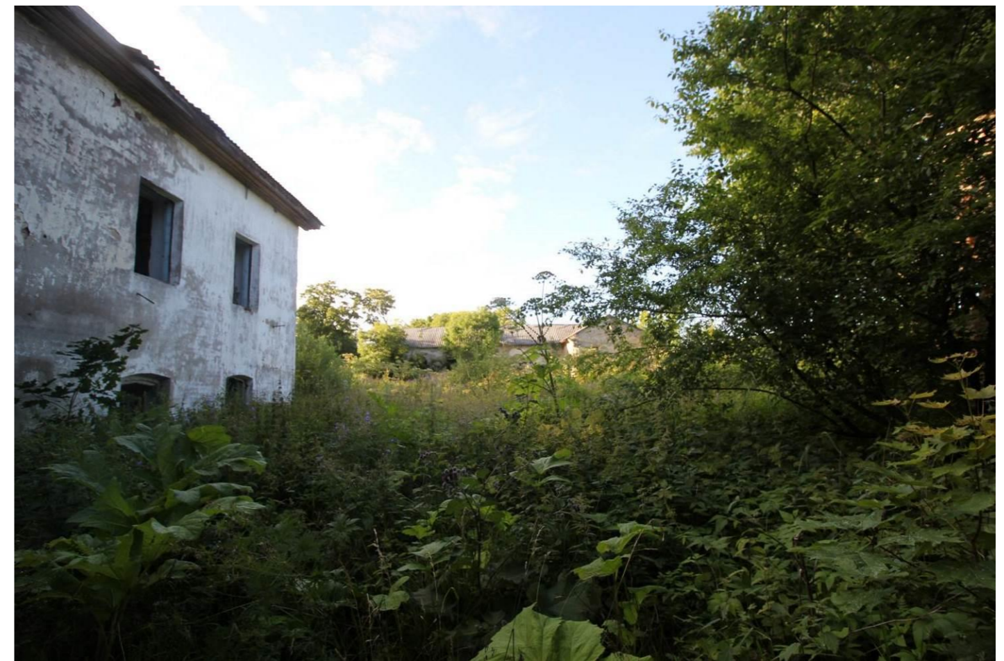
Фото 41. Объект культурного наследия регионального значения «Мыза Лапинская: господский дом, гостевой флигель, хозяйственная постройка дворового каре, фрагмент ограды дворового каре, южная ограда переднего въезда во дворовое каре, плодовый усадебный сад 5 га, природный ландшафт, оформленный при усадебном строительстве (склон ложбины и шлейф глинта, посадки декоративного кустарника, аллеи, руины мельницы на роднике 40 га)», по адресу: Ленинградская область, Ломоносовский муниципальный район, д. Вильповицы. Фрагмент объекта культурного наследия «Флигель» в северо-западном направлении. Двухскатная крыша. Оконные проемы с лучковыми перемычками и кирпичными откосами. Август 2020 года. Автор фотографии: Союров И.В.
