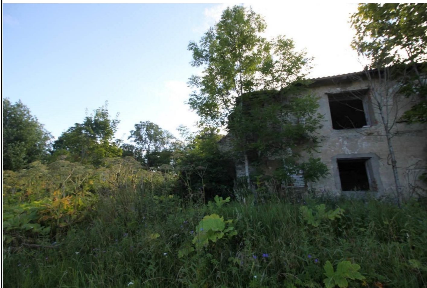
Фото 58. Объект культурного наследия регионального значения «Мыза Лапинская: господский дом, гостевой флигель, хозяйственная постройка дворового каре, фрагмент ограды дворового каре, южная ограда переднего въезда во дворовое каре, плодовый усадебный сад 5 га, природный ландшафт, оформленный при усадебном строительстве (склон ложбины и шлейф глинта, посадки декоративного кустарника, аллеи, руины мельницы на роднике 40 га)», по адресу: Ленинградская область, Ломоносовский муниципальный район, д. Вильповицы. Общий вид объекта культурного наследия «Хозяйственная постройка дворового каре» в западном направлении. Двухскатная крыша. Сложнопрофилированный венчающий карниз с углами, выложенными бутовым камнем. Оформление оконных проемов: резьба в виде стрельчатых полуналичников. Август 2020 года. Автор фотографии: Союров И.В.
