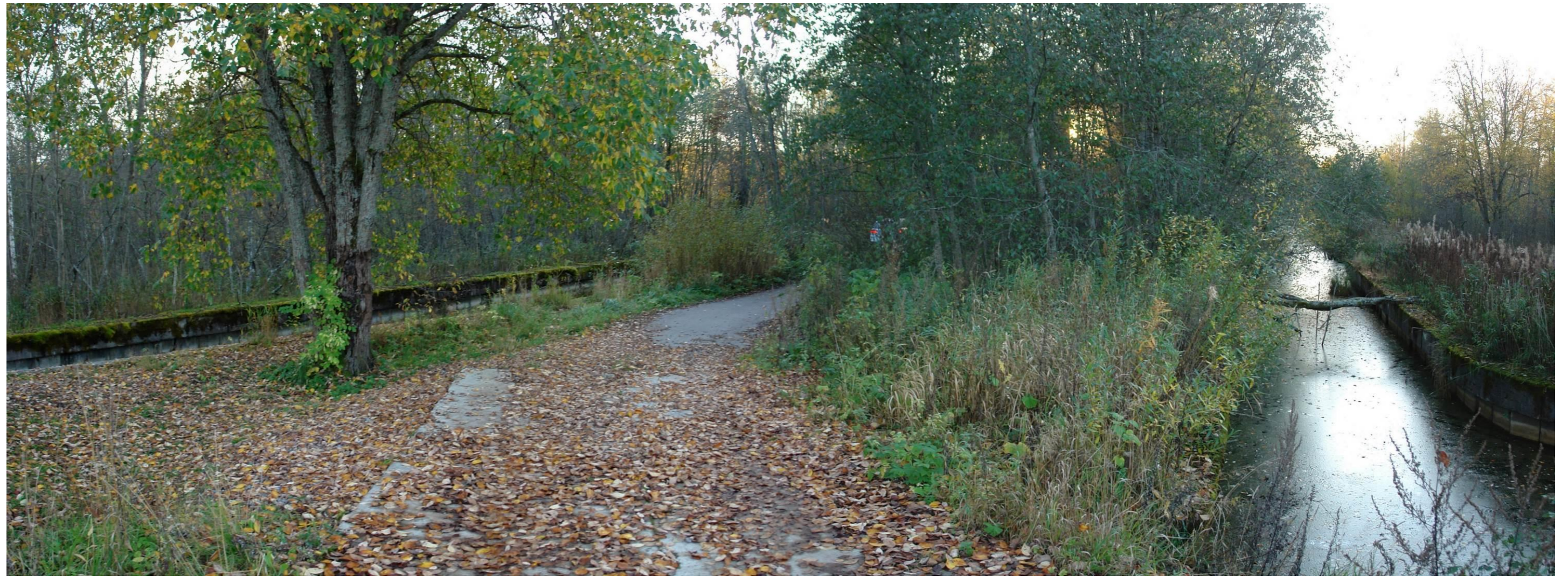
Фото 16. Объект культурного наследия федерального значения «Водоподводящая система Петергофа», 1720-1721 гг., 2-я пол. XVIII в., 1944-1948 гг., 1970-е гг. (реставрация), по адресу: г. Санкт-Петербург, город Петергоф, Ленинградская область, Ломоносовский район. Общий вид местности между рекой Шингарка и Новопетергофским каналом в юго-западном направлении. Октябрь 2020 года. Автор фотографии: Лащенко А.А.
