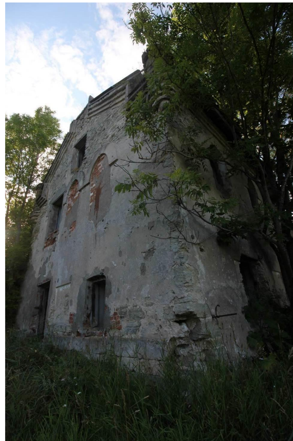
Фото 14. Объект культурного наследия регионального значения «Мыза Лапинская: господский дом, гостевой флигель, хозяйственная постройка дворового каре, фрагмент ограды дворового каре, южная ограда переднего въезда во дворовое каре, плодовый усадебный сад 5 га, природный ландшафт, оформленный при усадебном строительстве (склон ложбины и шлейф глинта, посадки декоративного кустарника, аллеи, руины мельницы на роднике 40 га)», по адресу: Ленинградская область, Ломоносовский муниципальный район, д. Вильповицы. Общий вид объекта культурного наследия «Господский дом с оградой» в северо-западном направлении. Двускатная крыша. Оконные проемы первого этажа с лучковыми перемычками. Стрельчатые оконные проемы второго этажа. Треугольный щипец. Угловые пинакли. Ступенчато-нарастающий карниз по периметру здания. Август 2020 года. Автор фотографии: Союров И.В.
