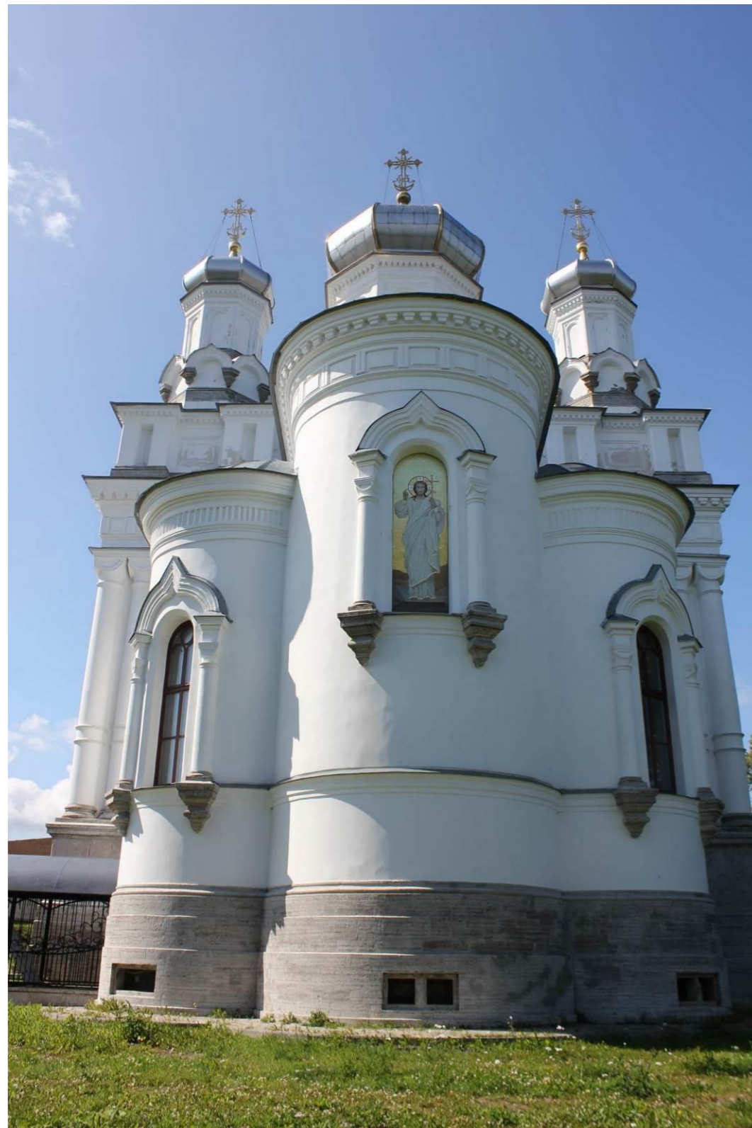
Фото 34. Объект культурного наследия регионального значения «Церковь Александры», 1854 г., по адресу: Ленинградская область, МО Ломоносовский муниципальный район, МО Низинское сельское поселение, д. Низино, ул. Центральная, д. 59. Общий вид восточного фасада объекта культурного наследия. Барабаны с закомарами, луковицами и крестами над объемом храма. Оконные проемы с лучковыми перемычками. Карниз с зубцами. Приставные колонны у окон. Гурт. Август 2020 года. Автор фотографии: Союров И.В.
