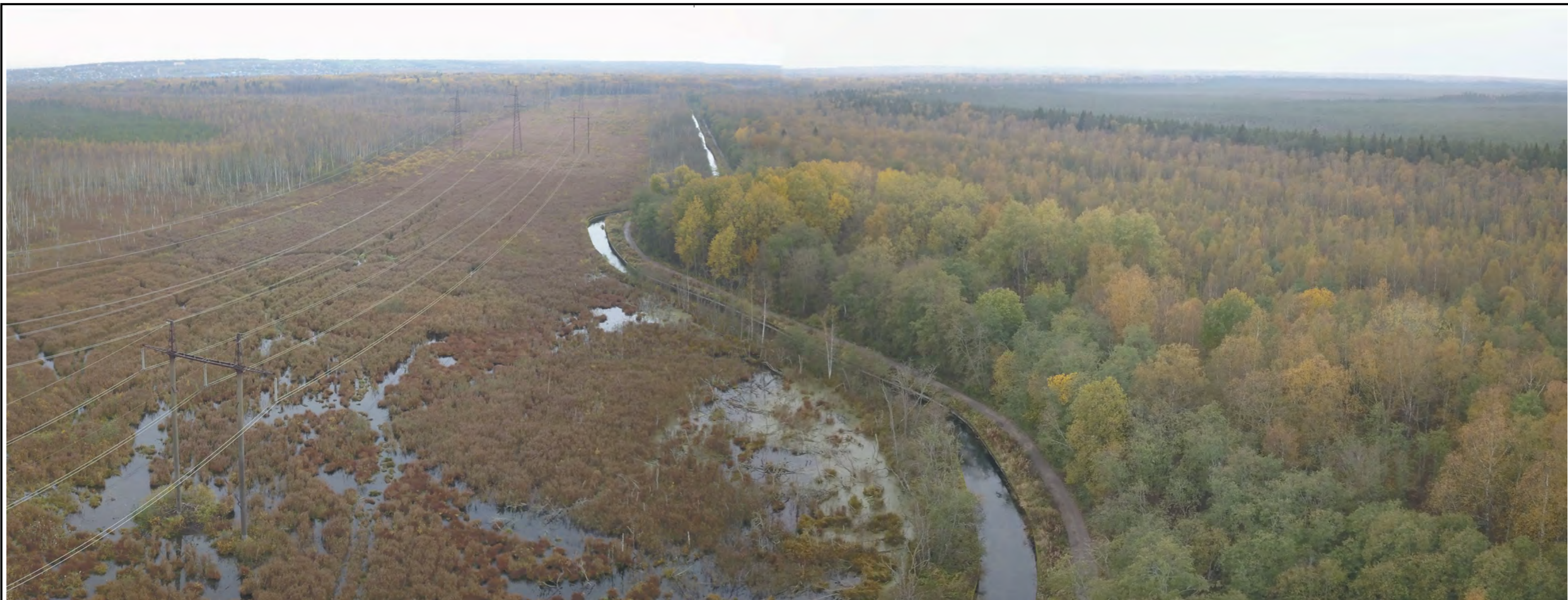
Фото 49. Аэрофотосъемка объектов культурного наследия в юго-западном направлении. Вид на канал реки Шингарка.
