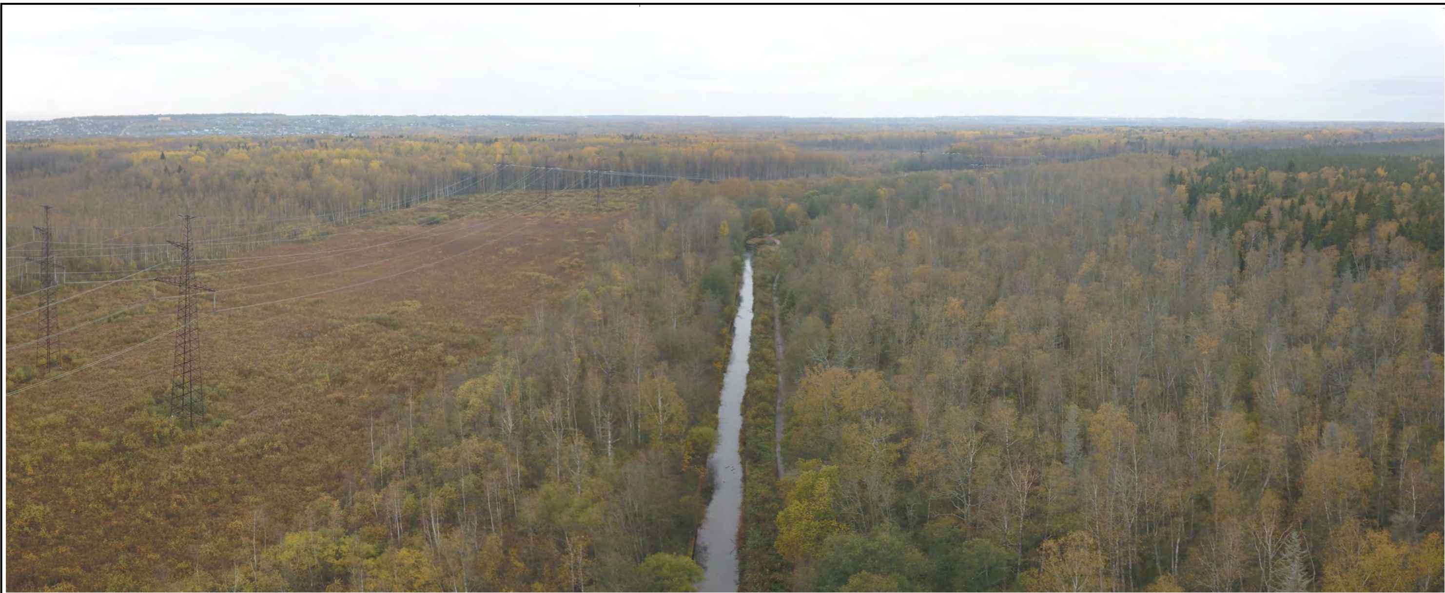
Фото 51. Аэрофотосъемка объектов культурного наследия в юго-западном направлении. Вид на канал реки Шингарка.
