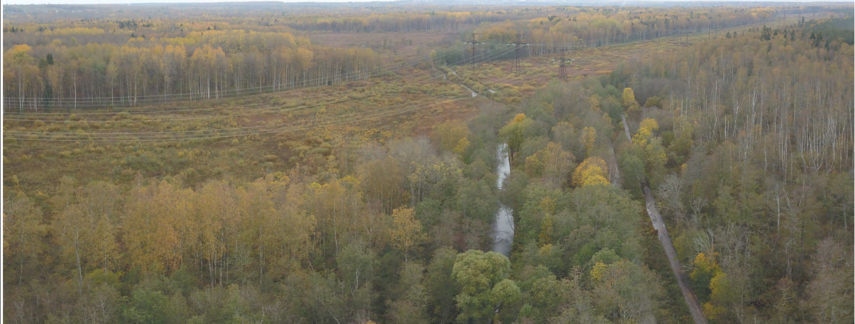
Фото 53. Аэрофотосъемка объектов культурного наследия в юго-западном направлении. Вид на канал реки Шингарка.
