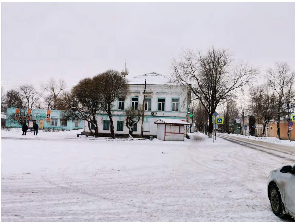
24. Лицевой и торцевой фасады «Здания городского училища, 1841 г.» пр. Карла Маркса, д. 27/10 на пересечении с ул. Пионерской. Направление съемки юго-запад.
