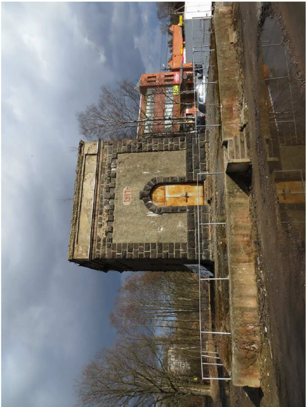
5. Западный фасад здания водонапорной башни. Фото 2016 г.
