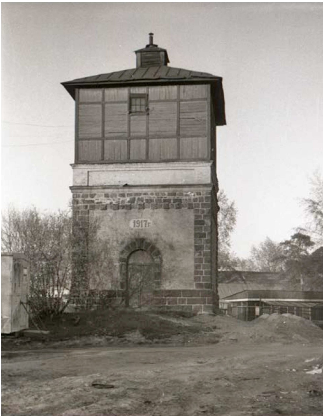
3. Водонапорная башня в Токсово. Вид до демонтажа 2-го деревянного яруса. 1987 г. (Из коллекции краеведа Д.И. Шитова).
