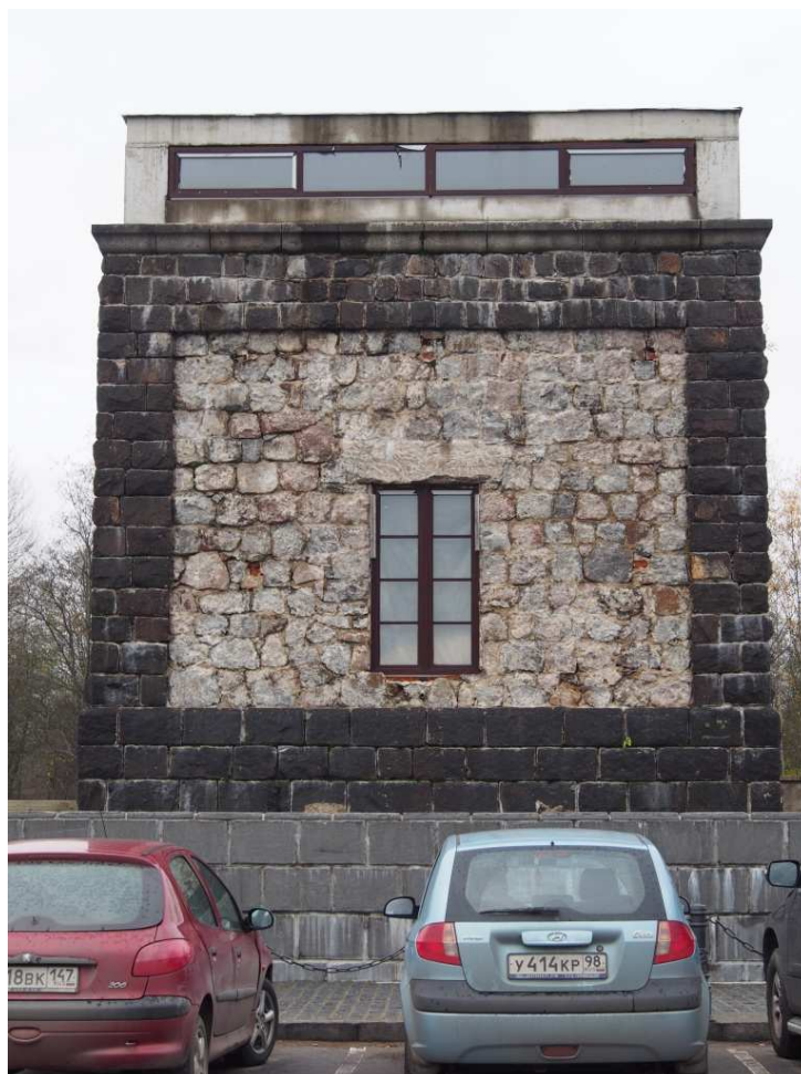
4. Объект культурного наследия регионального значения «Станционная водонапорная башня, 1917 г.» по адресу: Ленинградская область, Всеволожский район, г.п. Токсово, Привокзальная пл., д. 2Б. Южный фасад.
