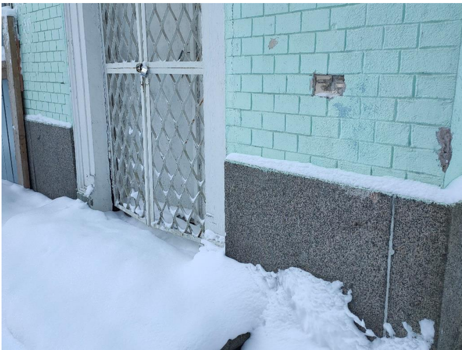
10. «Часовня над могилой графа П. П. Шувалова, 1906 г.», Ленинградская область, Всеволожский район, Агалатовское сельское поселение, д. Вартемяги, Токсовское шоссе,5. Юго-восточный фасад. Фрагмент. Фото 18.01.2021 г.
