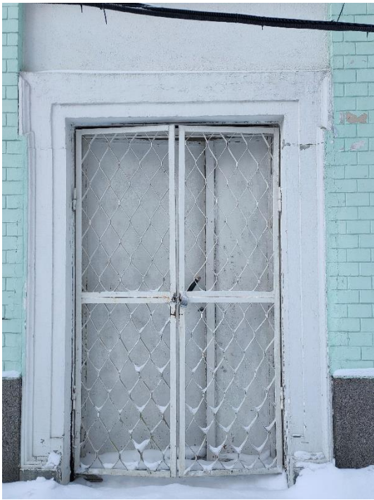
9. «Часовня над могилой графа П. П. Шувалова, 1906 г.», Ленинградская область, Всеволожский район, Агалатовское сельское поселение, д. Вартемяги, Токсовское шоссе,5. Юго-восточный фасад. Фрагмент. Фото 18.01.2021 г.
