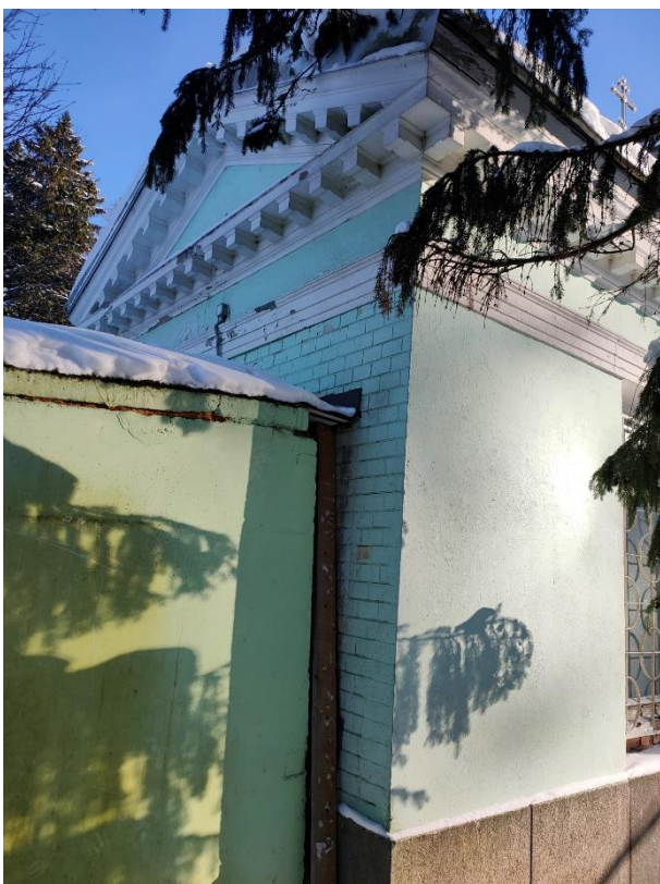
7. «Часовня над могилой графа П. П. Шувалова, 1906 г.», Ленинградская область, Всеволожский район, Агалатовское сельское поселение, д. Вартемяги, Токсовское шоссе,5. Северо-западный фасад. Общий вид. Фото 18.01.2021 г.
