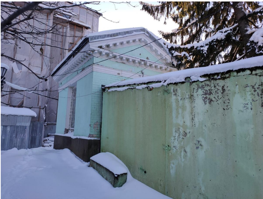
6. «Часовня над могилой графа П. П. Шувалова, 1906 г.», Ленинградская область, Всеволожский район, Агалатовское сельское поселение, д. Вартемяги, Токсовское шоссе, 5. Северо-западный фасад. Общий вид. Фото 18.01.2021 г.
