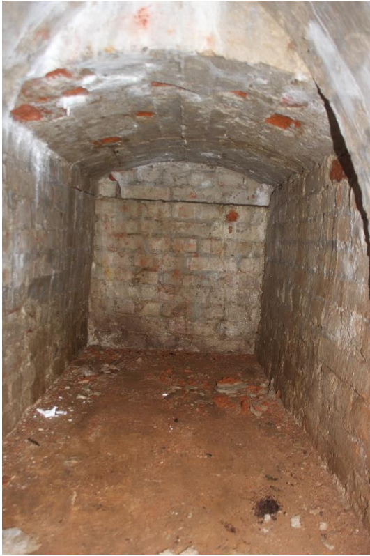
33. «Часовня над могилой графа П. П. Шувалова, 1906 г.», Ленинградская область, Всеволожский район, Агалатовское сельское поселение, д. Вартемяги, Токсовское шоссе, 5. Интерьер крипты. Общий вид. Фото 18.01.2021 г.
