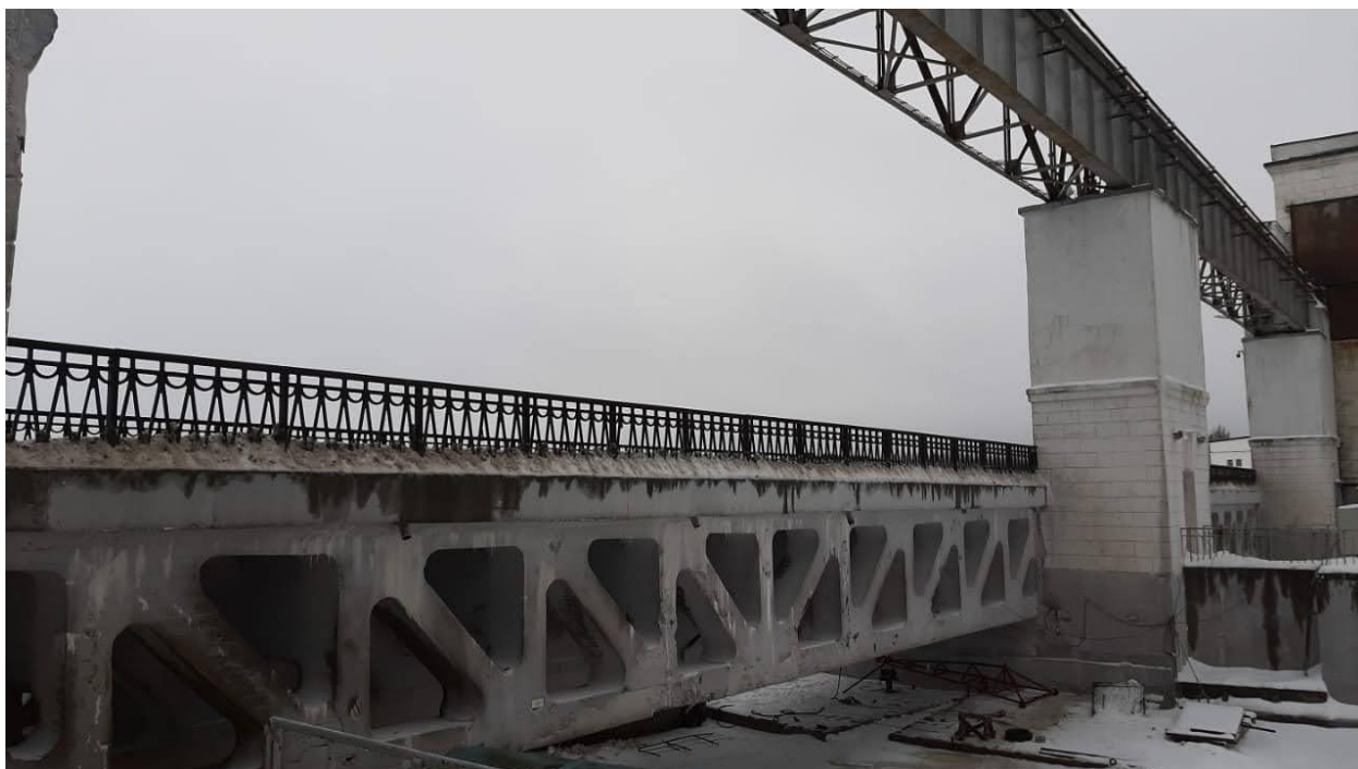
Фото 5. Пролёт секторного затвора №3 водосливной плотины (реконструируемый) с фрагментом моста
