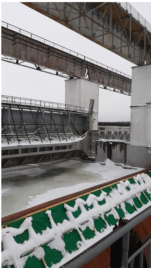
Фото 3. Пролёт секторного затвора №3 водосливной плотины (реконструируемый)
