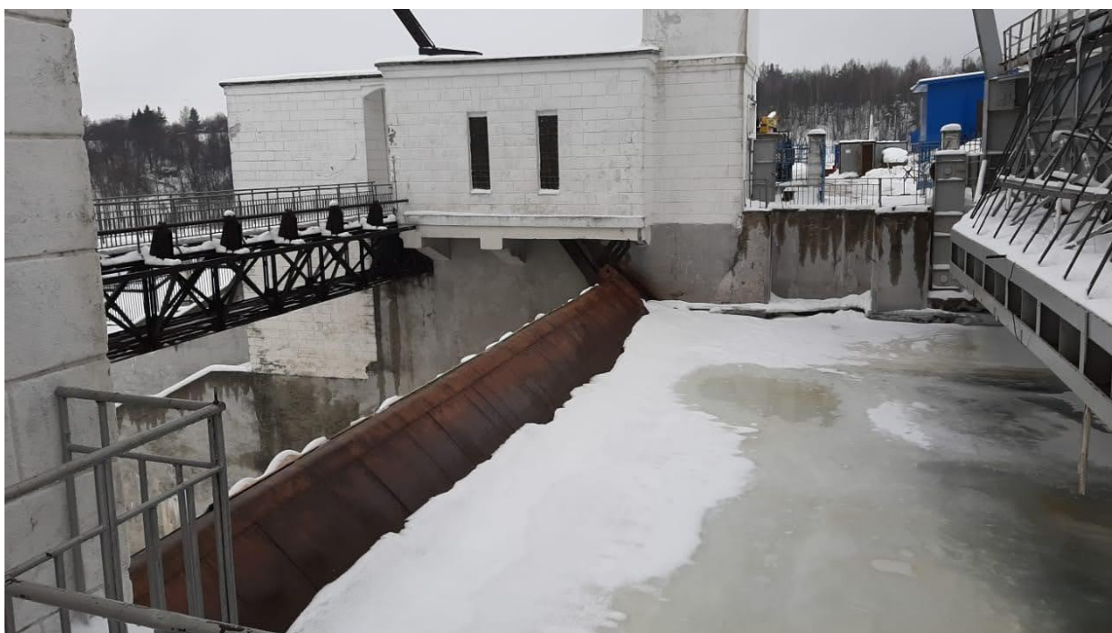
Фото 4. Пролёт секторного затвора №3 водосливной плотины (реконструируемый)
