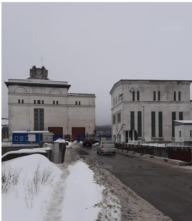
Фото 1. Общий вид на здание ГЭС со стороны шлюза.
