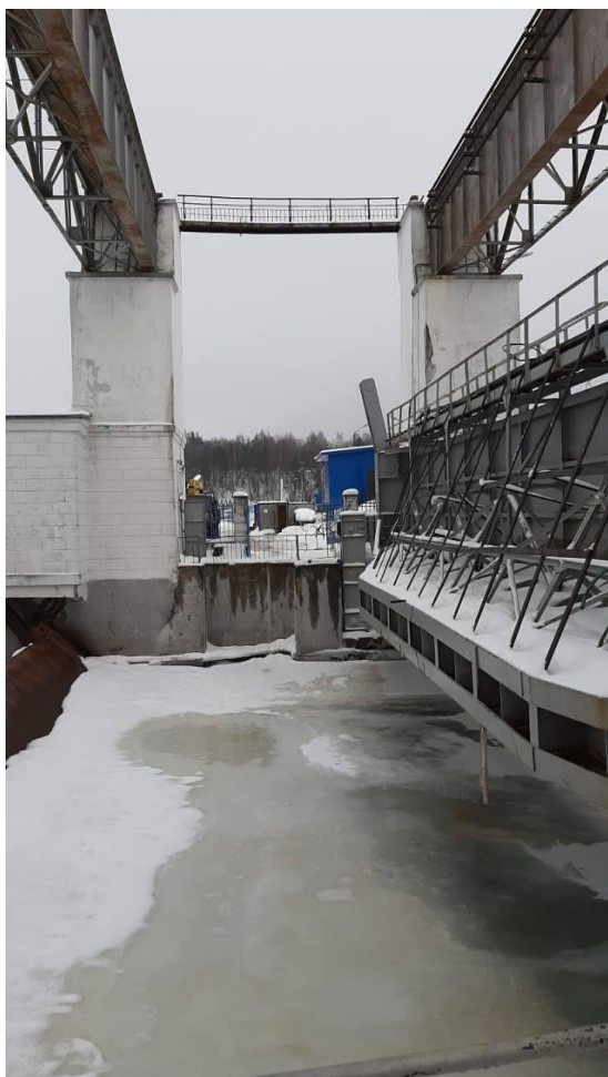
Фото 7. Пролёт секторного затвора №3 водосливной плотины (реконструируемый) и подкрановые эстакады
