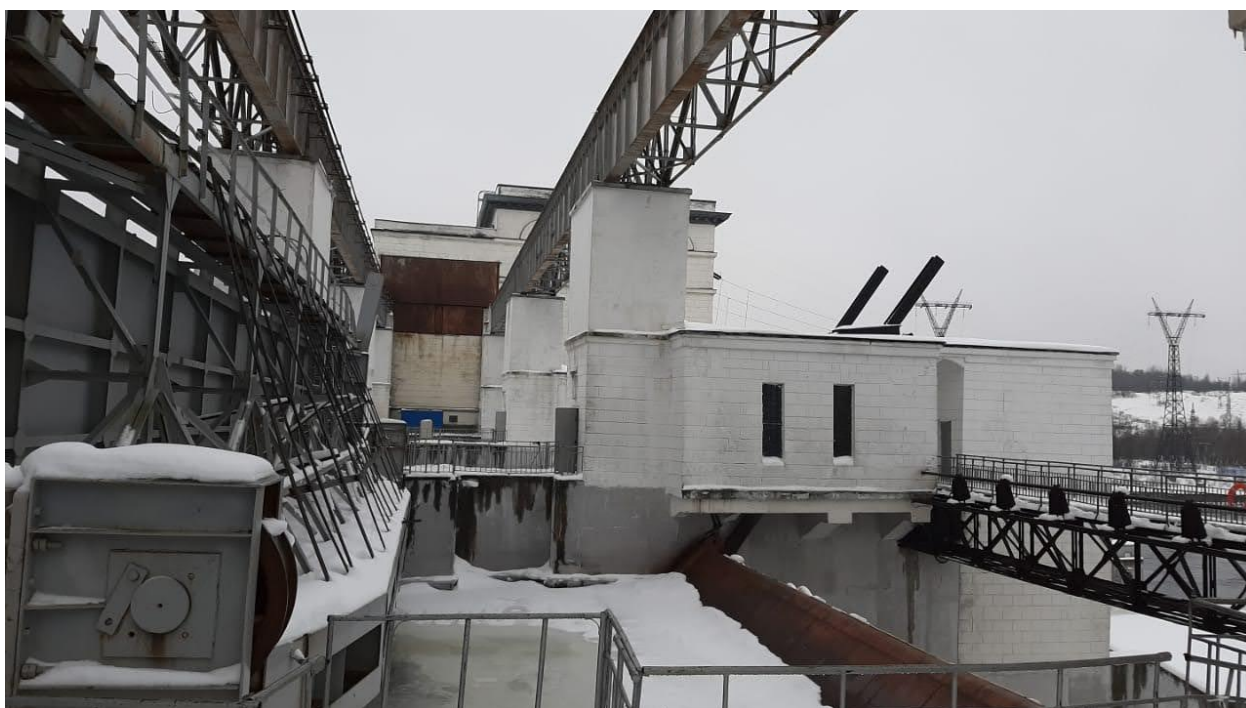
Фото 6. Пролёт секторного затвора №2 водосливной плотины и вид на здание ГЭС
