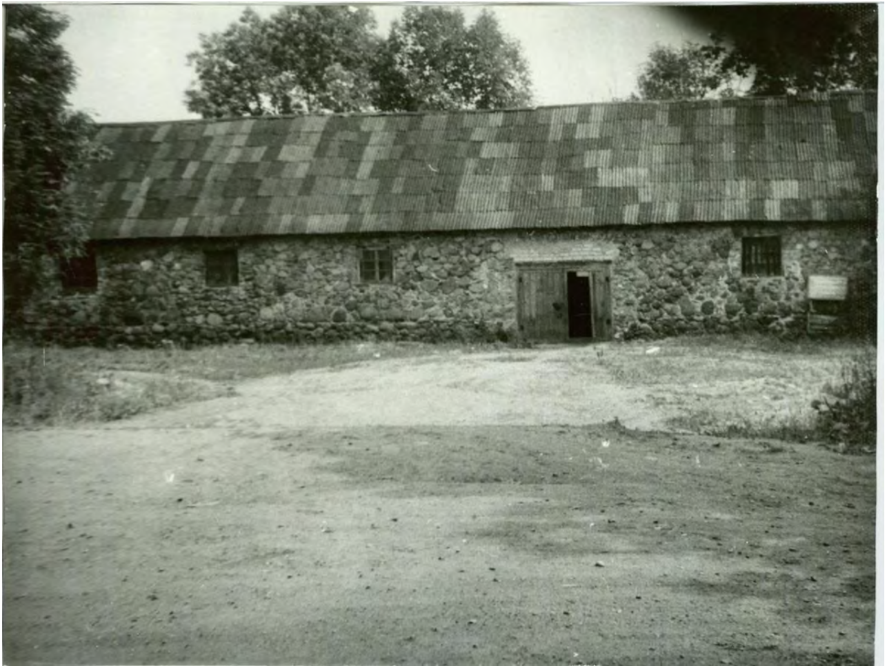
Илл. 04. Хозпостройка. Ленинградская область, Лужский район, д. Наволок, Парк усадьбы средний Наволок. Фото Мыслиной Л.П. 1992 г.
