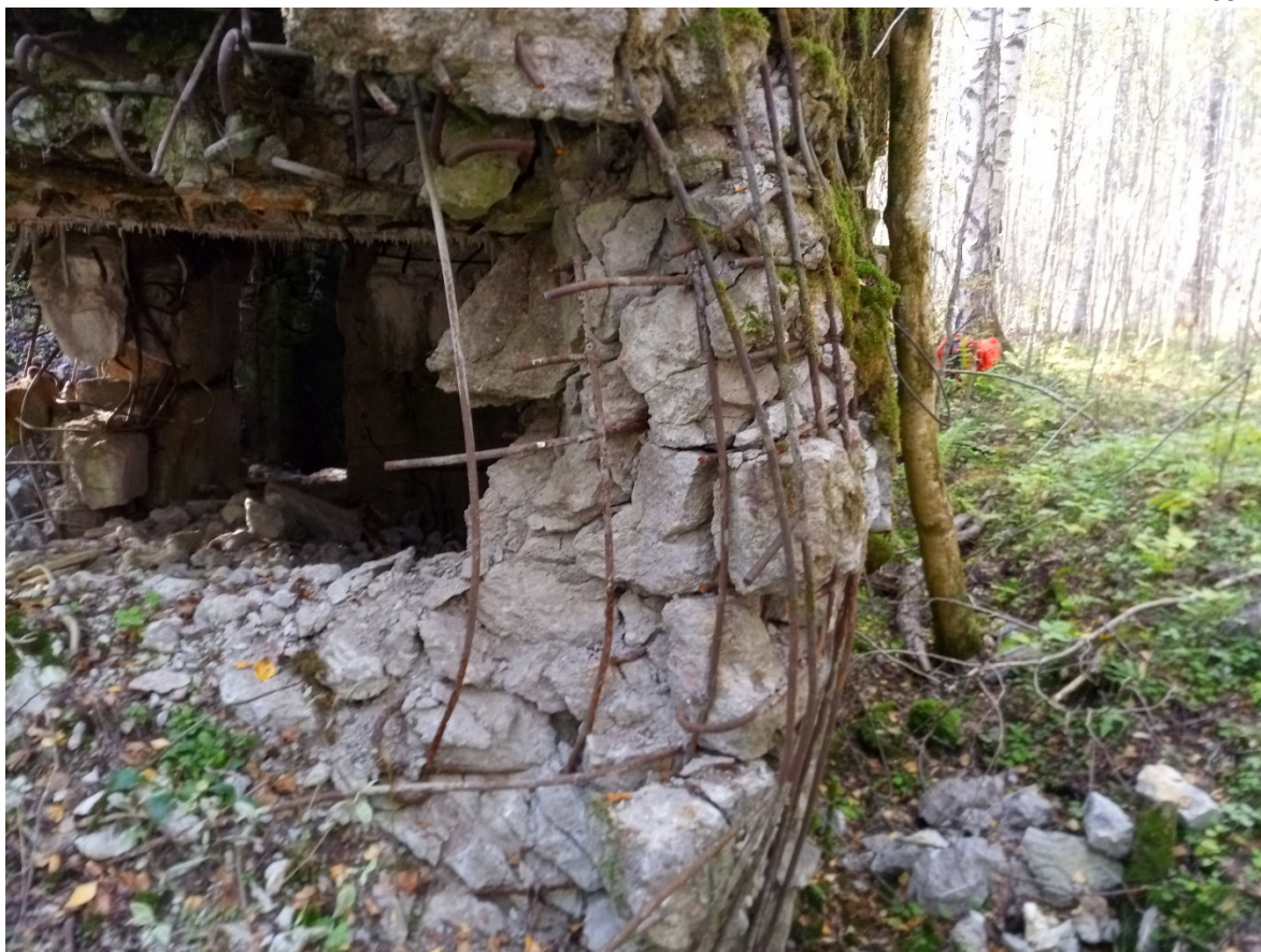
Подорванная стена капонира №28 на два пулемёта, укреплённый район Мялкёля. Арматура была срезана вандалами в 2020 году в период самоизоляции.
