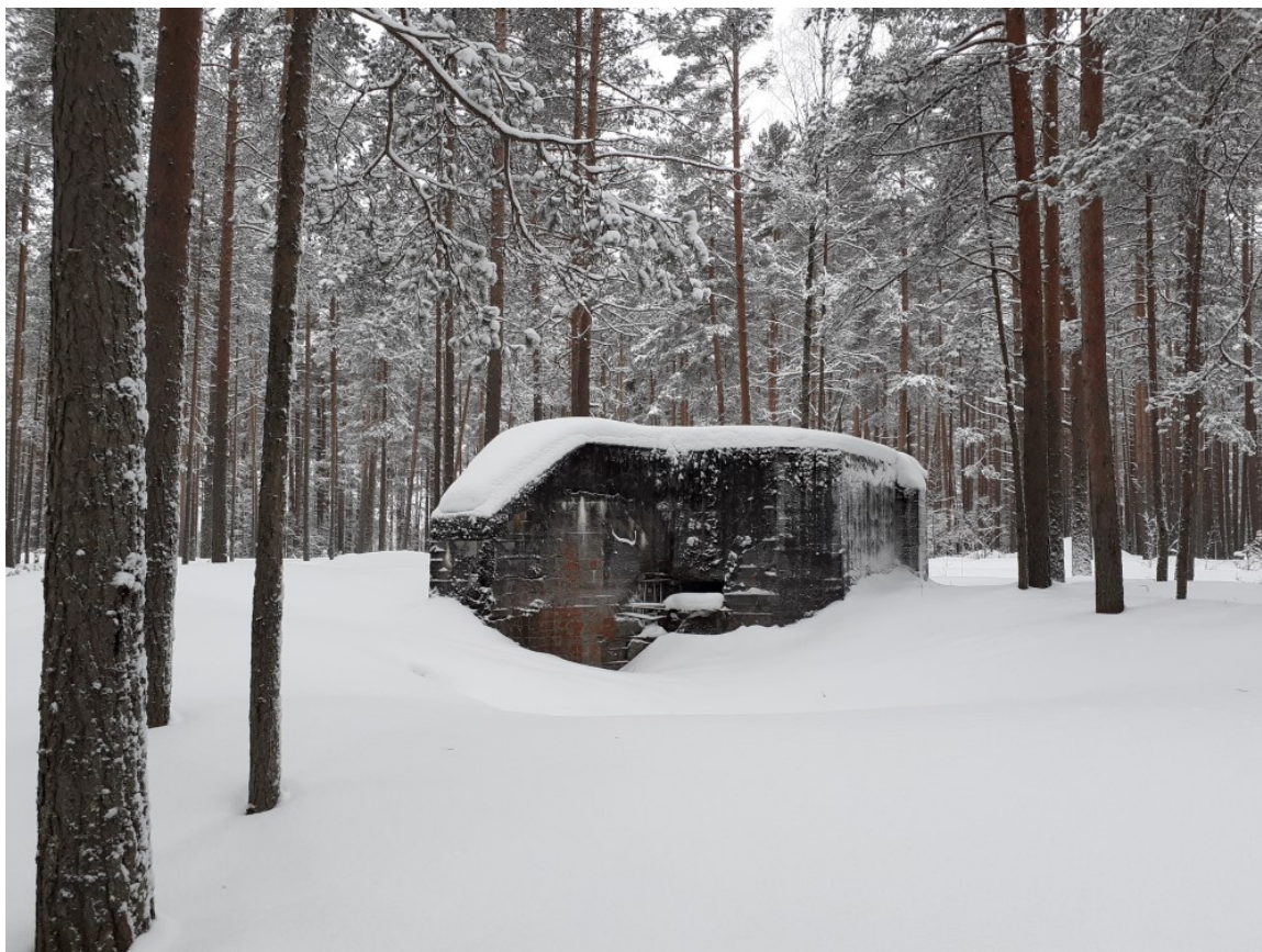
1. Общий вид на сооружение со стороны амбразуры
