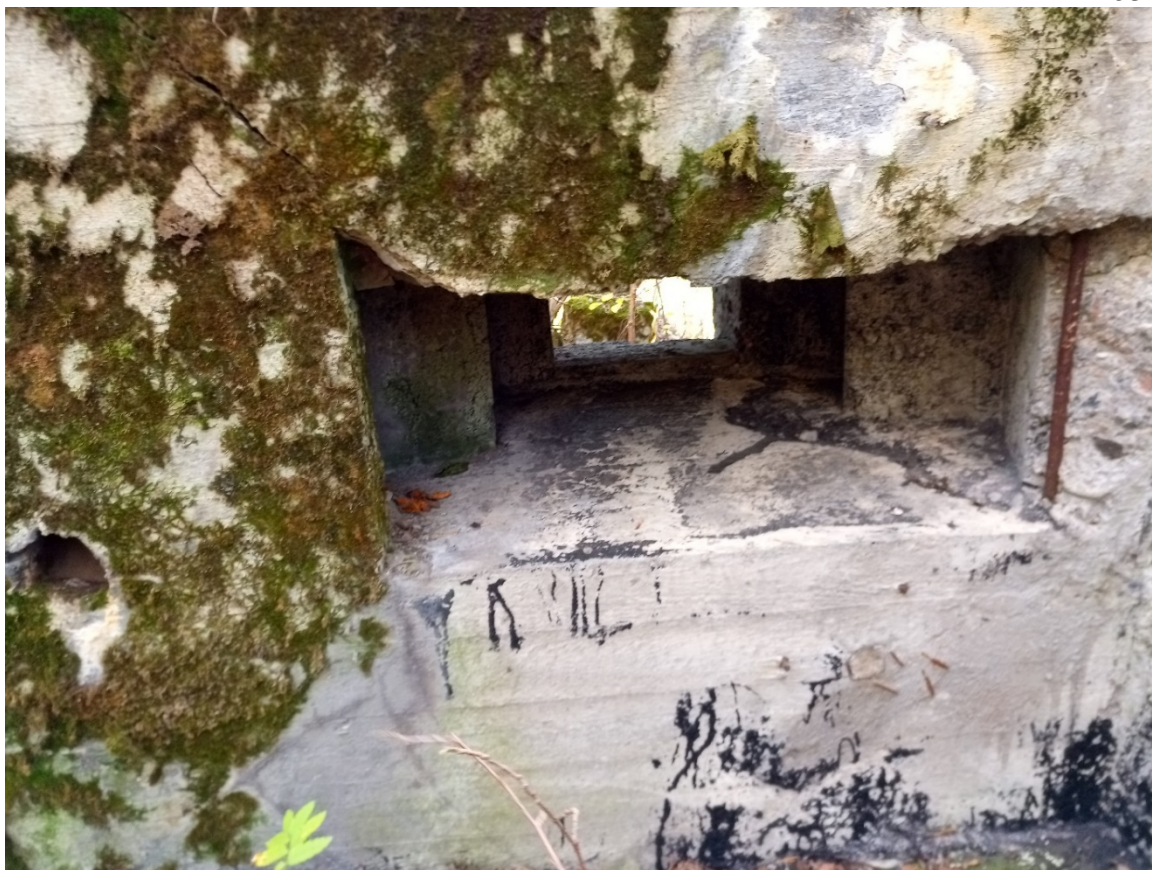
Сохранившаяся амбразура для пулемёта «Максим» капонира на два пулемёта №21, укреплённый район Мьялкёля. Вид снаружи.
