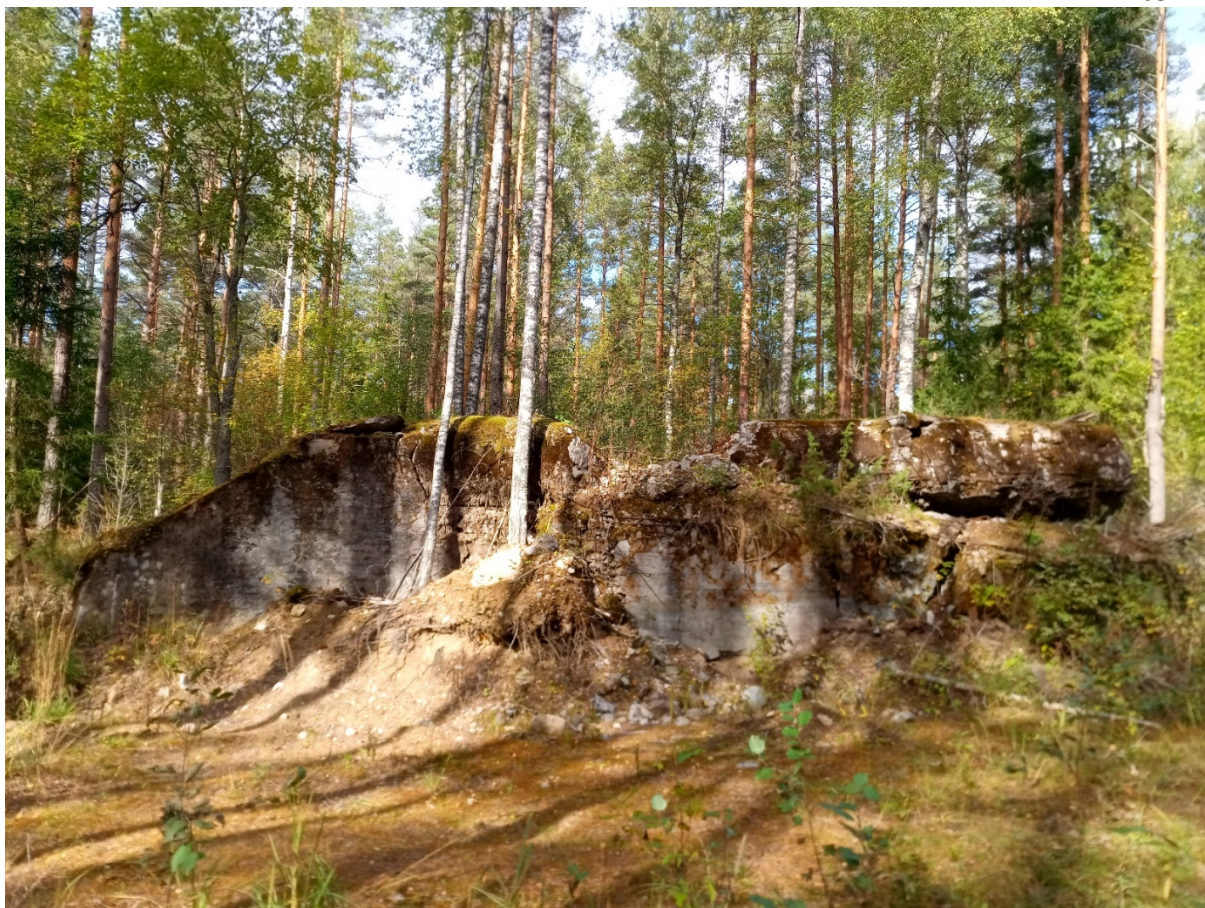
Общий вид полукапонира №26 на один пулемёт. Каменная подушка пущена на ограду близлежащего коттеджа.
