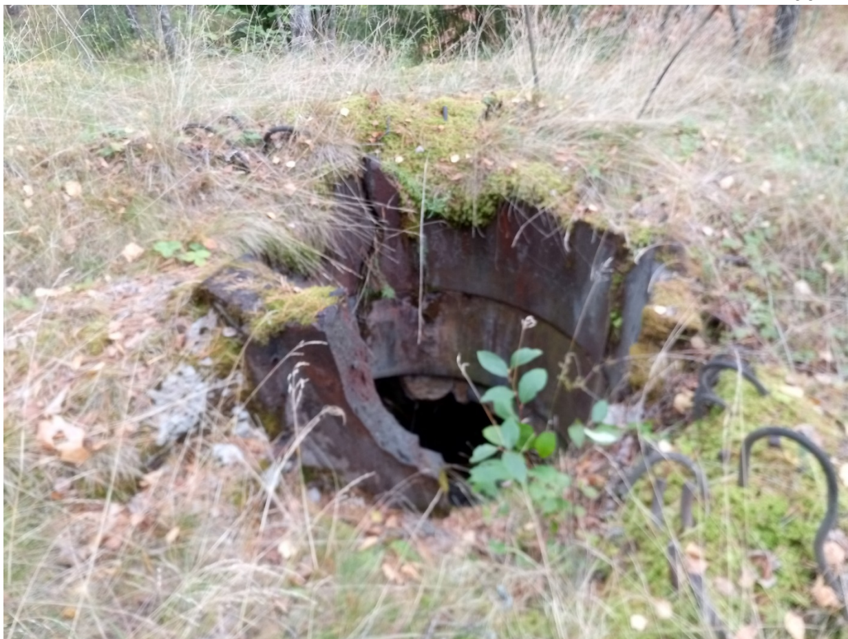
Фрагменты бронекупола полукапонира на один пулемёт №25 укрепрайона Мялкёля были демонтированы и вывезены вандалами в период самоизоляции в 2020 году.
