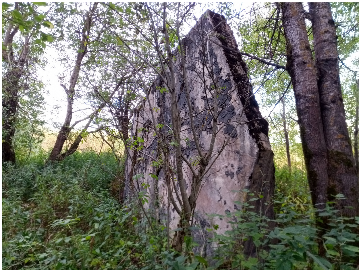
Поднятая взрывом и поставленная вертикально крыша ДОТ №2а
