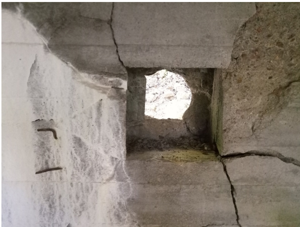
Вид сохранившейся амбразуры для винтовки изнутри капонира №28 на два пулемёта, укреплённый район Мялкёля.
