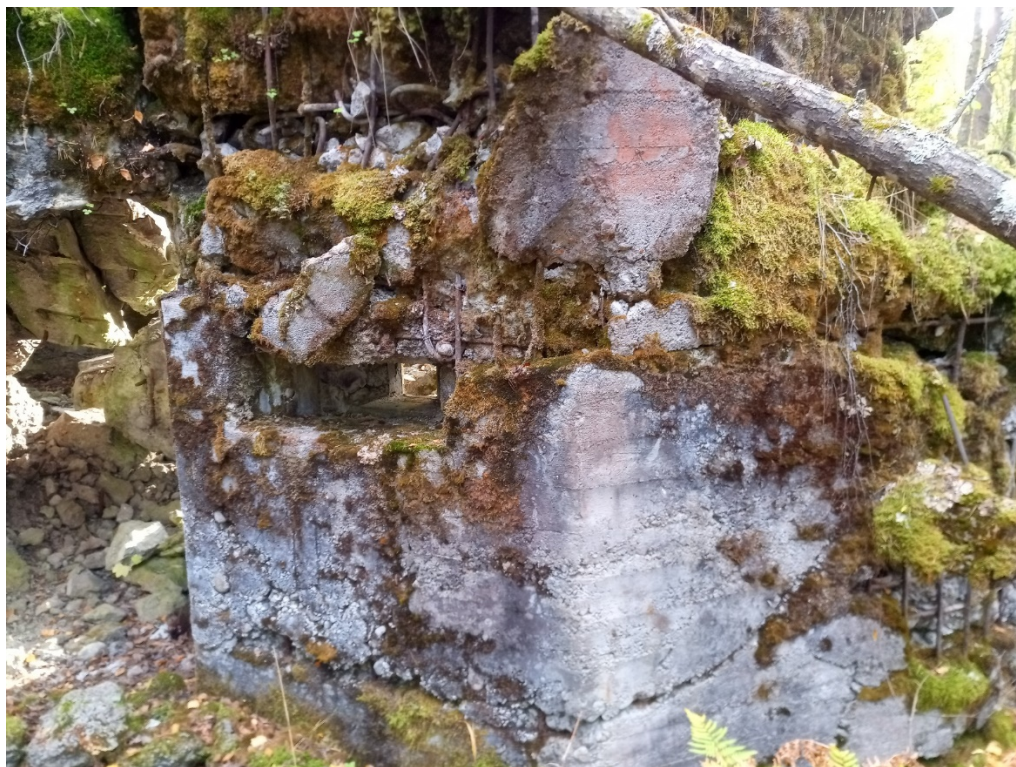
Типовое убежище №39, укрепленный район Мялкёля. Частично сохранившийся правый вход с амбразурой для ручного пулемёта.
