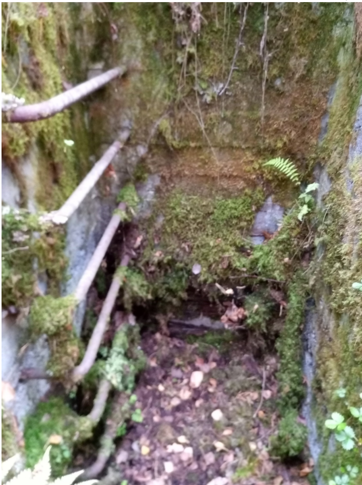
Сохранившаяся лестница в бронекупол, недостроенное типовое убежище №51, укрепленный район Мьякёля.
