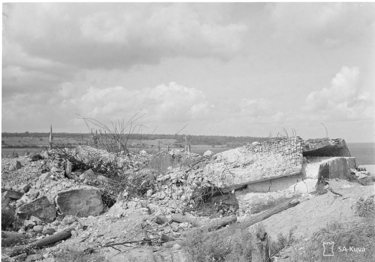
Рисунок 10. Подорванный форт Кивиниеми, 1942 год. Хорошо видна арматура.
