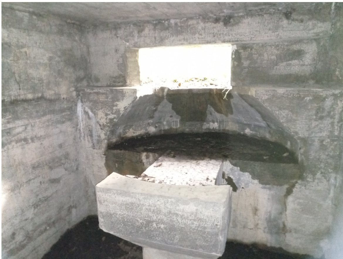
Стол под финский пулемёт «Максим» внутри полностью сохранившегося пулемётного ДОТ №3 укрепленного района Лауттаниеми.
