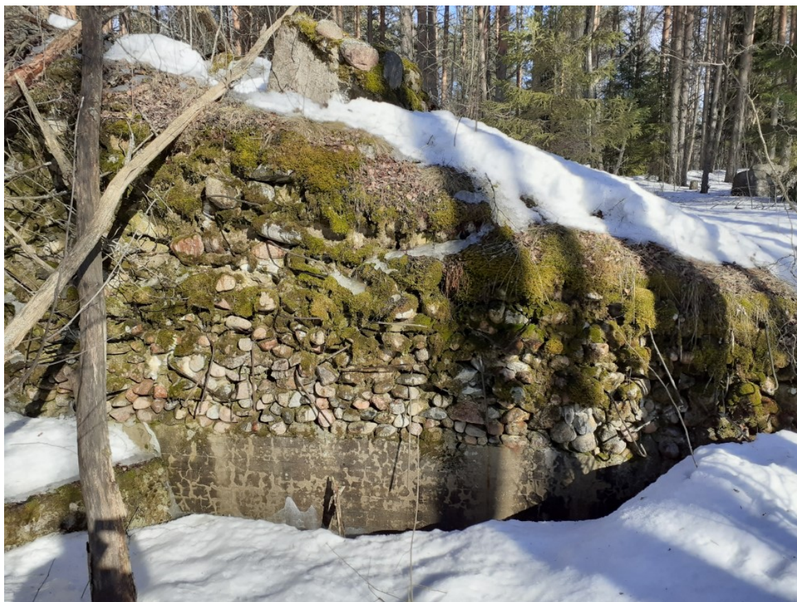
2. Вид на армированную стену-крыло, выложенную камнями
