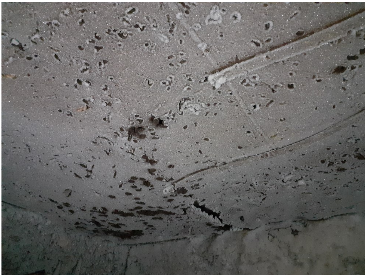
3. Сохранившийся стальной подбой на потолке сооружения
