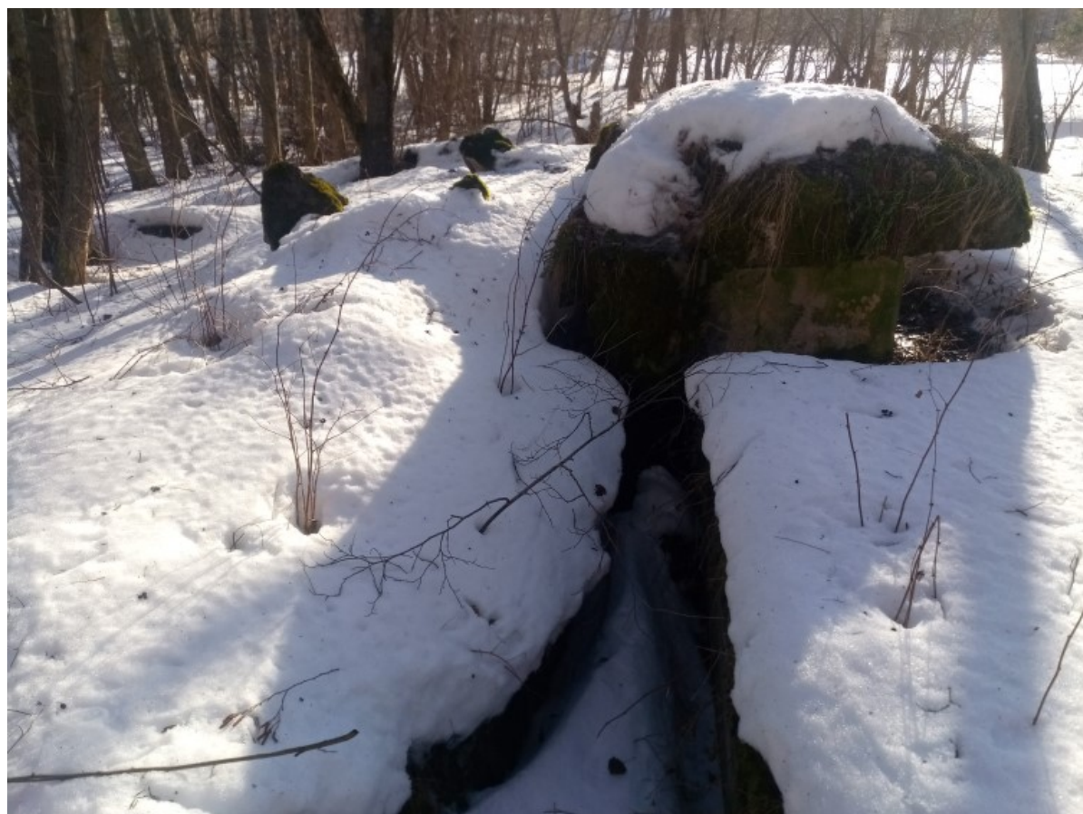
2. Вид на руины ДОТ с востока со стороны сохранившегося входа.
