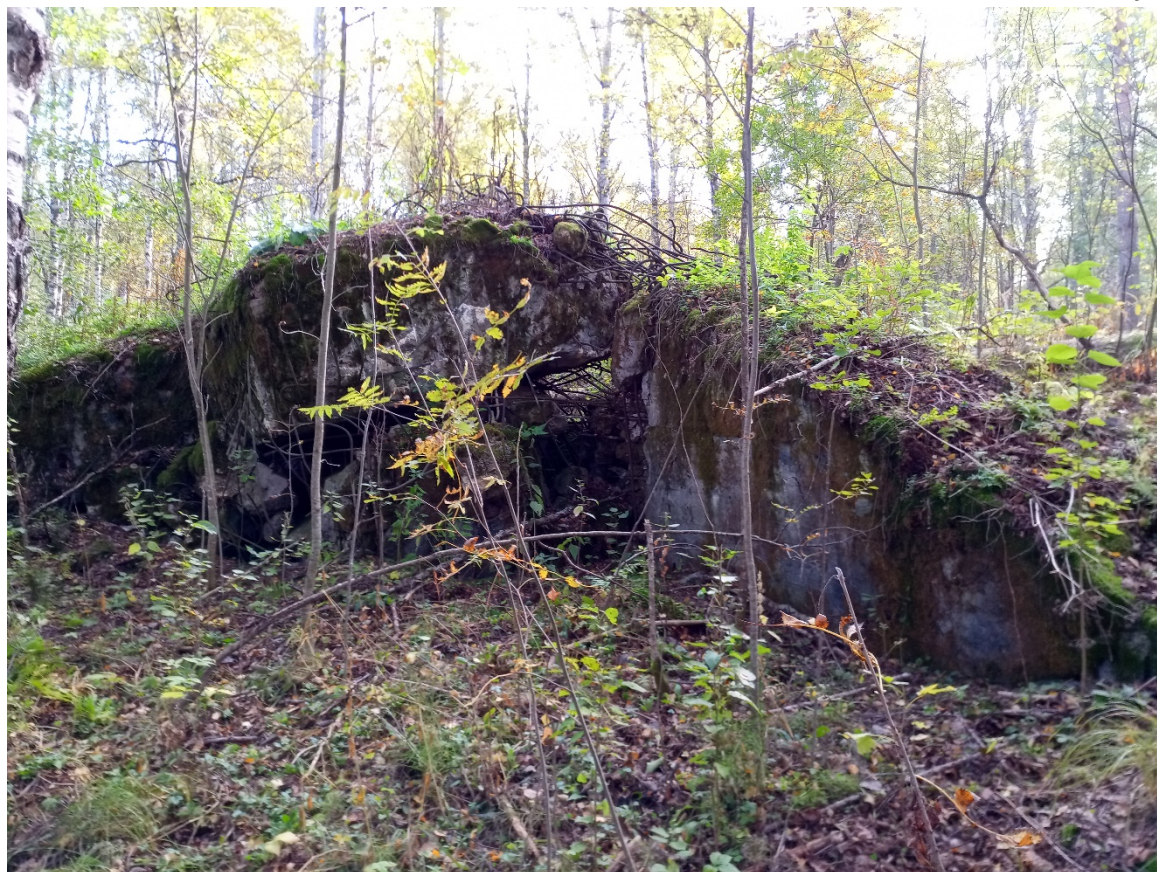
Общий вид на полукапонир №10 укрепрайона Мьяккеля
