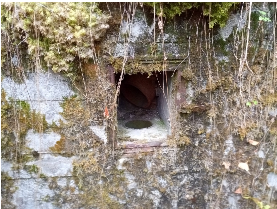
Система дымоходов, недостроенное типовое убежище №51, укрепленный район Мялкёля.
