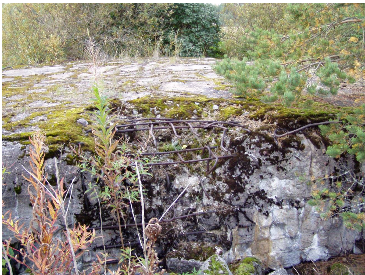
Рисунок 22. След прямого попадания на убежище №36 укрепленного района Мялкёля. 2007 год
