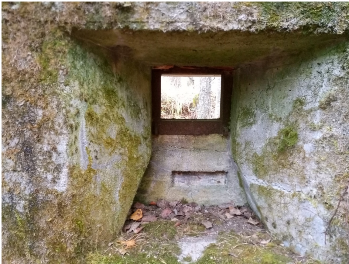
Амбразура для ручного пулемёта с сохранившейся рамкой бронезаслонки, недостроенное типовое убежище №51, укреплённый район Мялкёля.
