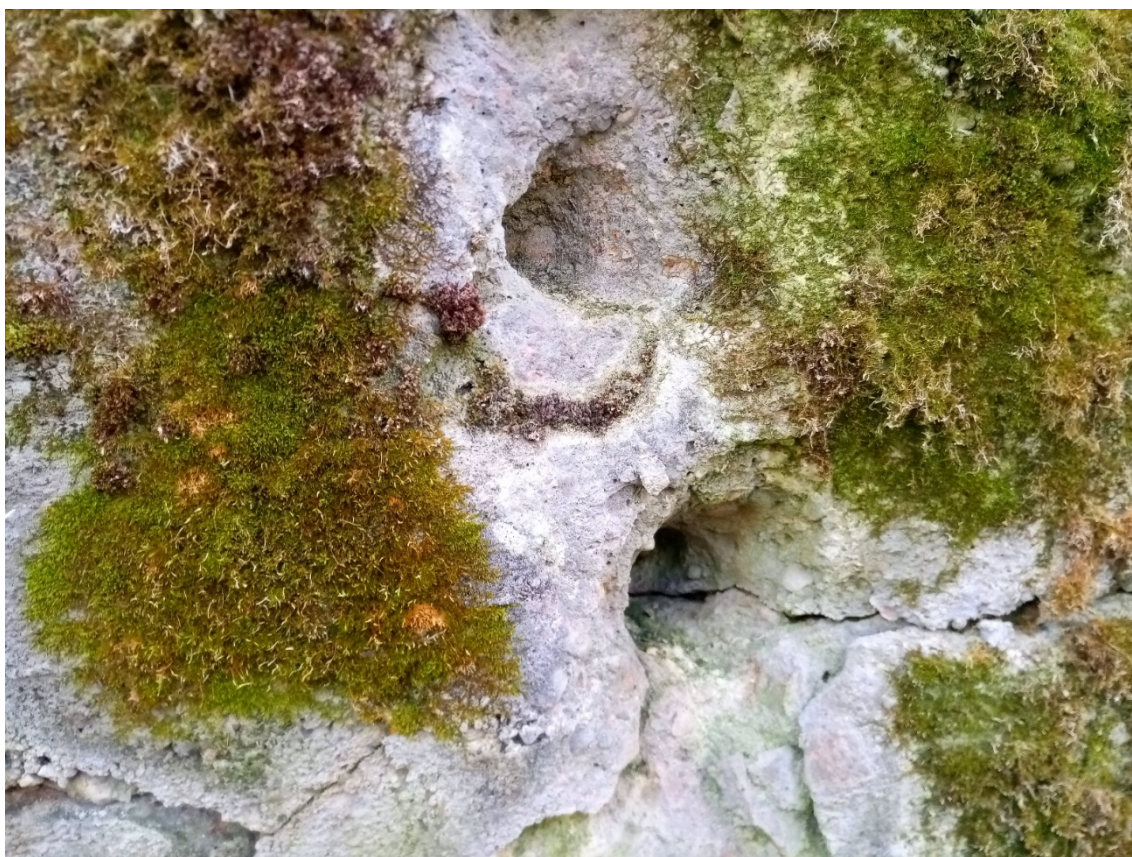
Следы попаданий снарядов на стене капонира №28 на два пулемёта, укреплённый район Мьякёля.
