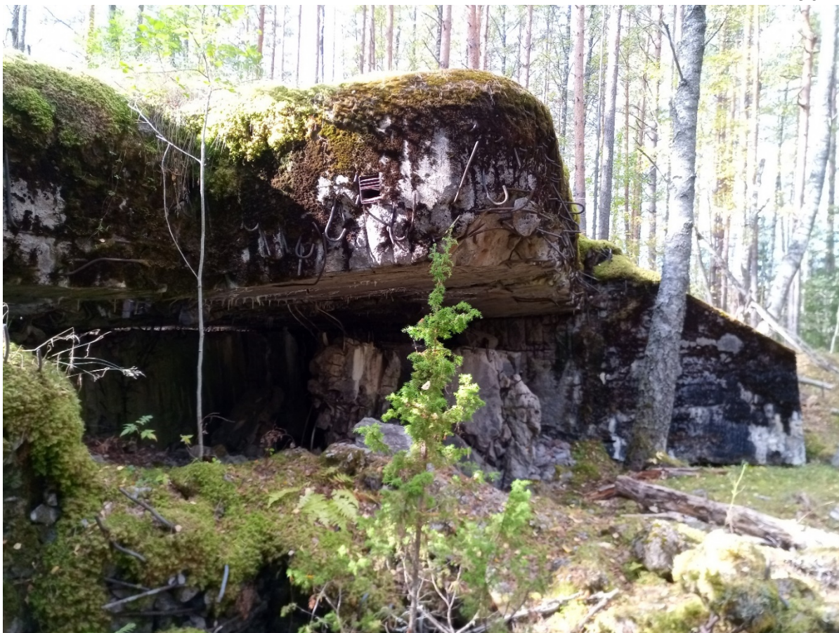
Общий вид полукапонира на один пулемёт №25 укрепрайона Мьялкёля были демонтированы и вывезены вандалами в период самоизоляции в 2020 году.
