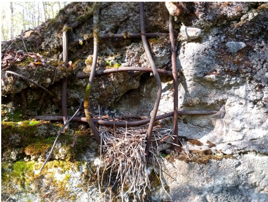
Следы попаданий снарядов на стене капонира №28 на два пулемёта, укреплённый район Мьякёля.
