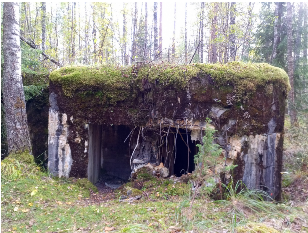
Типовое убежище №51, укрепленный район Мьялкёля. Правый вход и подорванная амбразура. Арматура была срезана вандалами в 2020 году в период самоизоляции.
