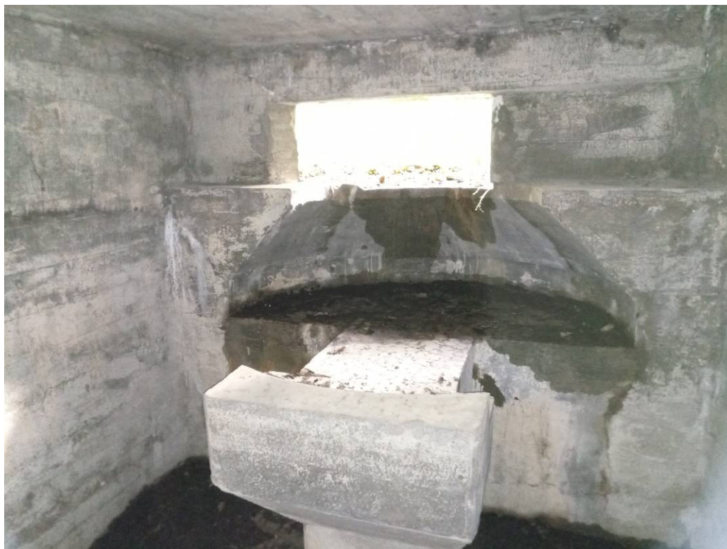
Рисунок 6. Внутри полностью сохранившейся восточной пулемётной точки на мысу Лауттаниеми. Прекрасно сохранилось основание под пулемёт «Максим» на финском лафете и амбразура. Сооружение не было подорвано, поскольку находится далеко от пушечного форта и советские сапёры летом 1940 года его не нашли. Фотография сделана осенью 2019 года. Возможно, что в связи с активизацией вандалов в период пандемии бронедверь уже спилена и сдана в металлолом.
