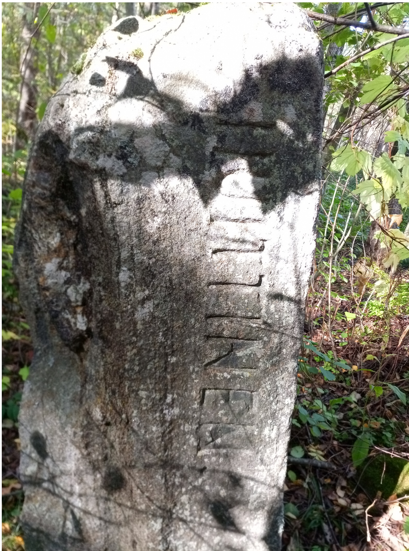
Один из подписных камней в линии противотанковых надолбов в районе полукапонира на один пулемёт №14 укрепрайона Мьялкёля. На этом камне нанесено название города Гуйттинен, из которого прибыли добровольцы, строившие данные препятствия.
