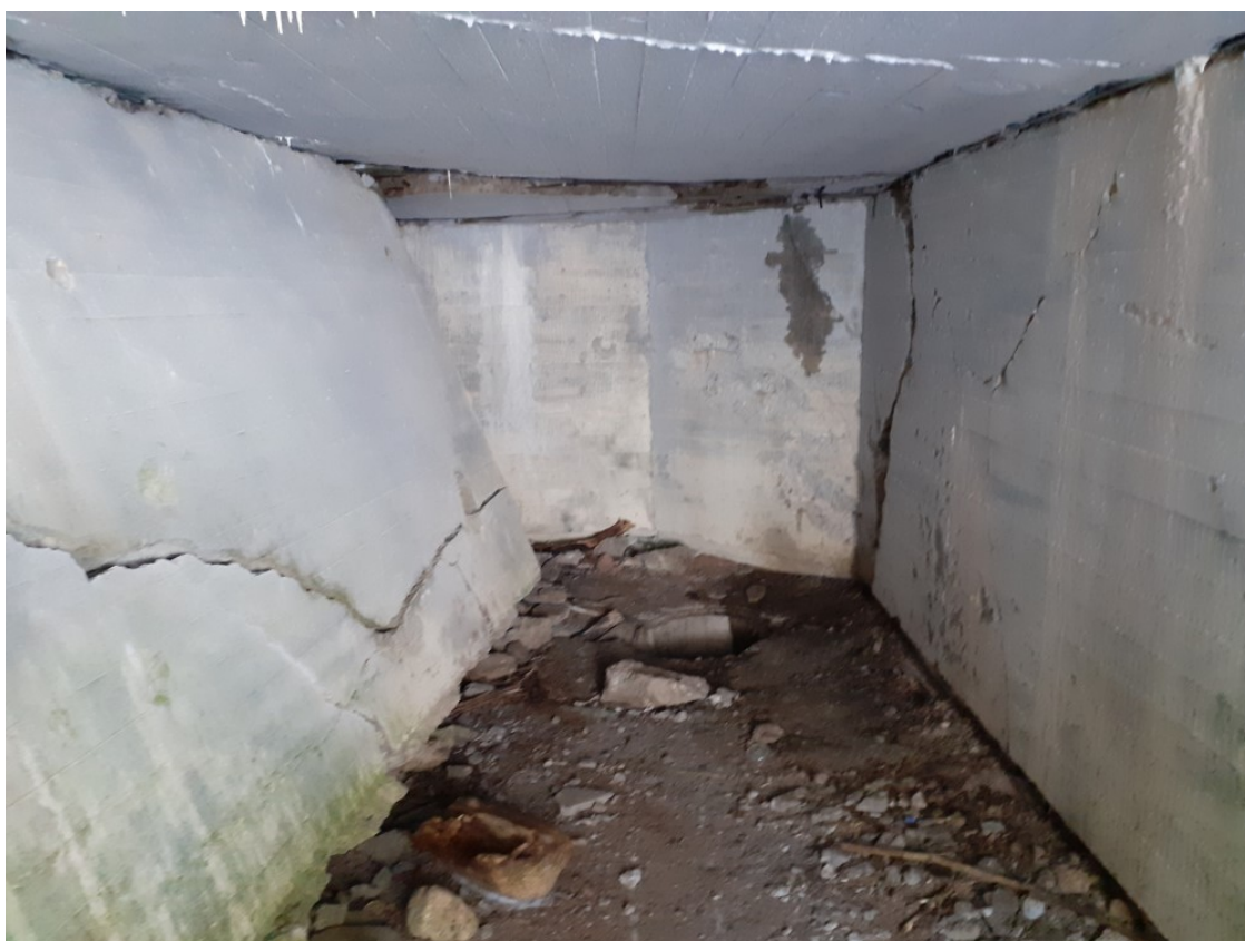
4. Общий вид главной галереи ДОТ со стороны входа
