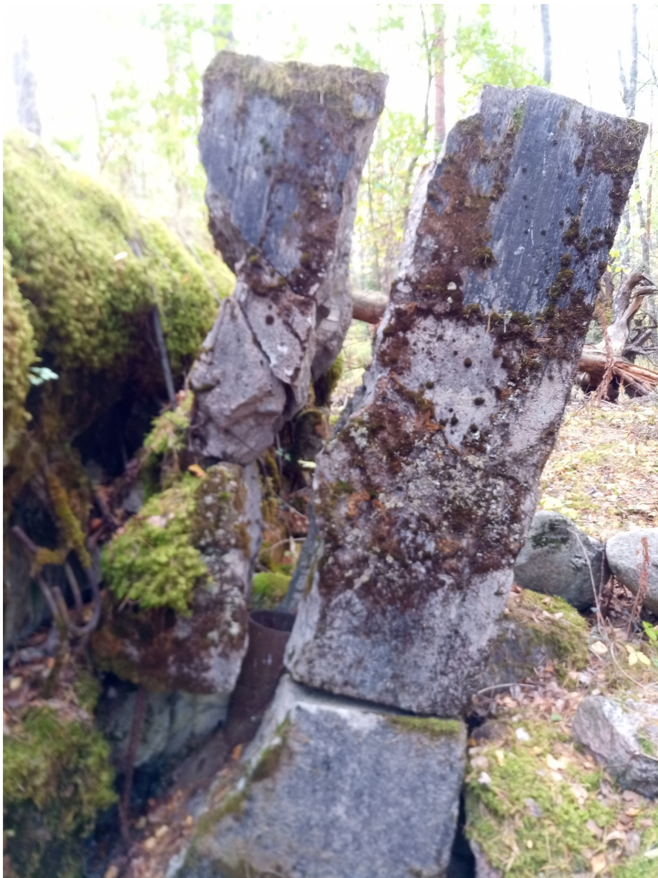
Расколота взрывом труба дымохода полукапонира на один пулемёт №25 укрепрайона Мялкёля
