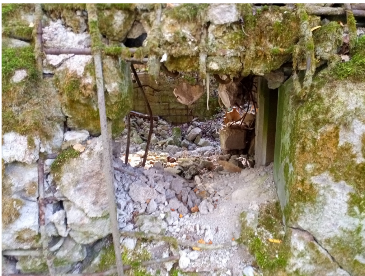
Сохранившийся эвакуационный люк капонира №28 на два пулемёта, укреплённый район Мялкёля.
