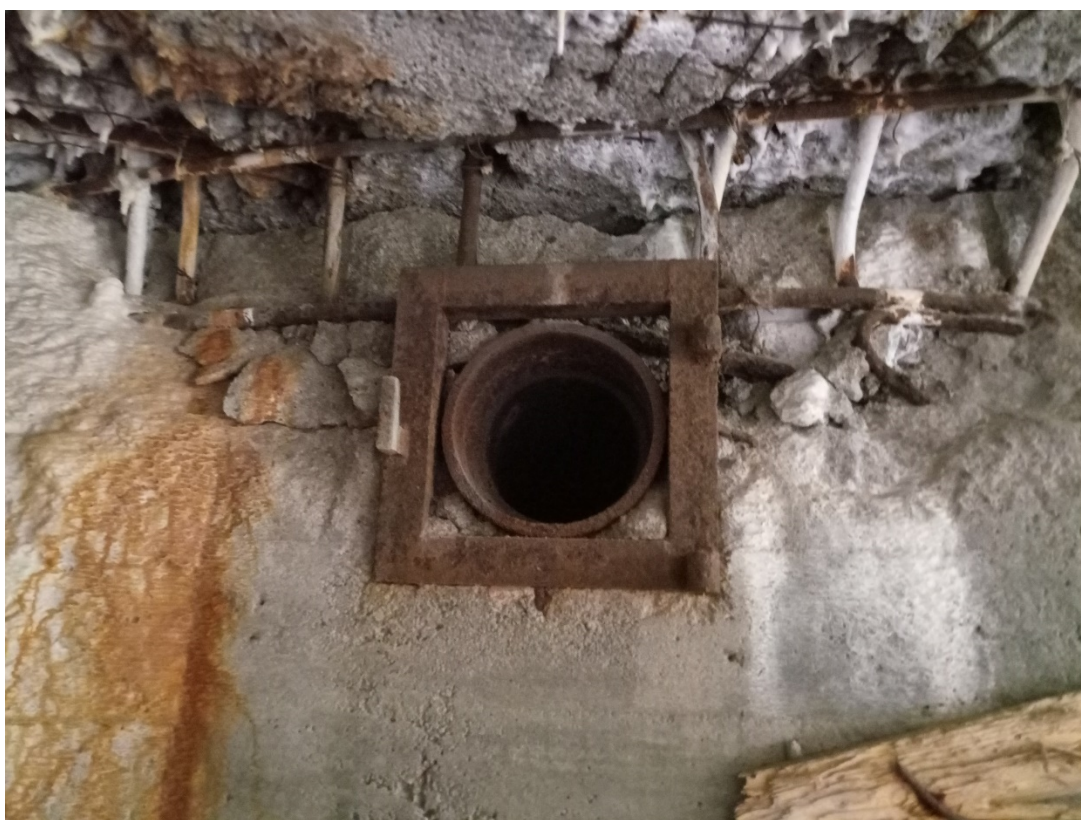
Сохранившаяся труба для выброса ручных гранат внутри капонира №28 на два пулемёта, укреплённый район Мялкёля.
