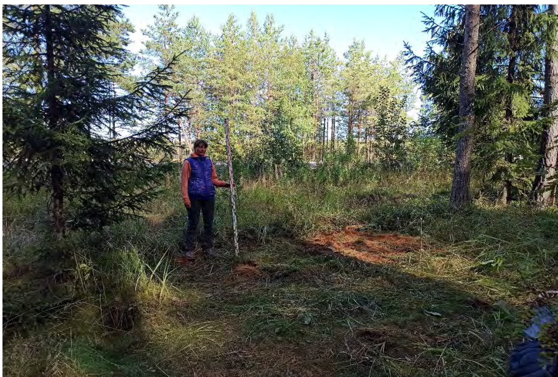
Рис.255. Ленинградская область, объект «Строительство кабельной волоконно-оптической линии связи мультисервисной транспортной сети связи Балтийского флота в направлении: УС 571-Д – объект 81809». Шурф №14. Общий вид шурфа после рекультивации. Вид с юго - запада.
