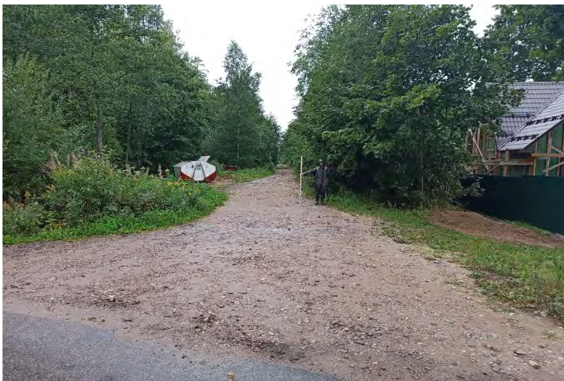
Рис.92. Ленинградская область, объект «Строительство кабельной волоконно-оптической линии связи мультисервисной транспортной сети связи Балтийского флота в направлении: УС 571-Д – объект 81809». ТФ №10. Проектируемая трасса ВОЛС. Вид с востока.
