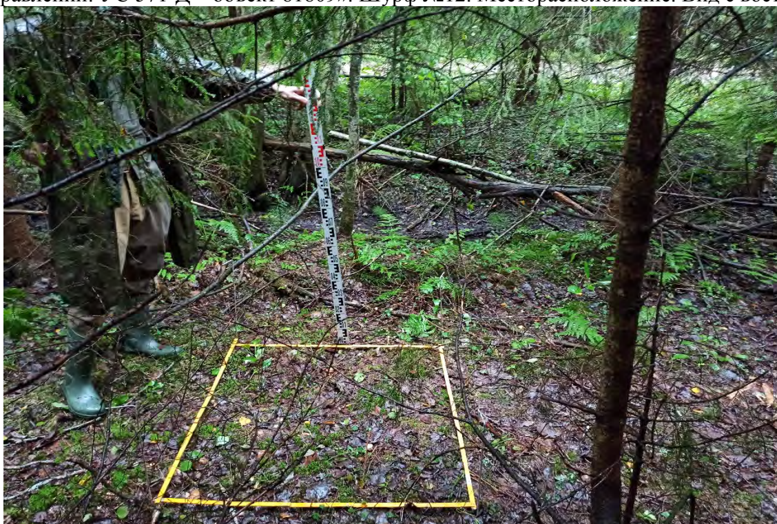
Рис.189. Ленинградская область, объект «Строительство кабельной волоконно-оптической линии связи мультисервисной транспортной сети связи Балтийского флота в направлении: УС 571-Д – объект 81809». Шурф №12. Общий вид перед началом работ. Вид с юга.
