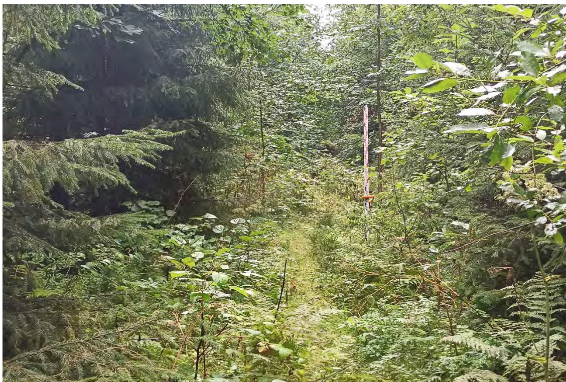
Рис.97. Ленинградская область, объект «Строительство кабельной волоконно-оптической линии связи мультисервисной транспортной сети связи Балтийского флота в направлении: УС 571-Д – объект 81809». ТФ №13. Проектируемая трасса ВОЛС. Вид с запада.
