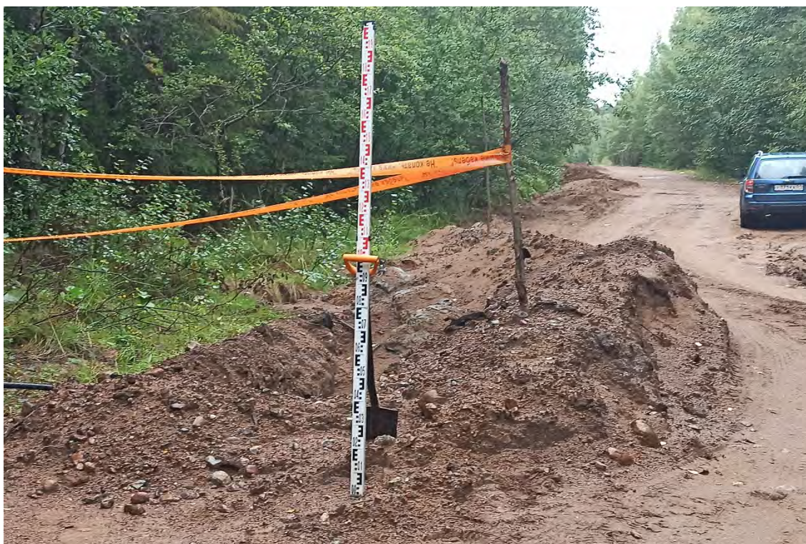
Рис.213. Ленинградская область, объект «Строительство кабельной волоконно-оптической линии связи мультисервисной транспортной сети связи Балтийского флота в направлении: УС 571-Д – объект 81809». ТФ №34. Проложенный участок ВОЛС. Вид с юга.
