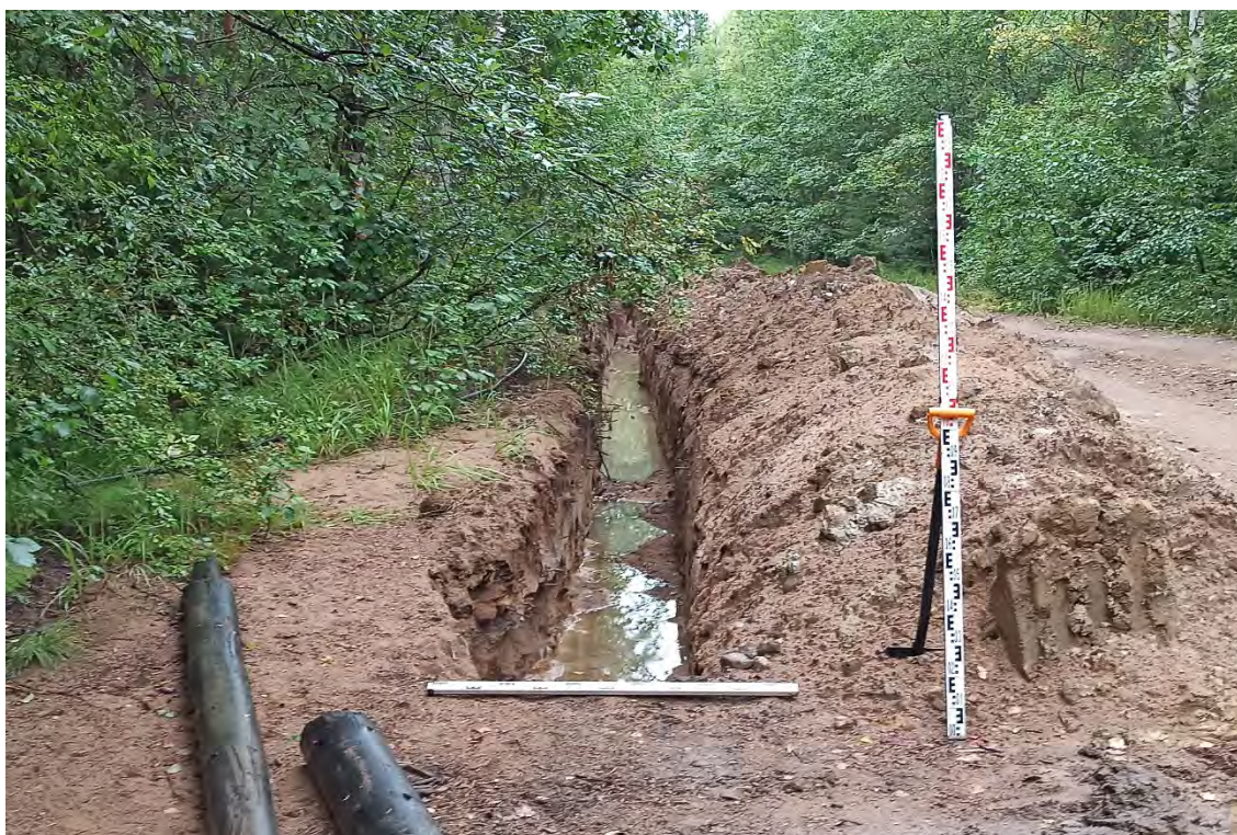
Рис.215. Ленинградская область, объект «Строительство кабельной волоконно-оптической линии связи мультисервисной транспортной сети связи Балтийского флота в направлении: УС 571-Д – объект 81809». ТФ №36. Проектируемая трасса ВОЛС. Участок с уже проложенным кабелем. Вид с юго - юго - востока.
