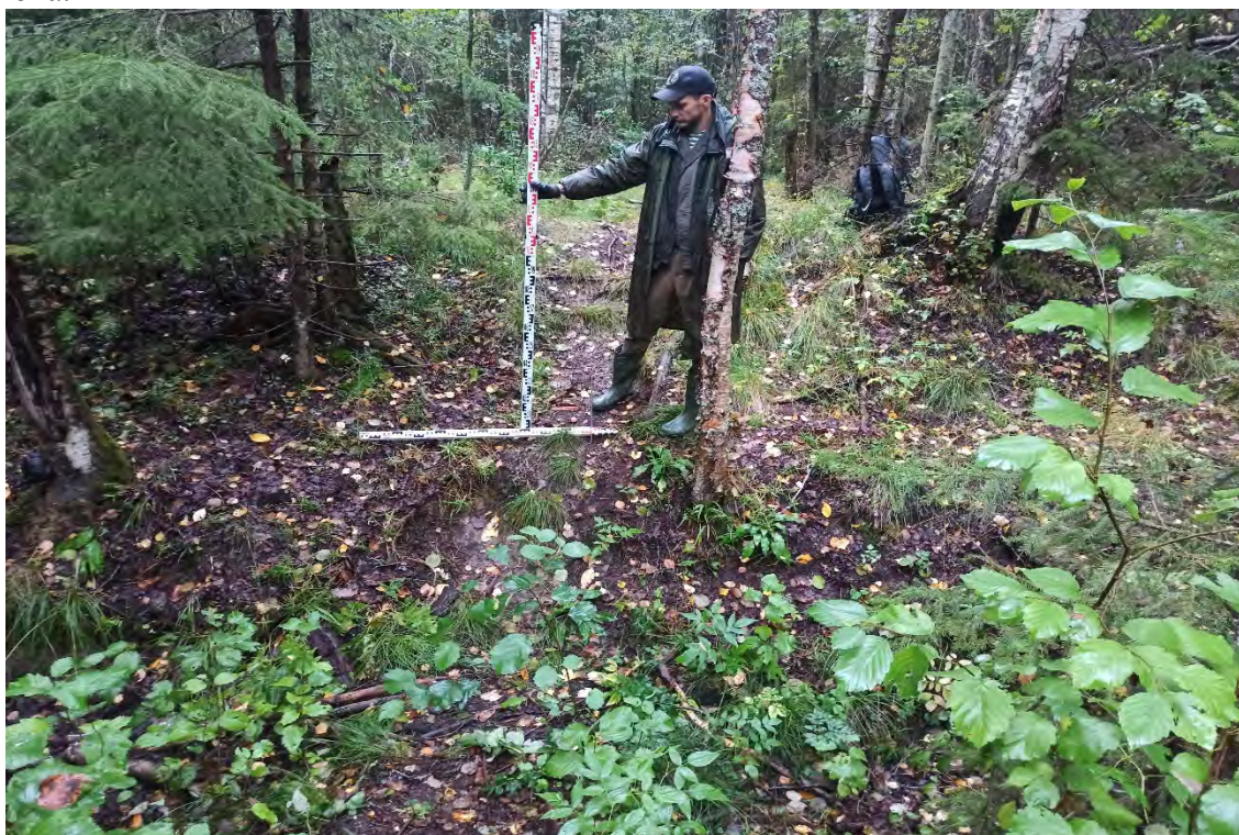
Рис.208. Ленинградская область, объект «Строительство кабельной волоконно-оптической линии связи мультисервисной транспортной сети связи Балтийского флота в направлении: УС 571-Д – объект 81809». Зачистка №12. Общий вид перед началом работ. Вид с юго - востока.
