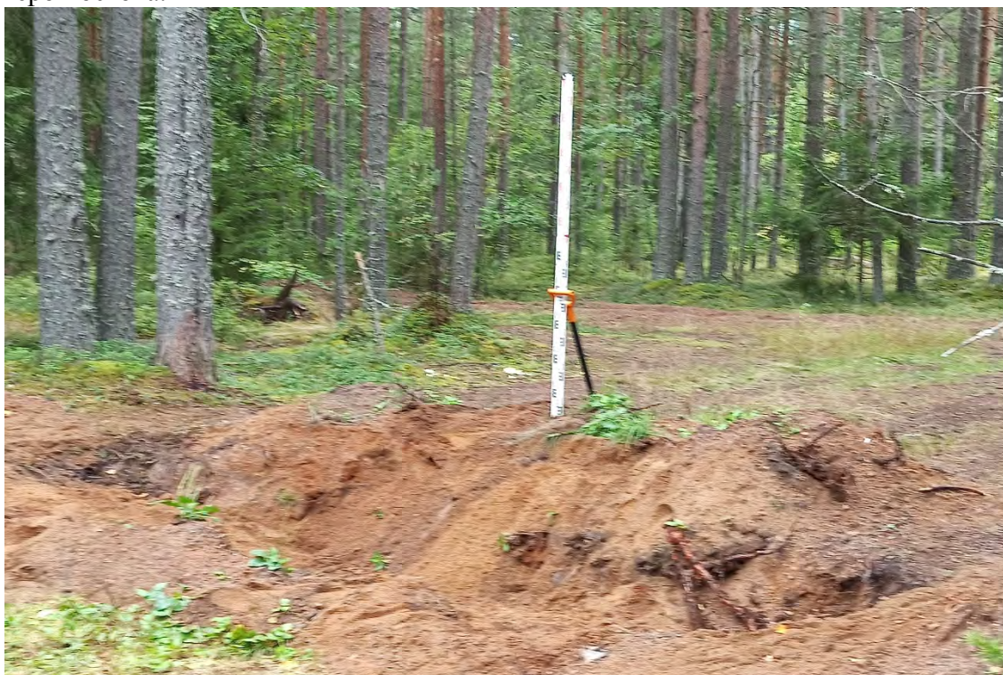
Рис.218. Ленинградская область, объект «Строительство кабельной волоконно-оптической линии связи мультисервисной транспортной сети связи Балтийского флота в направлении: УС 571-Д – объект 81809». Зачистка №14. Общий вид после рекультивации. Вид с севера-северо-востока.
