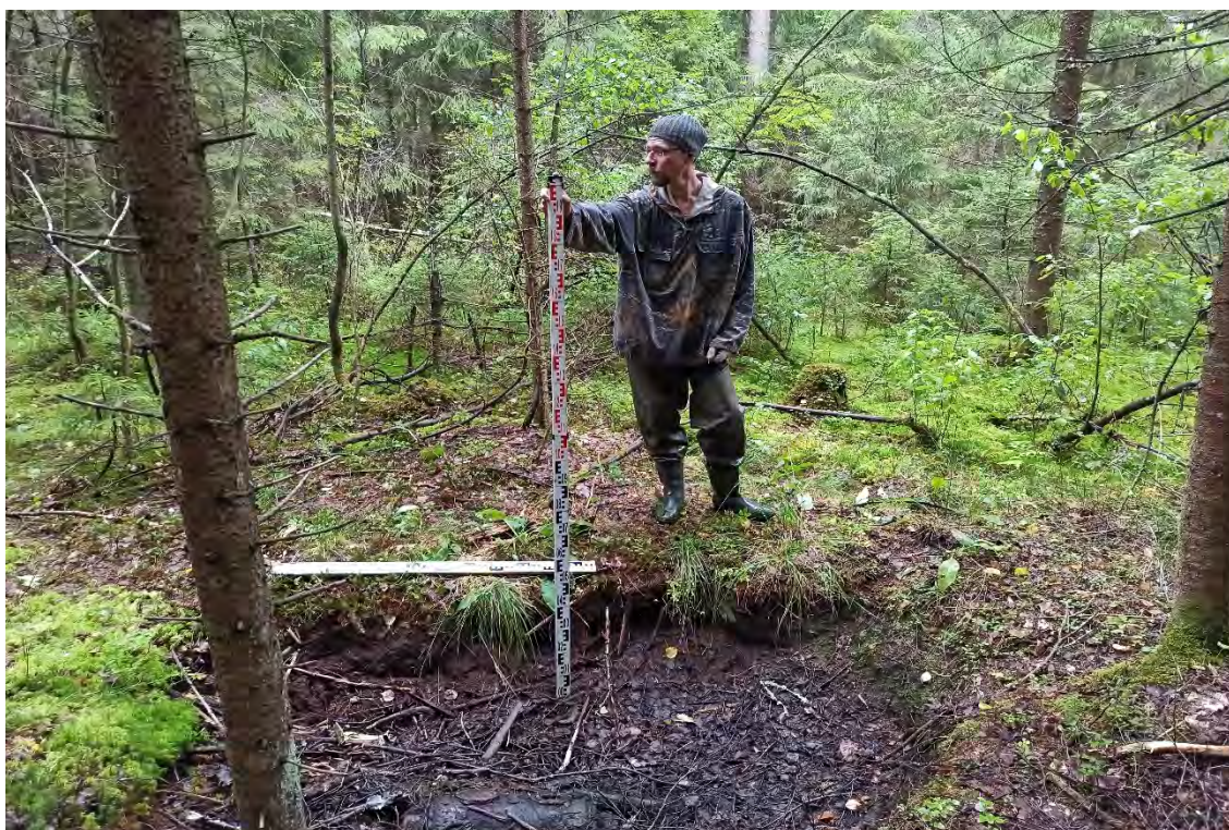
Рис.130. Ленинградская область, объект «Строительство кабельной волоконно-оптической линии связи мультисервисной транспортной сети связи Балтийского флота в направлении: УС 571-Д – объект 81809». Зачистка №7. Общий вид перед началом работ. Вид с юго-юго-запада.
