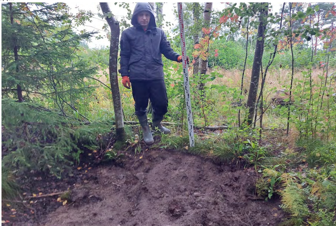
Рис.340. Ленинградская область, объект «Строительство кабельной волоконно-оптической линии связи мультисервисной транспортной сети связи Балтийского флота в направлении: УС 571-Д – объект 81809». Зачистка №24. После рекультивации. Вид с запада.
