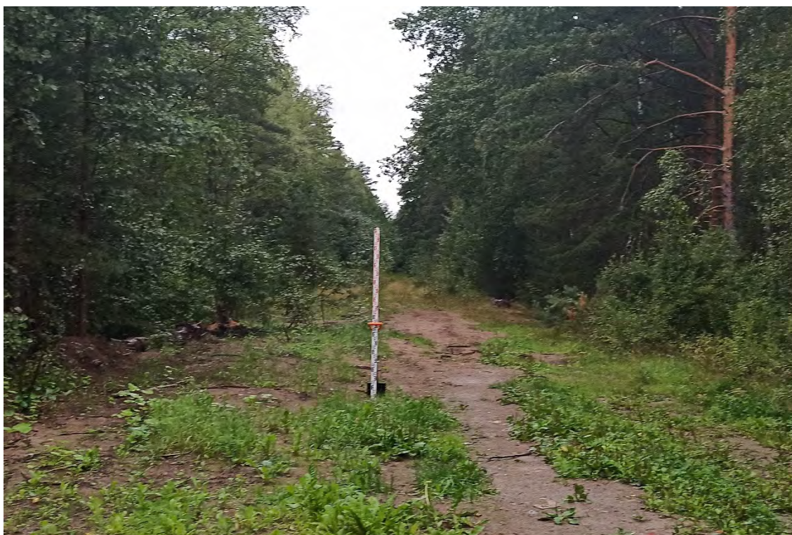
Рис.90. Ленинградская область, объект «Строительство кабельной волоконно-оптической линии связи мультисервисной транспортной сети связи Балтийского флота в направлении: УС 571-Д – объект 81809». ТФ №8. Проектируемая трасса ВОЛС. Вид с востока.
