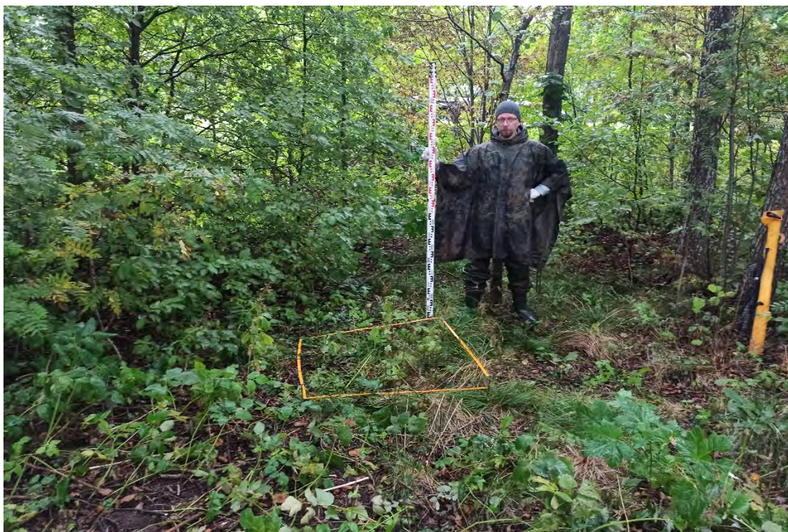
Рис.53. Ленинградская область, объект «Строительство кабельной волоконно-оптической линии связи мультисервисной транспортной сети связи Балтийского флота в направлении: УС 571-Д – объект 81809». Шурф №3. Общий вид перед началом работ. Вид с юга.
