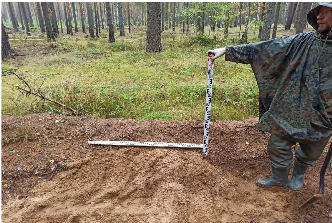
Рис.125. Ленинградская область, объект «Строительство кабельной волоконно-оптической линии связи мультисервисной транспортной сети связи Балтийского флота в направлении: УС 571-Д – объект 81809». Зачистка №5. Общий вид после рекультивации. Вид с юго-юго-востока.
