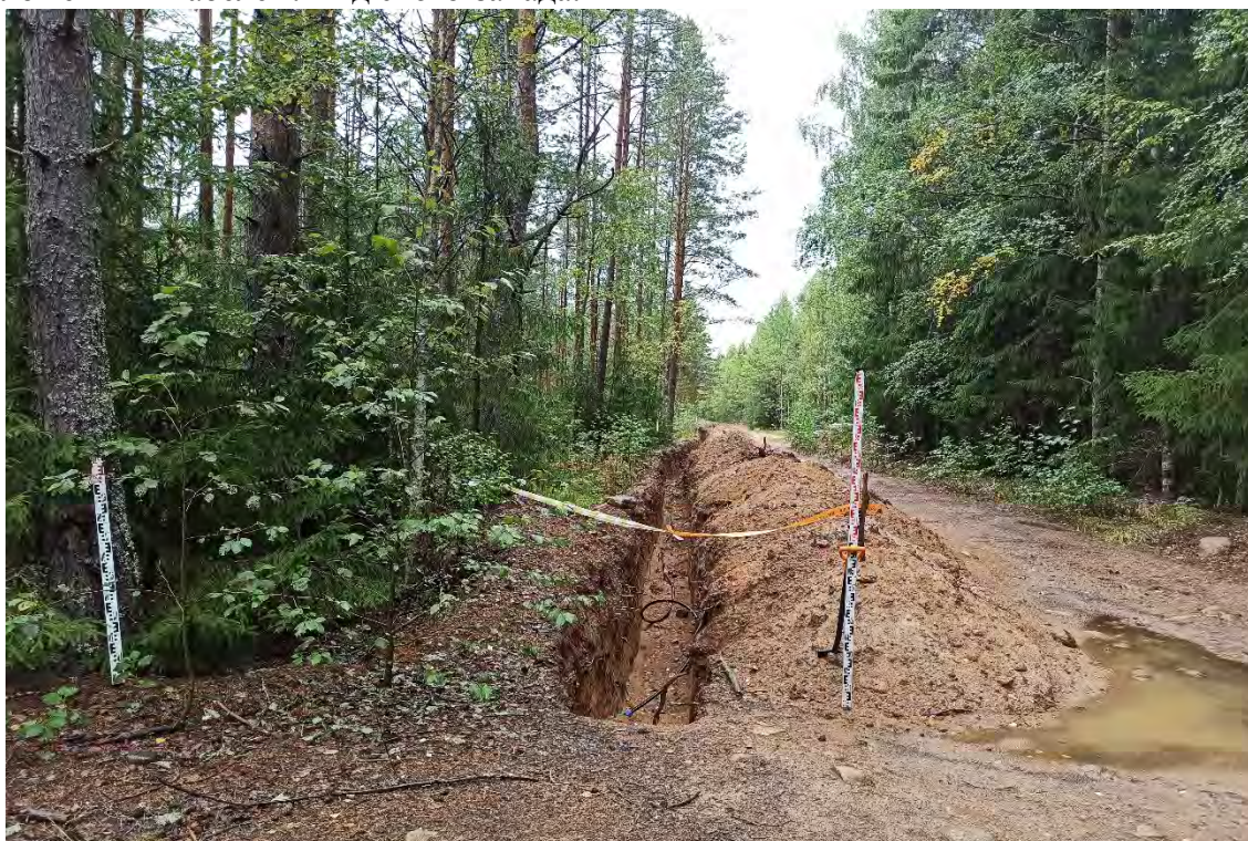
Рис.220. Ленинградская область, объект «Строительство кабельной волоконно-оптической линии связи мультисервисной транспортной сети связи Балтийского флота в направлении: УС 571-Д – объект 81809». ТФ №38. Проектируемая трасса ВОЛС. Участок с уже проложенным кабелем. Вид с юга-юго-запада.
