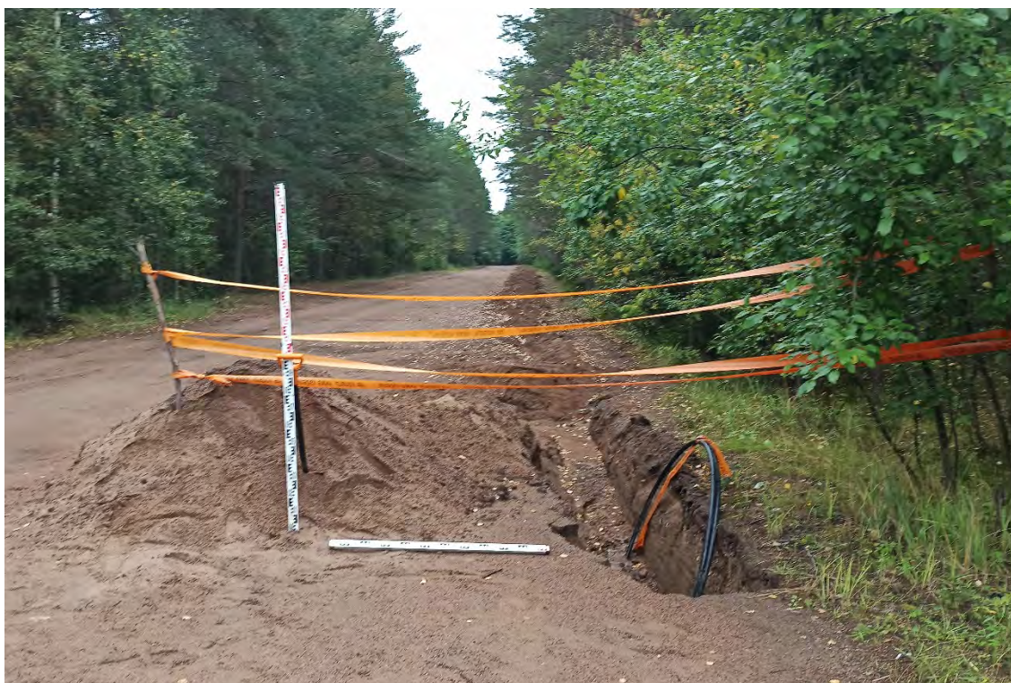
Рис.211. Ленинградская область, объект «Строительство кабельной волоконно-оптической линии связи мультисервисной транспортной сети связи Балтийского флота в направлении: УС 571-Д – объект 81809». Проложенный участок ВОЛС и месторасположение зачистка №13. Вид с запада.
