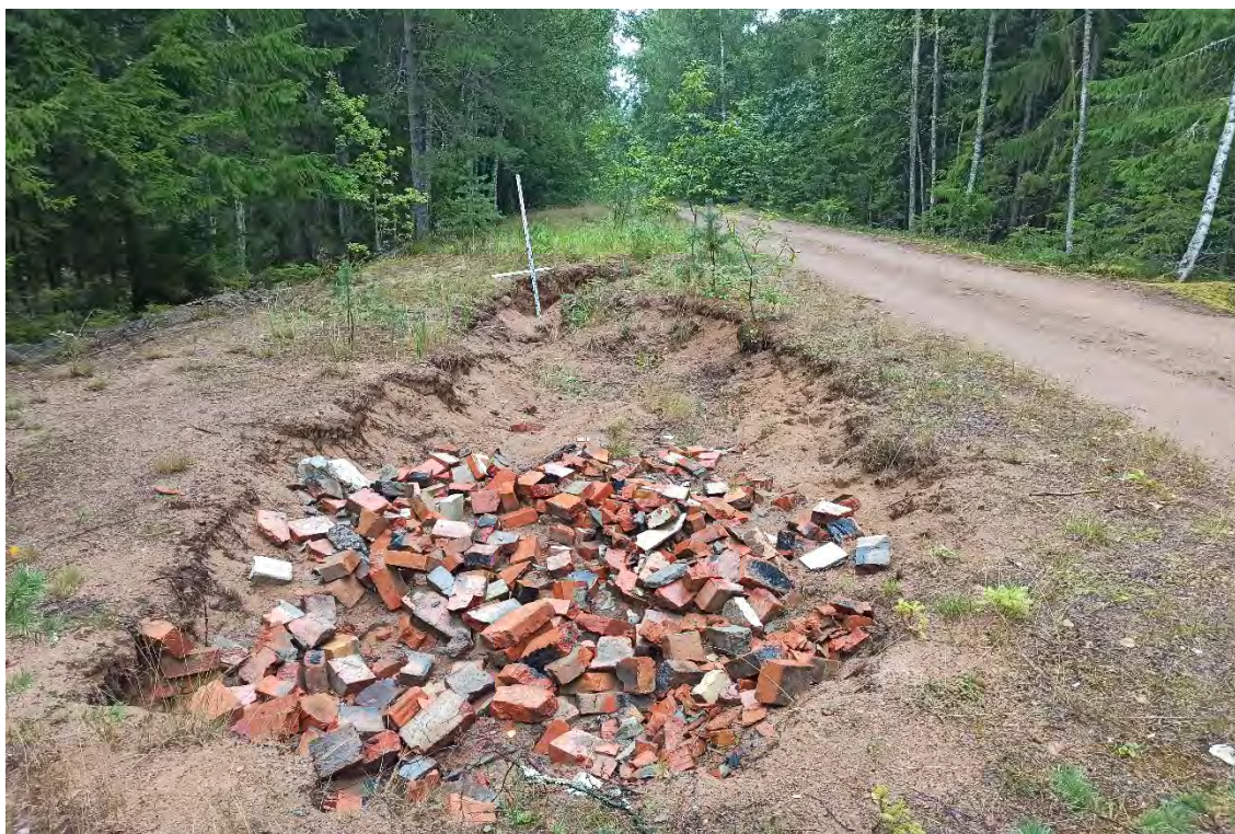
Рис.85. Ленинградская область, объект «Строительство кабельной волоконно-оптической линии связи мультисервисной транспортной сети связи Балтийского флота в направлении: УС 571-Д – объект 81809». Зачистка №3. Месторасположение. Вид с запада.
