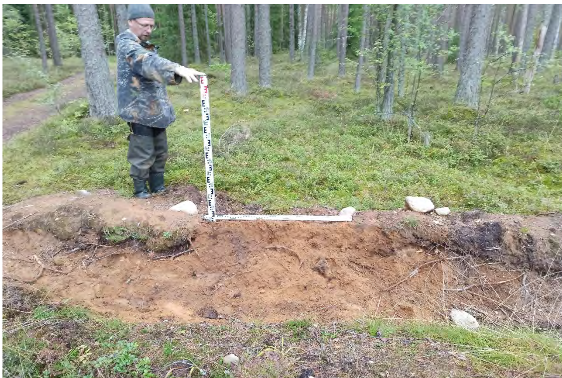
Рис.77. Ленинградская область, объект «Строительство кабельной волоконно-оптической линии связи мультисервисной транспортной сети связи Балтийского флота в направлении: УС 571-Д – объект 81809». Зачистка №1. Общий вид после рекультивации. Вид с запада.
