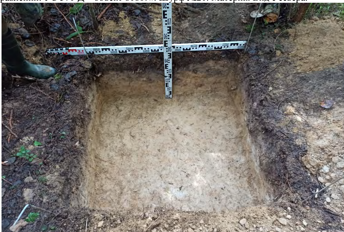
Рис.304. Ленинградская область, объект «Строительство кабельной волоконно-оптической линии связи мультисервисной транспортной сети связи Балтийского флота в направлении: УС 571-Д – объект 81809». Шурф №21. Контрольный прокоп материка. Вид с севера.
