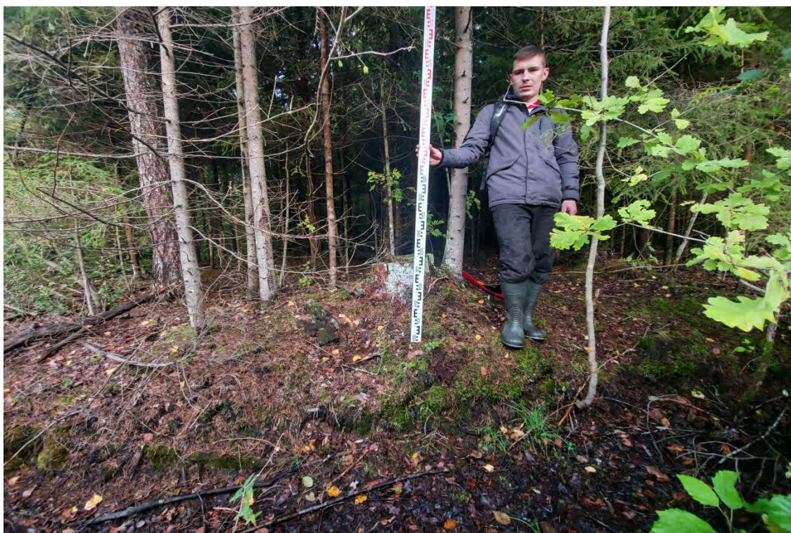
Рис.347. Ленинградская область, объект «Строительство кабельной волоконно-оптической линии связи мультисервисной транспортной сети связи Балтийского флота в направлении: УС 571-Д – объект 81809». Зачистка №26. Месторасположение/ до начала работ. Вид с запада.
