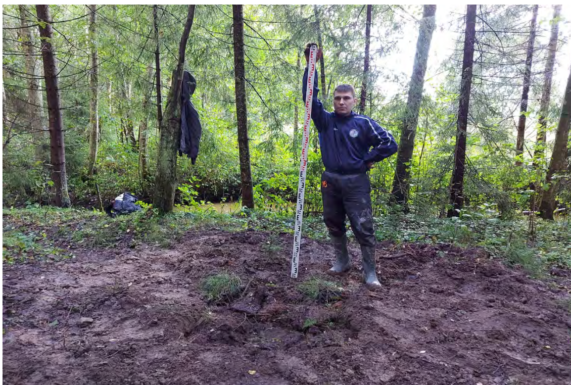
Рис.329. Ленинградская область, объект «Строительство кабельной волоконно-оптической линии связи мультисервисной транспортной сети связи Балтийского флота в направлении: УС 571-Д – объект 81809». Шурф №24. После рекультивации. Вид с юга.
