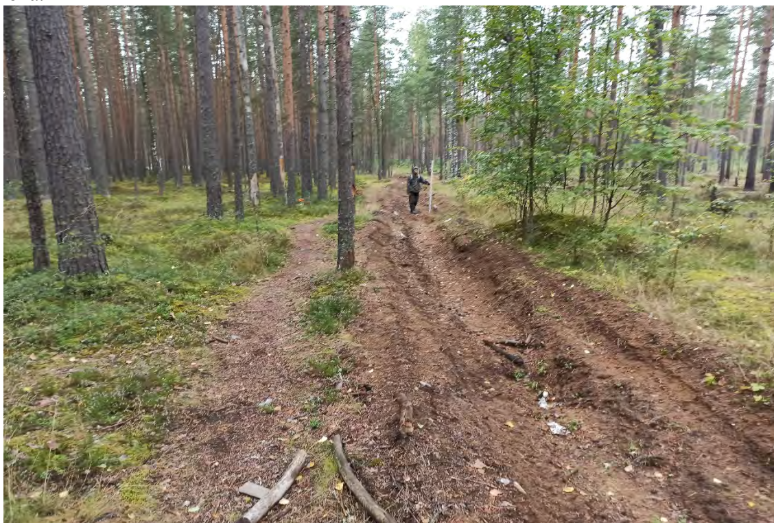
Рис.121. Ленинградская область, объект «Строительство кабельной волоконно-оптической линии связи мультисервисной транспортной сети связи Балтийского флота в направлении: УС 571-Д – объект 81809». Зачистка №5. Месторасположение. Вид с северо-востока.
