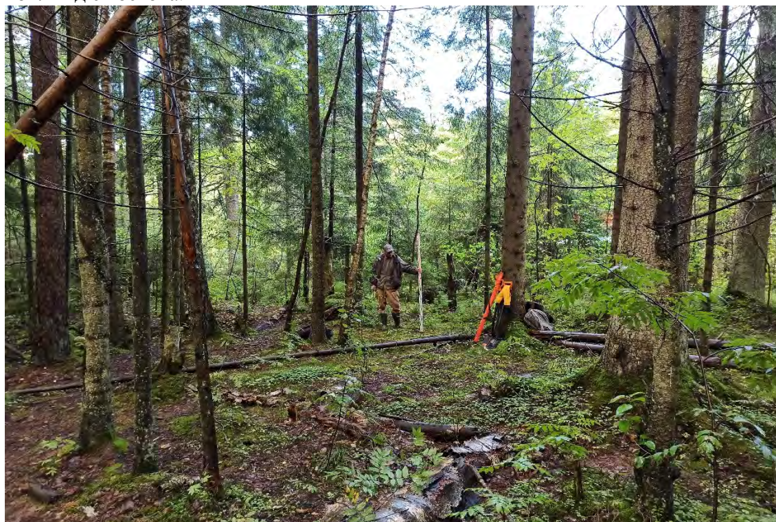
Рис.264. Ленинградская область, объект «Строительство кабельной волоконно-оптической линии связи мультисервисной транспортной сети связи Балтийского флота в направлении: УС 571-Д – объект 81809». Шурф №16. Месторасположение. Вид с юго - востока.
