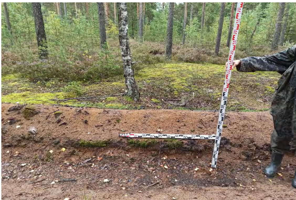
Рис.126. Ленинградская область, объект «Строительство кабельной волоконно-оптической линии связи мультисервисной транспортной сети связи Балтийского флота в направлении: УС 571-Д – объект 81809». Зачистка №6. Общий вид перед началом работ. Вид с запада.
