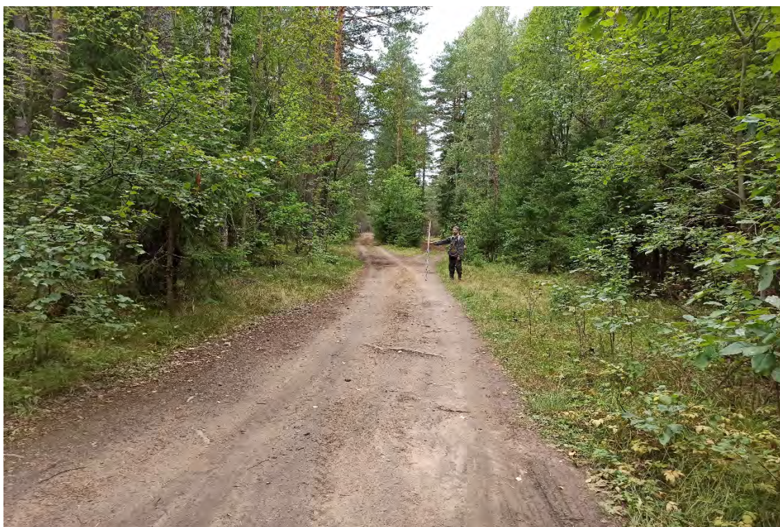
Рис.118. Ленинградская область, объект «Строительство кабельной волоконно-оптической линии связи мультисервисной транспортной сети связи Балтийского флота в направлении: УС 571-Д – объект 81809». ТФ №19. Проектируемая трасса ВОЛС. Вид с севера.
