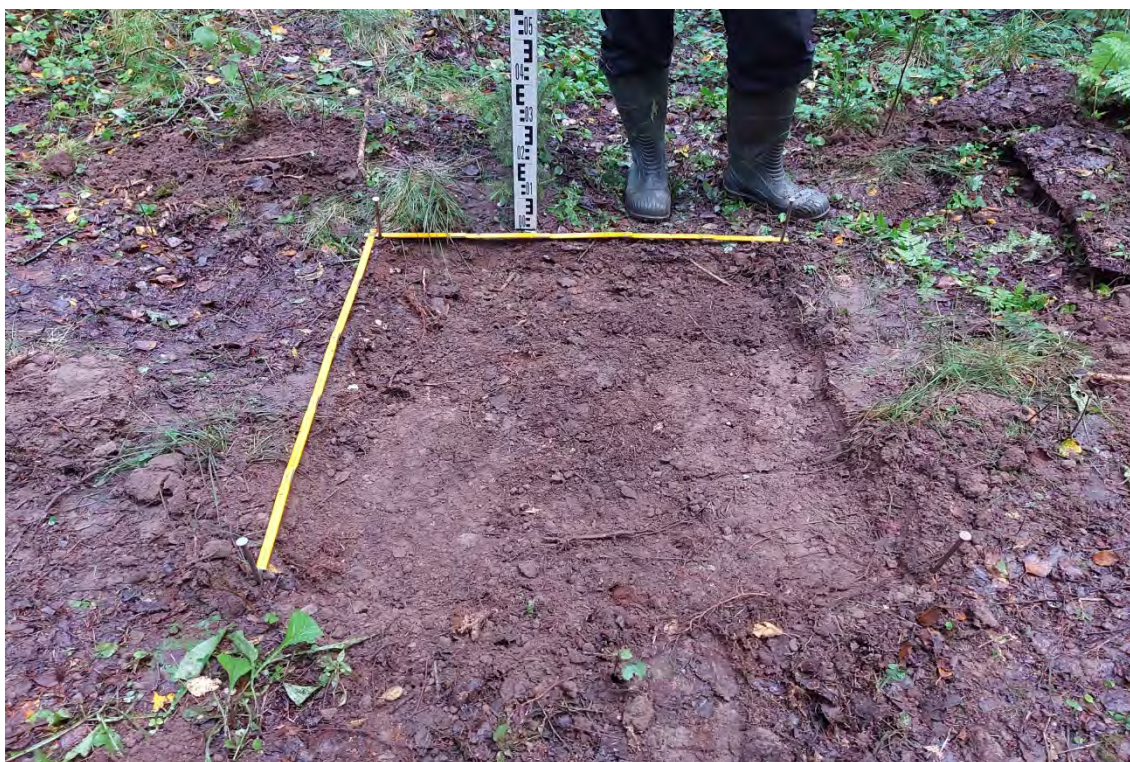
Рис.325. Ленинградская область, объект «Строительство кабельной волоконно-оптической линии связи мультисервисной транспортной сети связи Балтийского флота в направлении: УС 571-Д – объект 81809». Шурф №24. После снятия дерна. Вид с юга.
