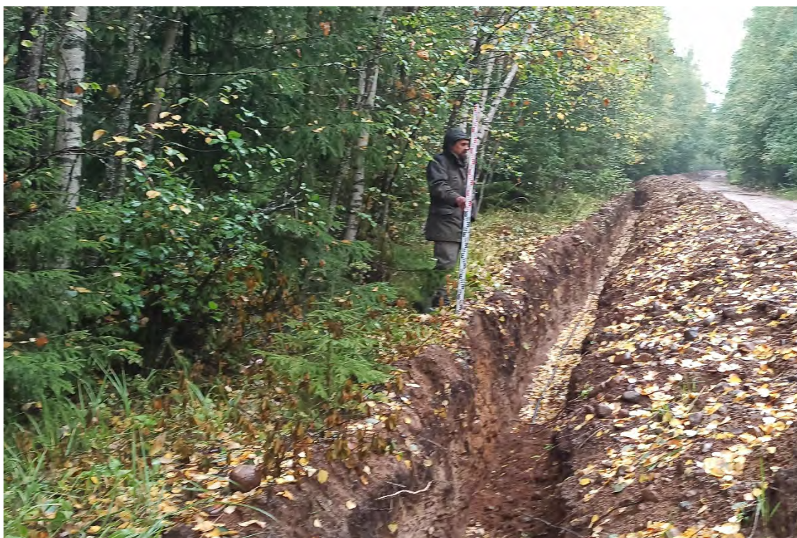
Рис.225 Ленинградская область, объект «Строительство кабельной волоконно-оптической линии связи мультисервисной транспортной сети связи Балтийского флота в направлении: УС 571-Д – объект 81809». Зачистка №16. Месторасположение. Вид с юго - юго - востока.
