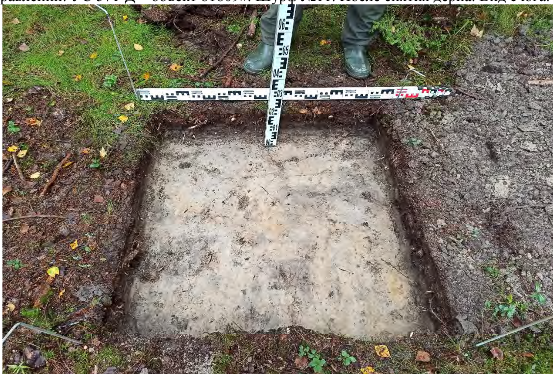
Рис.171. Ленинградская область, объект «Строительство кабельной волоконно-оптической линии связи мультисервисной транспортной сети связи Балтийского флота в направлении: УС 571-Д – объект 81809». Шурф №11. Материк. Вид с юга.
