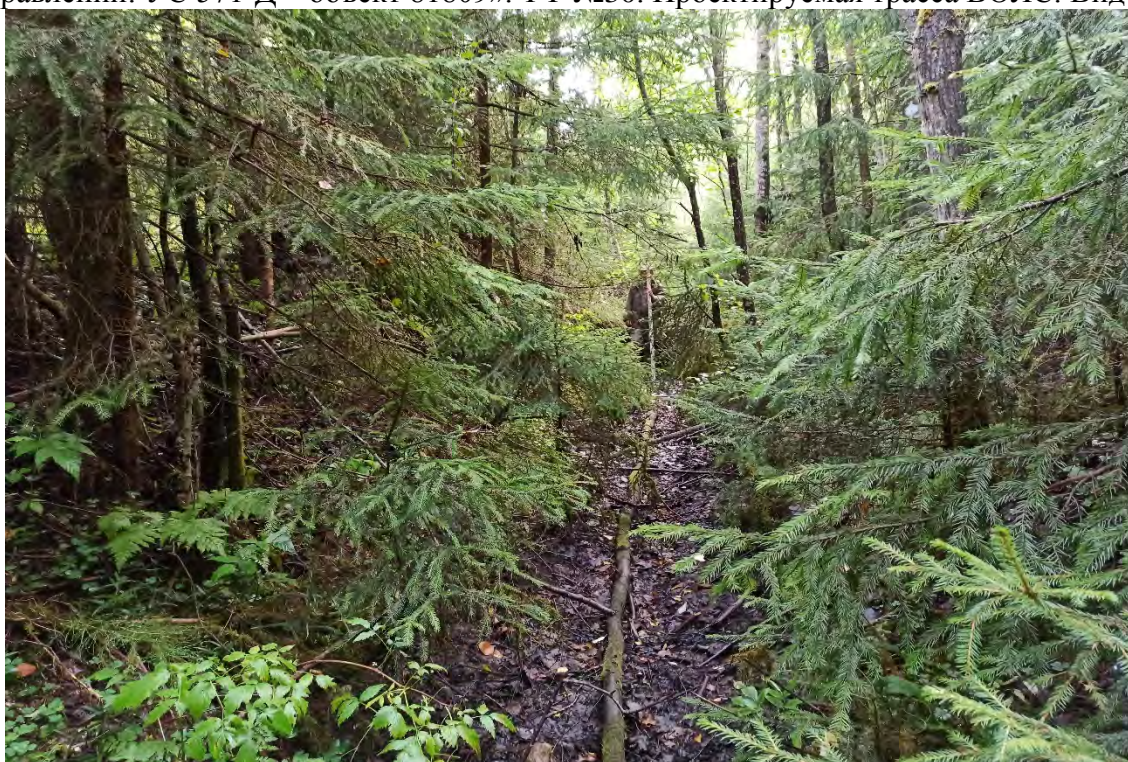
Рис.187. Ленинградская область, объект «Строительство кабельной волоконно-оптической линии связи мультисервисной транспортной сети связи Балтийского флота в направлении: УС 571-Д – объект 81809». ТФ №30. Проектируемая трасса ВОЛС. Вид с запада.
