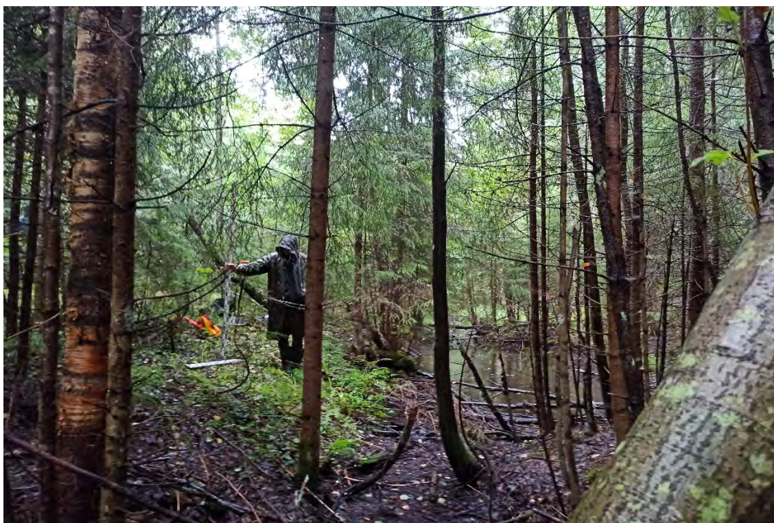
Рис.197. Ленинградская область, объект «Строительство кабельной волоконно-оптической линии связи мультисервисной транспортной сети связи Балтийского флота в направлении: УС 571-Д – объект 81809». Зачистка №10. Месторасположение. Вид с запада.
