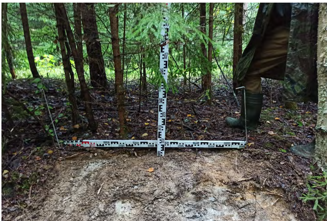
Рис.178. Ленинградская область, объект «Строительство кабельной волоконно-оптической линии связи мультисервисной транспортной сети связи Балтийского флота в направлении: УС 571-Д – объект 81809». Зачистка №8. Общий вид после рекультивации. Вид с юга.
