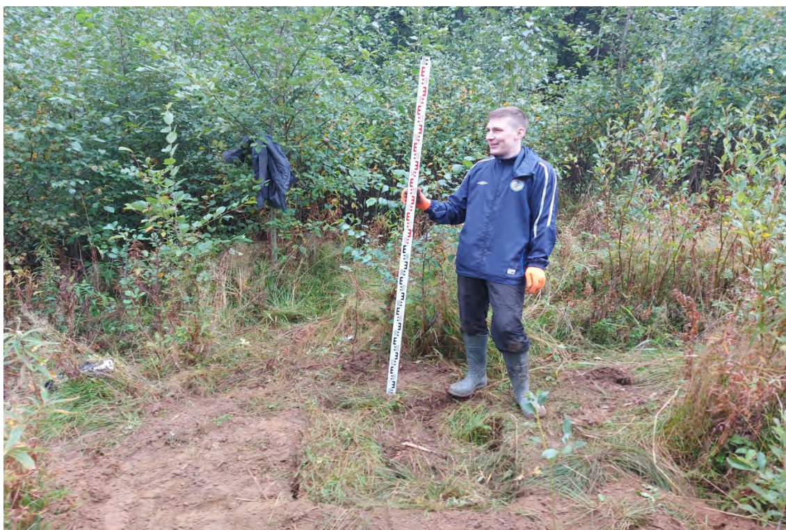
Рис.313. Ленинградская область, объект «Строительство кабельной волоконно-оптической линии связи мультисервисной транспортной сети связи Балтийского флота в направлении: УС 571-Д – объект 81809».Шурф №22. После рекультивации. Вид с юга.
