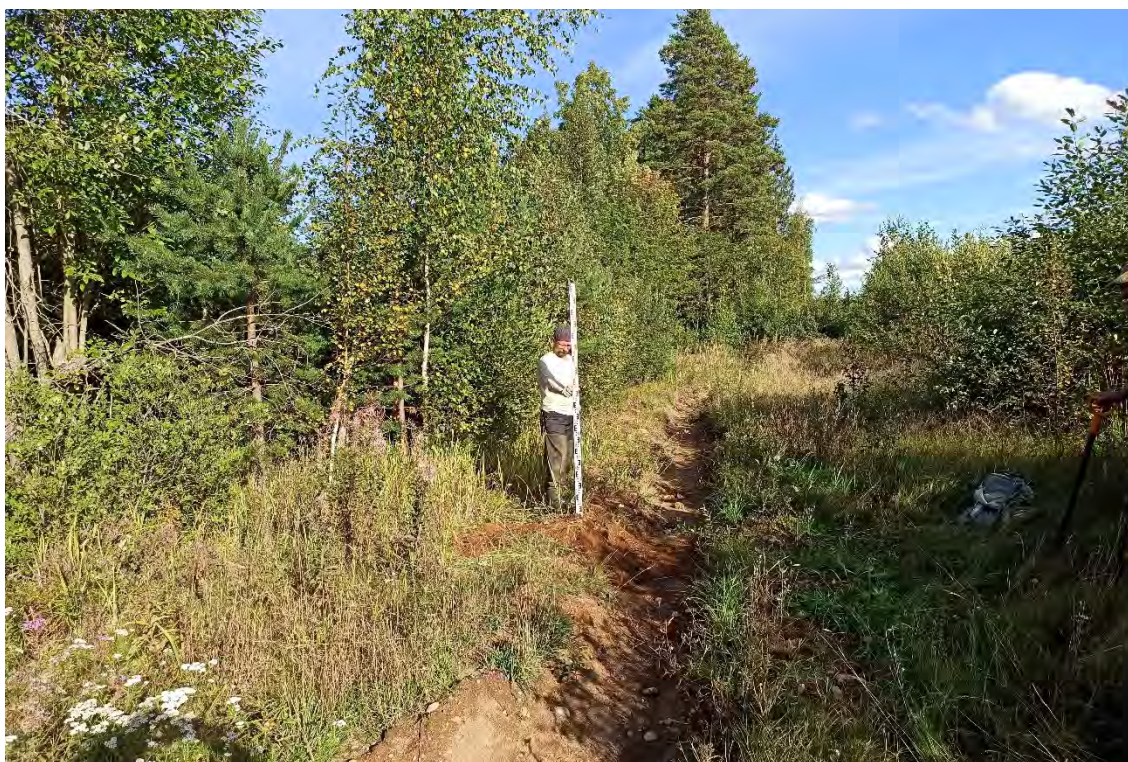
Рис.241. Ленинградская область, объект «Строительство кабельной волоконно-оптической линии связи мультисервисной транспортной сети связи Балтийского флота в направлении: УС 571-Д – объект 81809». Зачистка №20. Общий вид после рекультивации. Вид с запада.
