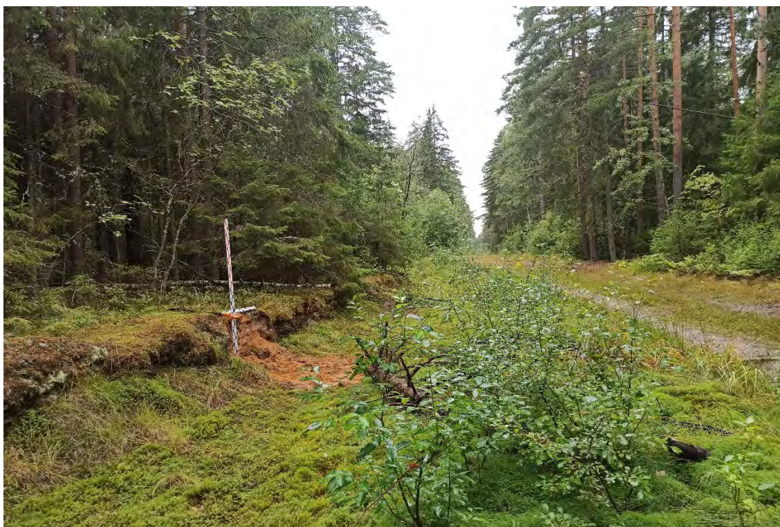
Рис.108. Ленинградская область, объект «Строительство кабельной волоконно-оптической линии связи мультисервисной транспортной сети связи Балтийского флота в направлении: УС 571-Д – объект 81809». Зачистка №4. Общий вид после рекультивации. Вид с восток - северо - востока.
