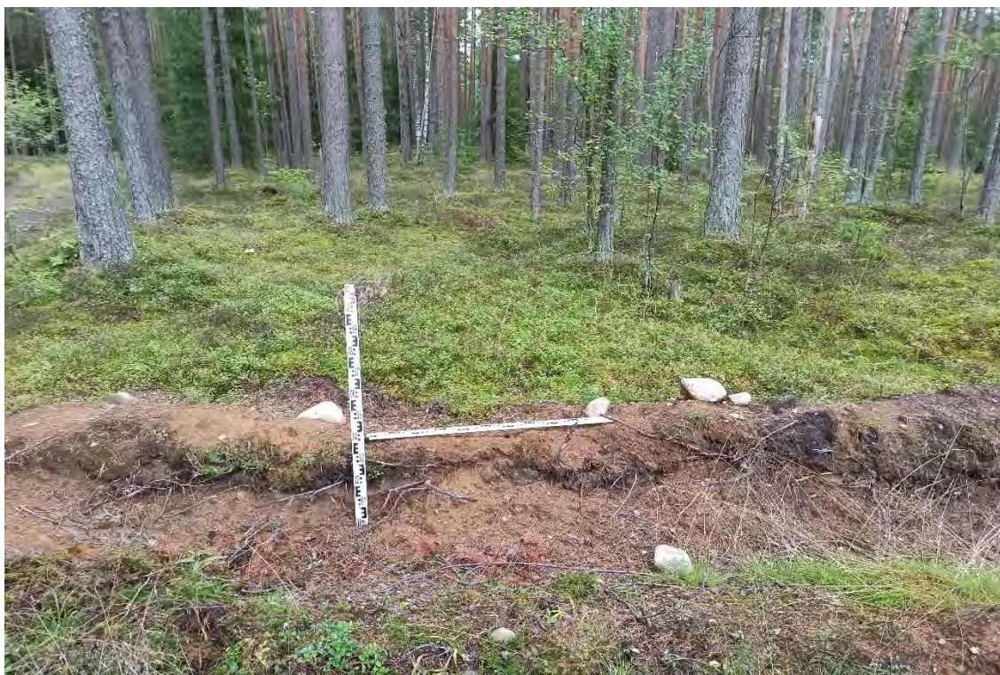
Рис.75. Ленинградская область, объект «Строительство кабельной волоконно-оптической линии связи мультисервисной транспортной сети связи Балтийского флота в направлении: УС 571-Д – объект 81809». Зачистка №1. Общий вид перед началом работ. Вид с запада.
