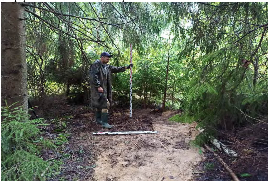
Рис.306. Ленинградская область, объект «Строительство кабельной волоконно-оптической линии связи мультисервисной транспортной сети связи Балтийского флота в направлении: УС 571-Д – объект 81809». Шурф №21. Общий вид шурфа после рекультивации. Вид с севера.
