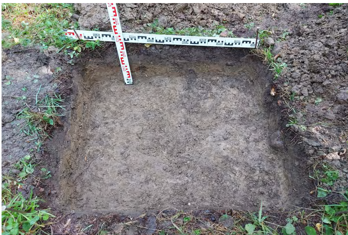
Рис.368. Петродворцовый район Санкт-Петербурга, объект «Строительство кабельной волоконно-оптической линии связи мультисервисной транспортной сети связи Балтийского флота в направлении: УС 571-Д – объект 81809». Шурф №27. Контрольный прокоп материка. Вид с юга.
