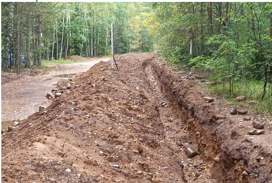
Рис.224. Ленинградская область, объект «Строительство кабельной волоконно-оптической линии связи мультисервисной транспортной сети связи Балтийского флота в направлении: УС 571-Д – объект 81809». ТФ №40. Проектируемая трасса ВОЛС. Участок с уже проложенным кабелем. Вид с северо - северо - запада.
