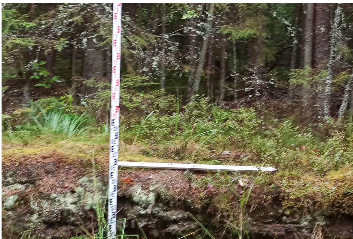
Рис.106. Ленинградская область, объект «Строительство кабельной волоконно-оптической линии связи мультисервисной транспортной сети связи Балтийского флота в направлении: УС 571-Д – объект 81809». Зачистка №4. Общий вид перед началом работ. Вид с севера.
