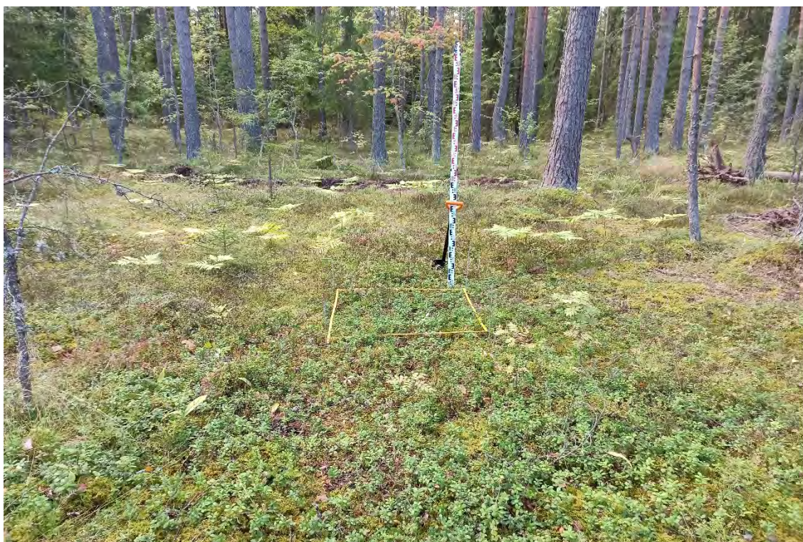
Рис.110. Ленинградская область, объект «Строительство кабельной волоконно-оптической линии связи мультисервисной транспортной сети связи Балтийского флота в направлении: УС 571-Д – объект 81809». Шурф №6. Общий вид перед началом работ. Вид с востока.
