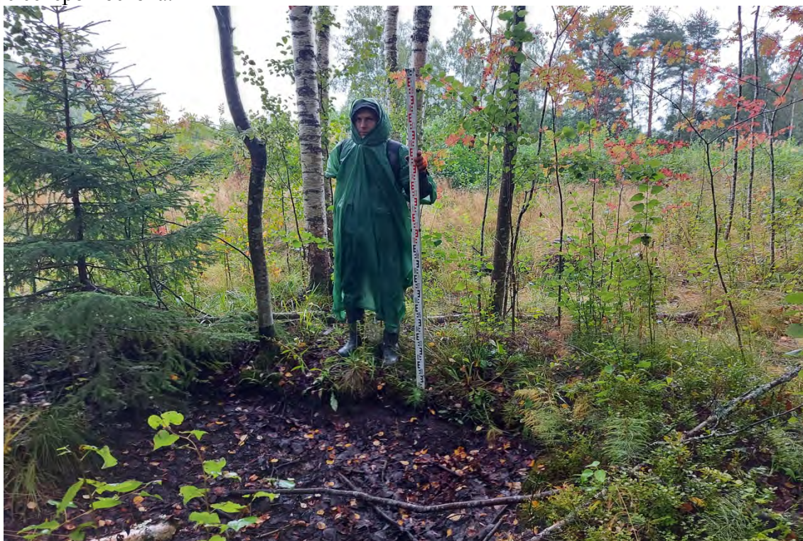
Рис.338. Ленинградская область, объект «Строительство кабельной волоконно-оптической линии связи мультисервисной транспортной сети связи Балтийского флота в направлении: УС 571-Д – объект 81809». Зачистка №24. Месторасположение/ до начала работ. Вид с запада.
