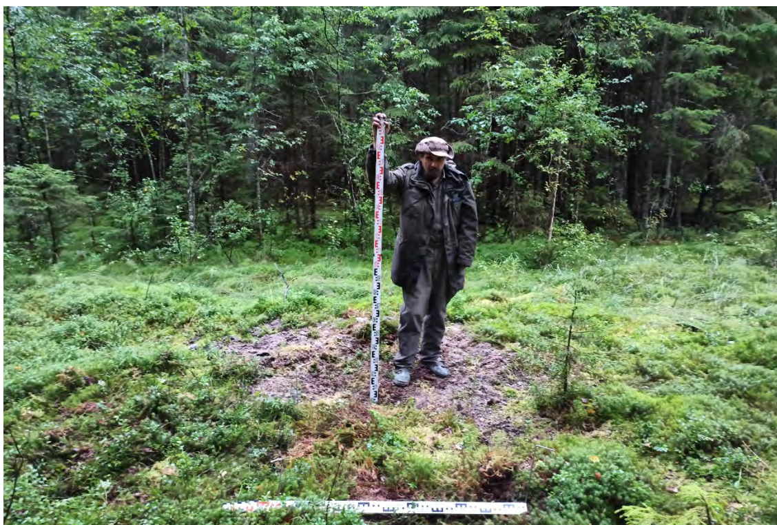
Рис.150. Ленинградская область, объект «Строительство кабельной волоконно-оптической линии связи мультисервисной транспортной сети связи Балтийского флота в направлении: УС 571-Д – объект 81809». Шурф №8. Общий вид шурфа после рекультивации. Вид с запада.
