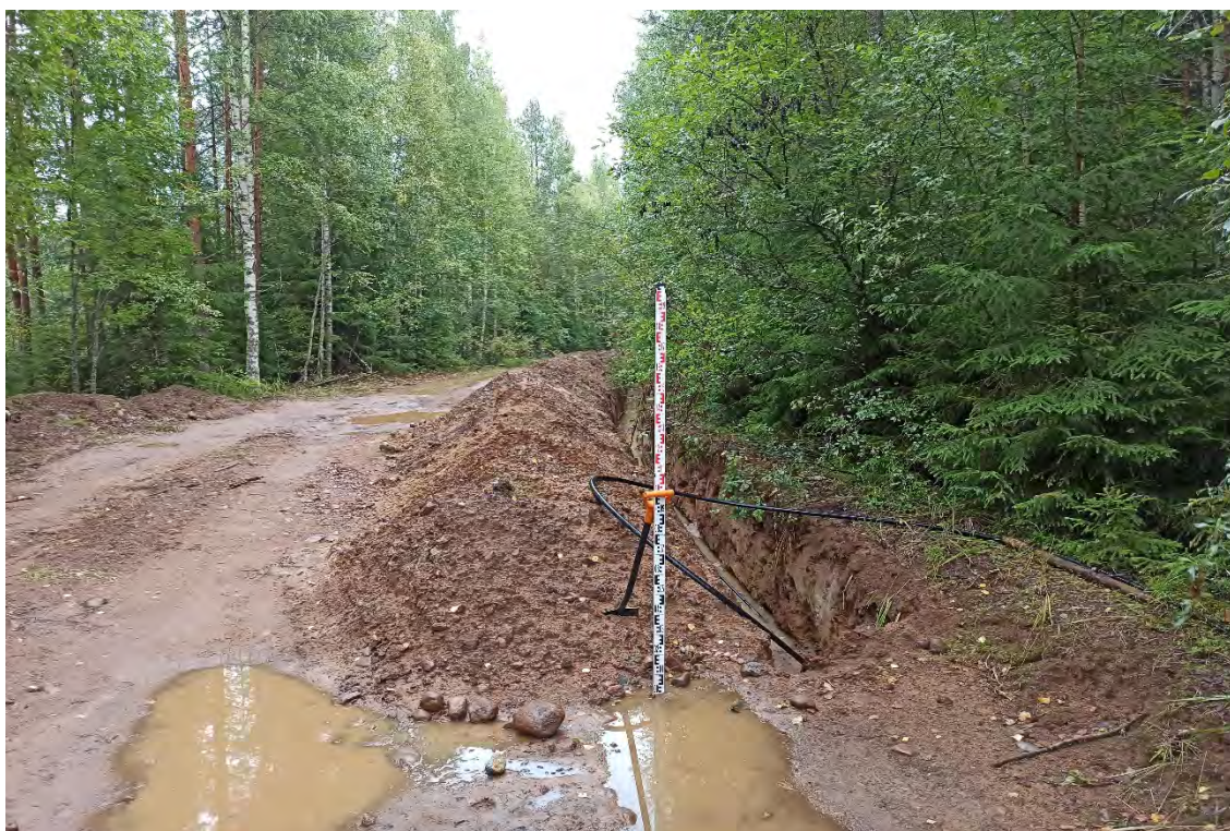
Рис.219 Ленинградская область, объект «Строительство кабельной волоконно-оптической линии связи мультисервисной транспортной сети связи Балтийского флота в направлении: УС 571-Д – объект 81809». ТФ №37. Проектируемая трасса ВОЛС. Участок с уже проложенным кабелем. Вид с юго-запада.
