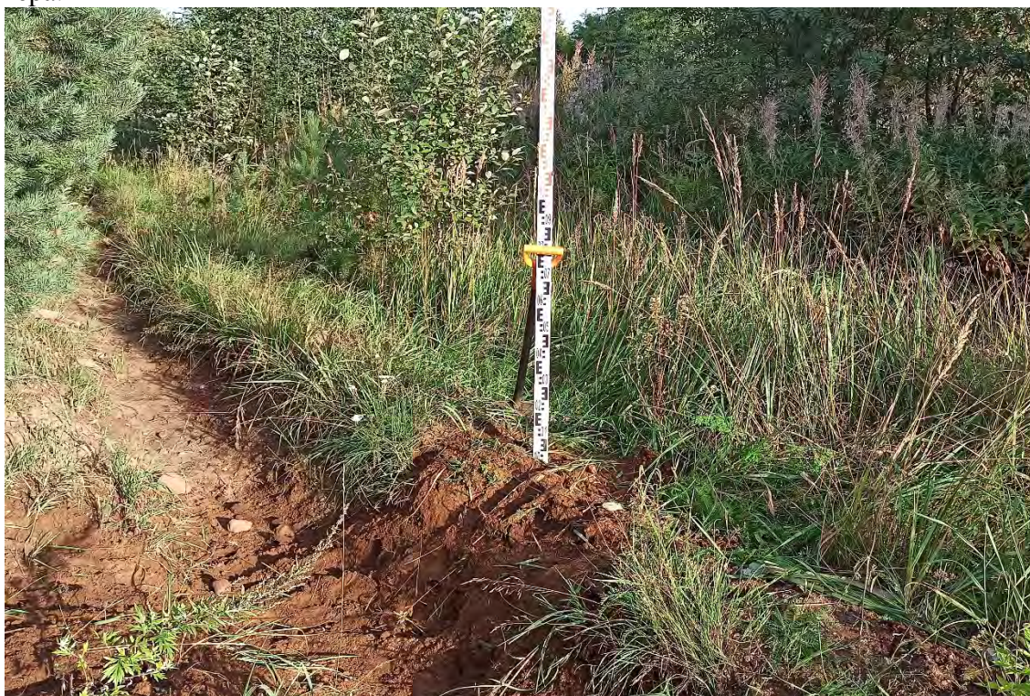
Рис.236 Ленинградская область, объект «Строительство кабельной волоконно-оптической линии связи мультисервисной транспортной сети связи Балтийского флота в направлении: УС 571-Д – объект 81809». Зачистка №19. Общий вид после рекультивации. Вид с запада.
