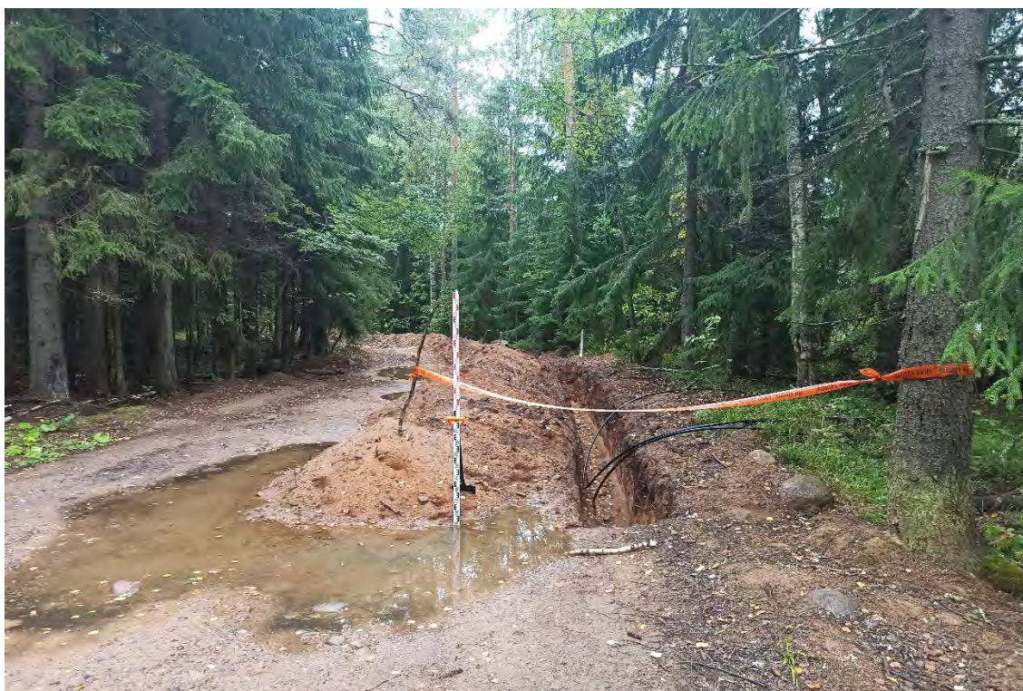
Рис.221. Ленинградская область, объект «Строительство кабельной волоконно-оптической линии связи мультисервисной транспортной сети связи Балтийского флота в направлении: УС 571-Д – объект 81809». ТФ №39. Проектируемая трасса ВОЛС. Участок с уже проложенным кабелем. Вид с северо - северо - запада.
