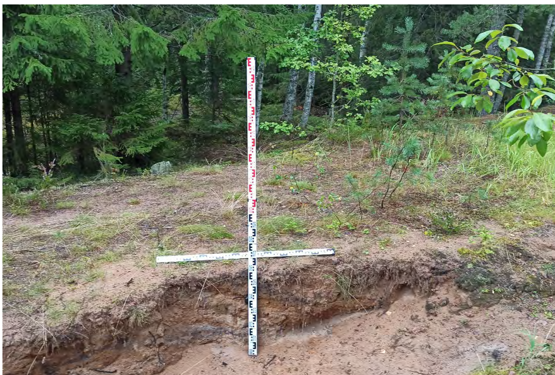
Рис.86. Ленинградская область, объект «Строительство кабельной волоконно-оптической линии связи мультисервисной транспортной сети связи Балтийского флота в направлении: УС 571-Д – объект 81809». Зачистка №3. Общий вид перед началом работ. Вид с юго-запада.
