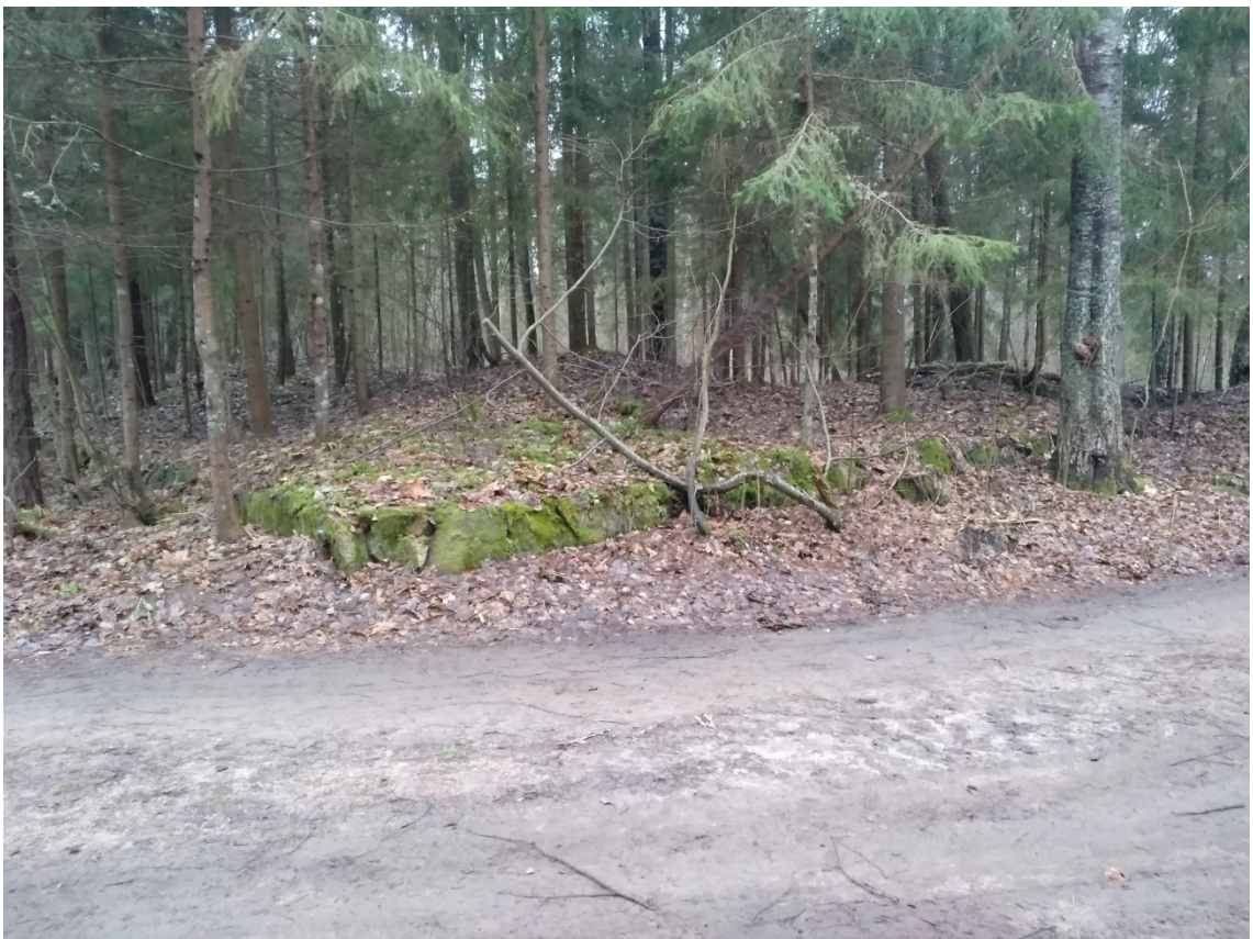
42. Северная часть территории. Вид на северо-запад. Фрагмент фундамента.
