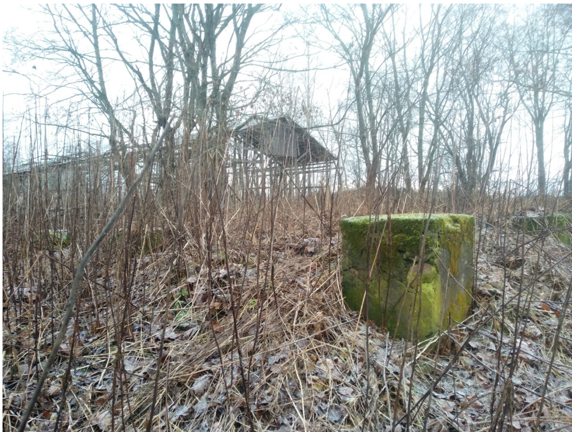
7. Северо-восточная часть парка. Фрагмент фундамента.
