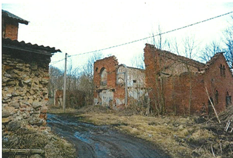
Вид на производственный корпус. Фото 28.03.2021 года.
