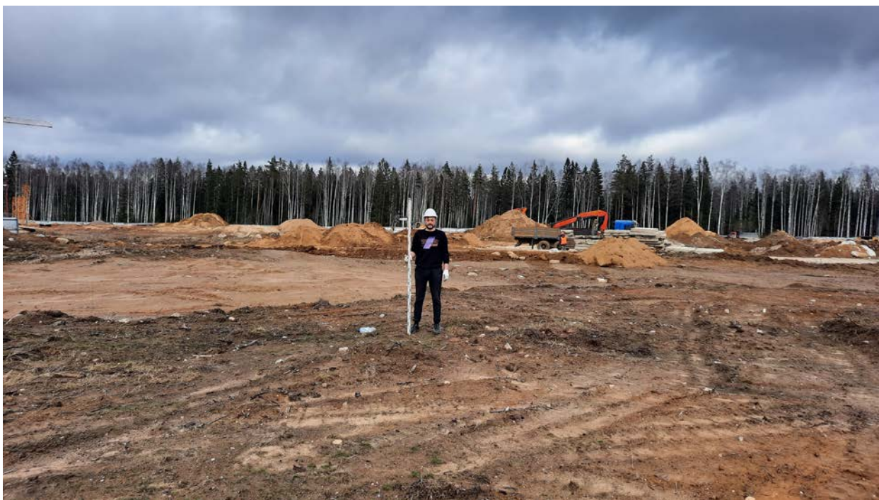
Илл.17. Ленинградская область. Всеволожский район. г. Сердолово. Земельный участок с кадастровым номером 47:08:0103002:2342. 2021 г. Точка фотофиксации 5.
