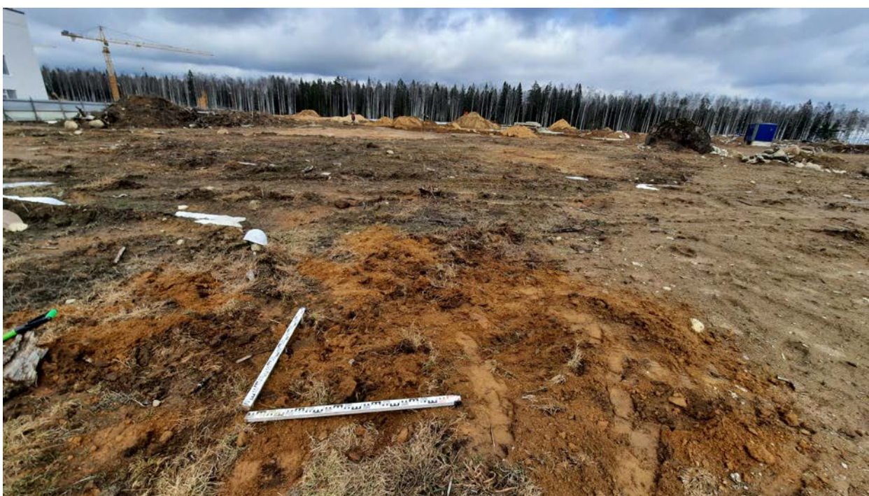
Илл.26. Ленинградская область. Всеволожский район. г. Сертолово. Земельный участок с кадастровым номером 47:08:0103002:2342. 2021 г. Шурф 1. Рекультивация. Вид с Ю.
