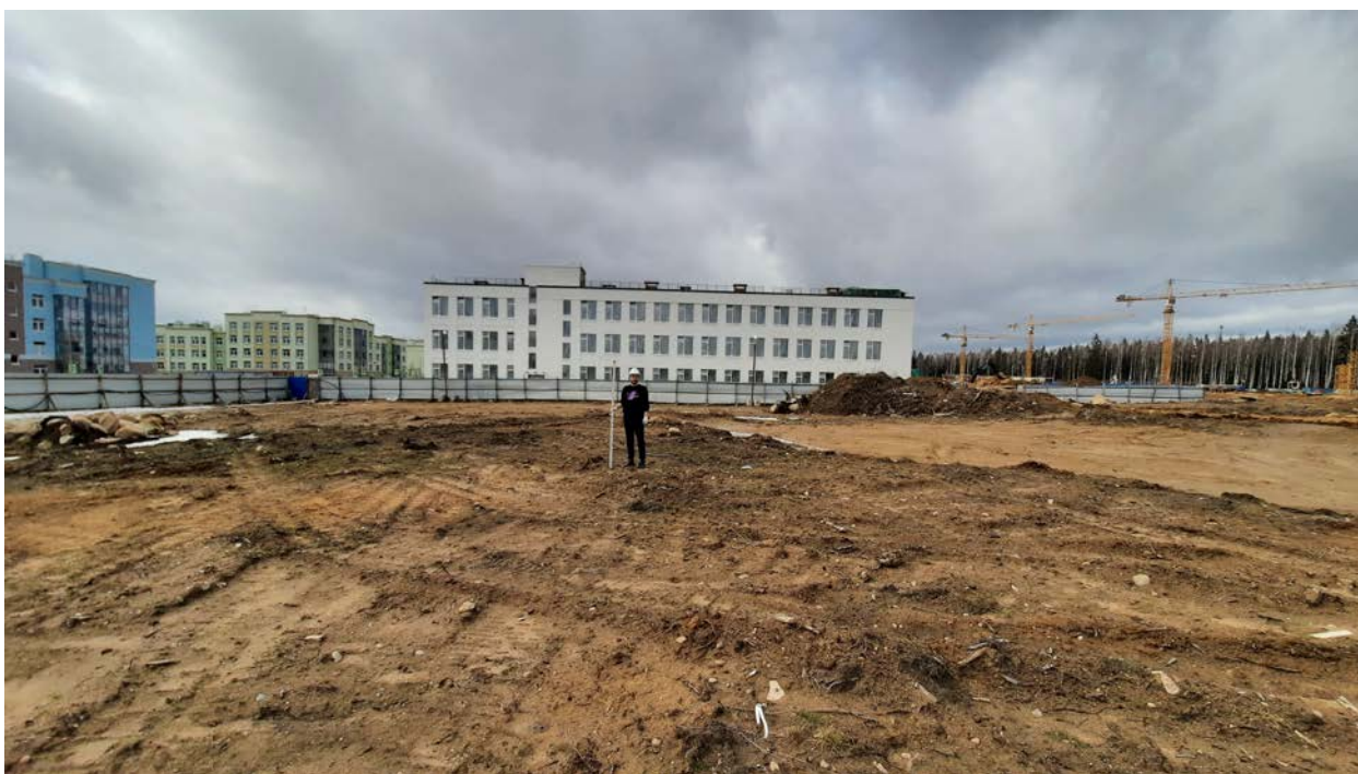
Илл.18. Ленинградская область. Всеволожский район. г. Сердолово. Земельный участок с кадастровым номером 47:08:0103002:2342. 2021 г. Точка фотофиксации 6.
