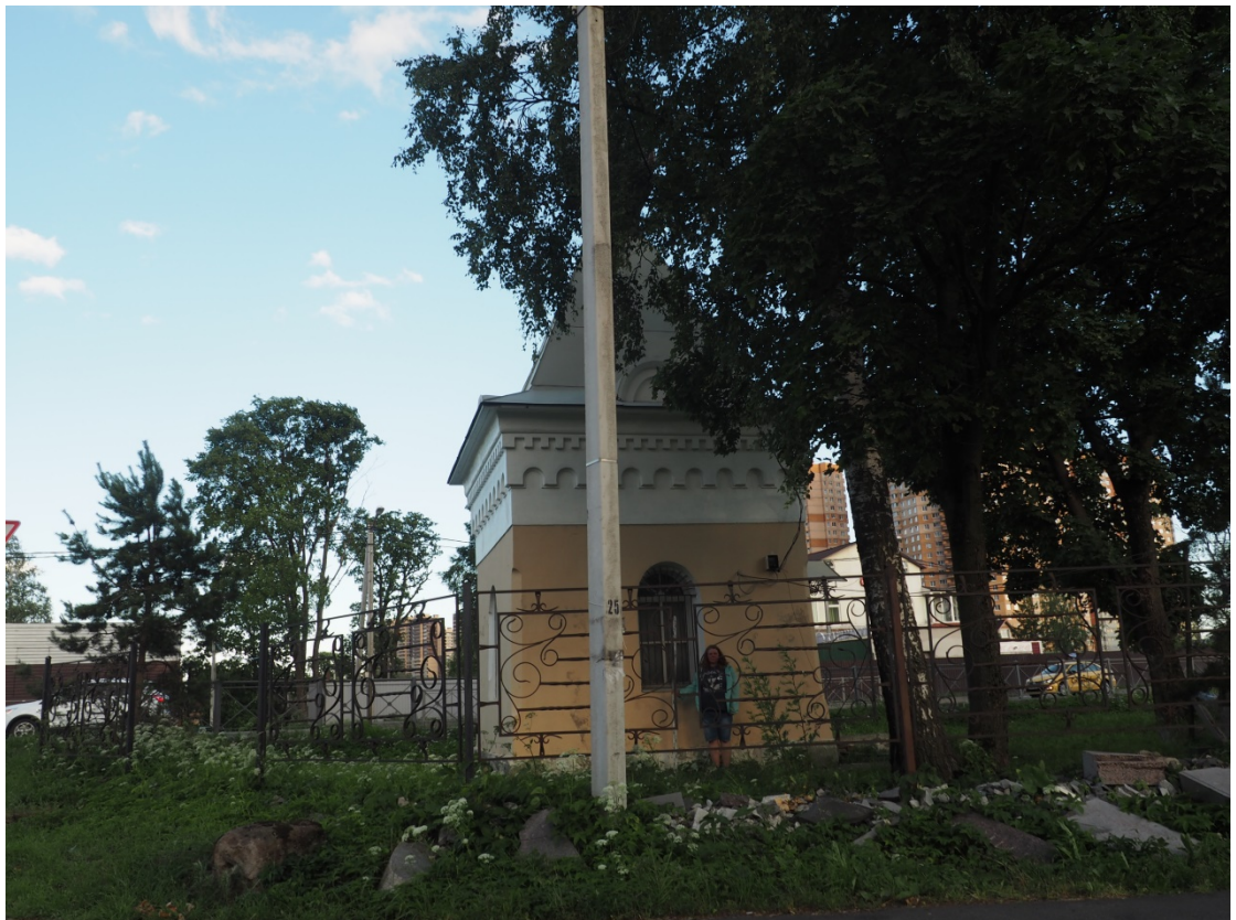
Илл. 20. Ленинградская обл., Всеволожский р-н, г. Мурино. ОКН «Часовня «В память императора Александра II». Точка фотофиксации 10. Вид с севера.
