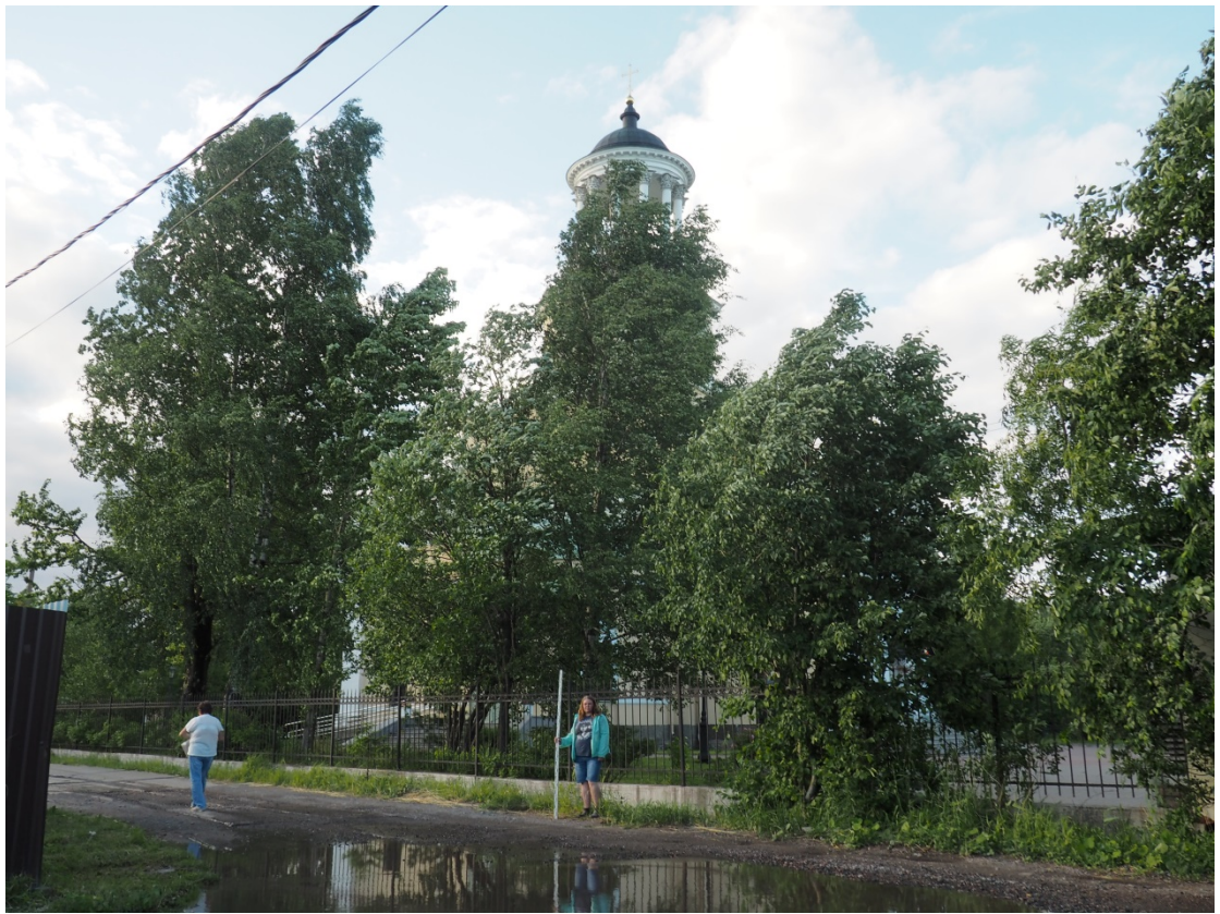
Илл. 15. Ленинградская обл., Всеволожский р-н, г. Мурино. ОКН «Церковь Святой Великомученицы Екатерины». Точка фотофиксации 5. Вид с юга.
