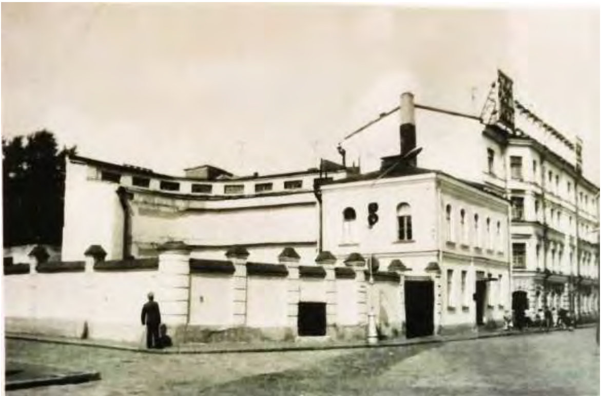
Илл. 21. Здание Полицейского управления. Фото 1982 г.
