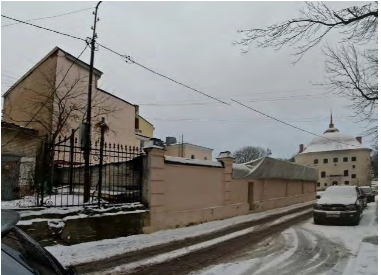
Фото 18. Вид с Прогонной ул. в юго-восточном направлении на территорию земельного участка 47:01:0107001:35, створ Прогонной ул. и Круглую башню.
