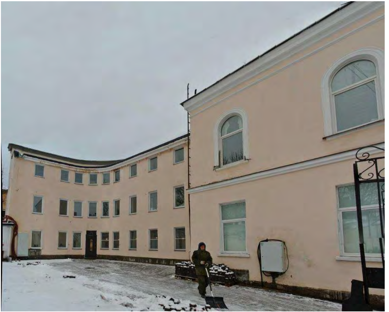
Фото 9. Территория внутреннего двора (земельный участок 47:01:0107001:35). Вид в северо-восточном направлении на дворовой фасад здания по адресу: Красноармейская, д. 20.
