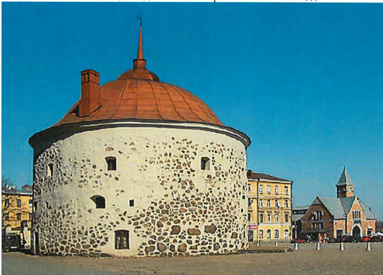
Фото 1. Общий вид объекта со стороны Рыночной площади
