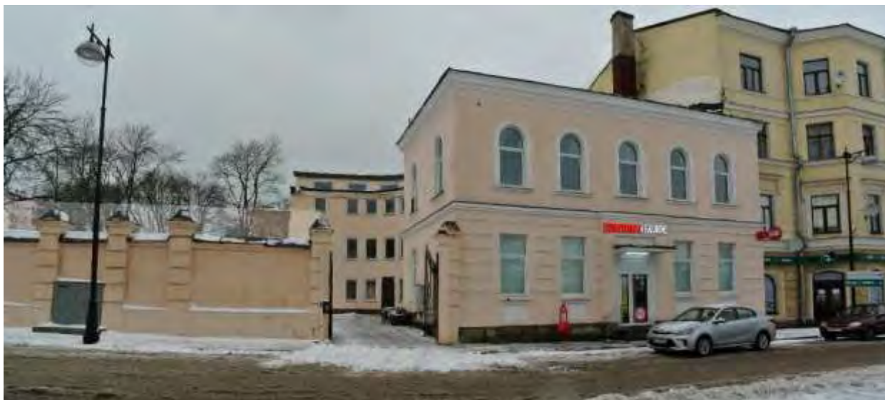
Рис. 1. Вид в северо-западном направлении на здания по адресу: Красноармейская ул., д. 20 и д. 21 с Рыночной площади.
