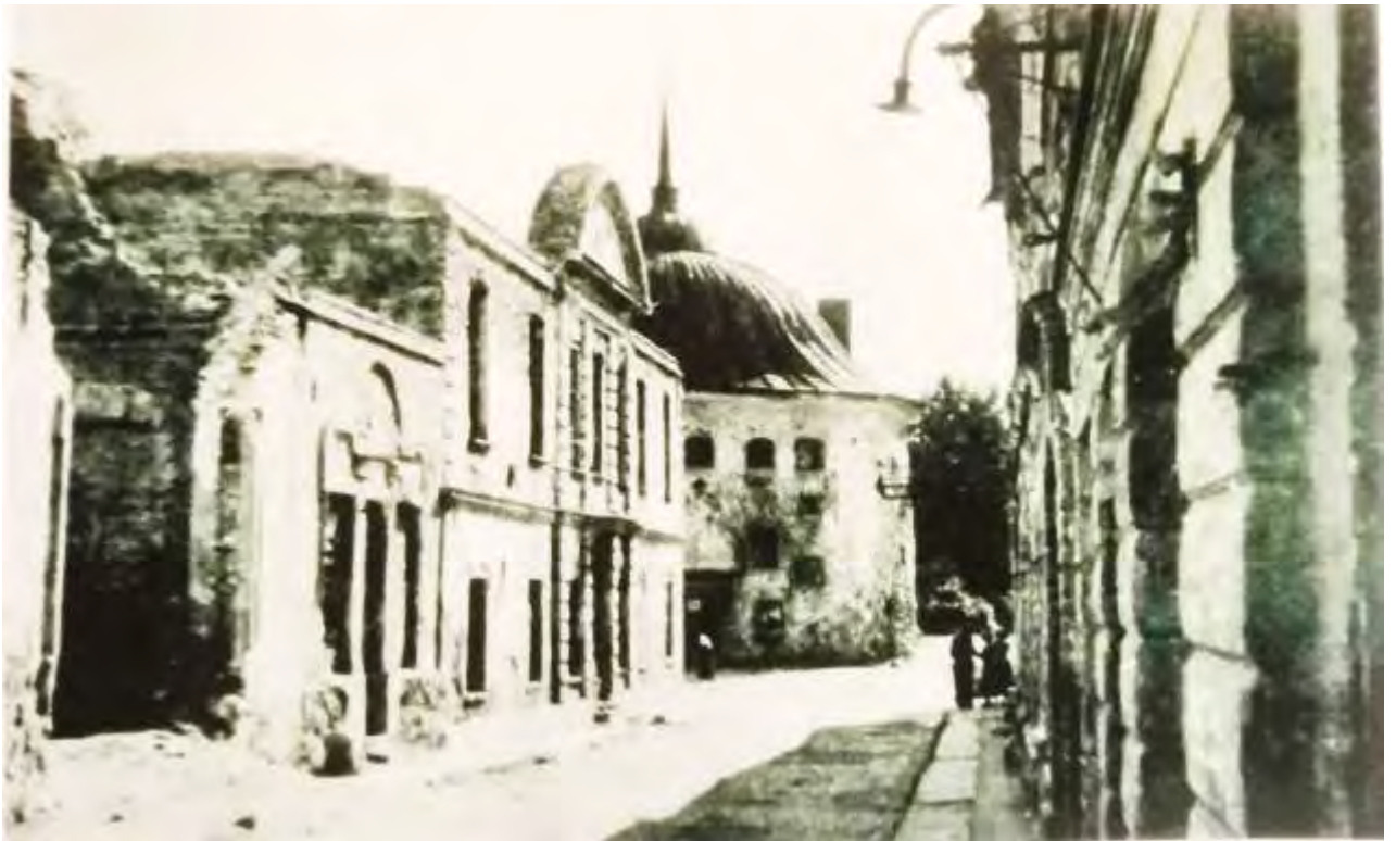
Илл. 20. Здание Полицейского управления. Разрушенный корпус по Прогонной улице. Фото 1954 г.
