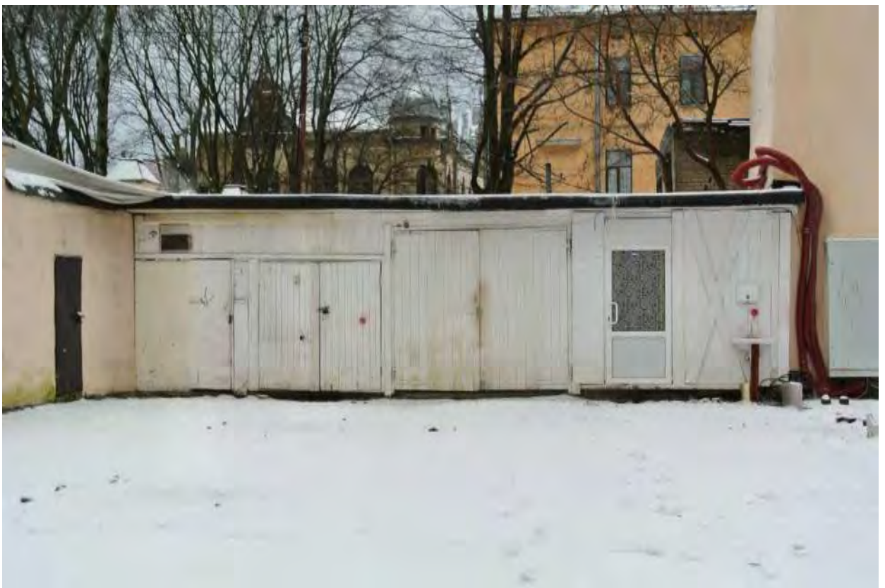
Фото 8. Территория внутреннего двора (земельный участок 47:01:0107001:35). Вид в северном направлении на здание гаража.
