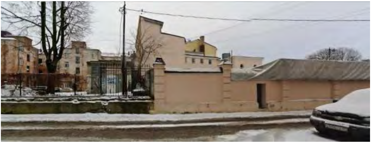
Фото 17. Вид с Прогонной ул. в северо-восточном направлении на территорию земельного участка 47:01:0107001:35, трансформаторную подстанцию на земельном участке 47:01:0107001:139 и дворовой фасад здания по адресу: ул. Северный Вал, д. 19.
