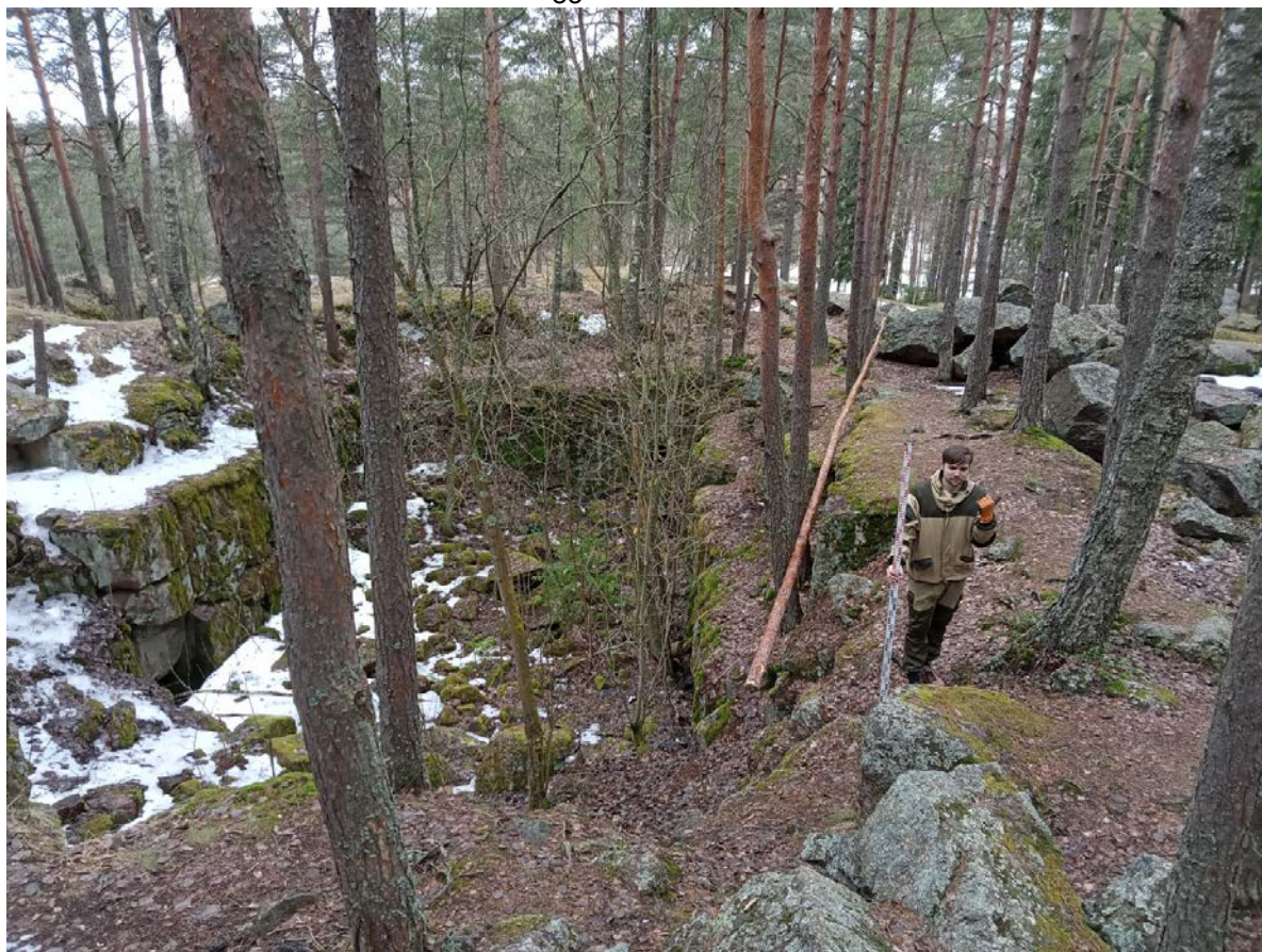
Рис. 14. Выборг-2021. М. Каменная ул., уч. КН:47:01:0108003:3190. Точка фотофиксации 2, вид на запад.
