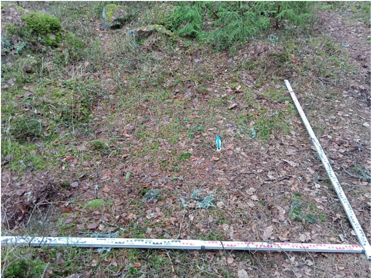
Рис. 52. Выборг-2021. М. Каменная ул., уч. КН:47:01:0108003:3190. Шурф 1, дневная поверхность до начала работ, вид на север.
