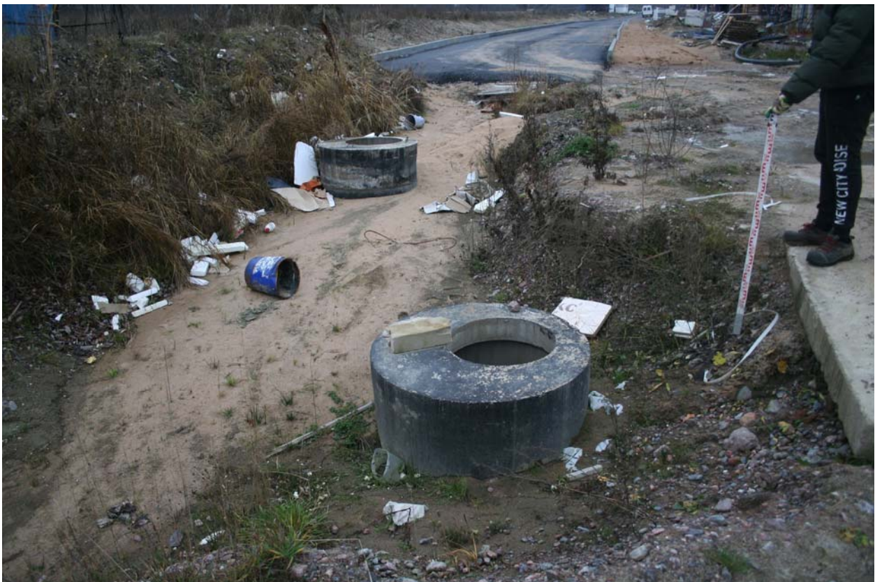
Илл. 38. Ленинградская обл., Кировский р-н, трасса обследования. Точка фотофиксации ф. 7. Проложенные инженерные коммуникации по трассе обследования. Для масштаба использована нивелировочная рейка длиной 2 м.
