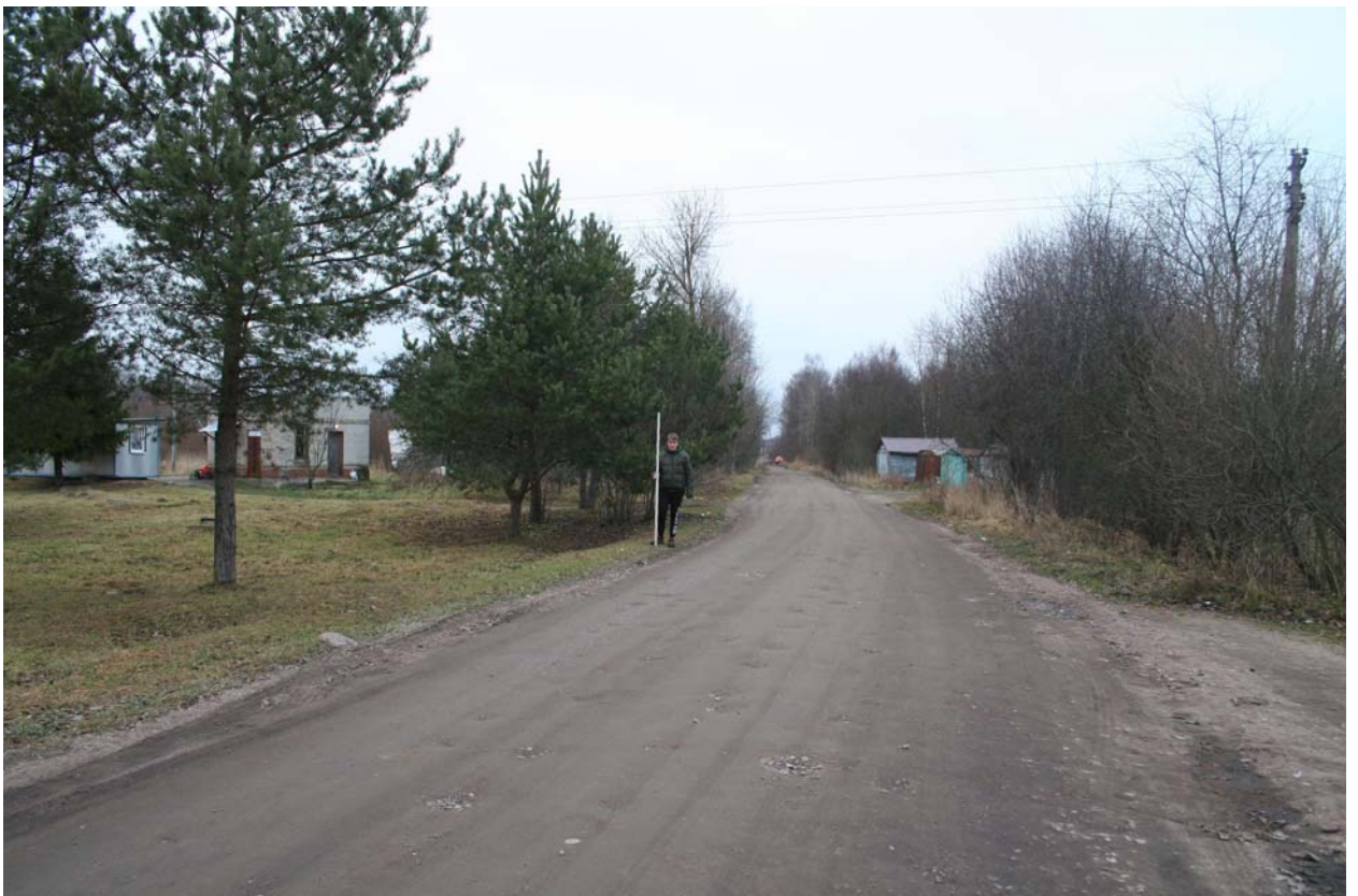
Илл. 14. Ленинградская обл., Кировский р-н, трасса обследования. Точка фотофиксации ф. 2. Общий вид трассы обследования с юга. Для масштаба использована нивелировочная рейка длиной 2 м.
