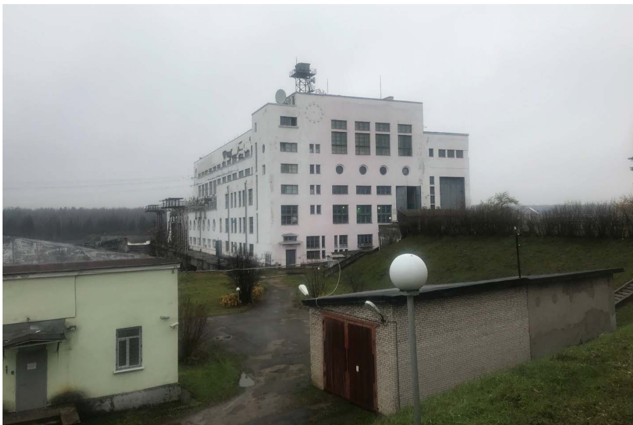
Фото 2. Вид на здание ГЭС с территории острова (с востока)
