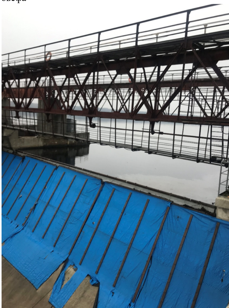
Фото 8. Вид на секторный затвор плотины со стороны нижнего бьефа
