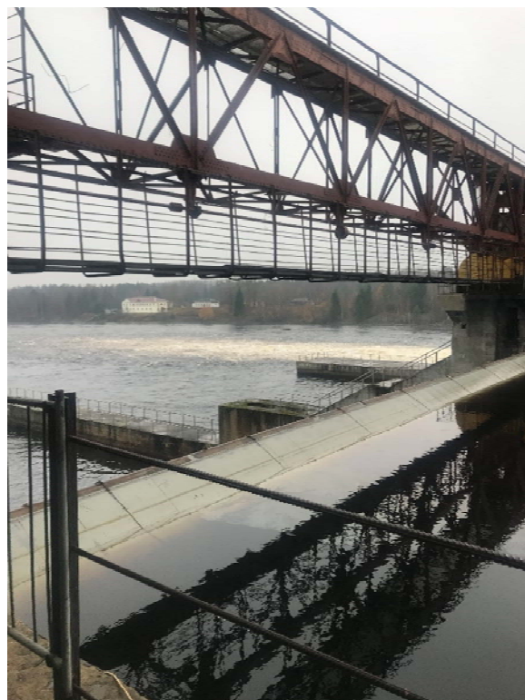
Фото 6, 7. Секторный затвор плотины. Вид от площадки у здания ГЭС, со стороны верхнего бьефа
