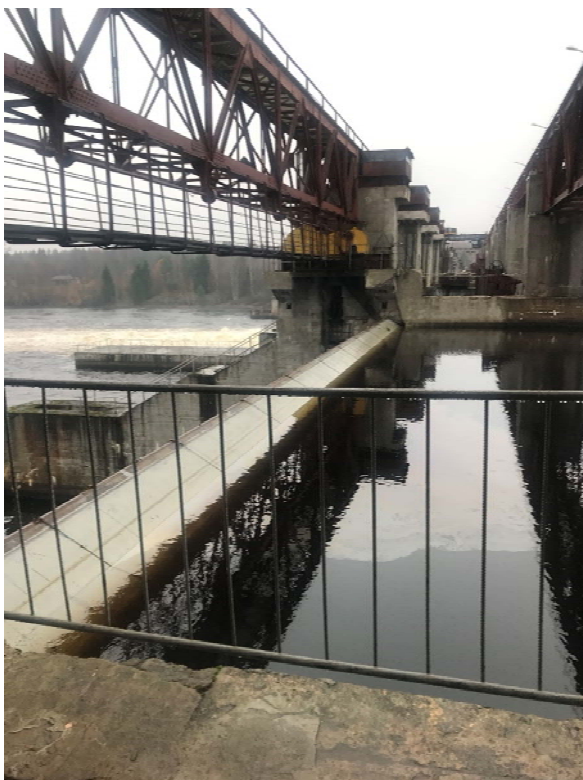
Фото 6, 7. Секторный затвор плотины. Вид от площадки у здания ГЭС, со стороны верхнего бьефа
