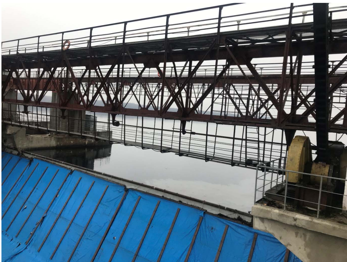
Фото 9. Вид на секторный затвор плотины со стороны нижнего бьефа
