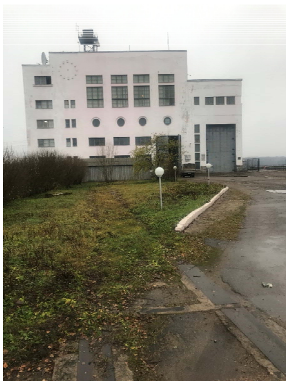
Фото 4. Восточный фасад здания ГЭС
