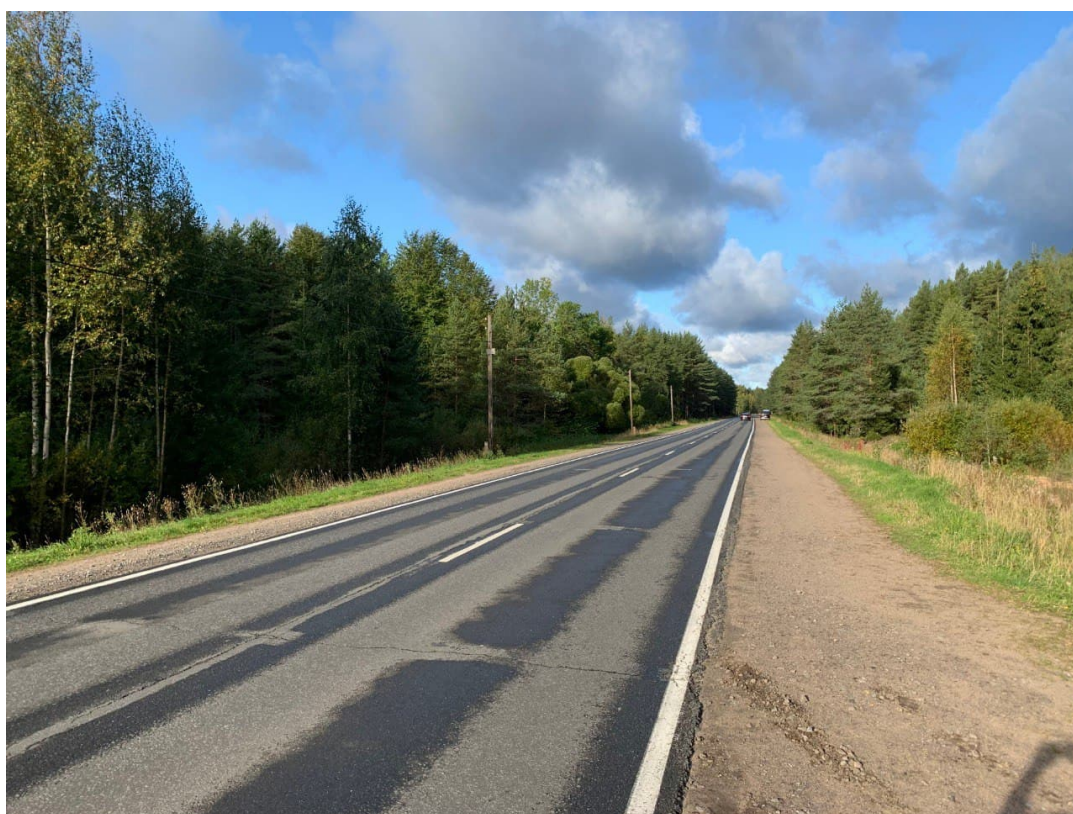
Рис. 10. Фотофиксация участка проектирования. 2020 год.
