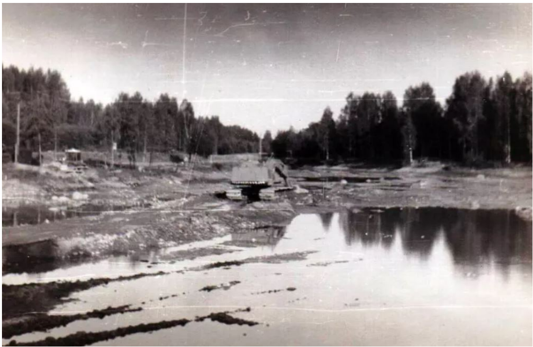
Рис. 8. Осушение и чистка озера "Каменка". Фото 1983– 1986, Россия, Ленинградская область, Всеволожский район, Рахьинское городское поселение
