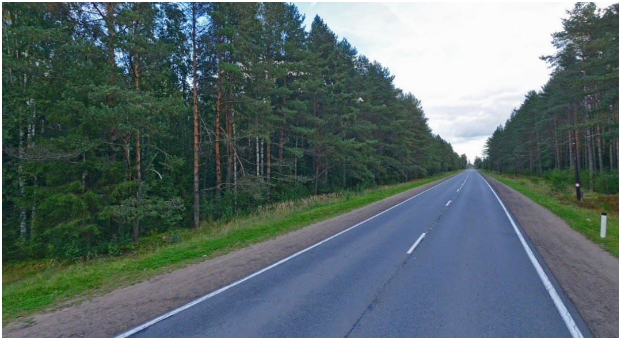
Рис. 12. Фотофиксация участка проектирования. 2020 год.
