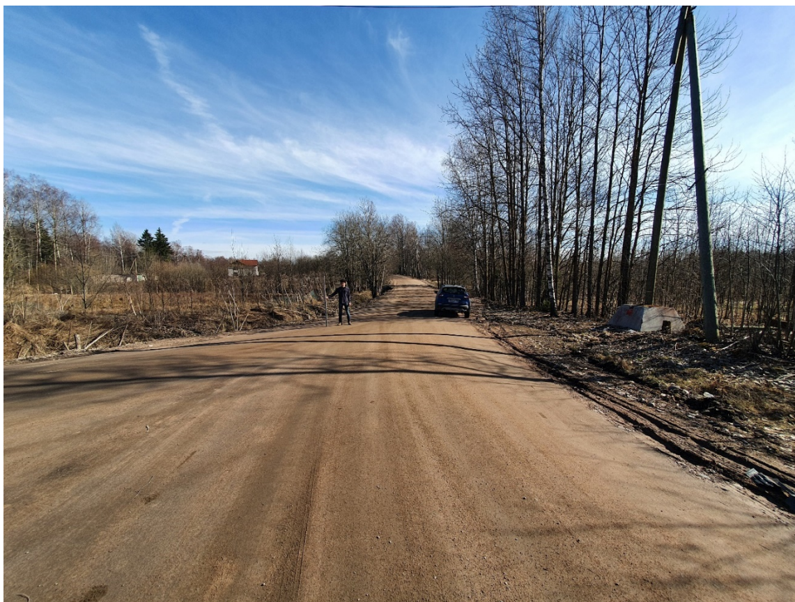
Рис. 22. Ленинградская обл., Выборгский район, «Черничное - Пионерское». Общий вид участка обследования. Точка фотофиксации 10. Вид на восток
