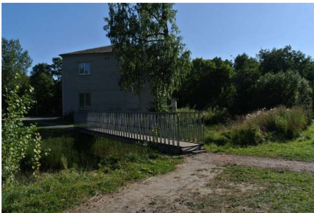
Фото 50. Вид в юго-восточном направлении на пешеходный мост через систему прудов, Дом культуры и усадебный парк.
