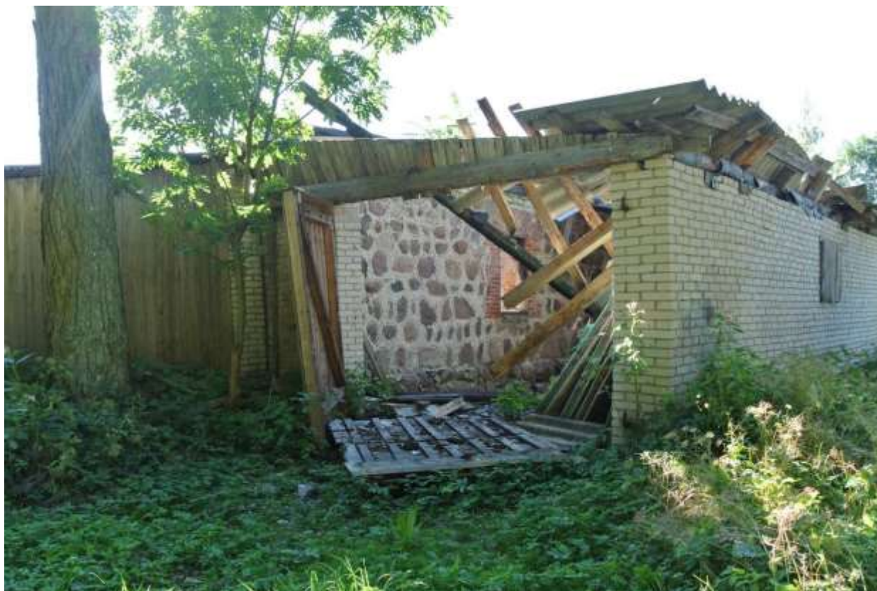
Фото 22. Вид на северо-восточный фасад объекта «Хозяйственный корпус одноэтажный» с более поздними пристройками.
