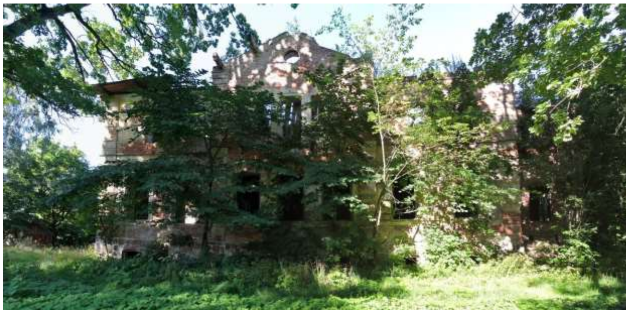
Фото 9. Юго-западный фасад главного господского дома.
