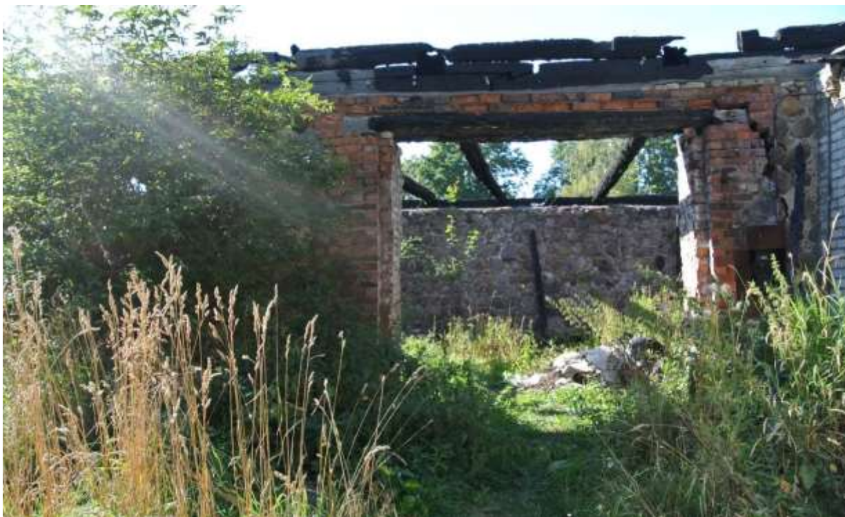
Фото 23. Вид на продольные стены объекта «Хозяйственный корпус одноэтажный» с более поздними пристройками и проемами.
