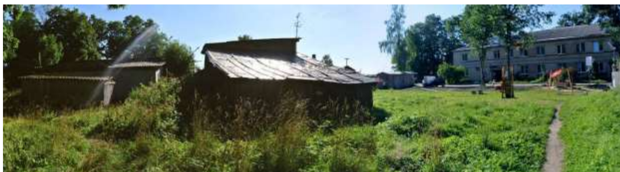
Фото 12. Вид в северо-западном направлении на детскую площадку перед многоквартирным жилым домом по адресу: Поселковая ул., д. 5 и хозяйственные постройки.
