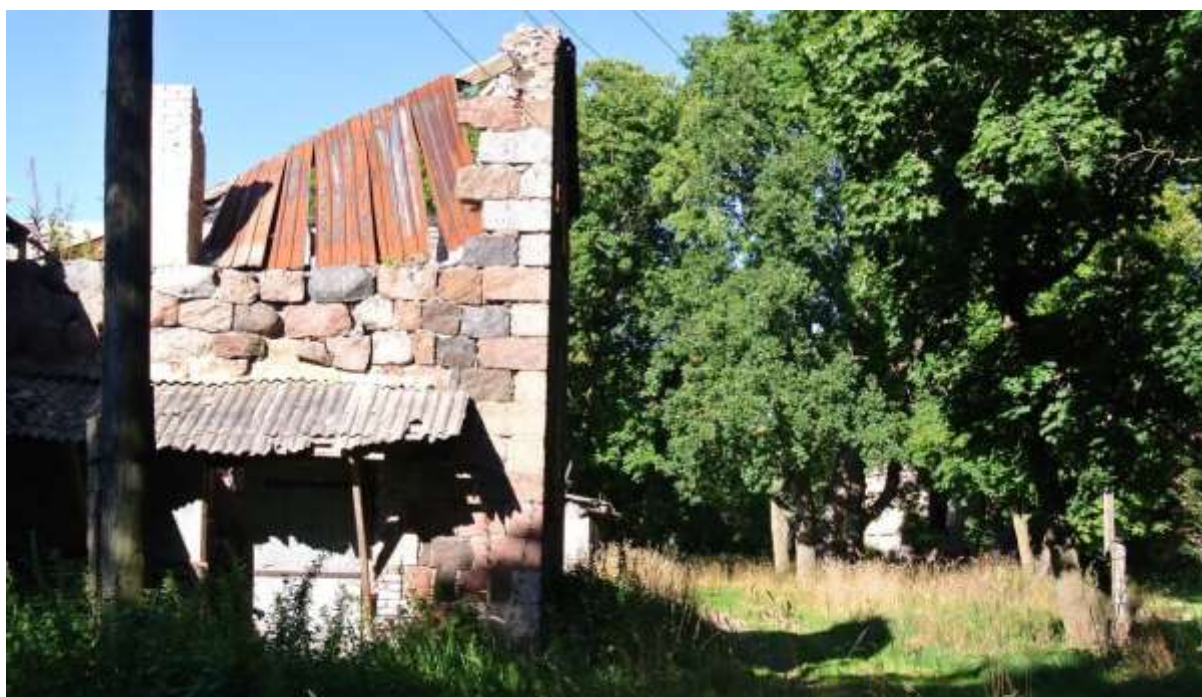
Фото 27. Вид с западной стороны на южный угол объекта «Хозяйственный корпус (двухэтажный)».
