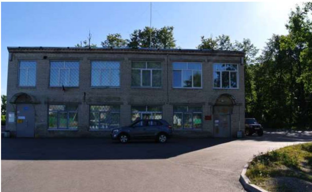
Фото 41. Вид на северо-восточный фасад здания ФАП и восточную часть сохранившегося усадебного парка.
