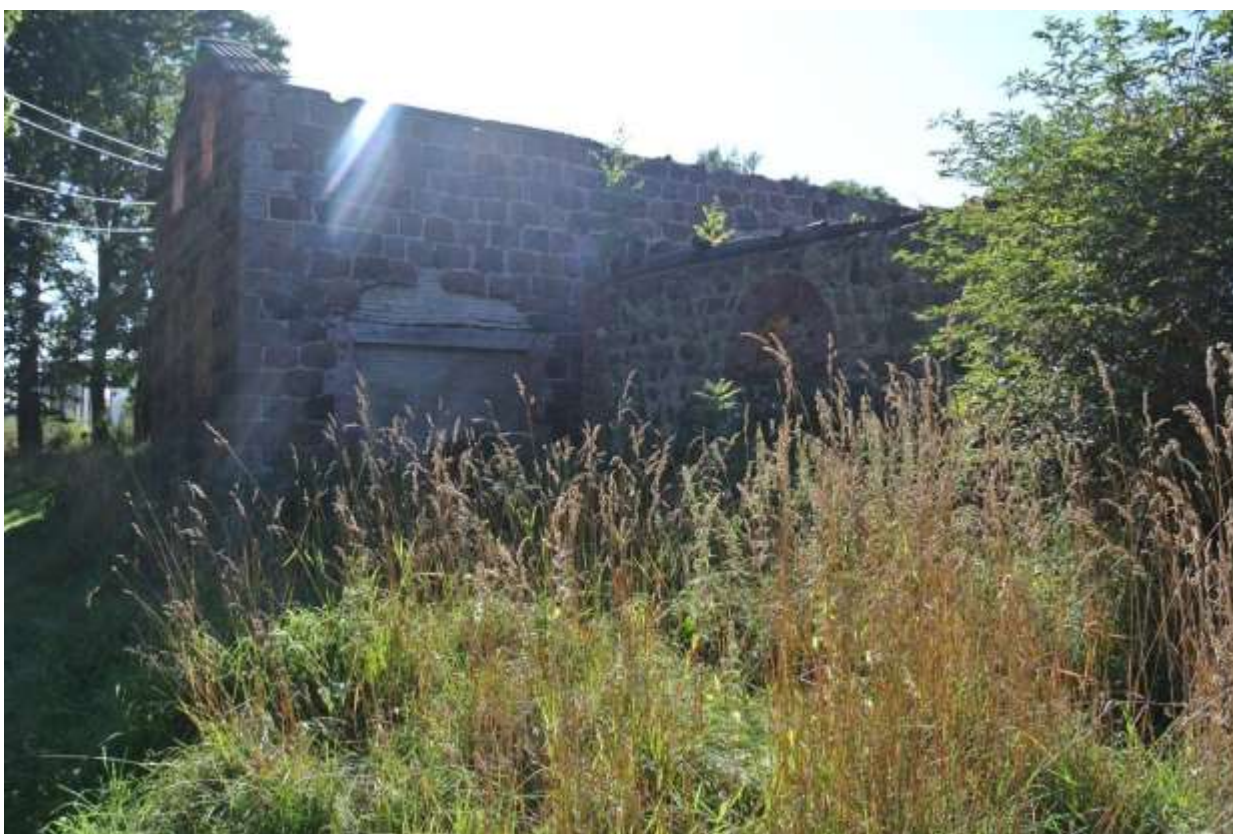
Фото 24. Вид в западном направлении на место примыкания объектов «Хозяйственный корпус (двухэтажный)» и «Хозяйственный корпус одноэтажный».
