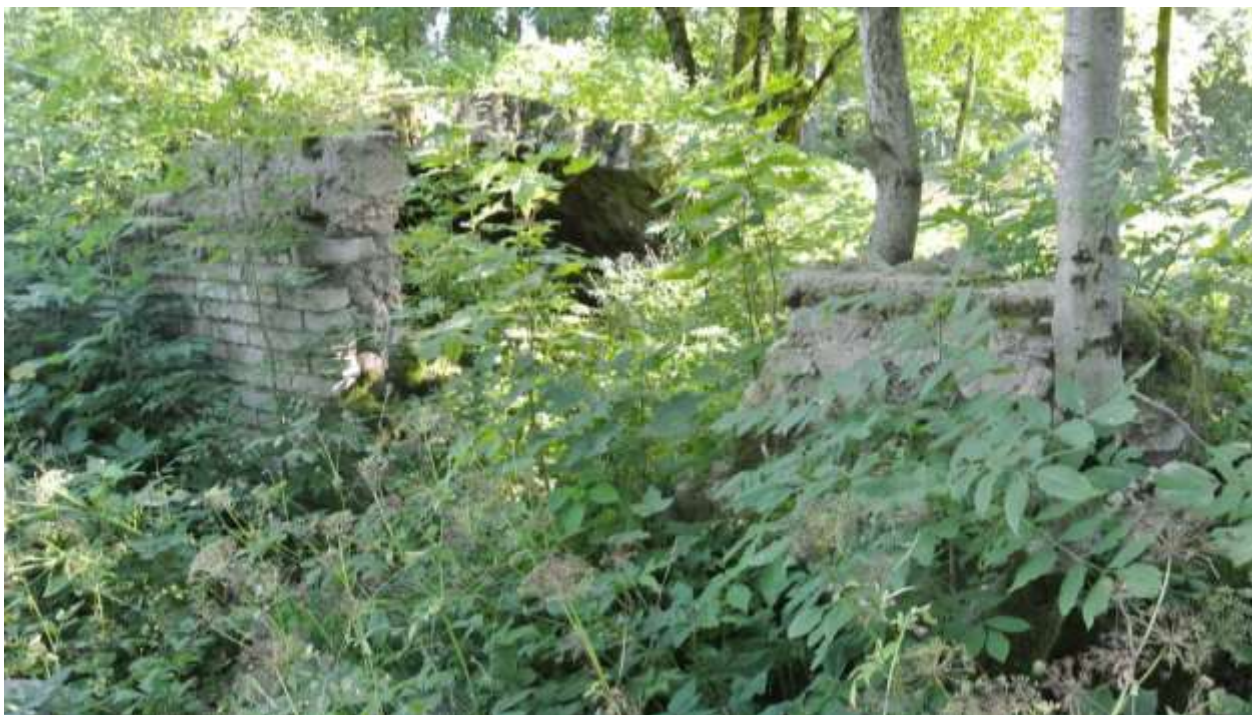
Фото 3. «Каменный погреб (ледник)». Вид в юго-западном направлении.
