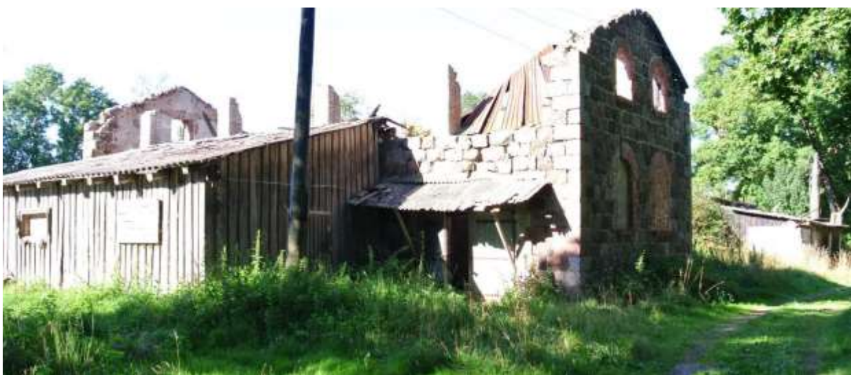
Фото 26. Вид на южный угол объекта «Хозяйственный корпус (двухэтажный)».
