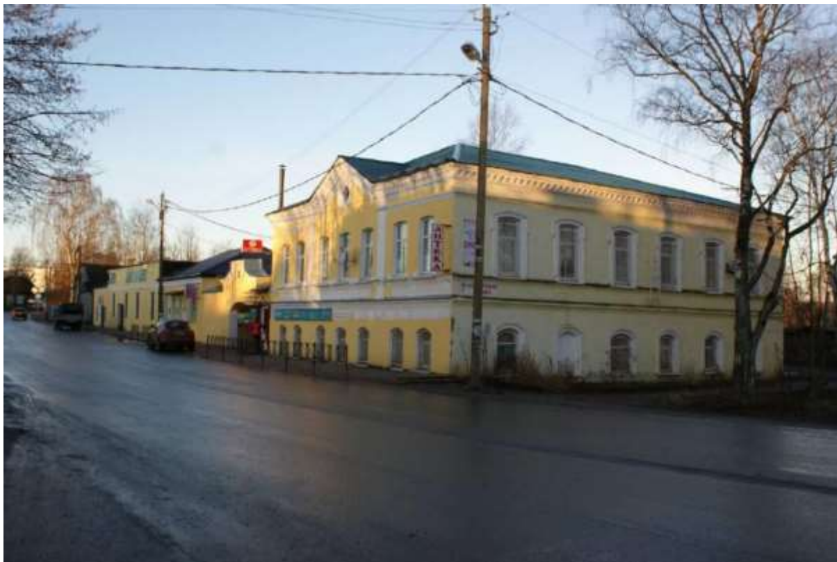
Фото 1.1 Лицевой фасад ансамбля «Здание бывшего детского приюта Благотворительного общества и пекарни» по пр. Карла Маркса. 2020 год
