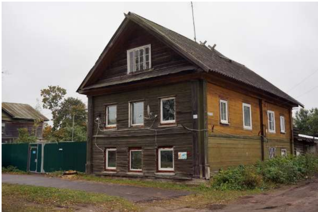
Фото 7.1 Общий вид объекта культурного наследия «Жилой дом – бывший дом священника Афанасьева» вид на северный и лицевой фасады с пр. Карла Маркса. 2020 год
