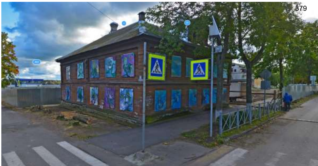
Фото 4.1 Общий вид объекта культурного наследия «Жилой дом – бывший дом Г.С. Сироткиной, середина XIX века» с перекрестка пр. Карла Маркса и ул. Ворошилова. 2020 год
