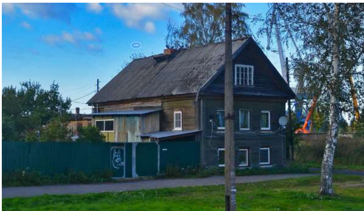
Фото 7.2 Вид на южный и лицевой фасады с пр. Карла Маркса. 2020 год
