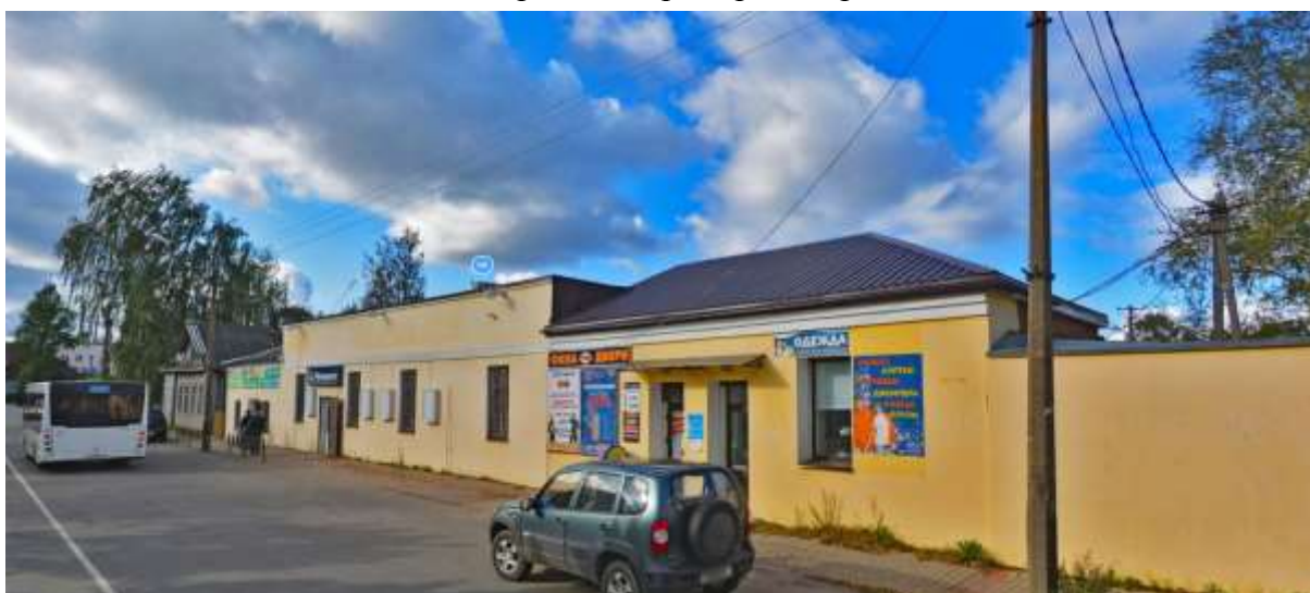
Фото 1.2 Лицевой фасад здания пекарни. 2020 год
