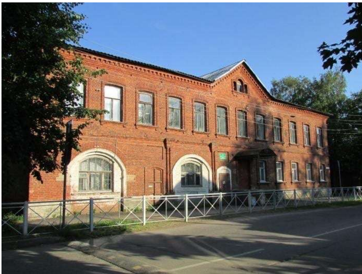
Фото 3.2 Лицевой фасад с пр. Карла Маркса
