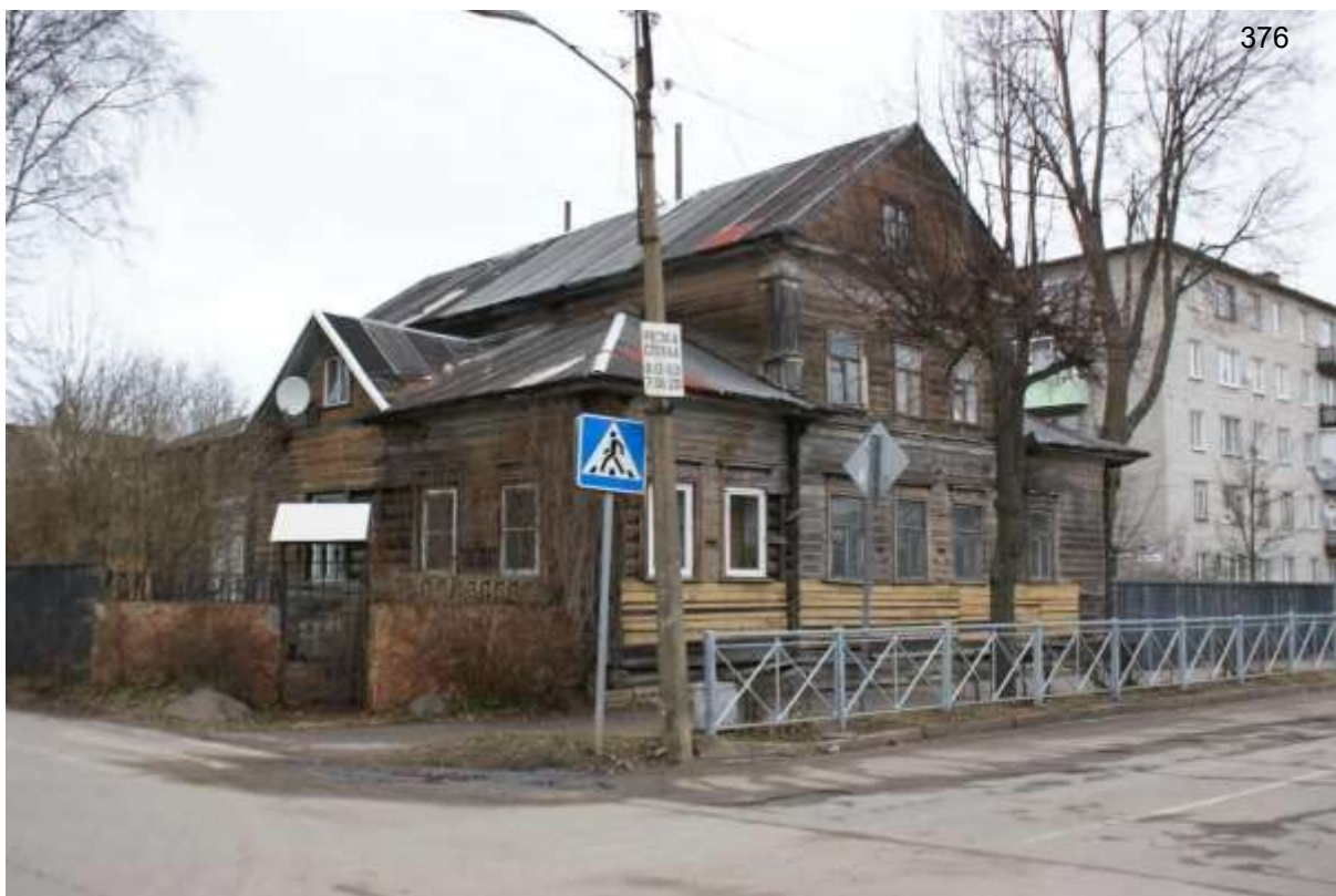
Фото 2.1 Общий вид объекта культурного наследия «Жилой дом – впоследствии богадельня Новоладожского благотворительного общества, середины XIX века» с перекрестка пр. Карла Маркса и ул. Ворошилова.
