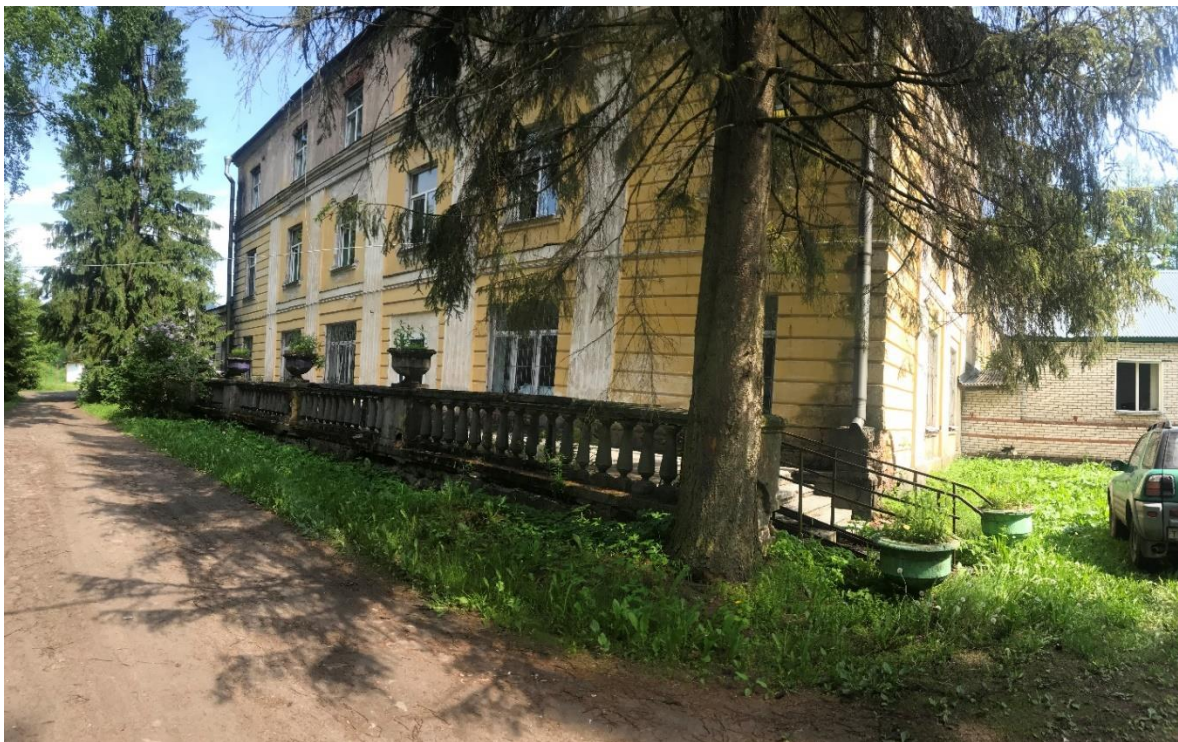
Фото 6. Здание ГКУЗ ЛО «ТБ «Дружноселье», расположенное по адресу: Ленинградская область, Гатчинский район, пос. Дружноселье, ул. Зеленая, д. 1. Фото Рябкова В. А. (июль 2020 г.)
