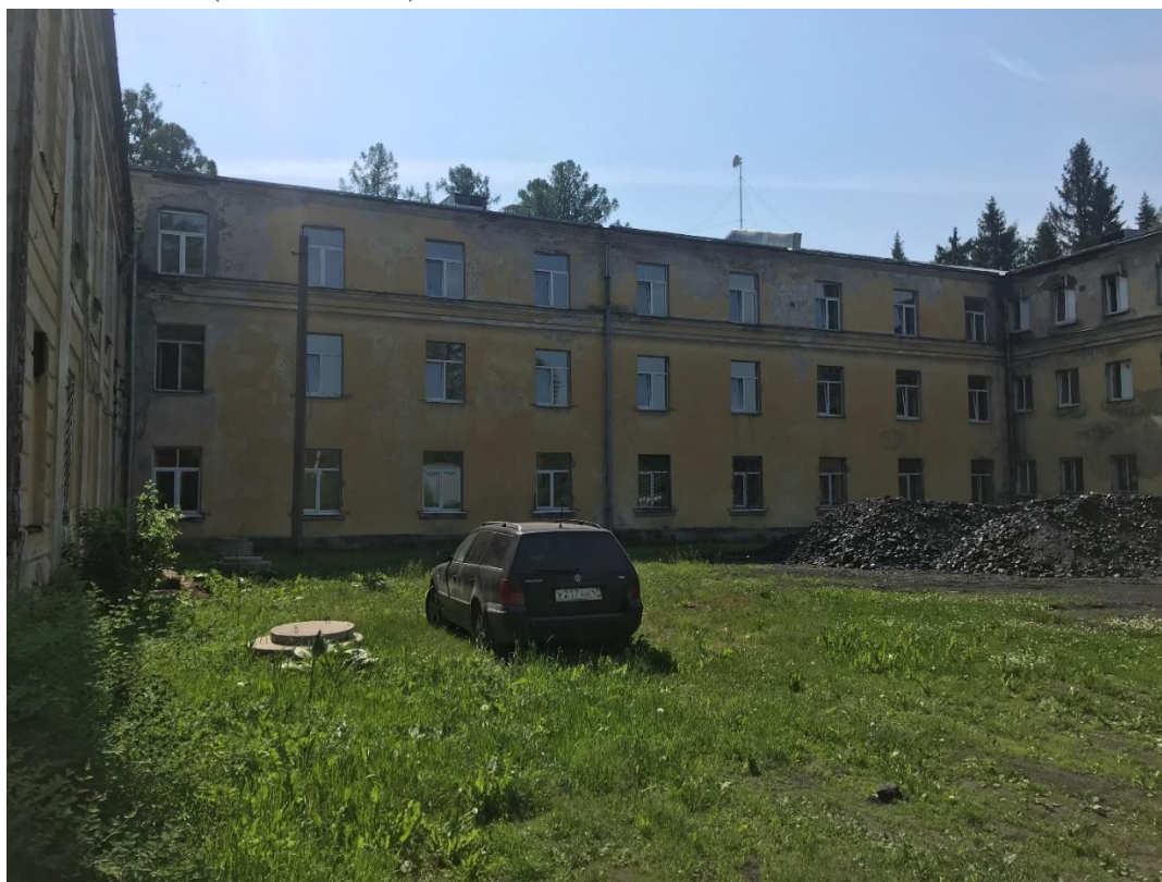
Фото 2. Здание ГКУЗ ЛО «ТБ «Дружноселье», расположенное по адресу: Ленинградская область, Гатчинский район, пос. Дружноселье, ул. Зеленая, д. 1. Вид со двора. Фото Рябкова В. А. (июль 2020 г.)
