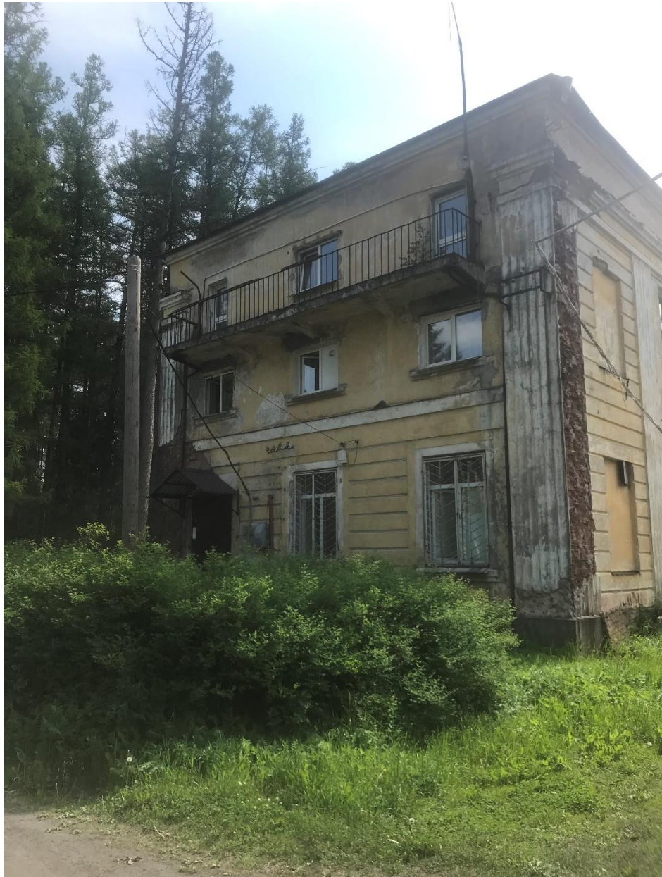
Фото 8. Здание ГКУЗ ЛО «ТБ «Дружноселье», расположенное по адресу: Ленинградская область, Гатчинский район, пос. Дружноселье, ул. Зеленая, д. 1. Фото Рябкова В. А. (июль 2020 г.)
