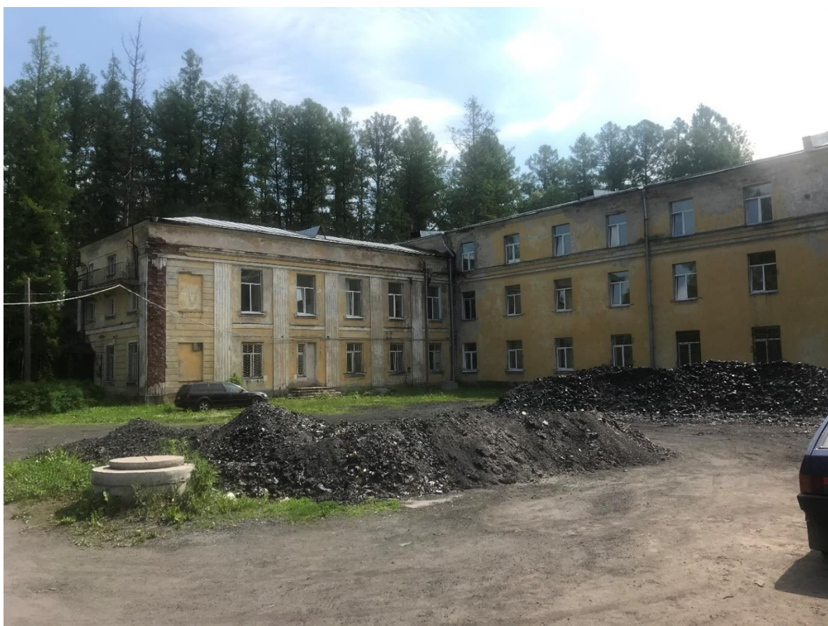
Фото 7. Здание ГКУЗ ЛО «ТБ «Дружноселье», расположенное по адресу: Ленинградская область, Гатчинский район, пос. Дружноселье, ул. Зеленая, д. 1. Вид на дворовой фасад. Фото Рябкова В. А. (июль 2020 г.)
