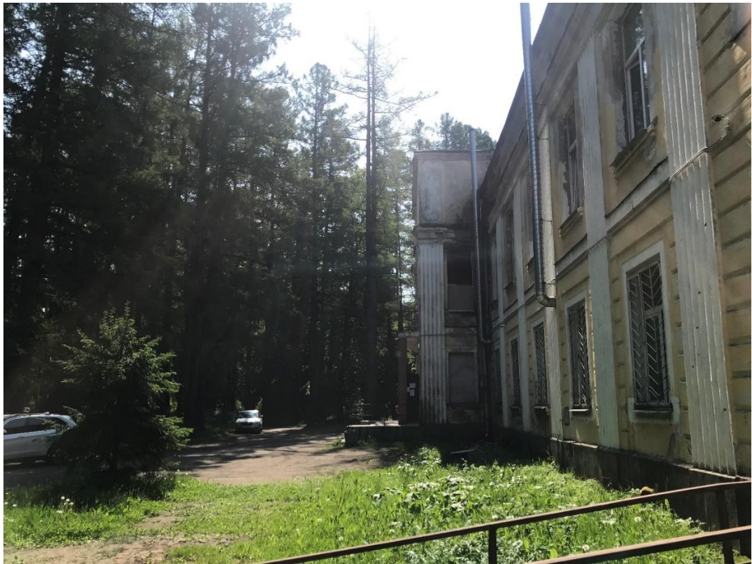
Фото 3. Здание ГКУЗ ЛО «ТБ «Дружноселье», расположенное по адресу: Ленинградская область, Гатчинский район, пос. Дружноселье, ул. Зеленая, д. 1. Фото Рябкова В. А. (июль 2020 г.)
