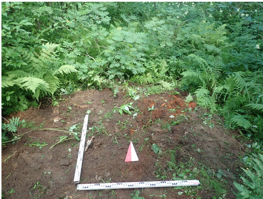
Рис. 33. Ленинградская область, Всеволожский район, поселок городского типа им. Морозова (кадастровые номера 47:07:1703021:147, 47:07:1703021:154, 47:07:1703021:155) - 2020 г. Шурф №2. Рекультивация методом обратной засыпки грунта. Вид с Ю.
