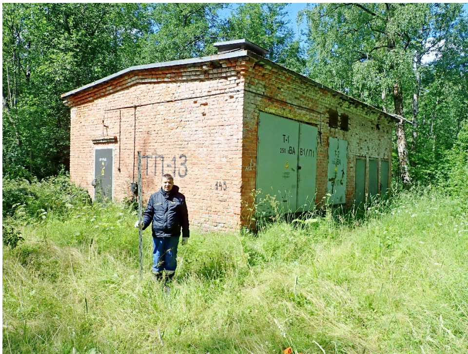
Рис. 19. Ленинградская область, Всеволожский район, поселок городского типа им. Морозова (кадастровые номера 47:07:1703021:147, 47:07:1703021:154, 47:07:1703021:155) - 2020 г. Точка фиксации № 5. Вид с В-ЮВ. В качестве масштаба использована геодезическая рейка 2 метра с сантиметровыми делениями.
