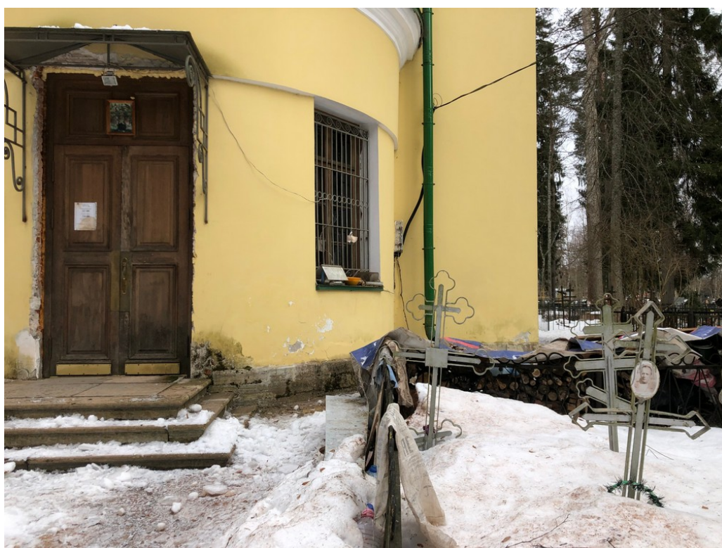
25. Село Рождествено. Вид на церковь Вознесения Господня в сторону востока. Фрагмент. 15.03.2021. Фото:Петухова Н.М.
