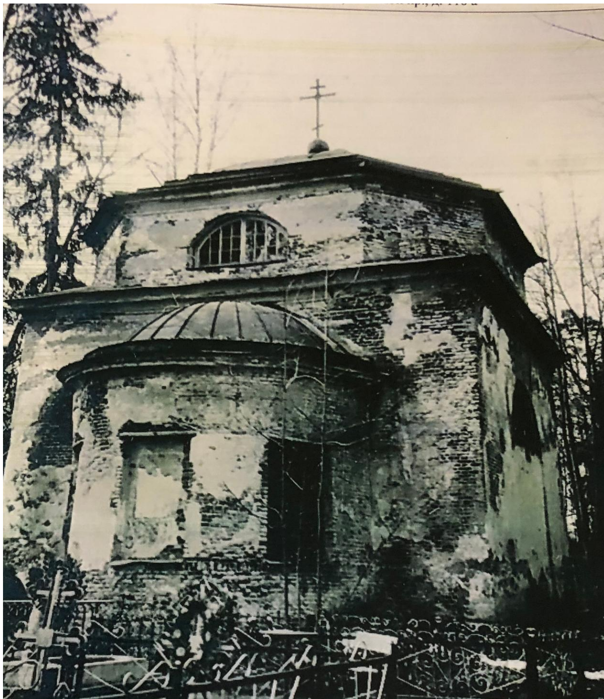
25. Восточный фасад церкви Вознесения Господня. Вид на северо-северо-восток. 1996 г. Инвентаризация объекта культурного наследия федерального значения «Церковь Вознесения», 1781 г., расположенного по адресу: Ленинградская область, Гатчинский муниципальный район, Рождественское сельское поселение, с. Рождествено, Большой пр., д. 118 а. Шифр: ИНВ-25-2019.
