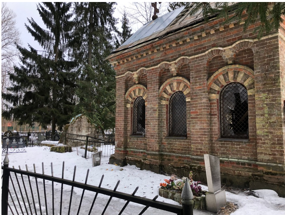
22. Село Рождествено. Вид на склеп перед церковью в сторону юго-востока. 15.03.2021. Фото:Петухова Н.М.
