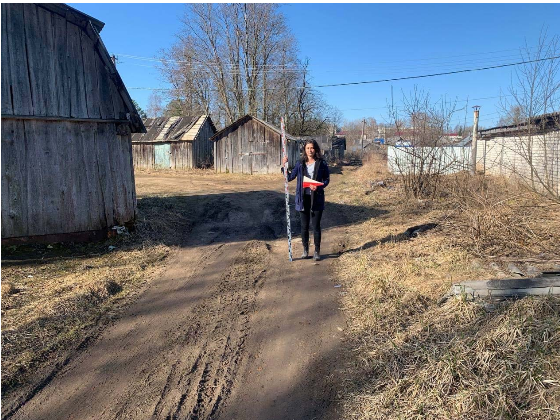
Рис. 24. Трасса обследования. Точка съемки 12. Вид с запада
