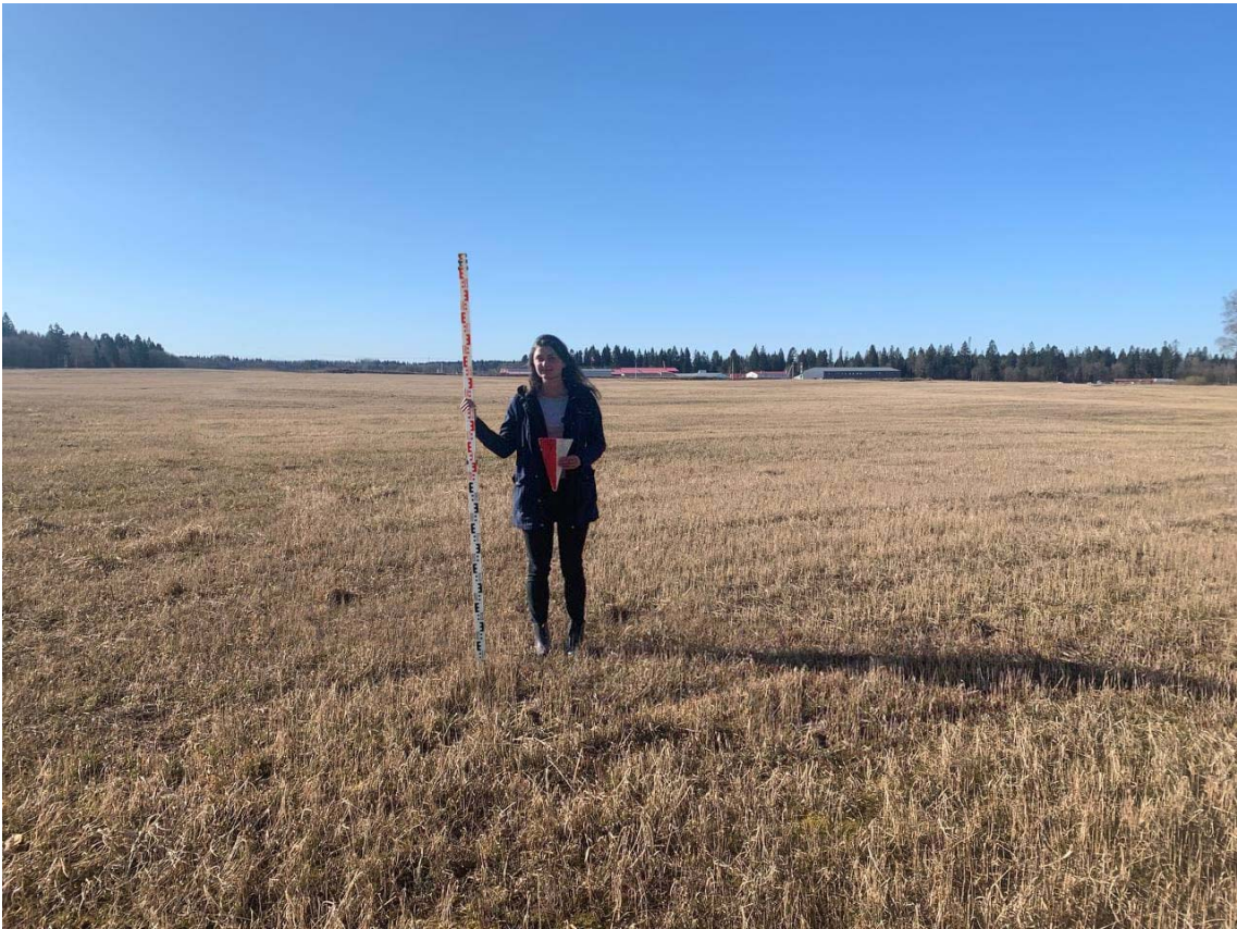
Рис. 49. Месторасположение Шурфа 3. До начала работ. Вид с севера
