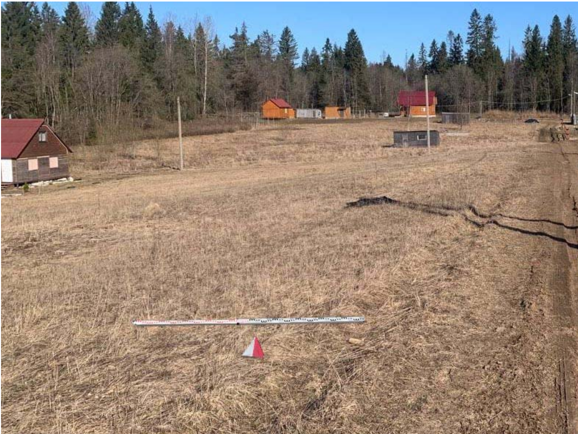
Рис. 57. Шурф 4. До начала работ. Вид с юга
