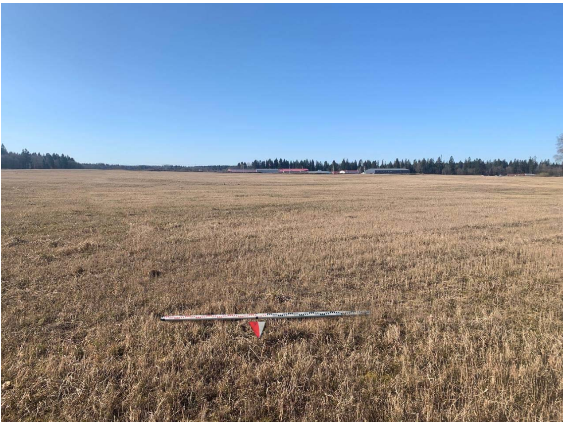
Рис. 50. Шурф 3. До начала работ. Вид с севера
