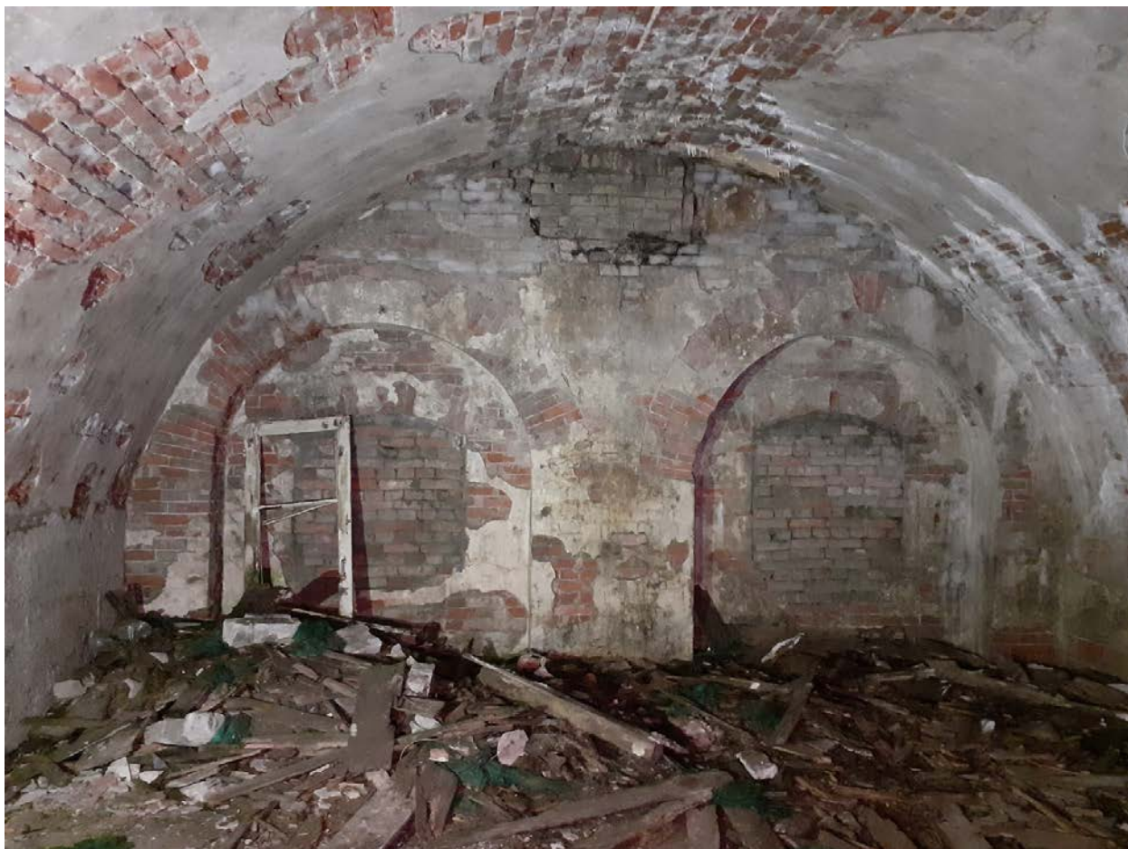
9. Капонир. Амбразуры для единорогов заложены кирпичом в 1950-е годы или позже.
