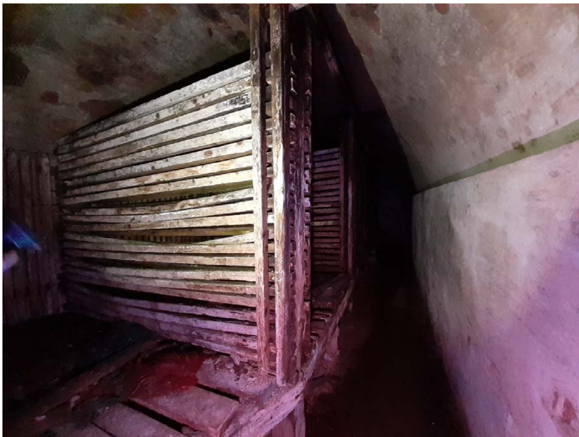
13. Пороховой погреб в основной потерне. Видны сгнившие деревянные стеллажи, оставшиеся от овощного склада XX-XXI века.
