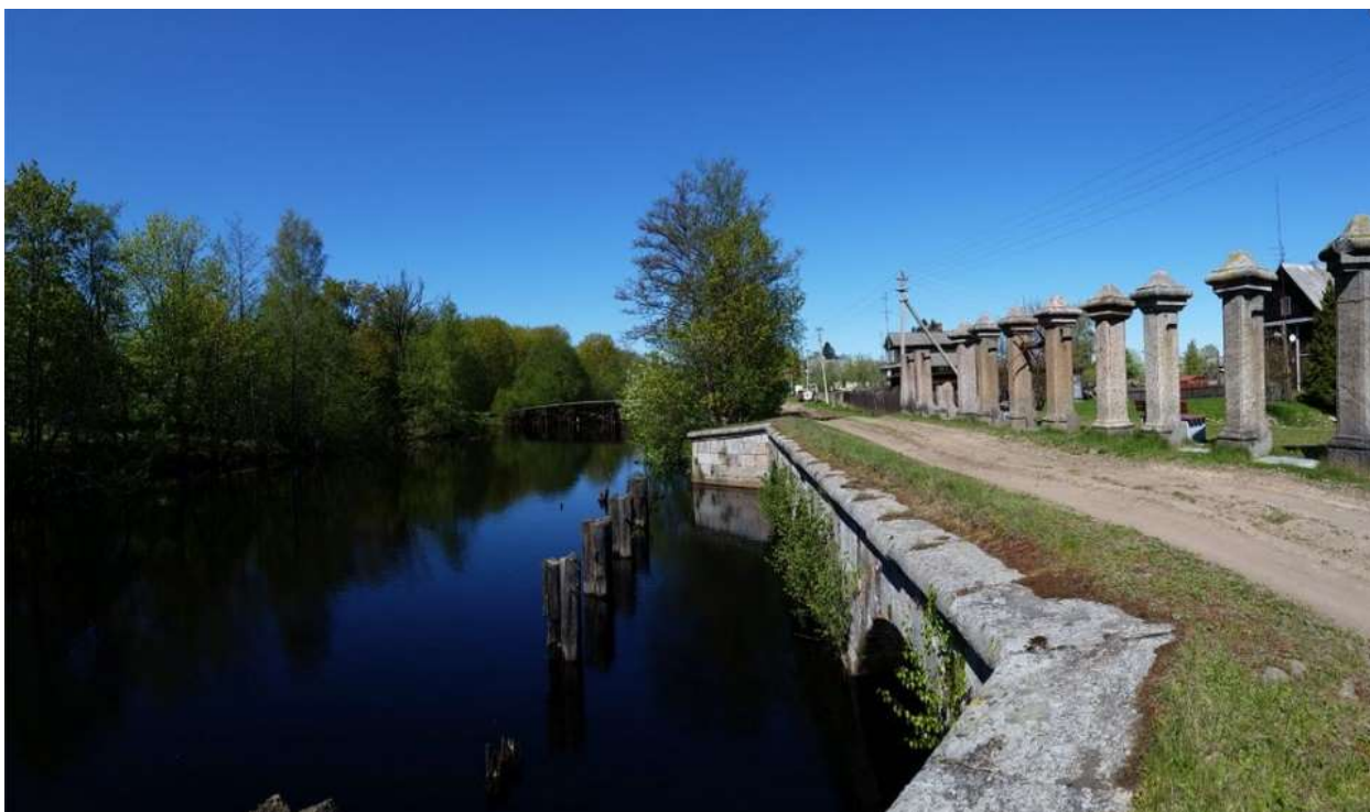
ФОТО 4. Вид в западном направлении на здание караулки и деревянный мост через Староладожский канал с шандорного моста.
