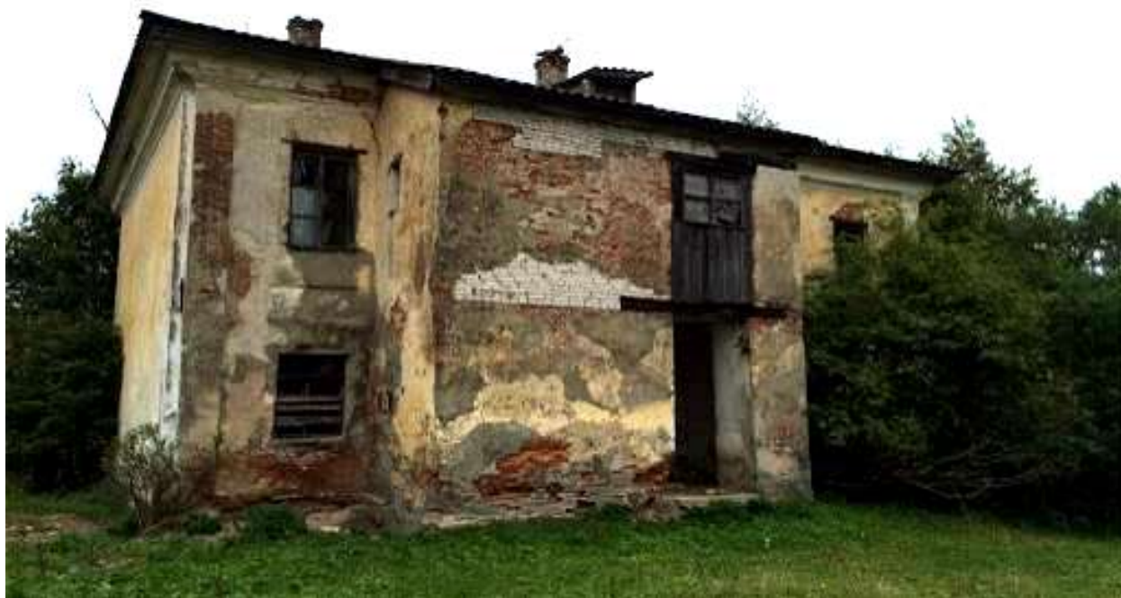
ФОТО 7. Вид южного фасада здания караулки.
