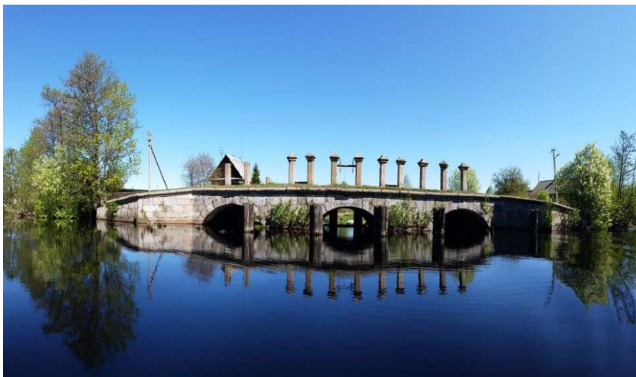
ФОТО 8. Вид в северном направлении на шандорный мост.
