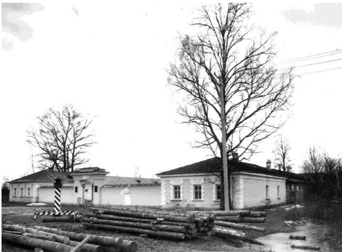
28. Общий вид главного фасада почтовой станции в Выре. После реставрации 1986 г. Фото А. Плошко.
