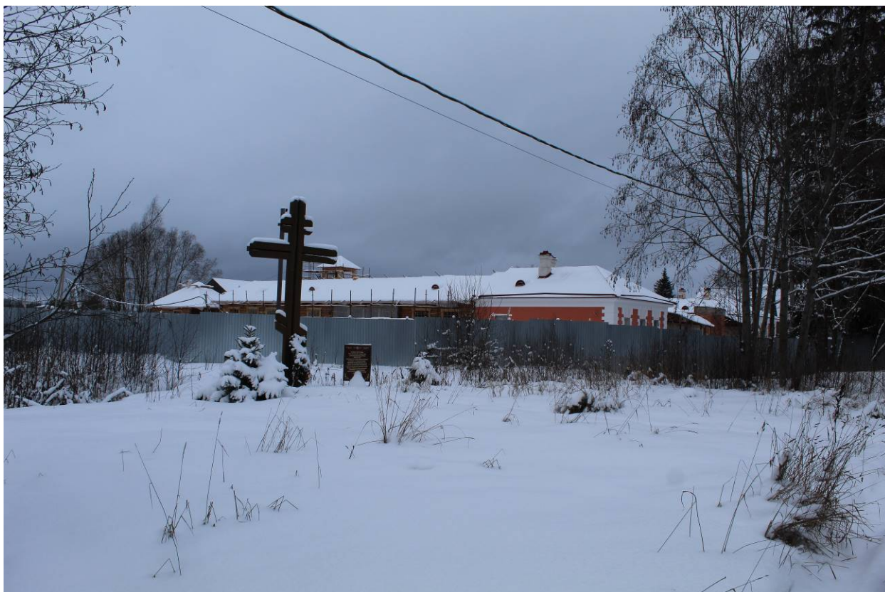
1. «Здание почтовой станции», «Дом для проезжающих» в д. Выра (Гатчинский район, Ленинградская область). Вид на «Дом для проезжающих» и «Здание почтовой станции» с юга.
