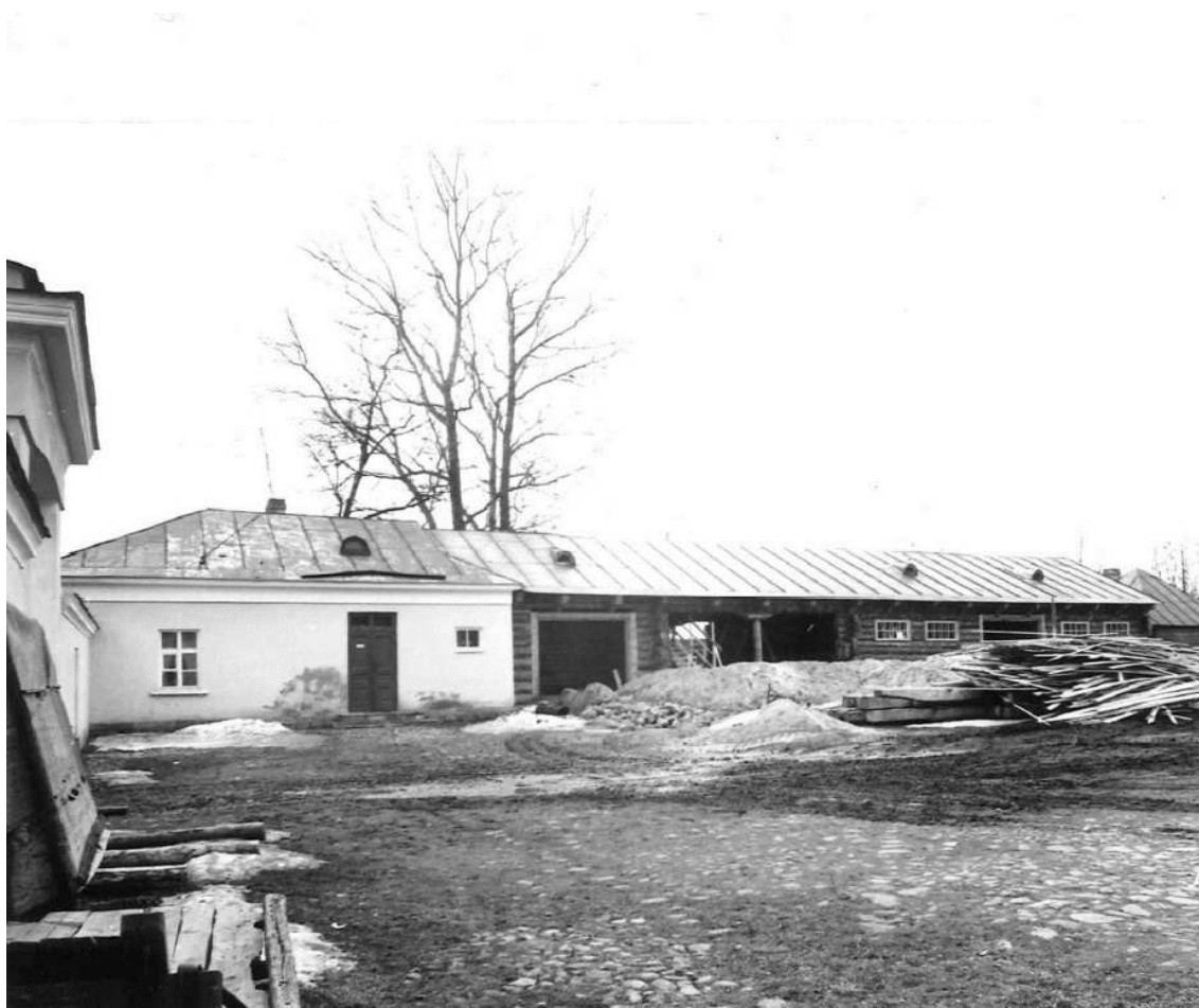
31. Дворовые фасады южного почтового корпуса и конюшен в процессе завершения работ. 1986 г. Фото А. Плошко.
