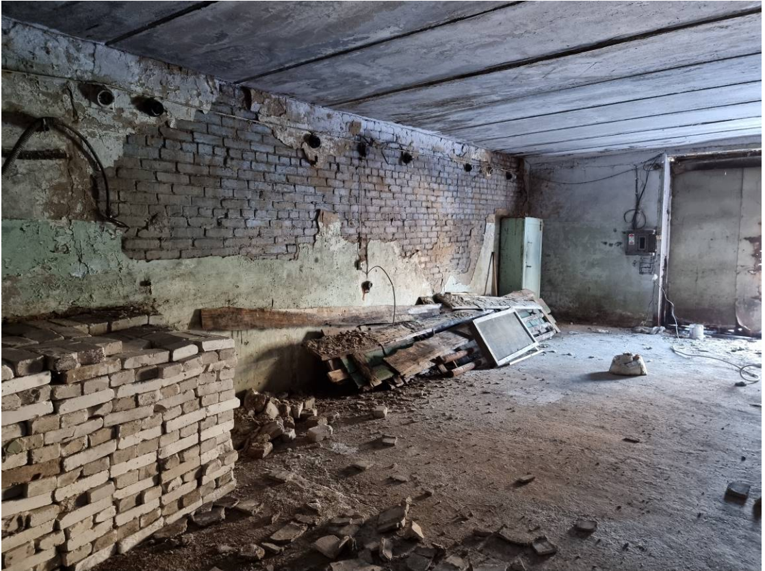
Илл. 9. Помещение гаража. Съемка 22.03.2021 г. Трушковский В.Э.
