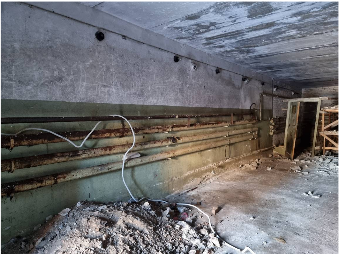
Илл. 8. Помещение гаража. Съемка 22.03.2021 г. Трушковский В.Э.
