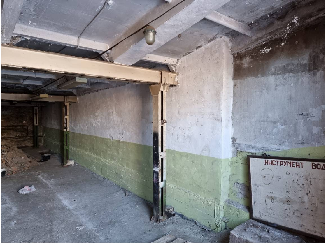
Илл. 7. Помещение гаража. Съемка 22.03.2021 г. Трушковский В.Э.
