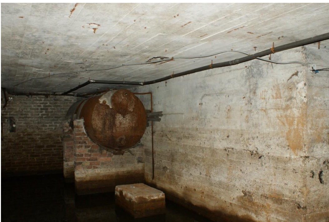
8. «Жилой и торговый дом «Карьяла»». г. Выборг, Ленина пр., д.12/10. Подвал. Общий вид. Фото 25.05.2021г.
