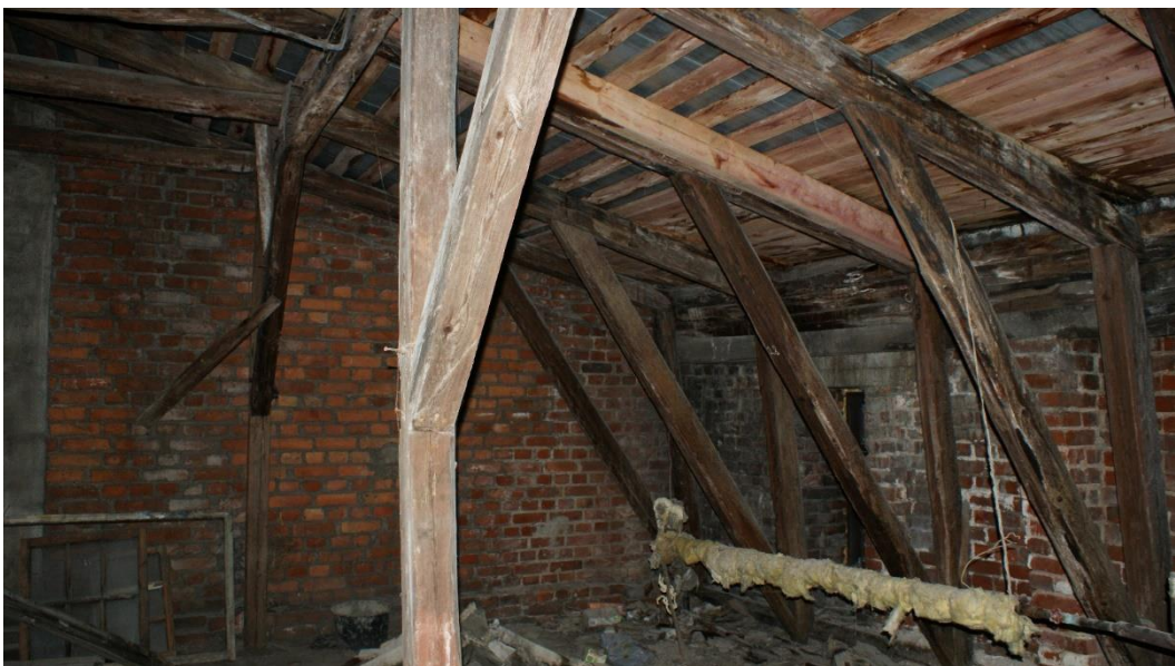
12. «Жилой и торговый дом «Карьяла»». г. Выборг, Ленина пр., д.12/10. Кровля. Общий вид. Фото 25.05.2021г.
