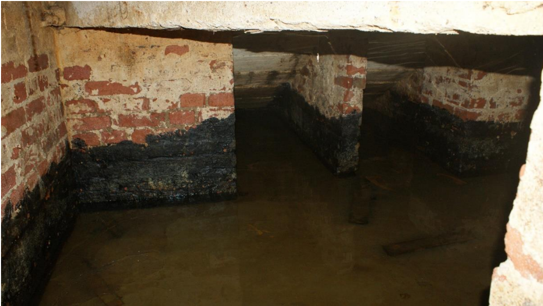
6. «Жилой и торговый дом «Карьяла»». г. Выборг, Ленина пр., д.12/10. Подвал. Общий вид. Фото 25.05.2021г.
