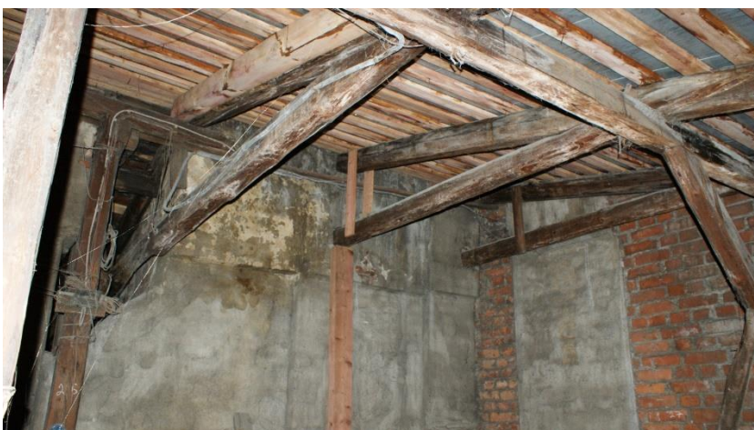
14. «Жилой и торговый дом «Карьяла»». г. Выборг, Ленина пр., д.12/10. Кровля. Фрагмент. Фото 25.05.2021г.
