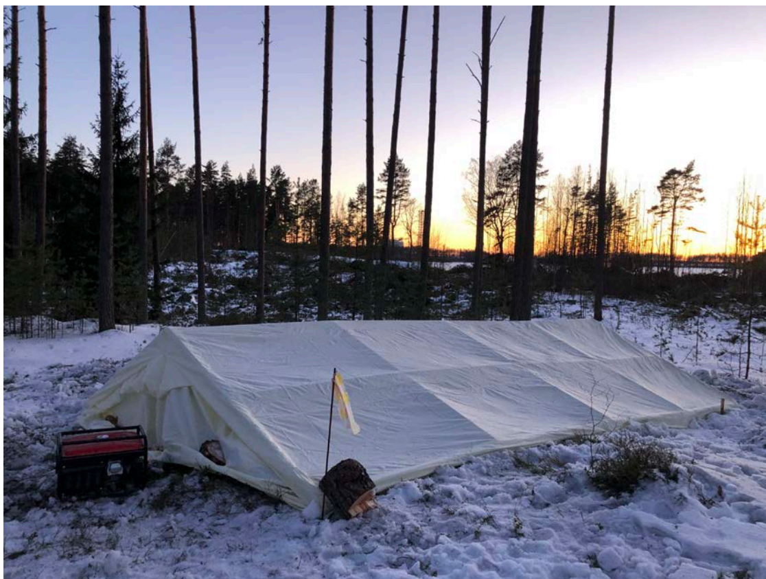
Илл.17. Выборгский район, Порт Высоцкий-1-2021. Процесс отогрева сектора 1. Вид с СВ.
