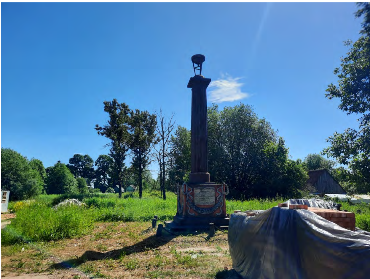
Илл. 22. Ленинградская обл., Волосовский р-н. ОКН «Чугунная колонна (памятник Н.Н. Демидову)». Точка фотофиксации Ф1. Вид с севера (июнь 2021).
