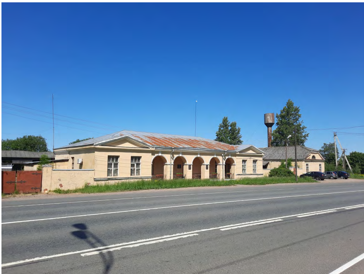
Илл. 14. Ленинградская обл., Волосовский р-н. ОКН «Здание почтовой станции» (ансамбль), 1806-1807 гг. Северо-западная часть памятника. Точка фотофиксации Ф1. Вид с юго-запада (июнь 2021).
