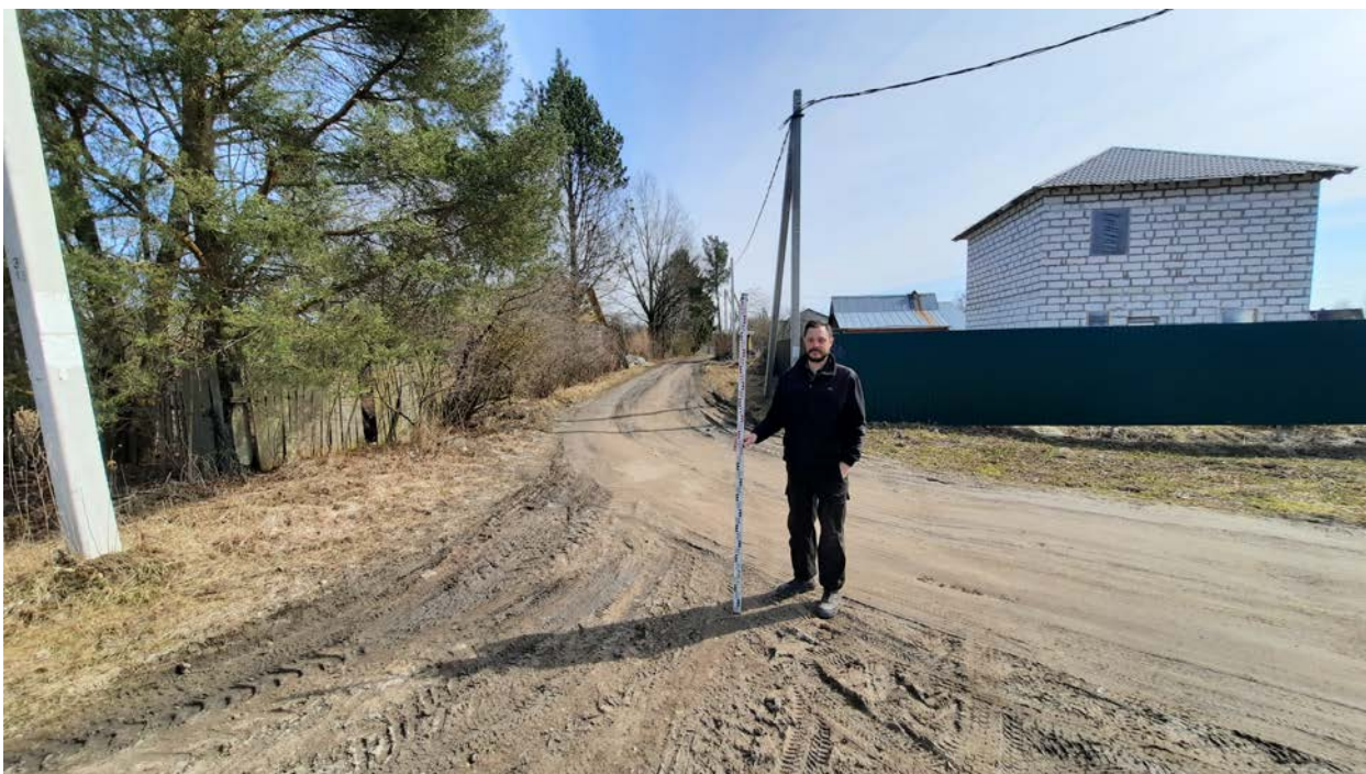
Илл.41. Ленинградская обл., Гатчинский район, д.Корпиково-2021. Точка фотофиксации 27. Вид с З.
