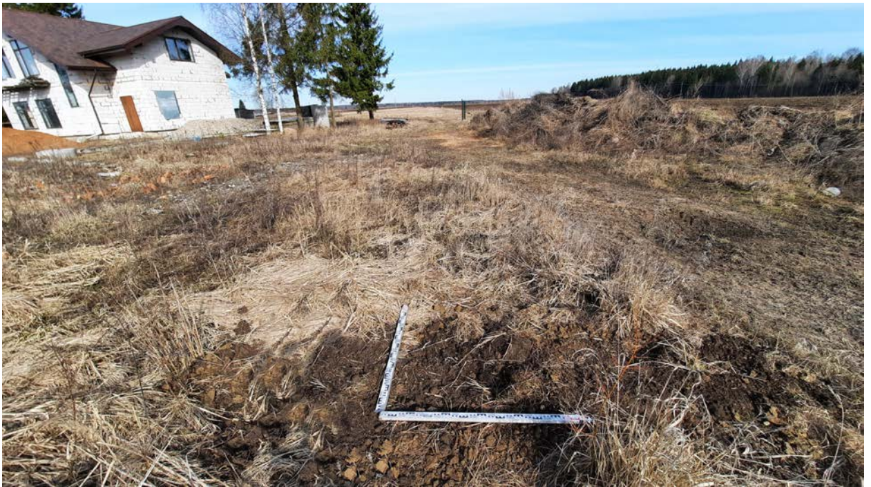
Илл.62. Ленинградская обл., Гатчинский район, д.Корпиково-2021. Шурф 1. Рекультивация. Вид с Ю.
