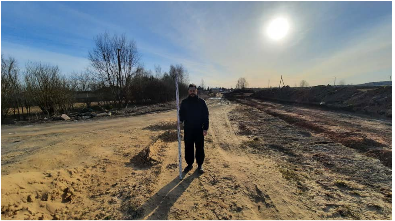
Илл.60. Ленинградская обл., Гатчинский район, д.Черново-2021. Точка фотофиксации 41. Вид с СВ.
