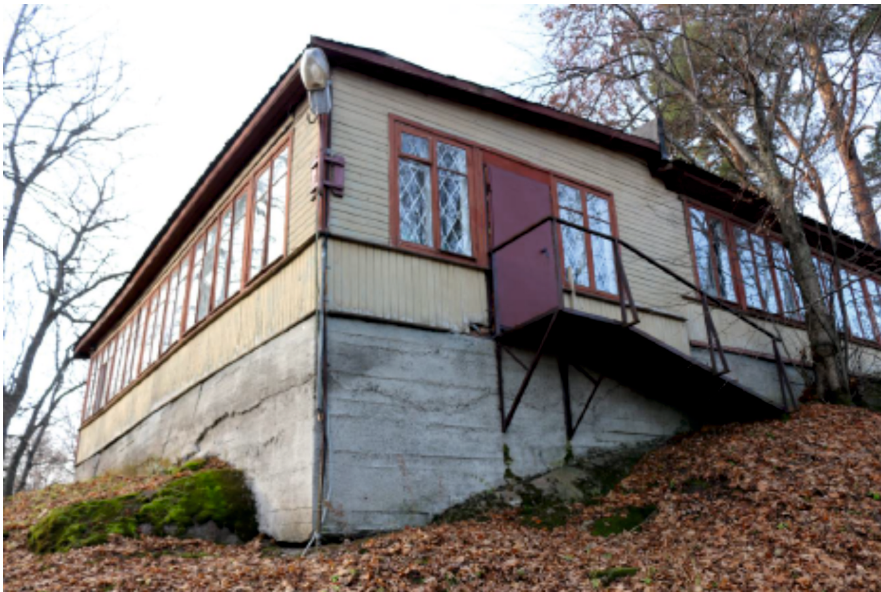
Фото 5. Объект культурного наследия «Флигель для гостей», по адресу: Ленинградская область, г. Выборг, парк Монрепо. Северо-восточный и юго-восточный фасады. Фото 01.10.2020 г.
