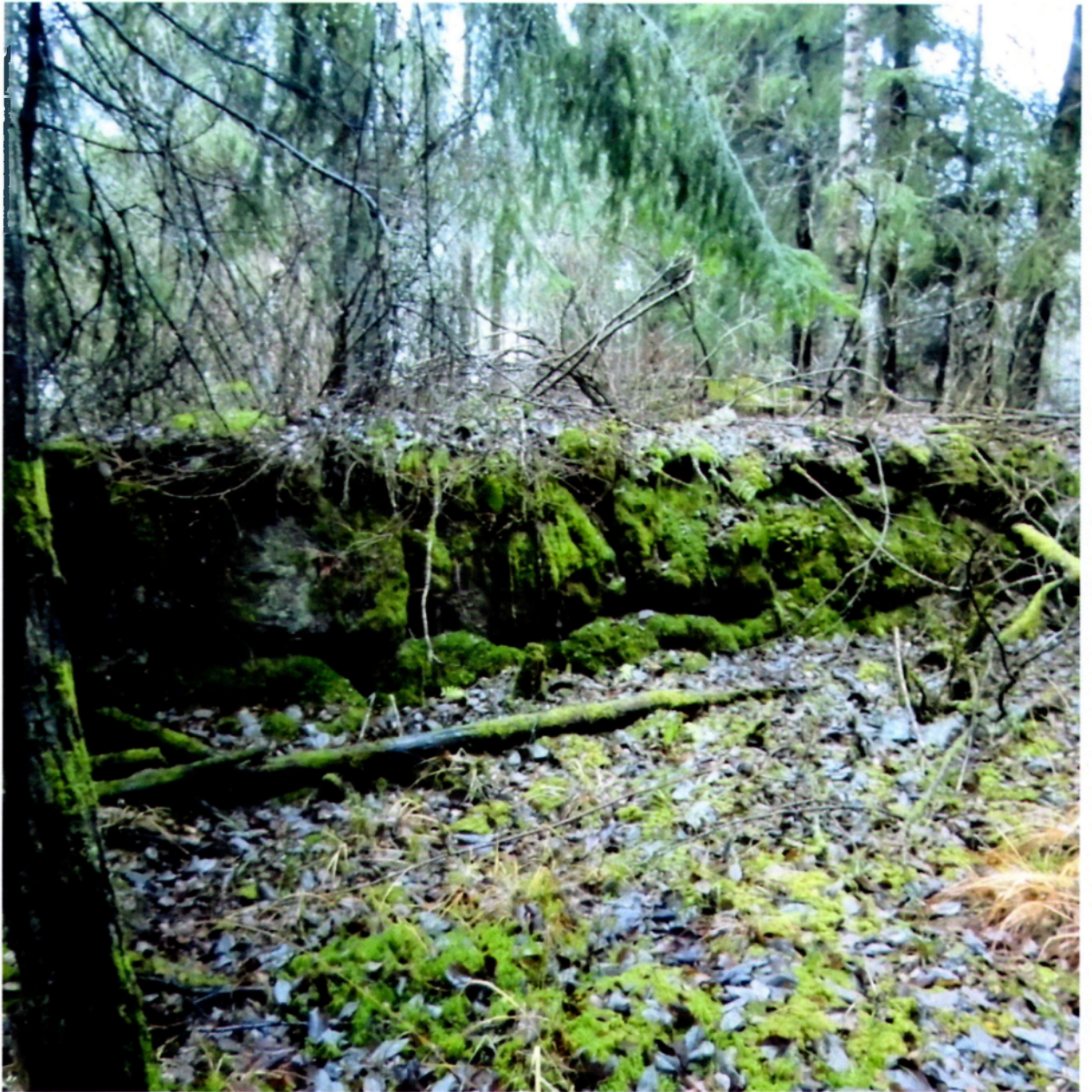
Дом жилой (фундамент).
