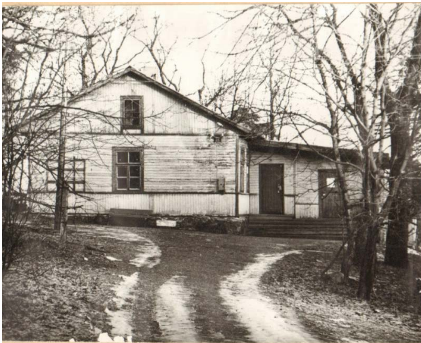
Ил. 24. Флигель для гостей (?). Западный фасад. 1993 г. // Паспорт памятника архитектуры середины XIX в. «Усадьба Монрепо. Флигель для гостей (?)», расположенного по адресу: Ленинградская область, Выборгский р-н, г. Выборг, пос. Выборгский, музей-заповедник «Парк Монрепо», инд. «3.7. 1.29.6».
