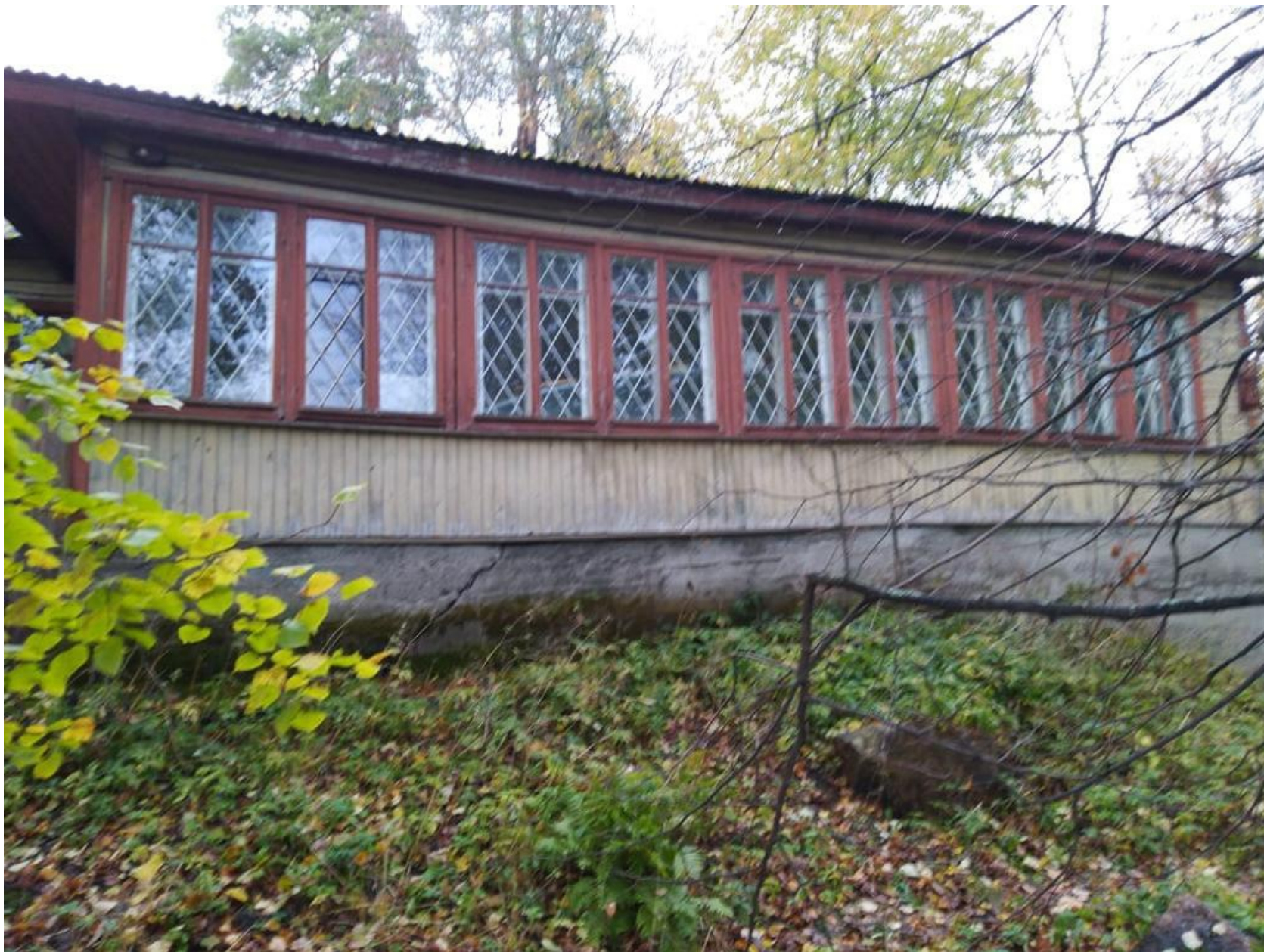
Фото 6. Объект культурного наследия «Флигель для гостей», по адресу: Ленинградская область, г. Выборг, парк Монрепо. Юго-восточный фасад. Фото 01.10.2020 г.
