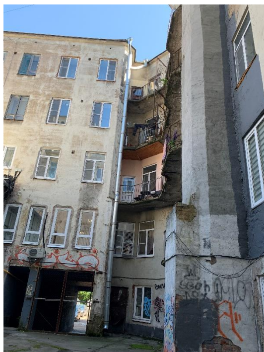
22. «Дом финского сберегательного банка», г. Выборг, Вокзальная ул., д.13. Дворовый фасад. Фрагмент. Фото 25.05.2021г.
