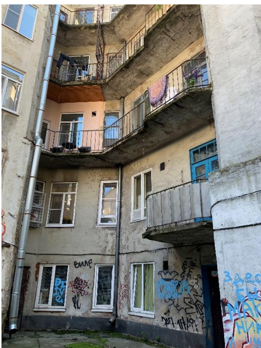
24. «Дом финского сберегательного банка», г. Выборг, Вокзальная ул., д.13. Дворовый фасад. Фрагмент. Фото 25.05.2021г.
