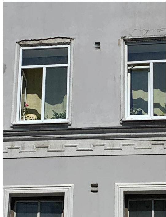
14. «Дом финского сберегательного банка», г. Выборг, Вокзальная ул., д.13. Южный фасад. Фрагмент. Фото 25.05.2021г.
