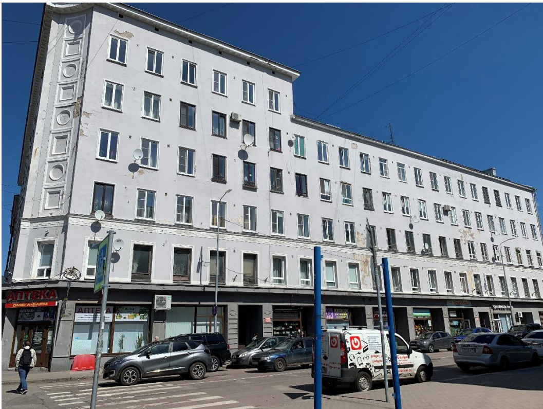
2. «Дом финского сберегательного банка», г. Выборг, Вокзальная ул., д.13. Южный фасад. Общий вид. Фото 25.05.2021г.
