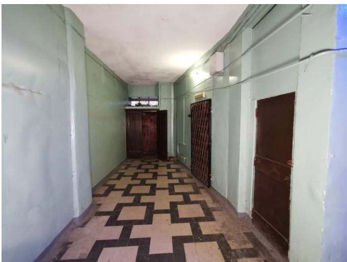
27. «Дом финского сберегательного банка», г. Выборг, Вокзальная ул., д.13. Подъезд №1. Общий вид. Фото 25.05.2021г.
