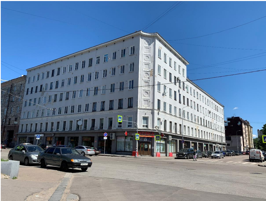
1. «Дом финского сберегательного банка», г. Выборг, Вокзальная ул., д.13. Общий вид с юго-запада. Фото 25.05.2021г.
