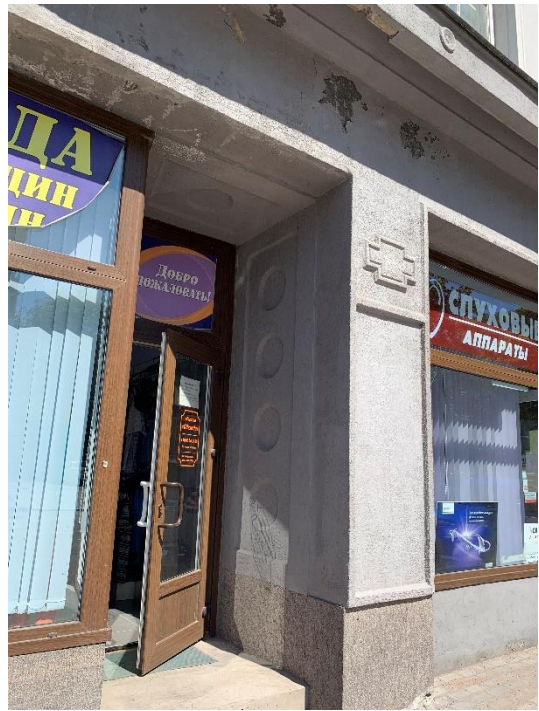
9. «Дом финского сберегательного банка», г. Выборг, Вокзальная ул., д.13. Южный фасад. Фрагмент. Фото 25.05.2021г.
