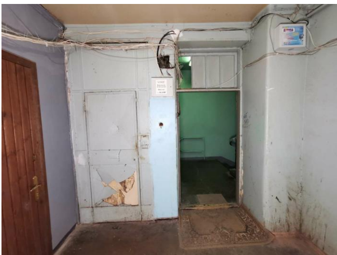
40. «Дом финского сберегательного банка», г. Выборг, Вокзальная ул., д.13. Подъезд №4. Общий вид. Фото 25.05.2021г.
