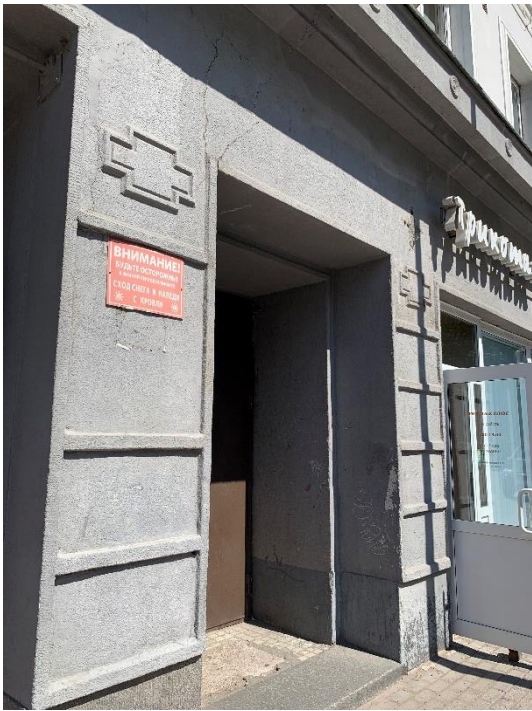
11. «Дом финского сберегательного банка», г. Выборг, Вокзальная ул., д.13. Южный фасад. Фрагмент. Фото 25.05.2021г.
