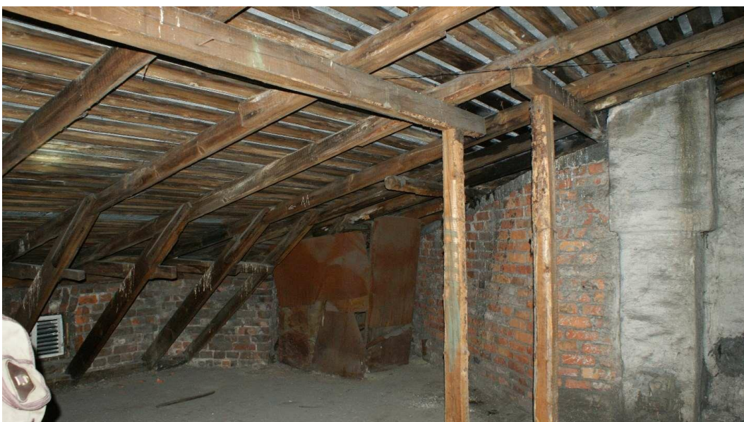
48. «Дом финского сберегательного банка», г. Выборг, Вокзальная ул., д.13. Кровля. Общий вид. Фото 25.05.2021г.
