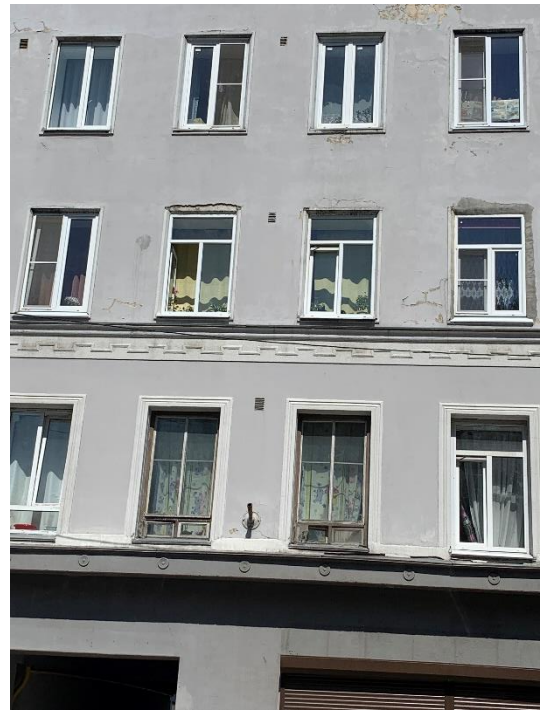
13. «Дом финского сберегательного банка», г. Выборг, Вокзальная ул., д.13. Южный фасад. Фрагмент. Фото 25.05.2021г.
