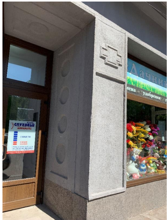
10. «Дом финского сберегательного банка», г. Выборг, Вокзальная ул., д.13. Южный фасад. Фрагмент. Фото 25.05.2021г.
