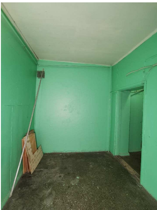
36. «Дом финского сберегательного банка», г. Выборг, Вокзальная ул., д.13. Подъезд №3. Общий вид. Фото 25.05.2021г.
