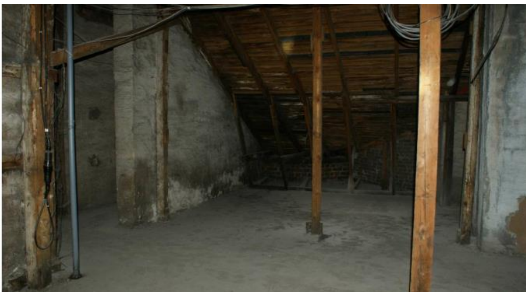
45. «Дом финского сберегательного банка», г. Выборг, Вокзальная ул., д.13. Кровля. Общий вид. Фото 25.05.2021г.
