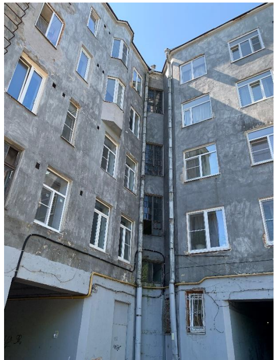
18. «Дом финского сберегательного банка», г. Выборг, Вокзальная ул., д.13. Дворовый фасад. Фрагмент. Фото 25.05.2021г.
