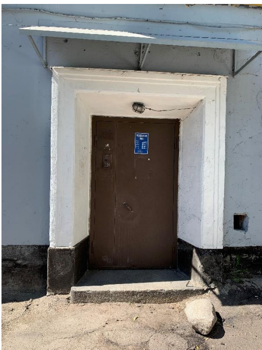
19. «Дом финского сберегательного банка», г. Выборг, Вокзальная ул., д.13. Дворовый фасад. Фрагмент. Фото 25.05.2021г.
