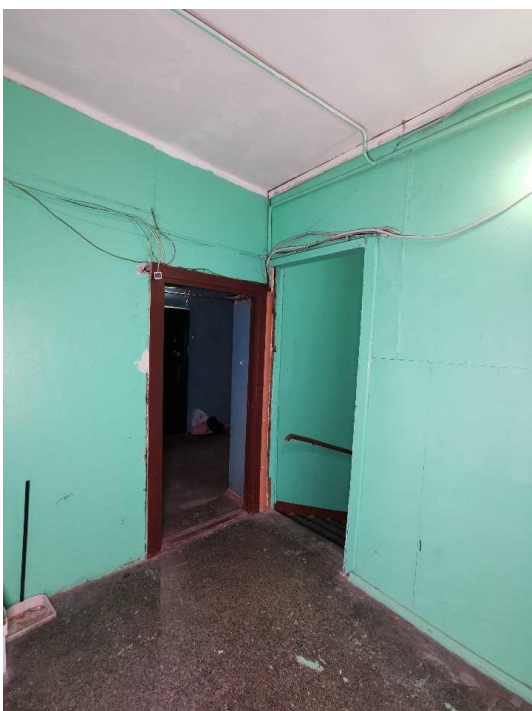
37. «Дом финского сберегательного банка», г. Выборг, Вокзальная ул., д.13. Подъезд №3. Общий вид. Фото 25.05.2021г.
