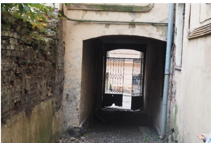
22. «Здание городского музея», г. Выборг, ул. Крепостная, д.2. Дворовый фасад. Фрагмент. Фото 25.05.2021г.
