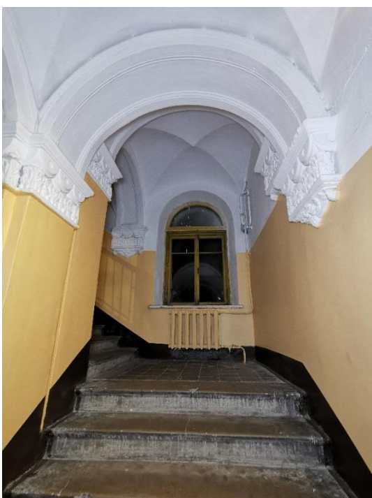
39. «Здание городского музея», г. Выборг, ул. Крепостная, д.2. Подъезд. Фрагмент. Фото 25.05.2021г.
