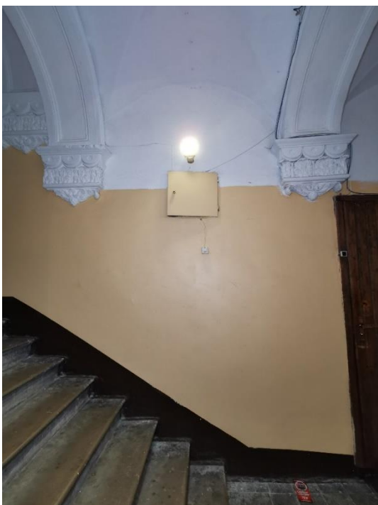
38. «Здание городского музея», г. Выборг, ул. Крепостная, д.2. Подъезд. Фрагмент. Фото 25.05.2021г.
