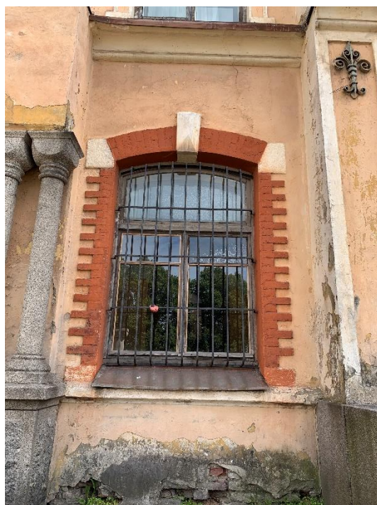
12. «Здание городского музея», г. Выборг, ул. Крепостная, д.2. Северо-западный фасад. Фрагмент. Фото 25.05.2021г.
