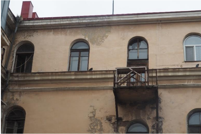
28. «Здание городского музея», г. Выборг, ул. Крепостная, д.2. Дворовый фасад. Фрагмент. Фото 25.05.2021г.
