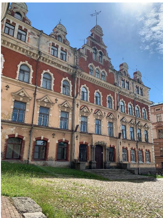
9. «Здание городского музея», г. Выборг, ул. Крепостная, д.2. Северо-западный фасад. Фрагмент. Фото 25.05.2021г.
