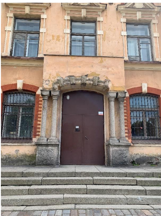
10. «Здание городского музея», г. Выборг, ул. Крепостная, д.2. Северо-западный фасад. Фрагмент. Фото 25.05.2021г.
