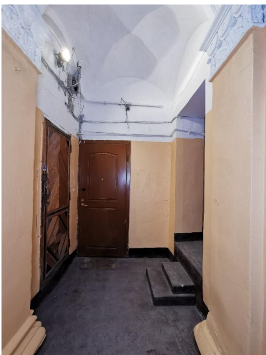
36. «Здание городского музея», г. Выборг, ул. Крепостная, д.2. Подъезд. Фрагмент. Фото 25.05.2021г.
