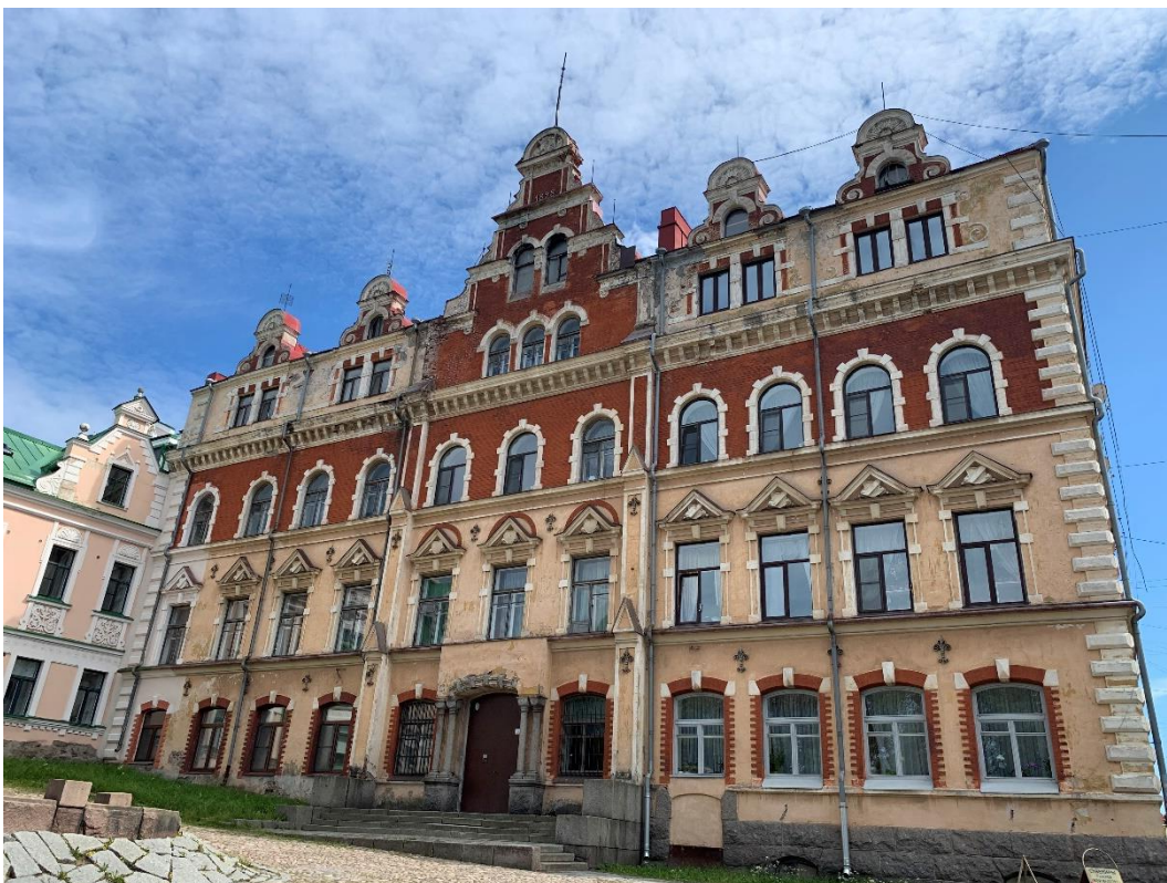
2. «Здание городского музея», г. Выборг, ул. Крепостная, д.2. Северо-западный фасад. Общий вид. Фото 25.05.2021г.
