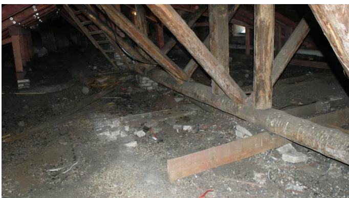
50. «Здание городского музея», г. Выборг, ул. Крепостная, д.2. Кровля. Фрагмент. Фото 25.05.2021г.
