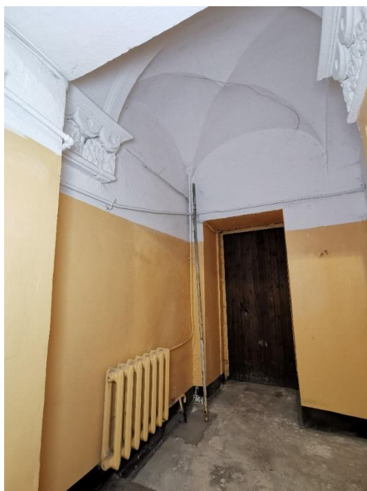
37. «Здание городского музея», г. Выборг, ул. Крепостная, д.2. Подъезд. Фрагмент. Фото 25.05.2021г.
