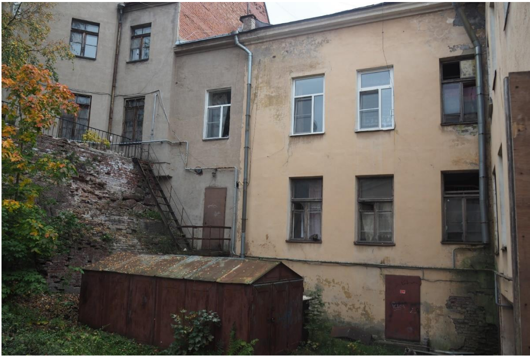
7. г. Выборг, ул. Крепостная, д.4. Дворовый фасад. Общий вид. Фото 25.05.2021г.
