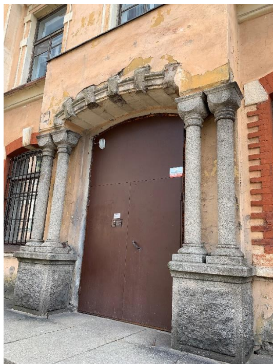
11. «Здание городского музея», г. Выборг, ул. Крепостная, д.2. Северо-западный фасад. Фрагмент. Фото 25.05.2021г.
