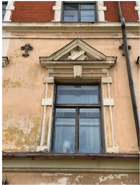
15. «Здание городского музея», г. Выборг, ул. Крепостная, д.2. Северо-западный фасад. Фрагмент. Фото 25.05.2021г.
