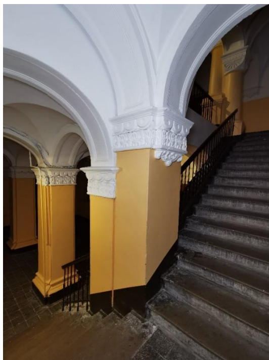
40. «Здание городского музея», г. Выборг, ул. Крепостная, д.2. Подъезд. Фрагмент. Фото 25.05.2021г.
