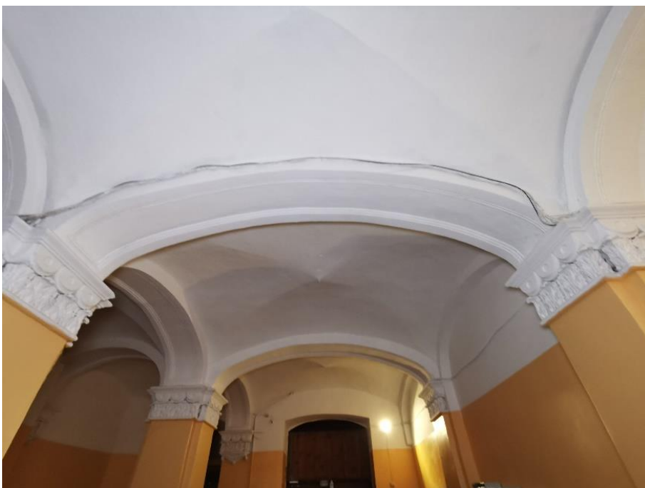
35. «Здание городского музея», г. Выборг, ул. Крепостная, д.2. Подъезд. Фрагмент. Фото 25.05.2021г.
