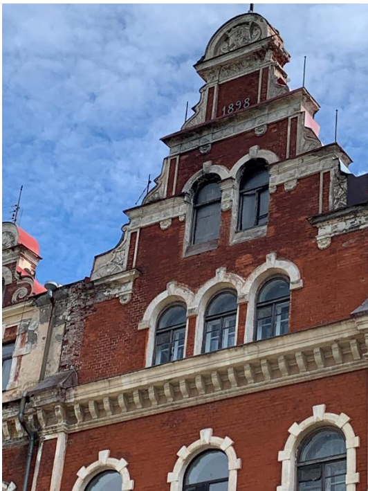
18. «Здание городского музея», г. Выборг, ул. Крепостная, д.2. Северо-западный фасад. Фрагмент. Фото 25.05.2021г.
