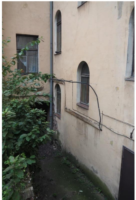
27. «Здание городского музея», г. Выборг, ул. Крепостная, д.2. Дворовый фасад. Фрагмент. Фото 25.05.2021г.
