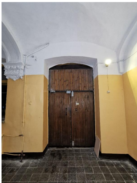
33. «Здание городского музея», г. Выборг, ул. Крепостная, д.2. Подъезд. Общий вид. Фото 25.05.2021г.
