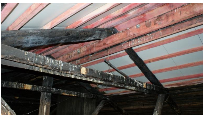
51. «Здание городского музея», г. Выборг, ул. Крепостная, д.2. Кровля. Фрагмент. Фото 25.05.2021г.
