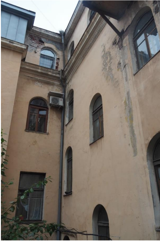
24. «Здание городского музея», г. Выборг, ул. Крепостная, д.2. Дворовый фасад. Фрагмент. Фото 25.05.2021г.
