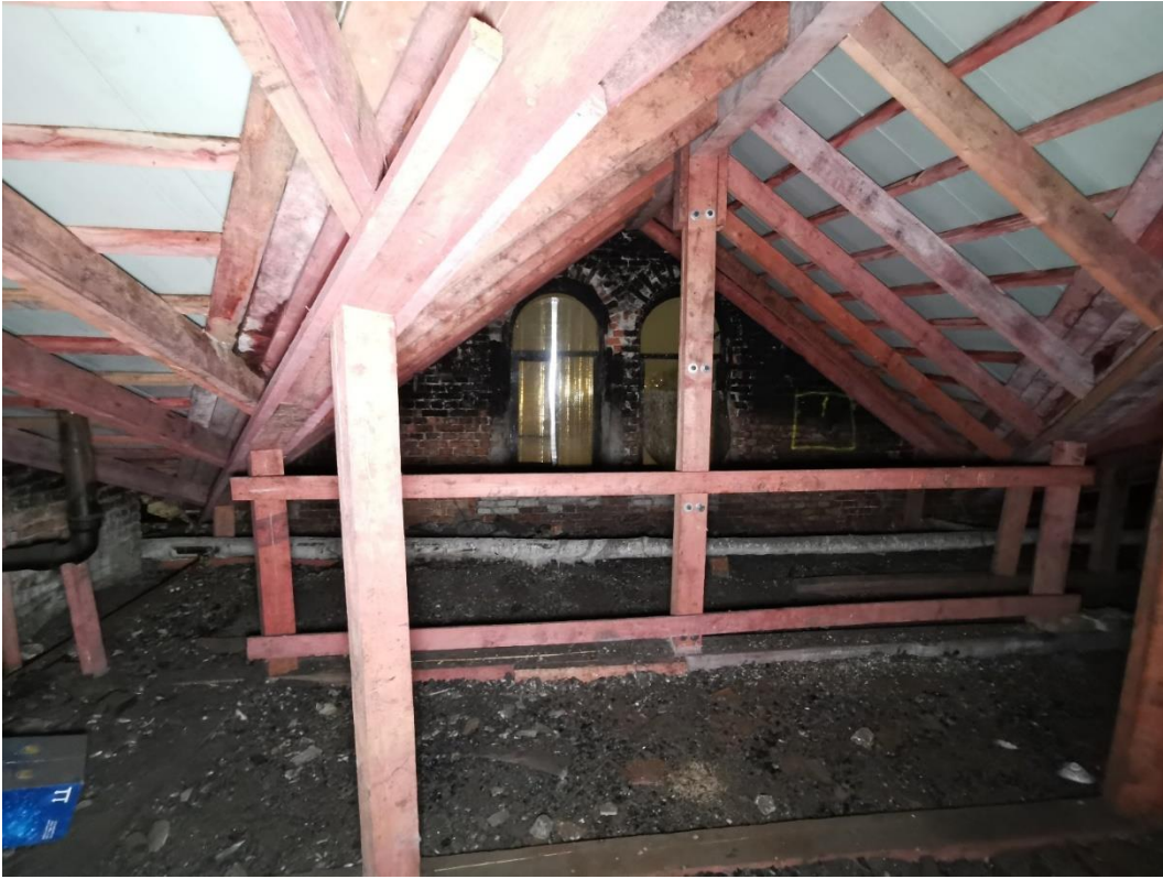
48. «Здание городского музея», г. Выборг, ул. Крепостная, д.2. Кровля. Общий вид. Фото 25.05.2021г.
