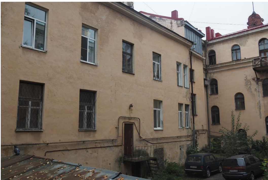
8. г. Выборг, ул. Крепостная, д.4. Дворовый фасад. Общий вид. Фото 25.05.2021г.
