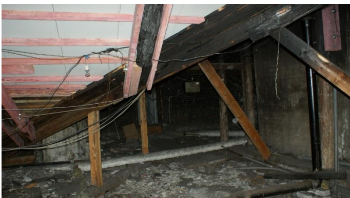
52. «Здание городского музея», г. Выборг, ул. Крепостная, д.2. Кровля. Фрагмент. Фото 25.05.2021г.
