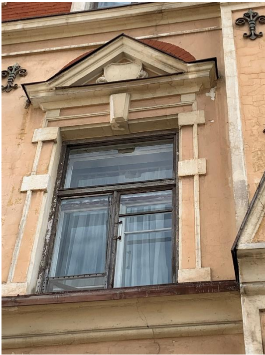
13. «Здание городского музея», г. Выборг, ул. Крепостная, д.2. Северо-западный фасад. Фрагмент. Фото 25.05.2021г.
