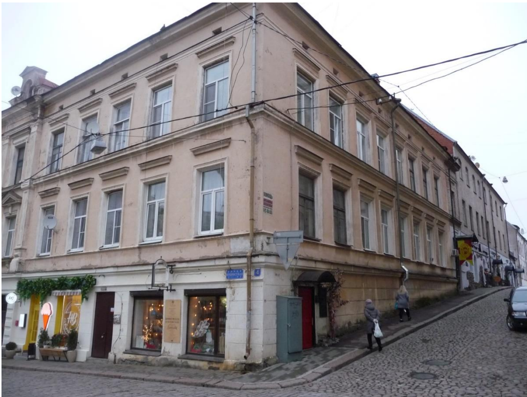
6. г. Выборг, ул. Крепостная, д.4. Юго-восточный фасад. Общий вид. Фото 25.05.2021г.
