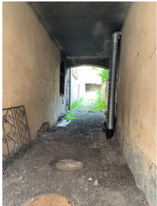
20. «Здание городского музея», г. Выборг, ул. Крепостная, д.2. Проход во двор. Общий вид. Фото 25.05.2021г.
