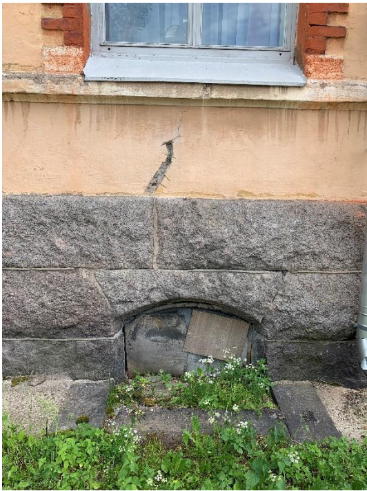
17. «Здание городского музея», г. Выборг, ул. Крепостная, д.2. Северо-западный фасад. Фрагмент. Фото 25.05.2021г.
