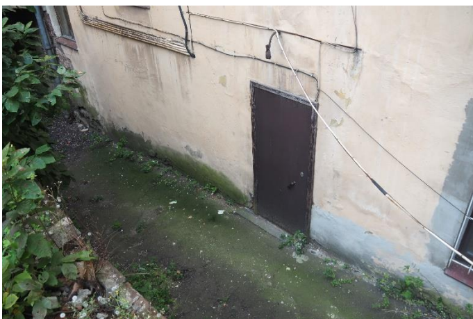
23. «Здание городского музея», г. Выборг, ул. Крепостная, д.2. Дворовый фасад. Фрагмент. Фото 25.05.2021г.
