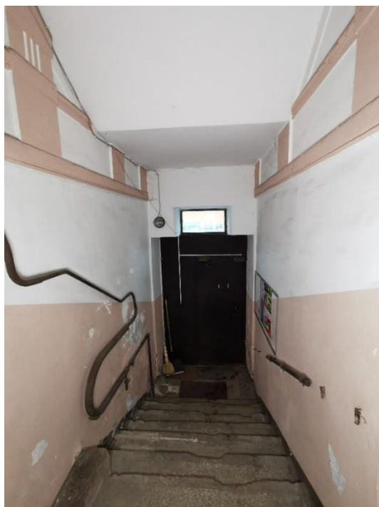
71. «Банк», г. Выборг, пр. Ленина 8А. Подъезд №3. Фрагмент. Фото 25.05.2021г.
