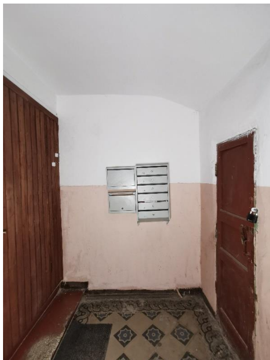
68. «Банк», г. Выборг, пр. Ленина 8А. Подъезд №3. Фрагмент. Фото 25.05.2021г.
