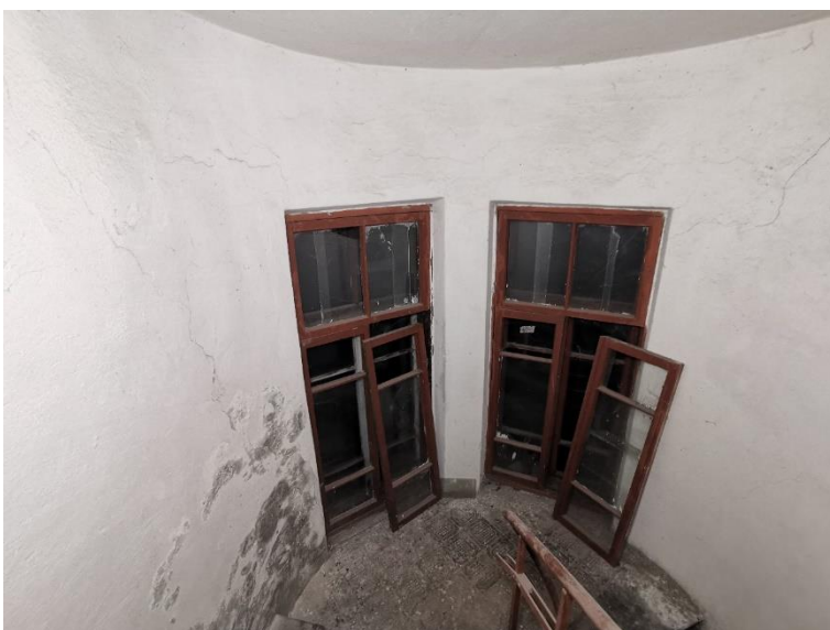
88. «Банк», г. Выборг, пр. Ленина 8А. Подъезд №4. Фрагмент. Фото 25.05.2021г.
