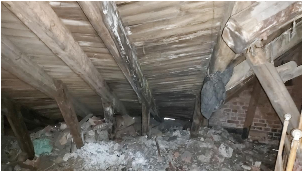
99. «Банк», г. Выборг, пр. Ленина 8А. Кровля. Общий вид. Фото 25.05.2021г.
