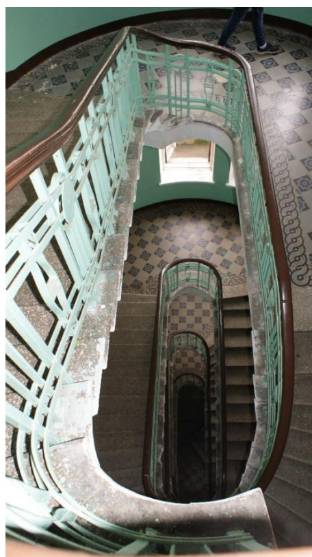
40. «Банк», г. Выборг, пр. Ленина 8А. Подъезд №1. Фрагмент. Фото 25.05.2021г.
