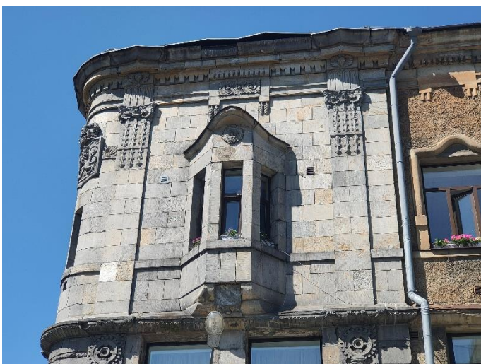
20. «Банк», г. Выборг, пр. Ленина 8А. Юго-восточный фасад. Фрагмент. Фото 25.05.2021г.
