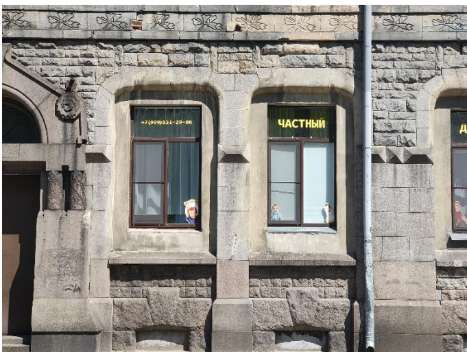
10. «Банк», г. Выборг, пр. Ленина 8А. Юго-западный фасад. Фрагмент. Фото 25.05.2021г.
