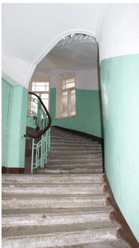
39. «Банк», г. Выборг, пр. Ленина 8А. Подъезд №1. Фрагмент. Фото 25.05.2021г.
