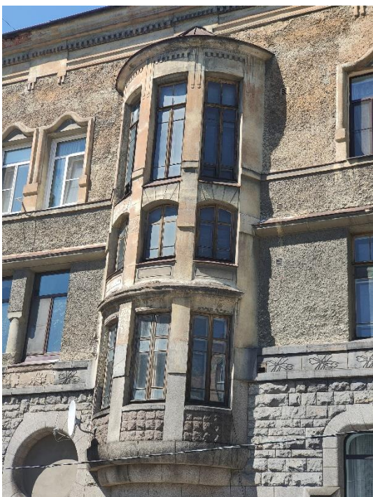
23. «Банк», г. Выборг, пр. Ленина 8А. Юго-восточный фасад. Фрагмент. Фото 25.05.2021г.
