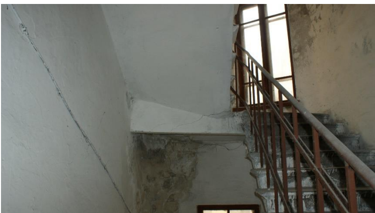
82. «Банк», г. Выборг, пр. Ленина 8А. Подъезд №4. Фрагмент. Фото 25.05.2021г.
