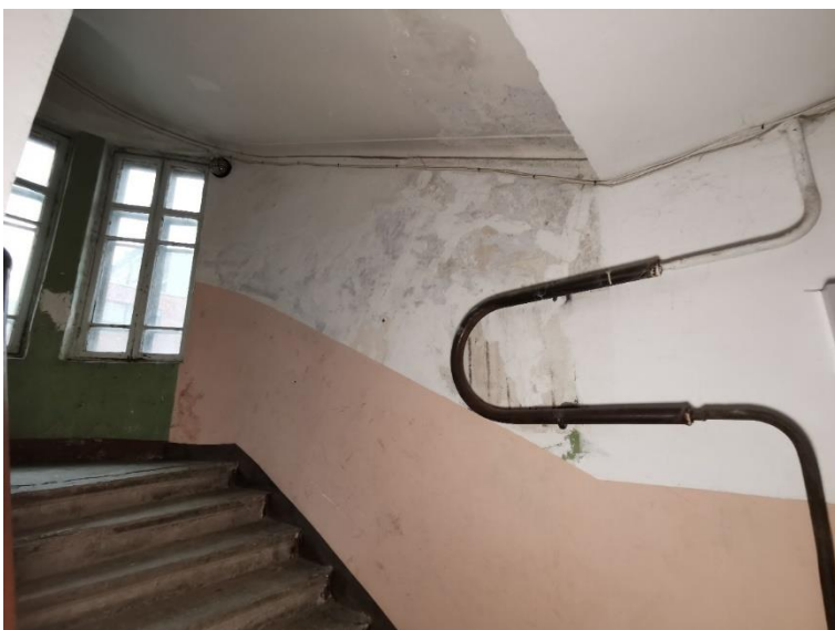
73. «Банк», г. Выборг, пр. Ленина 8А. Подъезд №3. Фрагмент. Фото 25.05.2021г.
