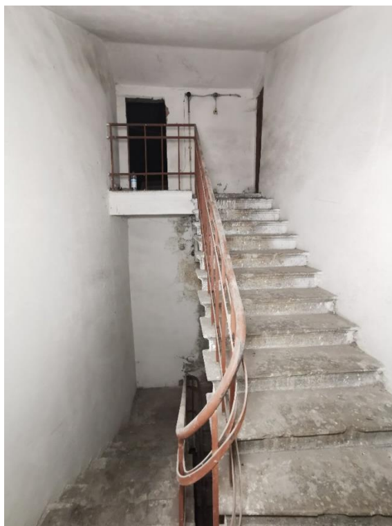
80. «Банк», г. Выборг, пр. Ленина 8А. Подъезд №4. Фрагмент. Фото 25.05.2021г.
