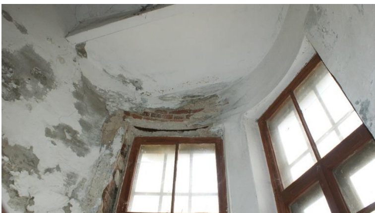
84. «Банк», г. Выборг, пр. Ленина 8А. Подъезд №4. Фрагмент. Фото 25.05.2021г.
