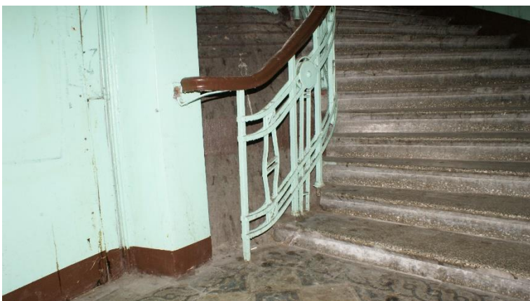
42. «Банк», г. Выборг, пр. Ленина 8А. Подъезд №1. Фрагмент. Фото 25.05.2021г.
