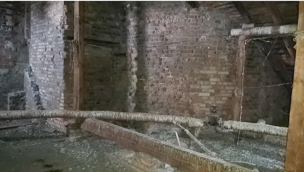
98. «Банк», г. Выборг, пр. Ленина 8А. Кровля. Общий вид. Фото 25.05.2021г.
