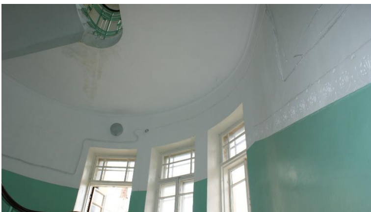
51. «Банк», г. Выборг, пр. Ленина 8А. Подъезд №1. Фрагмент. Фото 25.05.2021г.
