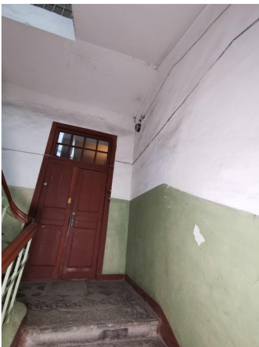
75. «Банк», г. Выборг, пр. Ленина 8А. Подъезд №3. Фрагмент. Фото 25.05.2021г.
