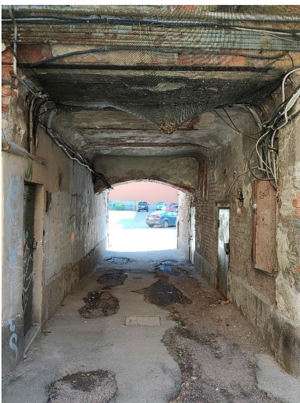
34. «Банк», г. Выборг, пр. Ленина 8А. Дворовый фасад. Фрагмент. Фото 25.05.2021г.
