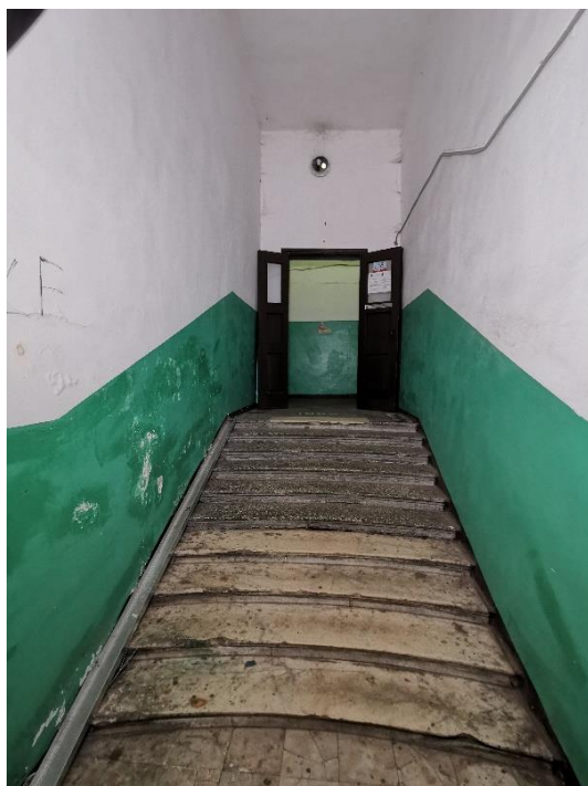
64. «Банк», г. Выборг, пр. Ленина 8А. Подъезд №2. Фрагмент. Фото 25.05.2021г.
