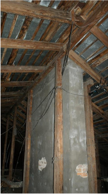
97. «Банк», г. Выборг, пр. Ленина 8А. Кровля. Общий вид. Фото 25.05.2021г.
