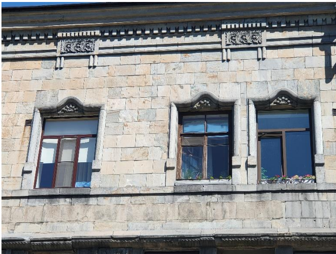
8. «Банк», г. Выборг, пр. Ленина 8А. Юго-западный фасад. Фрагмент. Фото 25.05.2021г.
