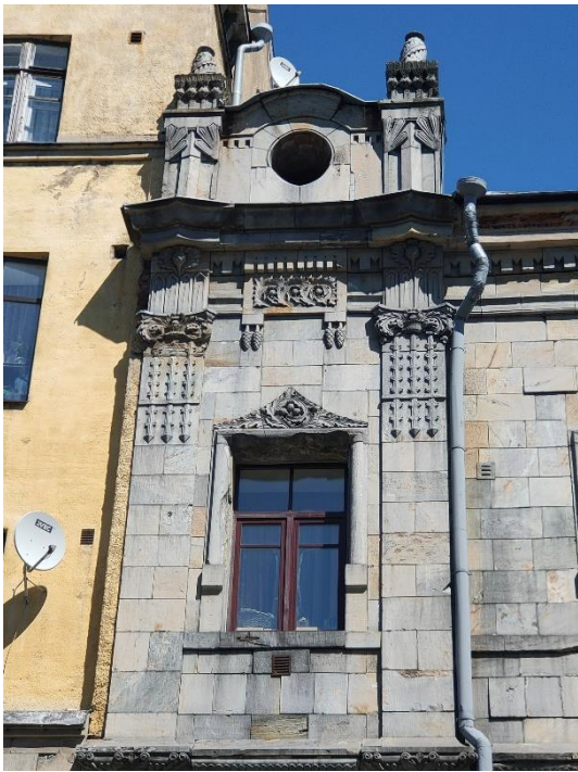
14. «Банк», г. Выборг, пр. Ленина 8А. Юго-западный фасад. Фрагмент. Фото 25.05.2021г.
