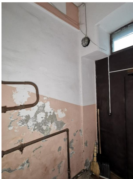
72. «Банк», г. Выборг, пр. Ленина 8А. Подъезд №3. Фрагмент. Фото 25.05.2021г.
