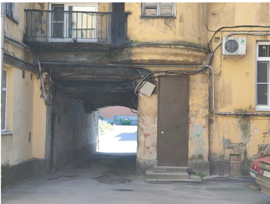
33. «Банк», г. Выборг, пр. Ленина 8А. Дворовый фасад. Фрагмент. Фото 25.05.2021г.
