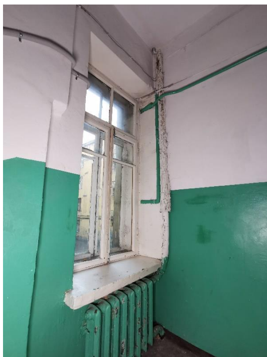
65. «Банк», г. Выборг, пр. Ленина 8А. Подъезд №2. Фрагмент. Фото 25.05.2021г.
