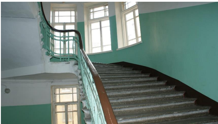
46. «Банк», г. Выборг, пр. Ленина 8А. Подъезд №1. Фрагмент. Фото 25.05.2021г.
