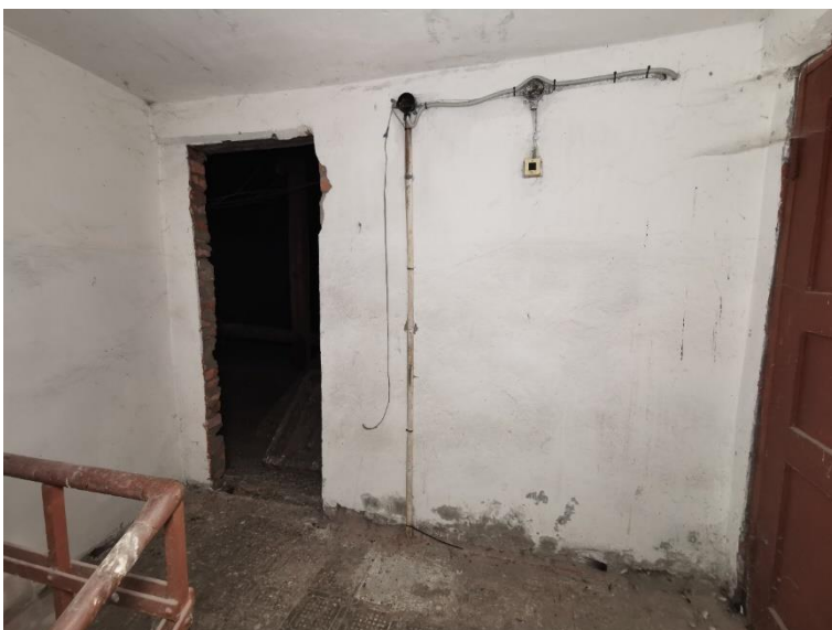
86. «Банк», г. Выборг, пр. Ленина 8А. Подъезд №4. Фрагмент. Фото 25.05.2021г.
