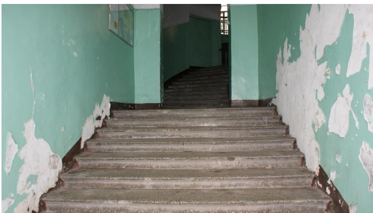
35. «Банк», г. Выборг, пр. Ленина 8А. Подъезд №1. Фрагмент. Фото 25.05.2021г.
