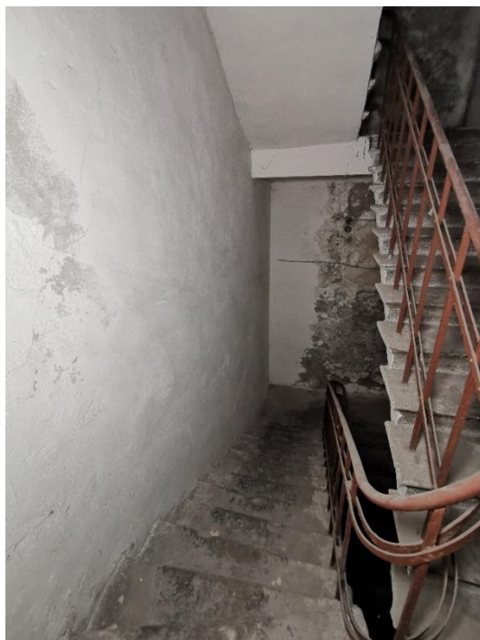
91. «Банк», г. Выборг, пр. Ленина 8А. Подъезд №4. Фрагмент. Фото 25.05.2021г.
