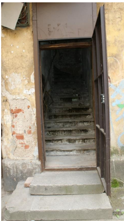
79. «Банк», г. Выборг, пр. Ленина 8А. Подъезд №4. Фрагмент. Фото 25.05.2021г.
