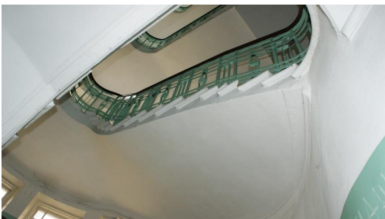
41. «Банк», г. Выборг, пр. Ленина 8А. Подъезд №1. Фрагмент. Фото 25.05.2021г.
