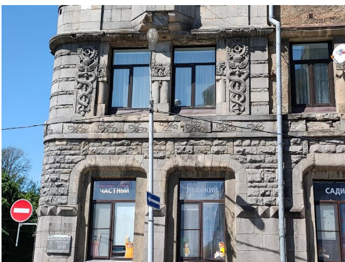
21. «Банк», г. Выборг, пр. Ленина 8А. Юго-восточный фасад. Фрагмент. Фото 25.05.2021г.
