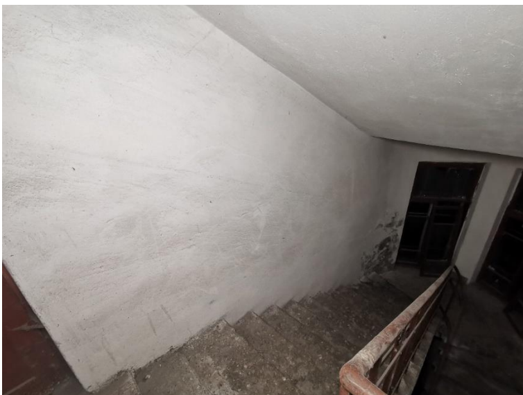
87. «Банк», г. Выборг, пр. Ленина 8А. Подъезд №4. Фрагмент. Фото 25.05.2021г.
