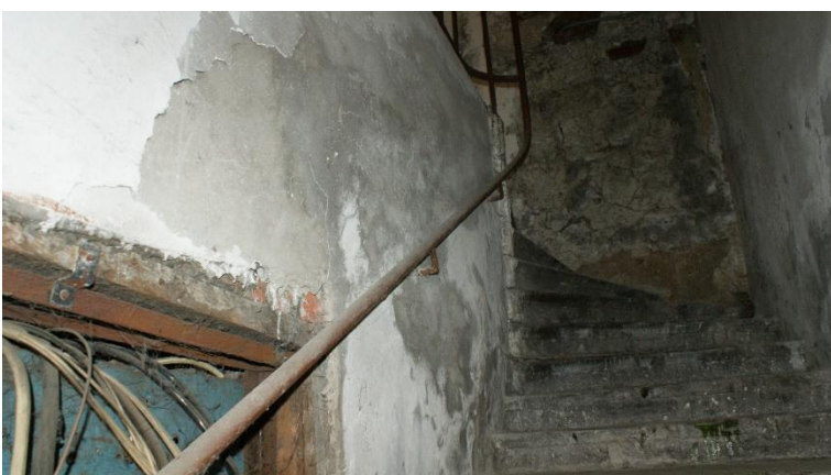
81. «Банк», г. Выборг, пр. Ленина 8А. Подъезд №4. Фрагмент. Фото 25.05.2021г.
