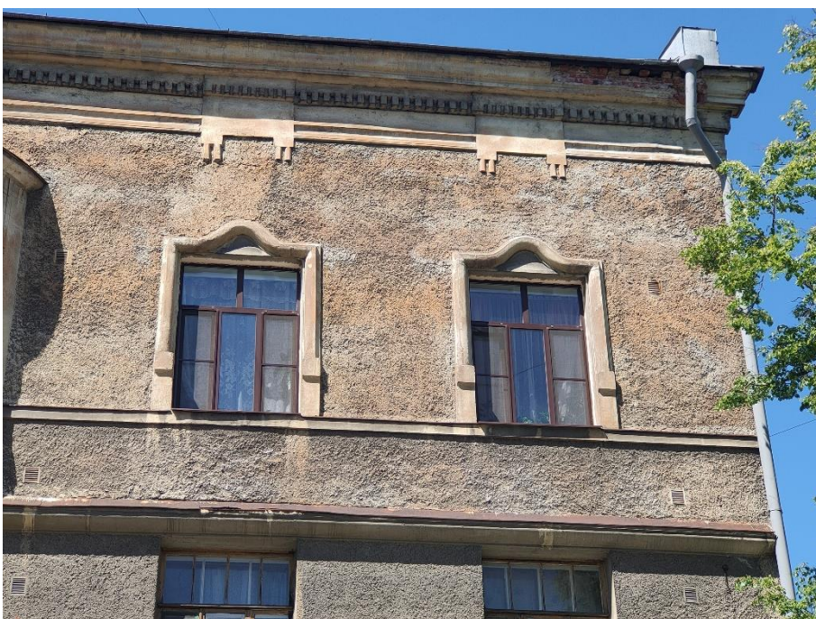
27. «Банк», г. Выборг, пр. Ленина 8А. Юго-восточный фасад. Фрагмент. Фото 25.05.2021г.
