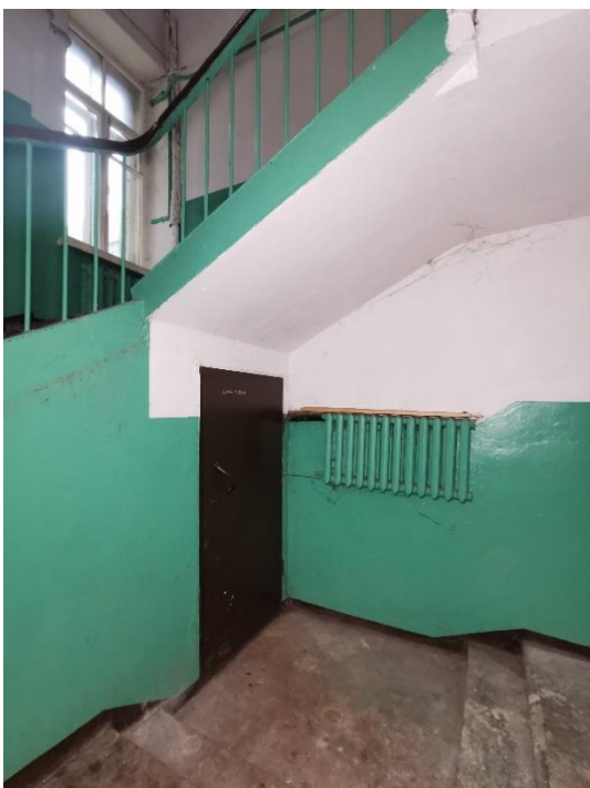
55. «Банк», г. Выборг, пр. Ленина 8А. Подъезд №2. Фрагмент. Фото 25.05.2021г.
