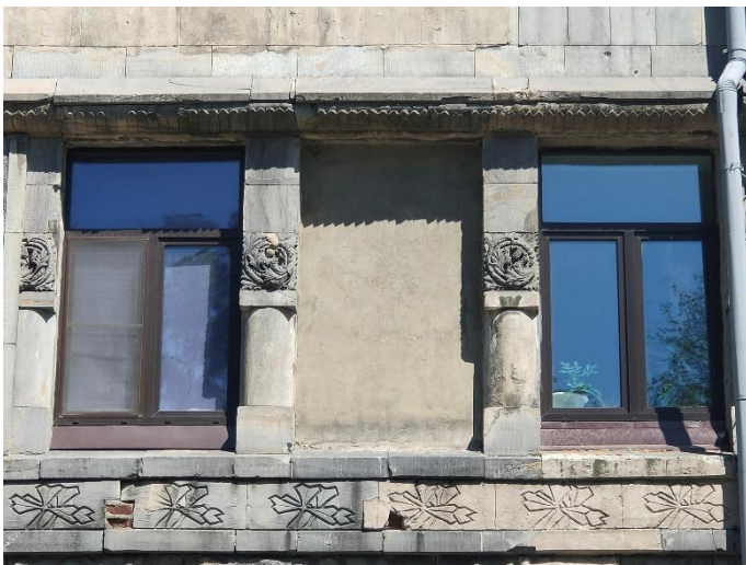
9. «Банк», г. Выборг, пр. Ленина 8А. Юго-западный фасад. Фрагмент. Фото 25.05.2021г.
