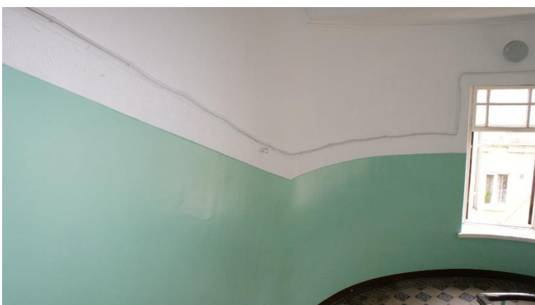
52. «Банк», г. Выборг, пр. Ленина 8А. Подъезд №1. Фрагмент. Фото 25.05.2021г.
