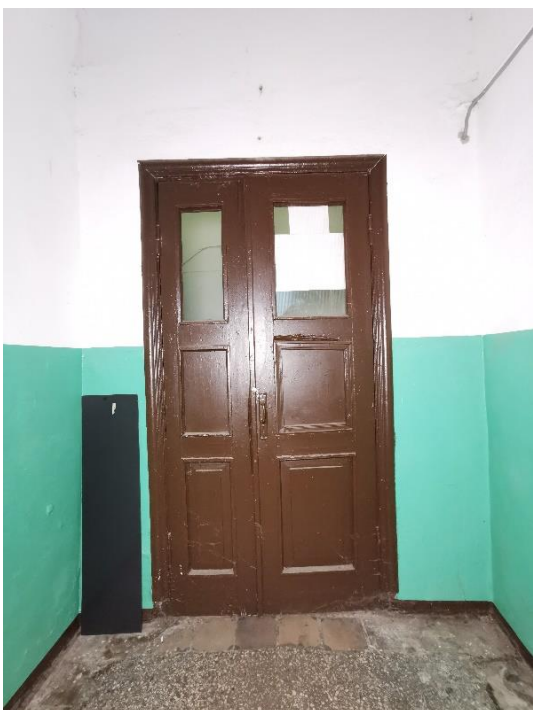
53. «Банк», г. Выборг, пр. Ленина 8А. Подъезд №2. Фрагмент. Фото 25.05.2021г.
