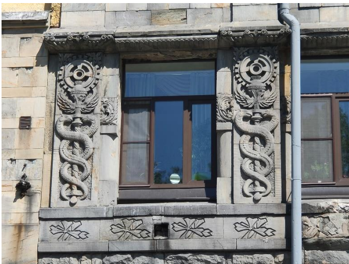
18. «Банк», г. Выборг, пр. Ленина 8А. Юго-западный фасад. Фрагмент. Фото 25.05.2021г.
