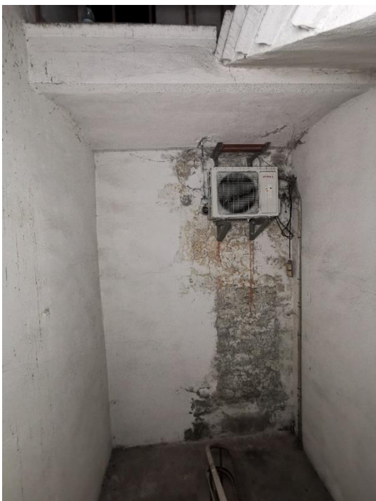
89. «Банк», г. Выборг, пр. Ленина 8А. Подъезд №4. Фрагмент. Фото 25.05.2021г.
