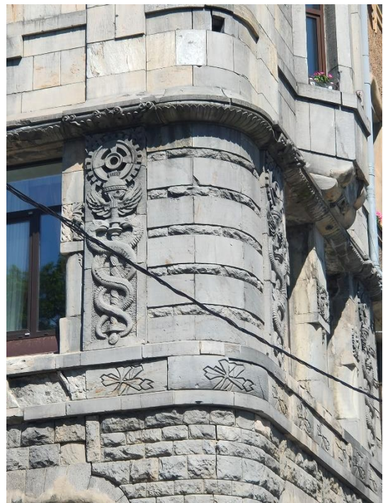
7. «Банк», г. Выборг, пр. Ленина 8А. Юго-западный фасад. Фрагмент. Фото 25.05.2021г.
