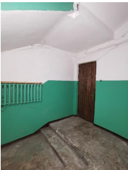
56. «Банк», г. Выборг, пр. Ленина 8А. Подъезд №2. Фрагмент. Фото 25.05.2021г.
