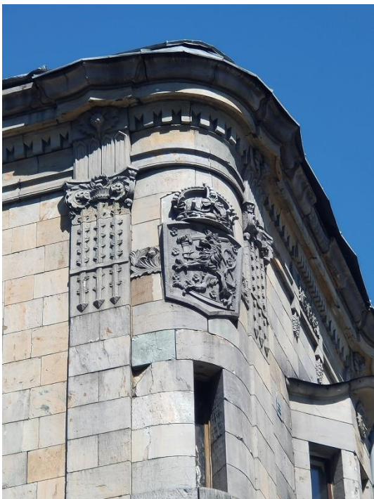
6. «Банк», г. Выборг, пр. Ленина 8А. Юго-западный фасад. Фрагмент. Фото 25.05.2021г.
