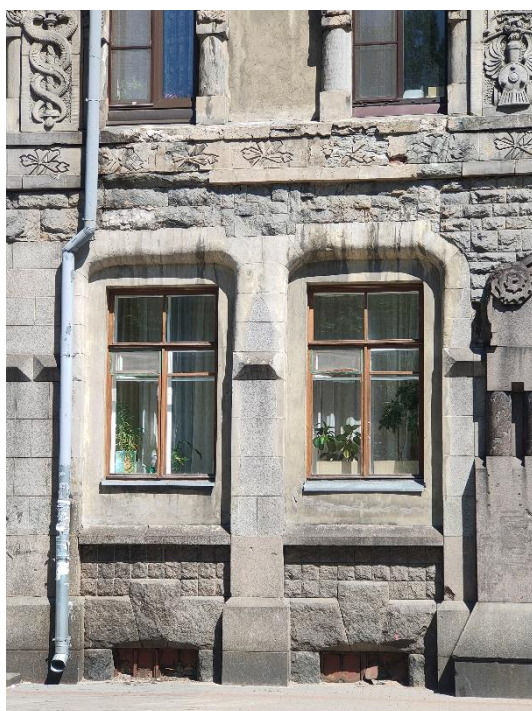
13. «Банк», г. Выборг, пр. Ленина 8А. Юго-западный фасад. Фрагмент. Фото 25.05.2021г.
