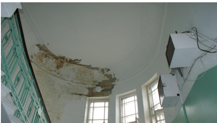
38. «Банк», г. Выборг, пр. Ленина 8А. Подъезд №1. Фрагмент. Фото 25.05.2021г.
