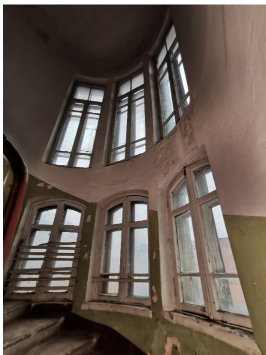
78. «Банк», г. Выборг, пр. Ленина 8А. Подъезд №3. Фрагмент. Фото 25.05.2021г.
