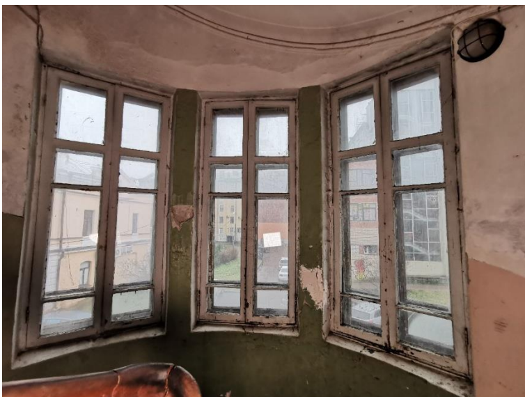
74. «Банк», г. Выборг, пр. Ленина 8А. Подъезд №3. Фрагмент. Фото 25.05.2021г.
