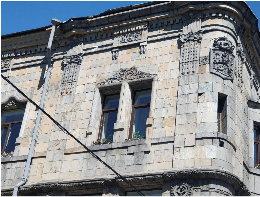
5. «Банк», г. Выборг, пр. Ленина 8А. Юго-западный фасад. Фрагмент. Фото 25.05.2021г.
