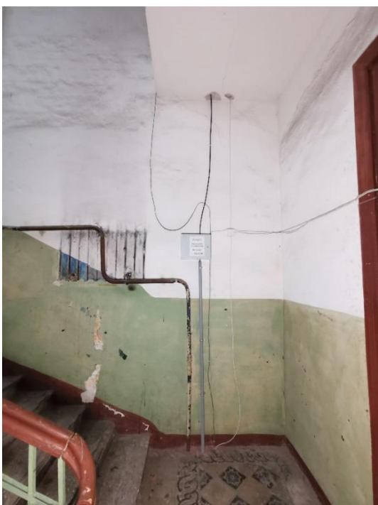
76. «Банк», г. Выборг, пр. Ленина 8А. Подъезд №3. Фрагмент. Фото 25.05.2021г.
