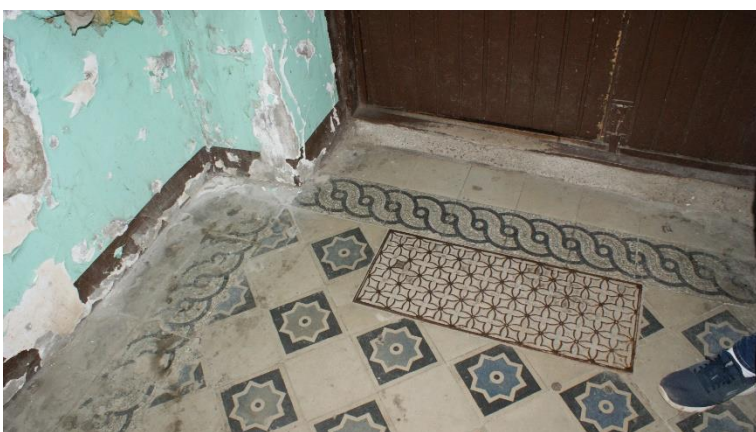
36. «Банк», г. Выборг, пр. Ленина 8А. Подъезд №1. Фрагмент. Фото 25.05.2021г.
