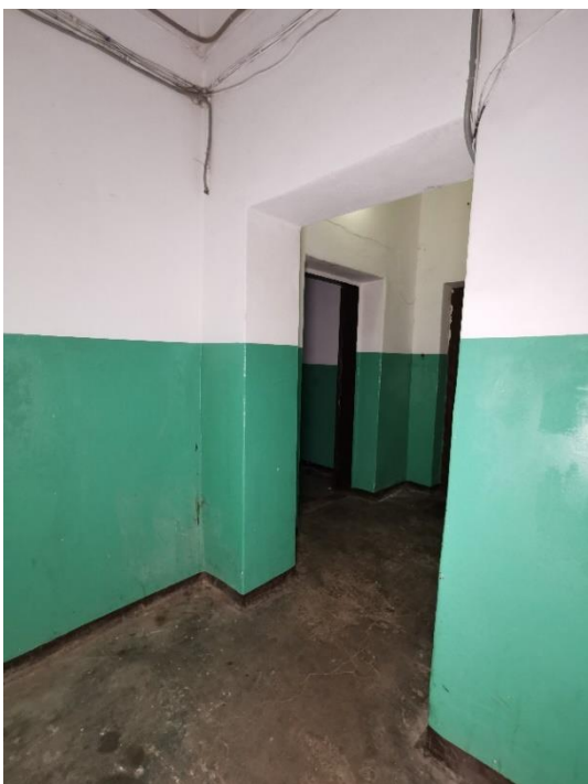
62. «Банк», г. Выборг, пр. Ленина 8А. Подъезд №2. Фрагмент. Фото 25.05.2021г.
