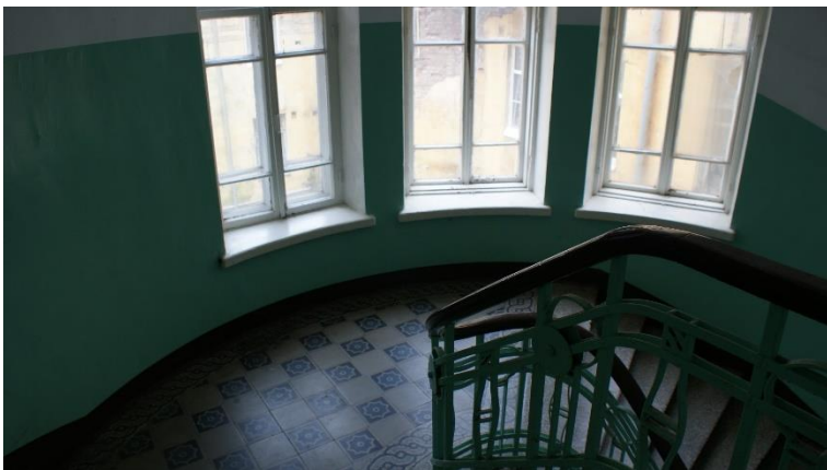
48. «Банк», г. Выборг, пр. Ленина 8А. Подъезд №1. Фрагмент. Фото 25.05.2021г.
