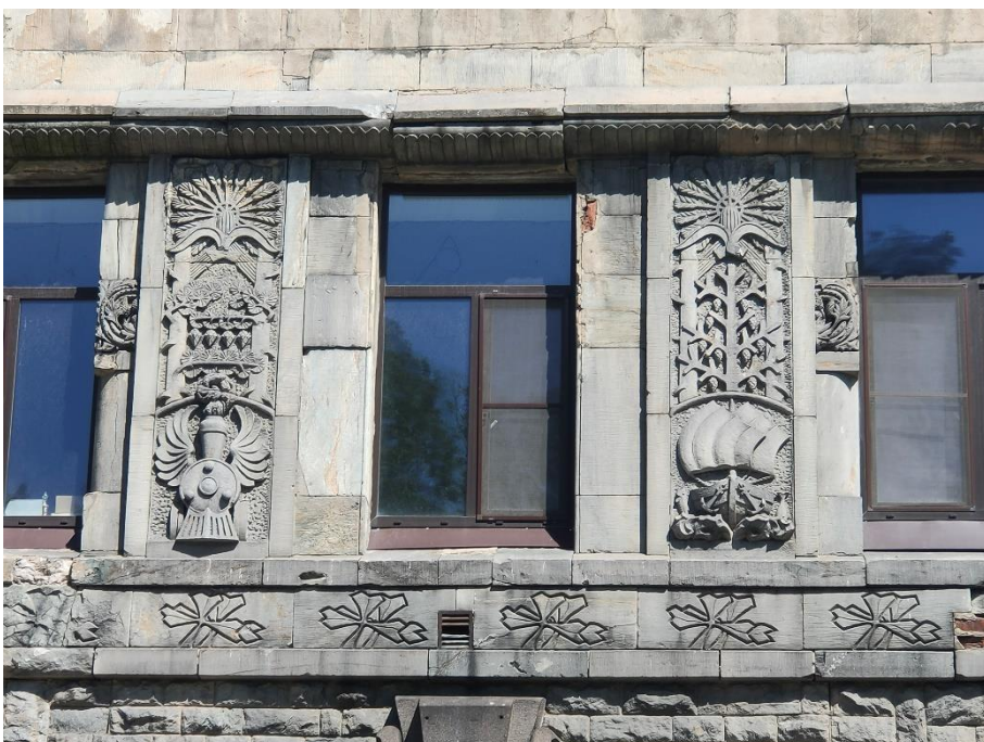
11. «Банк», г. Выборг, пр. Ленина 8А. Юго-западный фасад. Фрагмент. Фото 25.05.2021г.
