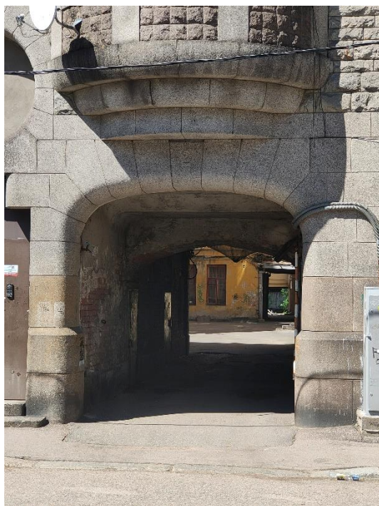
24. «Банк», г. Выборг, пр. Ленина 8А. Юго-восточный фасад. Фрагмент. Фото 25.05.2021г.
