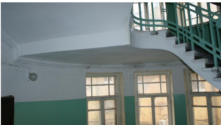
44. «Банк», г. Выборг, пр. Ленина 8А. Подъезд №1. Фрагмент. Фото 25.05.2021г.
