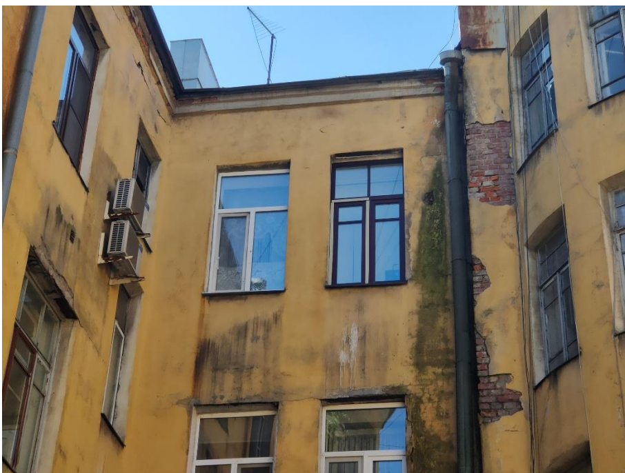
29. «Банк», г. Выборг, пр. Ленина 8А. Дворовый фасад. Фрагмент. Фото 25.05.2021г.
