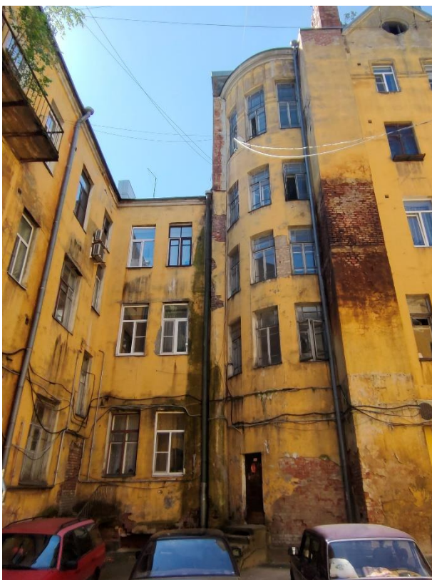
28. «Банк», г. Выборг, пр. Ленина 8А. Дворовый фасад. Фрагмент. Фото 25.05.2021г.
