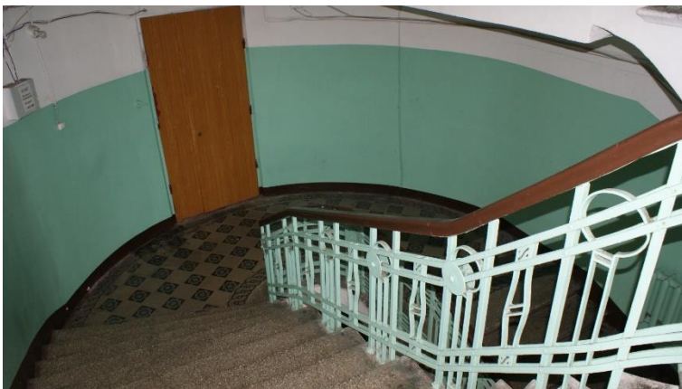
47. «Банк», г. Выборг, пр. Ленина 8А. Подъезд №1. Фрагмент. Фото 25.05.2021г.
