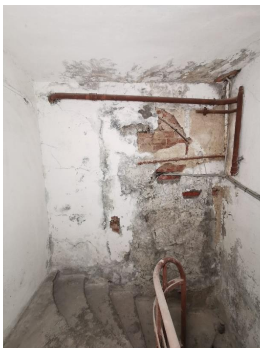
92. «Банк», г. Выборг, пр. Ленина 8А. Подъезд №4. Фрагмент. Фото 25.05.2021г.
