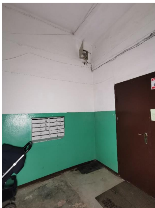
58. «Банк», г. Выборг, пр. Ленина 8А. Подъезд №2. Фрагмент. Фото 25.05.2021г.
