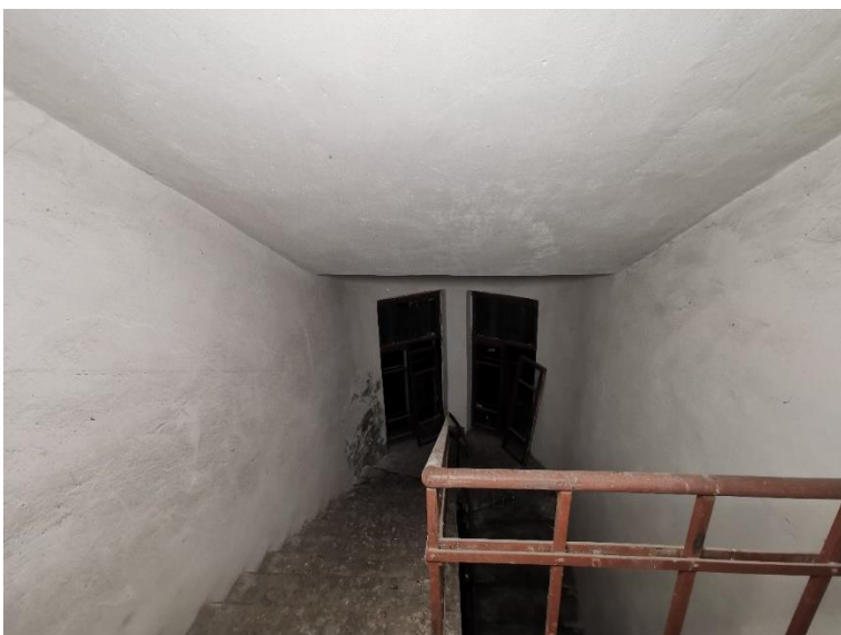
85. «Банк», г. Выборг, пр. Ленина 8А. Подъезд №4. Фрагмент. Фото 25.05.2021г.
