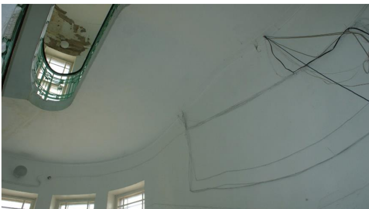
49. «Банк», г. Выборг, пр. Ленина 8А. Подъезд №1. Фрагмент. Фото 25.05.2021г.
