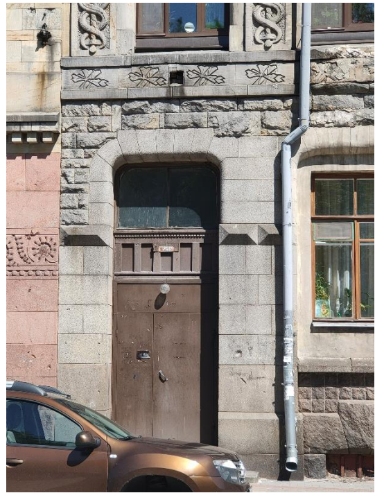
15. «Банк», г. Выборг, пр. Ленина 8А. Юго-западный фасад. Фрагмент. Фото 25.05.2021г.
