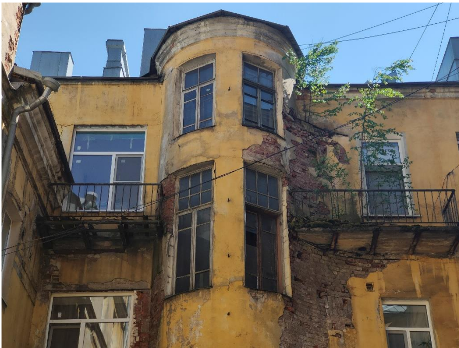
32. «Банк», г. Выборг, пр. Ленина 8А. Дворовый фасад. Фрагмент. Фото 25.05.2021г.
