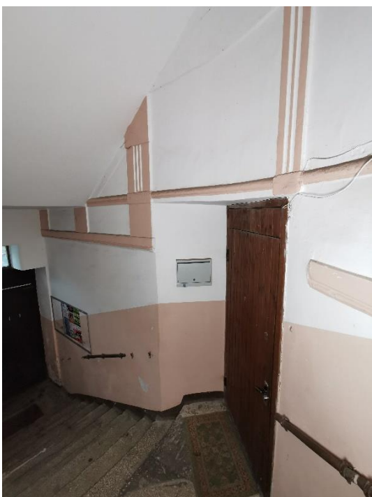
70. «Банк», г. Выборг, пр. Ленина 8А. Подъезд №3. Фрагмент. Фото 25.05.2021г.
