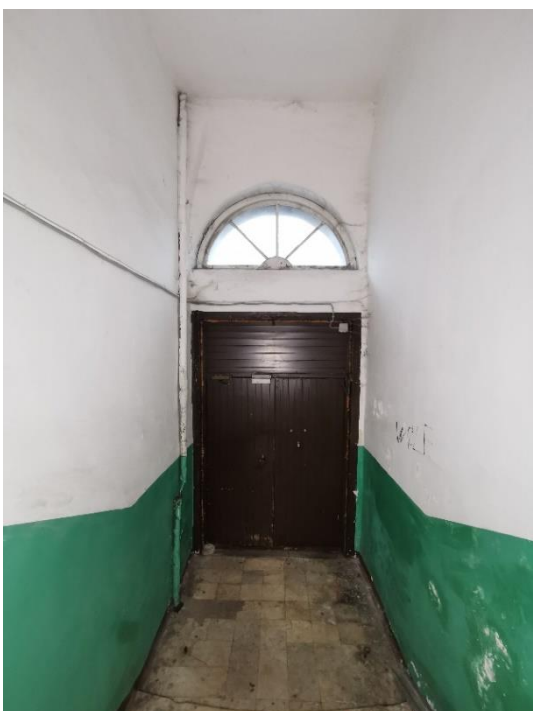
63. «Банк», г. Выборг, пр. Ленина 8А. Подъезд №2. Фрагмент. Фото 25.05.2021г.
