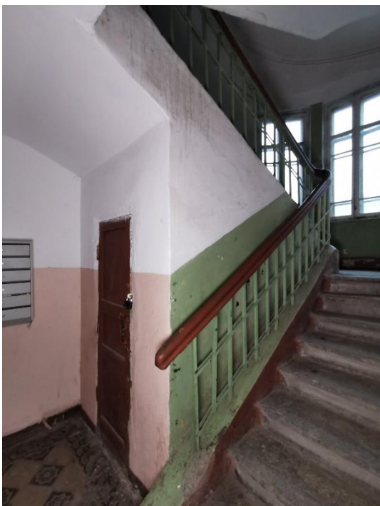
67. «Банк», г. Выборг, пр. Ленина 8А. Подъезд №3. Фрагмент. Фото 25.05.2021г.
