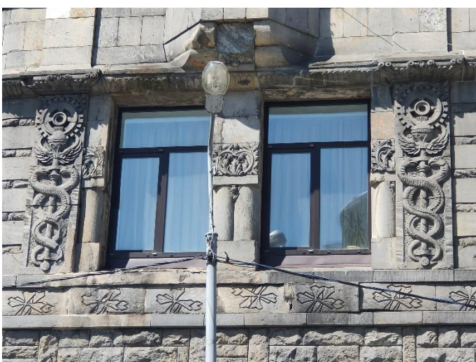
22. «Банк», г. Выборг, пр. Ленина 8А. Юго-восточный фасад. Фрагмент. Фото 25.05.2021г.
