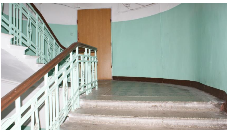
43. «Банк», г. Выборг, пр. Ленина 8А. Подъезд №1. Фрагмент. Фото 25.05.2021г.
