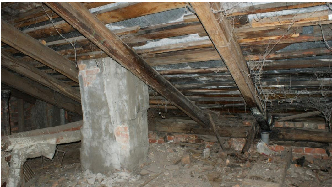
100. «Банк», г. Выборг, пр. Ленина 8А. Кровля. Общий вид. Фото 25.05.2021г.
