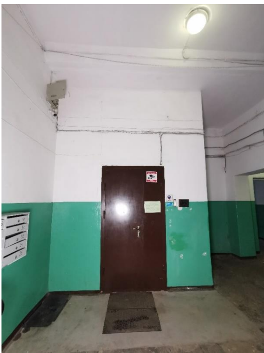
59. «Банк», г. Выборг, пр. Ленина 8А. Подъезд №2. Фрагмент. Фото 25.05.2021г.
