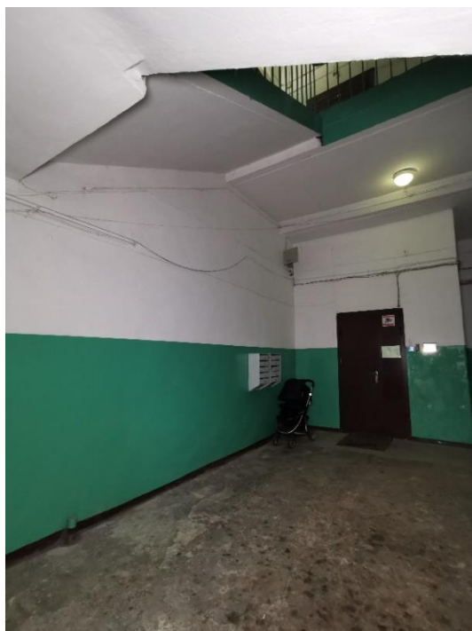
57. «Банк», г. Выборг, пр. Ленина 8А. Подъезд №2. Фрагмент. Фото 25.05.2021г.
