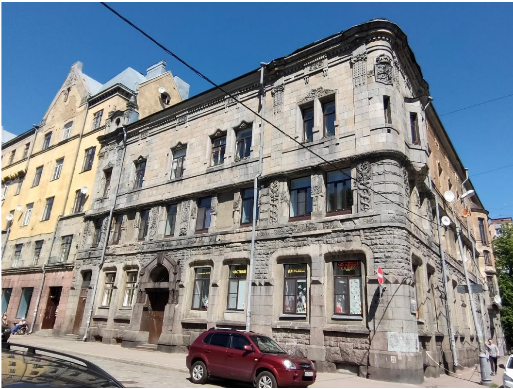
1. «Банк», г. Выборг, пр. Ленина 8А. Юго-западный фасад. Общий вид. Фото 25.05.2021г.
