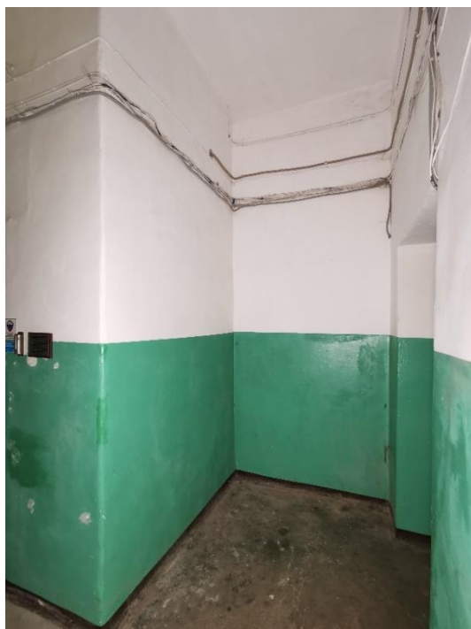
60. «Банк», г. Выборг, пр. Ленина 8А. Подъезд №2. Фрагмент. Фото 25.05.2021г.
