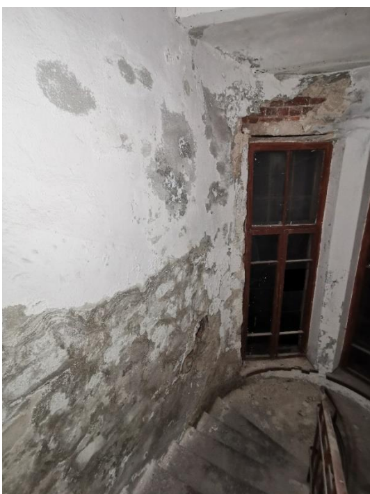
90. «Банк», г. Выборг, пр. Ленина 8А. Подъезд №4. Фрагмент. Фото 25.05.2021г.
