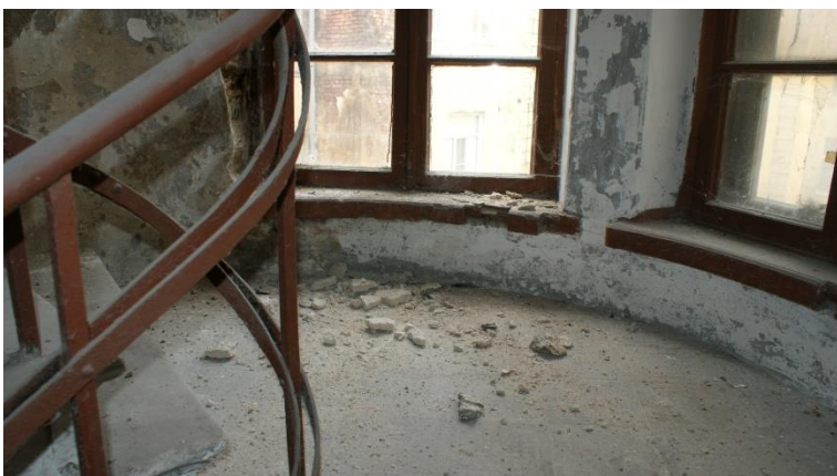
83. «Банк», г. Выборг, пр. Ленина 8А. Подъезд №4. Фрагмент. Фото 25.05.2021г.
