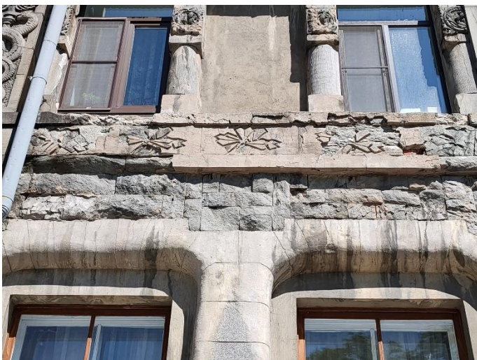
19. «Банк», г. Выборг, пр. Ленина 8А. Юго-западный фасад. Фрагмент. Фото 25.05.2021г.
