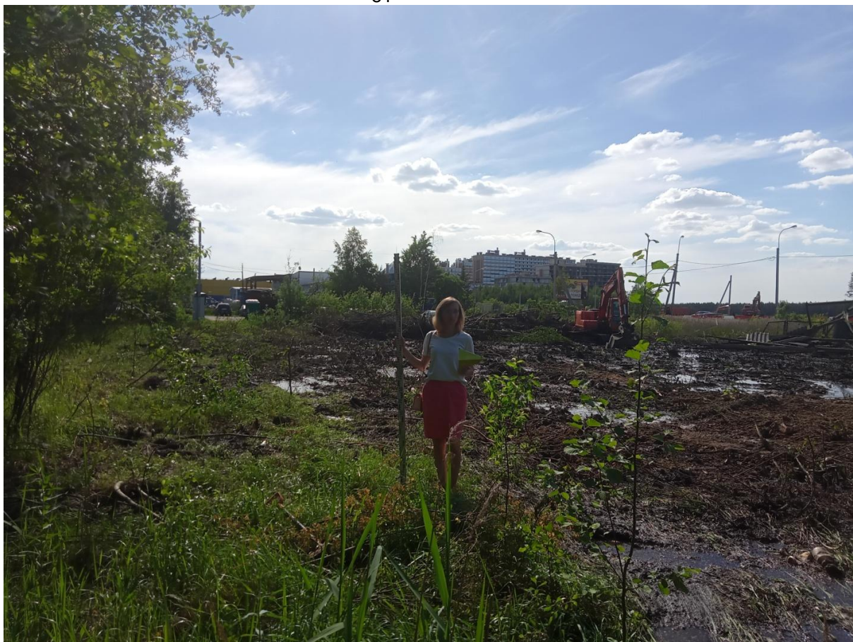
Рис. 17. Всеволожск, ул. Культуры, уч. 64 с КН: 47:07:1301090:16, 2021. Точка фотофиксации 4, вид на запад.
