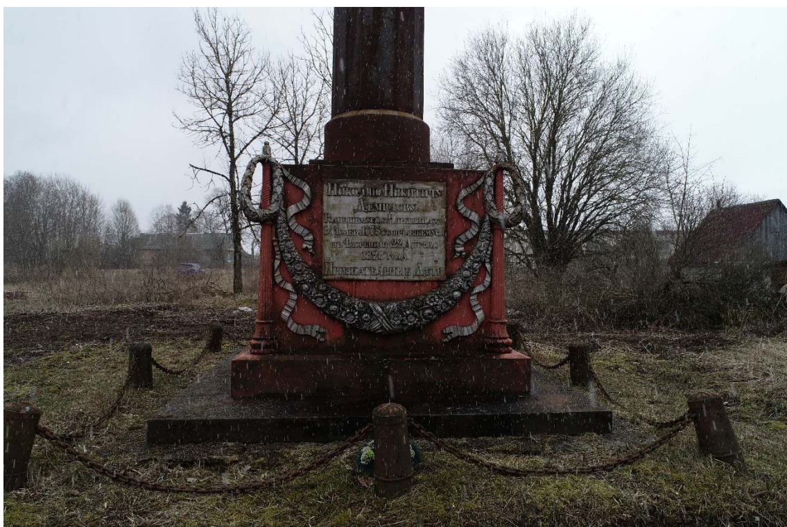
Фото 3. Главный фасад колонны с памятным текстом
