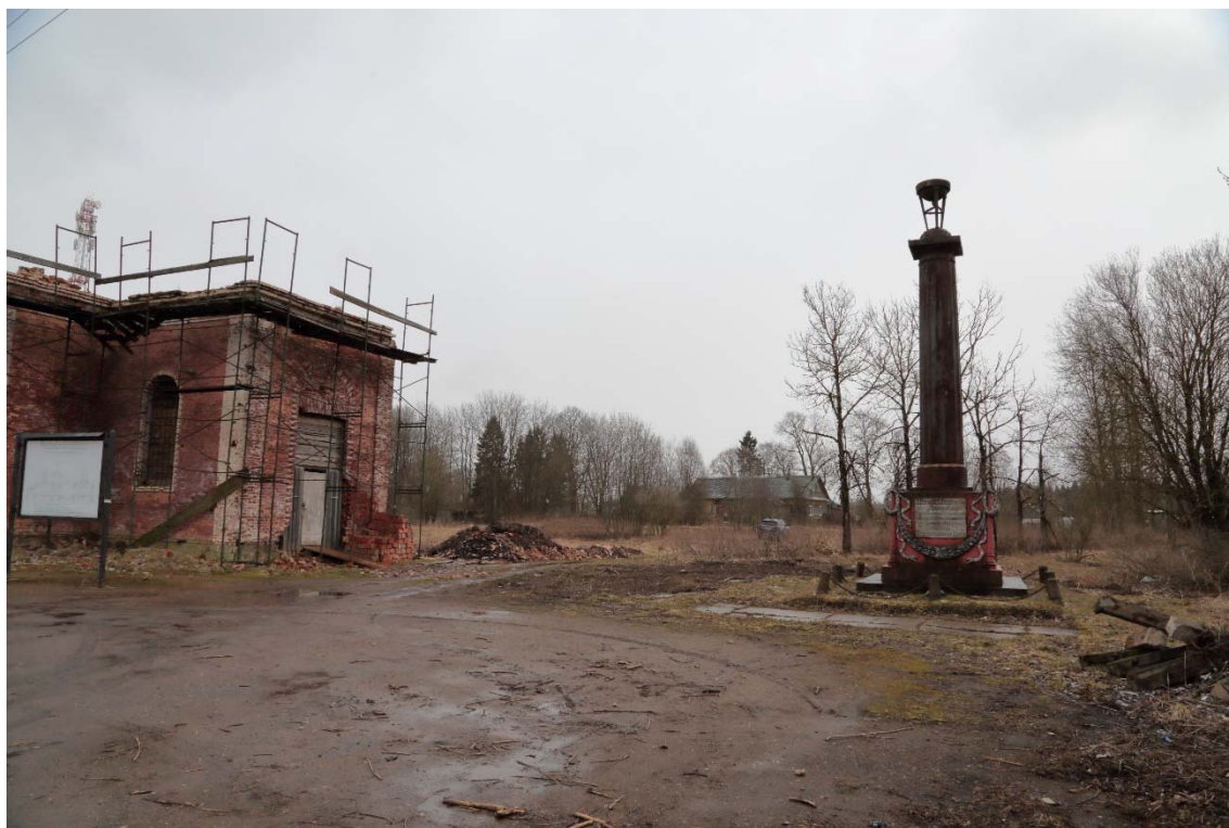
Фото 4. Вид на колонну с северо-запада.
