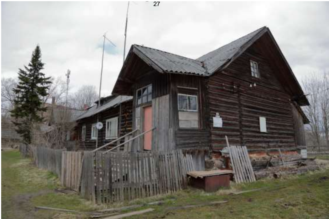
Фото 1. Вид на юго-восточный фасад
