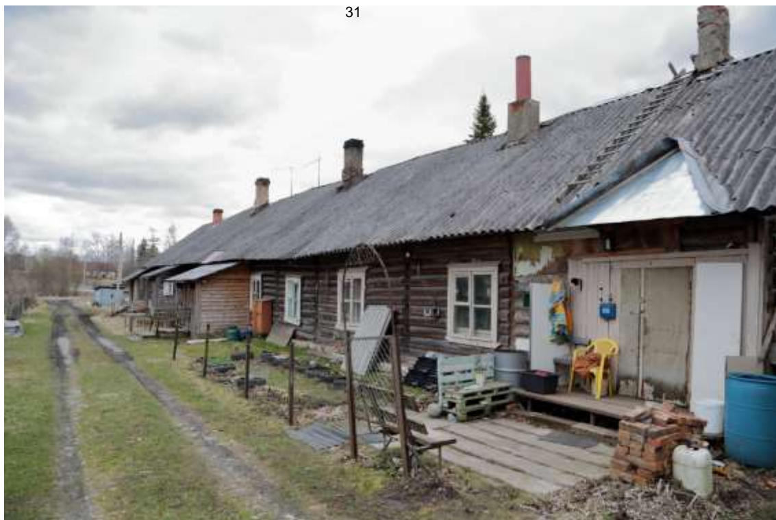
Фото 9. Вид вдоль северо-восточного фасада
