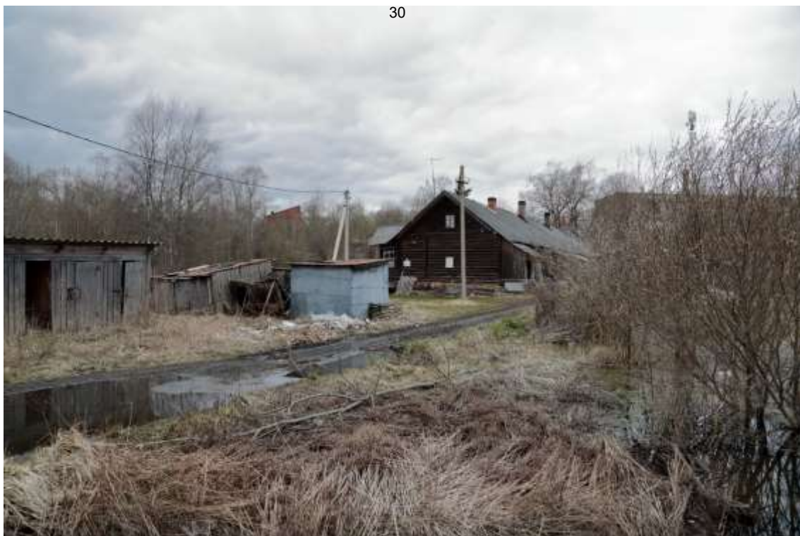
Фото 7. Вид с юго-востока бытовые постройки.
