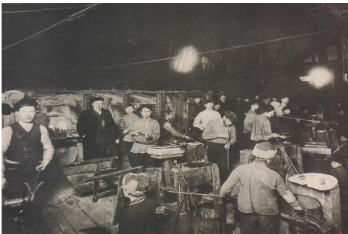
Илл.12. Стеклодувы во время работы, фотография К.К. Булла 1915 г. Источник: www.drujnayagorka.ru
