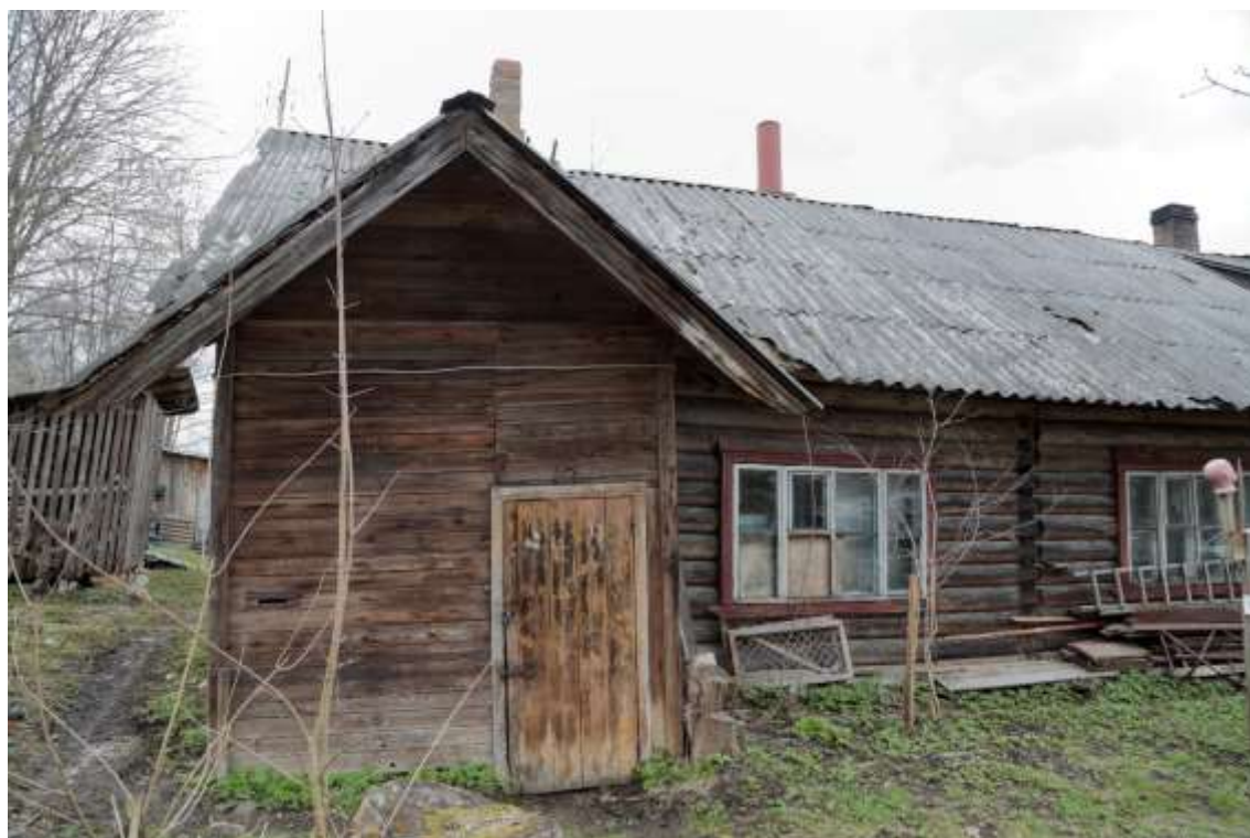
Фото 4 Фрагмент юго-западного фасада
