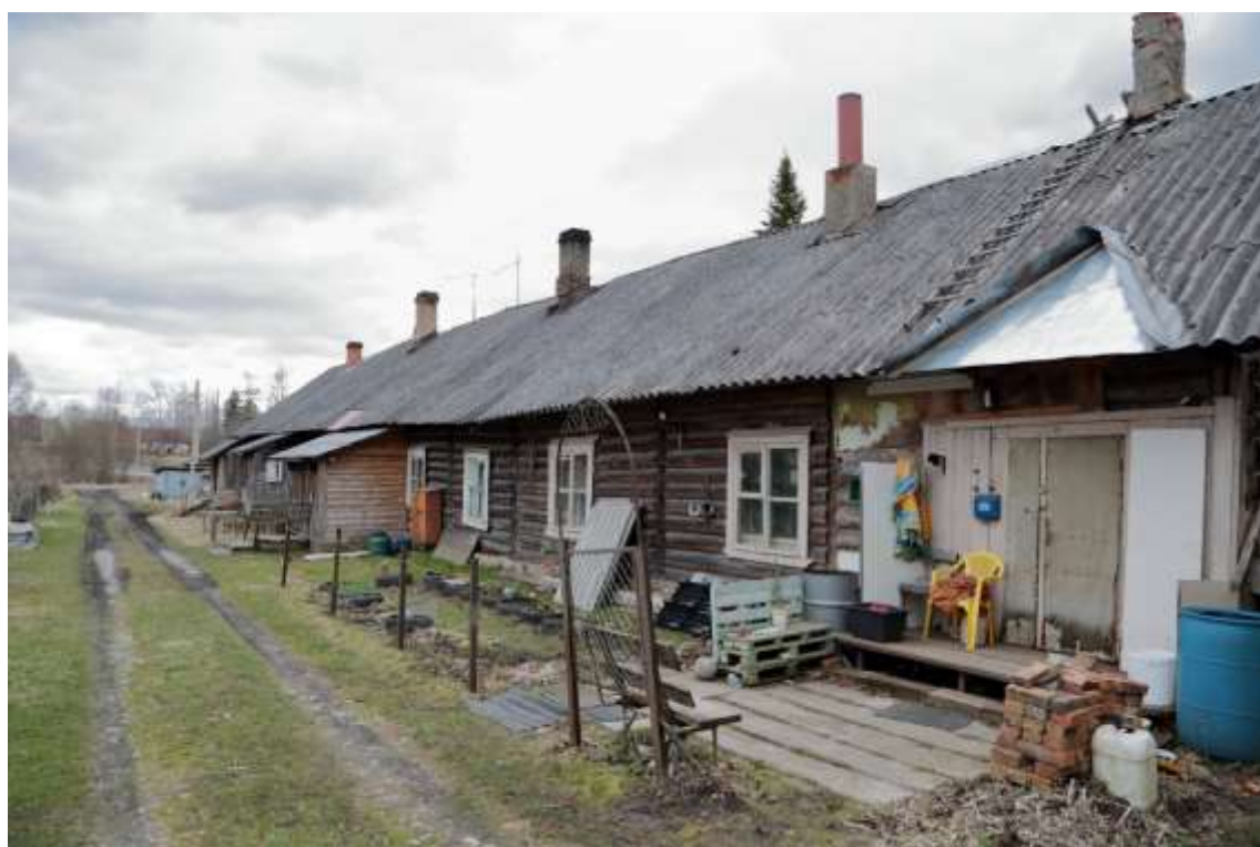
Фото 6. Наземная фотосъемка. Вдоль северо-восточного фасада.
