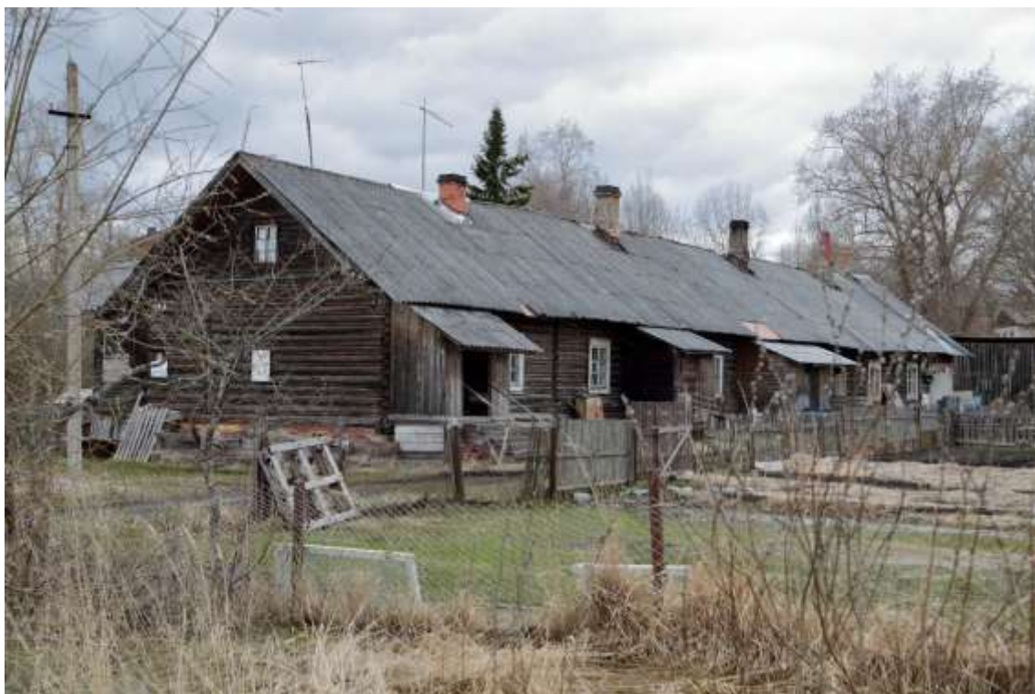
Фото 3. Наземная фотосъемка. Общий вид с востока
