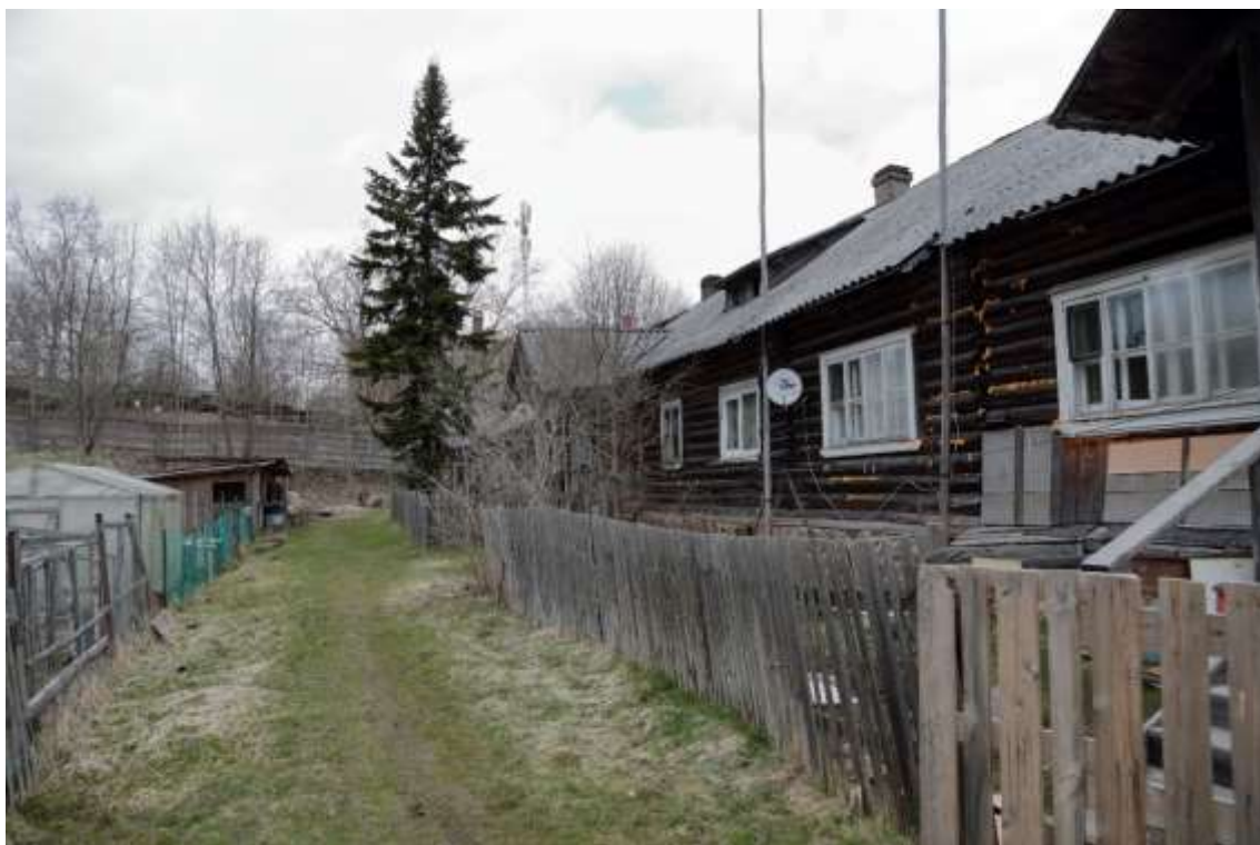
Фото 5. Наземная фотосъемка. Вдоль Юго-западного фасада.
