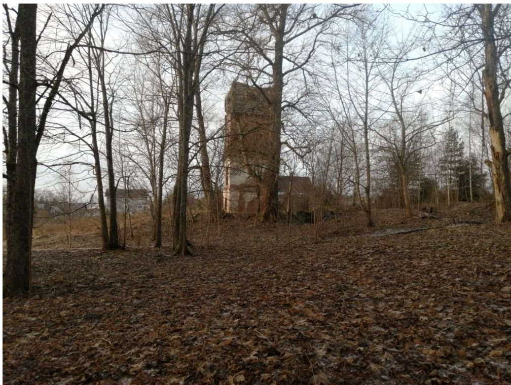
Фото 7. Вид на водонапорную башню.
