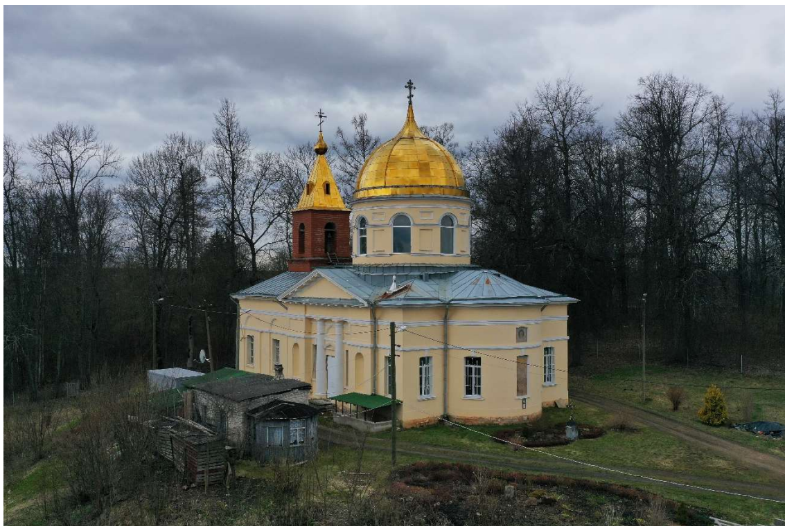
Фото 3. Наземная фотосъемка. Общий вид с юго-востока. Основной объем завершен золоченым куполом на высоком барабане
