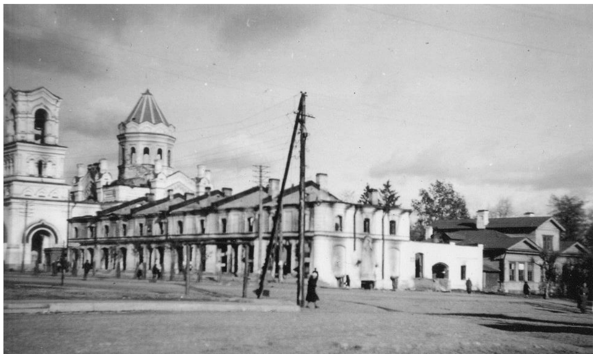
29. Базарный переулоч (сов. пер. Связи). Вид на собор, гостиный двор и приходскую школу. 1941-1943 гг. Автор неизвестен. Направление съемки северо-восток. // https://pastvu.com/p/504246
