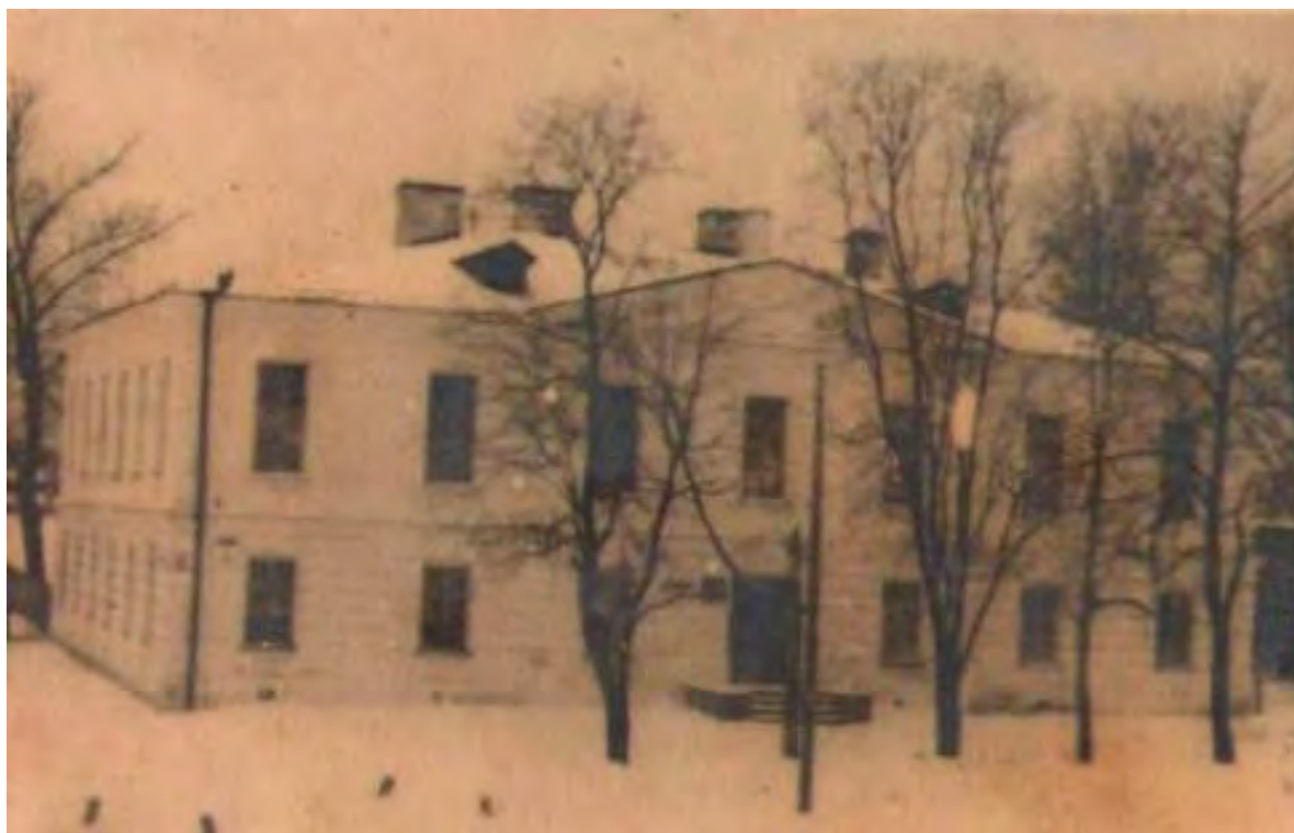
30. Лицевой фасад школы. 1949 год. Автор неизвестен. Направление съемки юг. // Инвентаризационное дело № 59 объекта культурного наследия регионального значения «Здание б. уездной школы», расположенного по Адреск: Ленинградская область, Лужский район г. Луга, пер. Связи, 2. НПиПО «СОЮЗСТРОЙРЕСТАВРАЦИЯ», СПб, 2019г.
