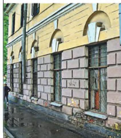
Решение парадной входной группы с помощью неглубокого ризалита шириной на три оси в уровне первого этажа и утопленная часть фасада в этих же осях в уровне второго этажа.
