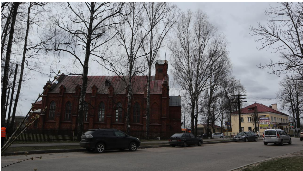
4. Объект культурного наследия регионального значения «Польский костел», расположенный по адресу: г. Луга, пр. Урицкого, 44. Вид на здание с ул. Ленинградской.
