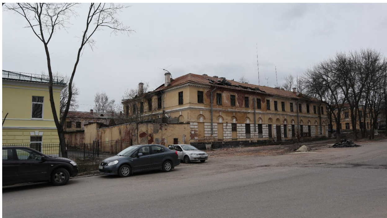
Илл. 2. Вид на лицевой и торцевой фасады здания присутственных мест, направление съемки – юго-запад. Объект культурного наследия регионального значения «Здание бывших присутственных мест», расположенный по адресу: г. Луга, пр. Володарского, 2.
