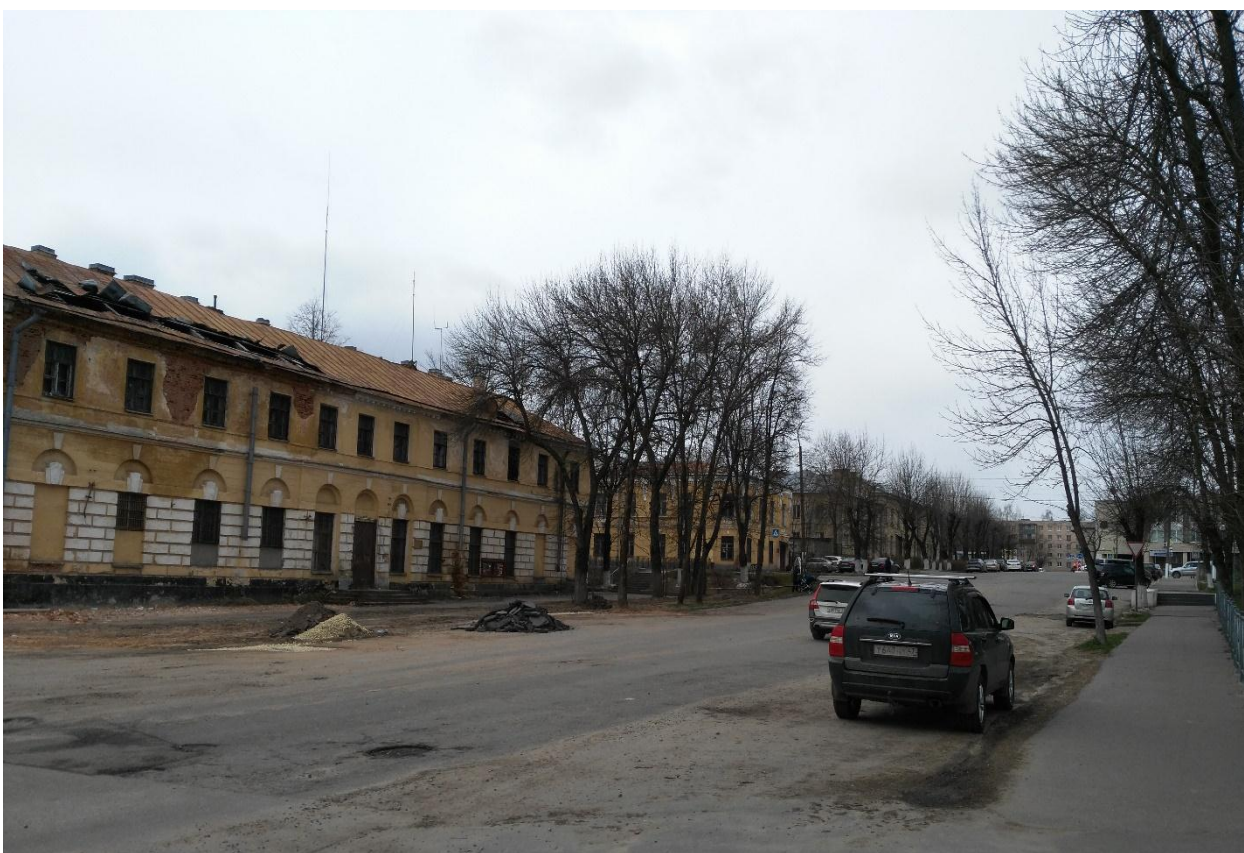
Илл. 12. Общий вид на здание бывших присутственных мест вдоль ул. Набережная, направление съемки – запад. Объект культурного наследия регионального значения «Здание бывших присутственных мест», расположенный по адресу: г. Луга, пр. Володарского, 2.
