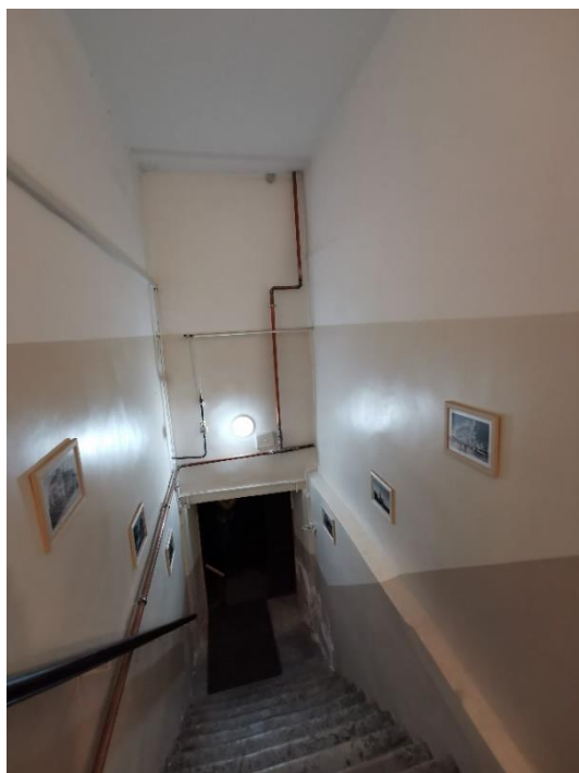
65. «Жилой дом», г. Выборг, ул. Крепостная, д.8. Подъезд №4. Фрагмент. Фото 25.05.2021г.
