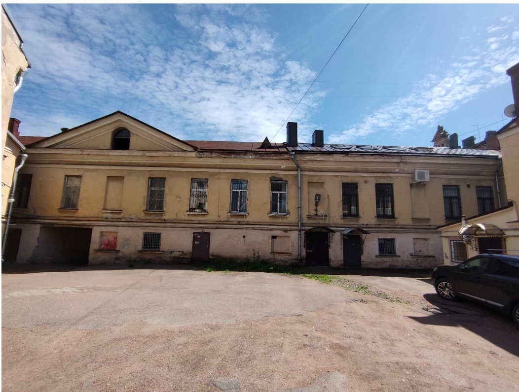
4. «Жилой дом», г. Выборг, ул. Крепостная, д.8. Северо-западный фасад. Общий вид. Фото 25.05.2021г.
