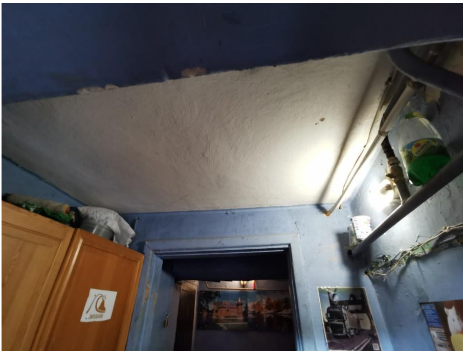
56. «Жилой дом», г. Выборг, ул. Крепостная, д.8. Подъезд №2. Фрагмент. Фото 25.05.2021г.
