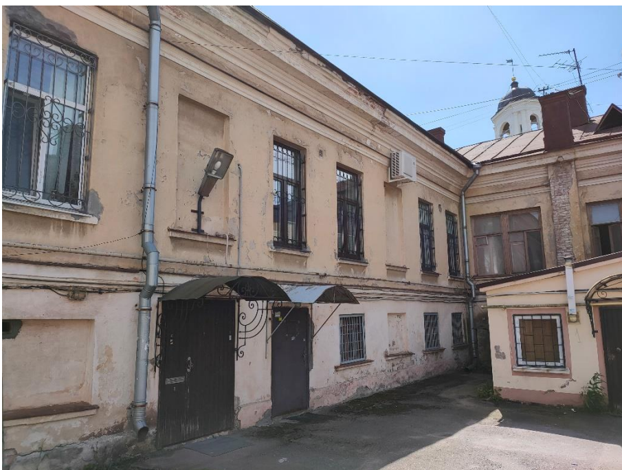
29. «Жилой дом», г. Выборг, ул. Крепостная, д.8. Северо-западный фасад. Фрагмент. Фото 25.05.2021г.
