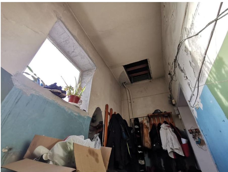
57. «Жилой дом», г. Выборг, ул. Крепостная, д.8. Подъезд №3. Фрагмент. Фото 25.05.2021г.
