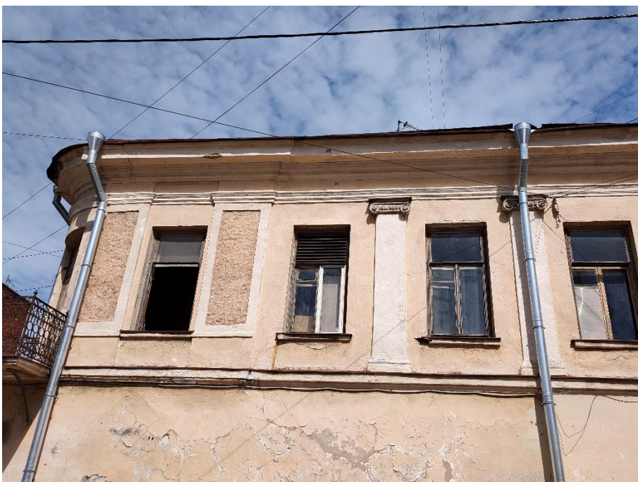
9. «Жилой дом», г. Выборг, ул. Крепостная, д.8. Юго-западный фасад. Фрагмент. Фото 25.05.2021г.
