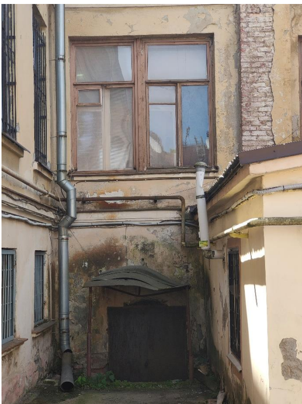
31. «Жилой дом», г. Выборг, ул. Крепостная, д.8. Северо-западный фасад. Фрагмент. Фото 25.05.2021г.
