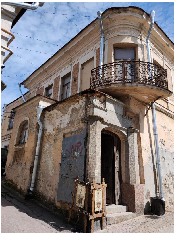
18. «Жилой дом», г. Выборг, ул. Крепостная, д.8. Юго-западный фасад. Фрагмент. Фото 25.05.2021г.
