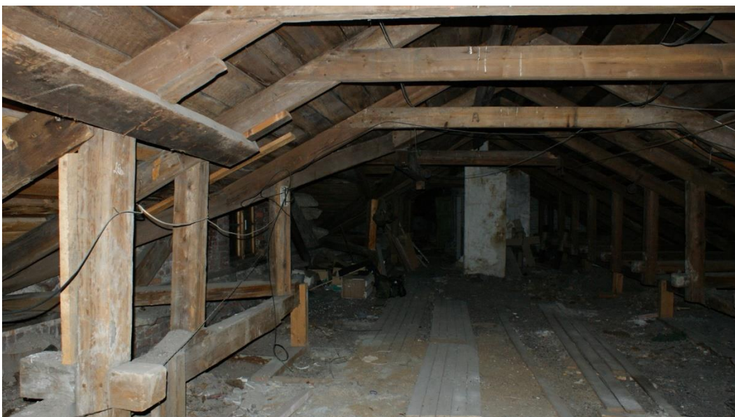
74. «Жилой дом», г. Выборг, ул. Крепостная, д.8. Кровля. Общий вид. Фото 25.05.2021г.
