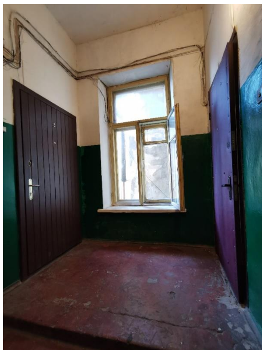
49. «Жилой дом», г. Выборг, ул. Крепостная, д.8. Подъезд №1. Общий вид. Фото 25.05.2021г.
