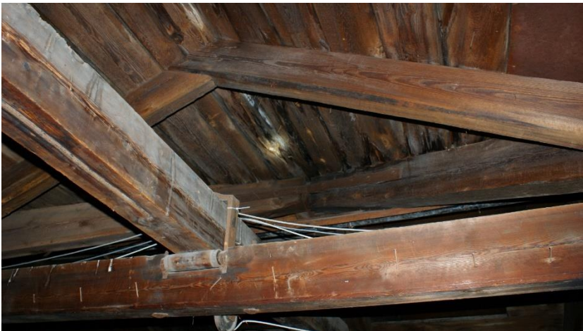
78. «Жилой дом», г. Выборг, ул. Крепостная, д.8. Кровля. Фрагмент. Фото 25.05.2021г.
