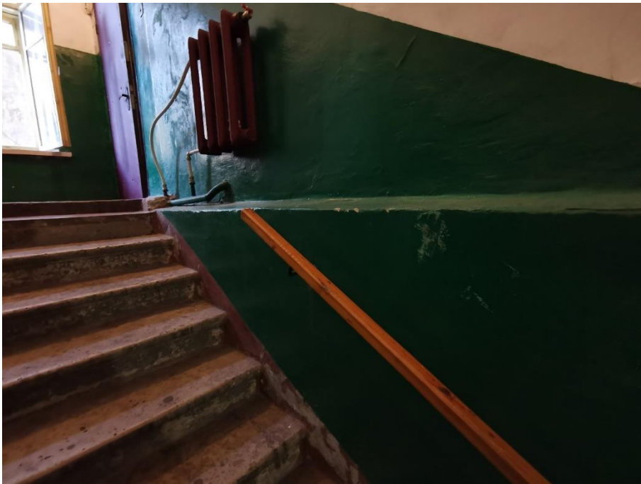
51. «Жилой дом», г. Выборг, ул. Крепостная, д.8. Подъезд №1. Фрагмент. Фото 25.05.2021г.
