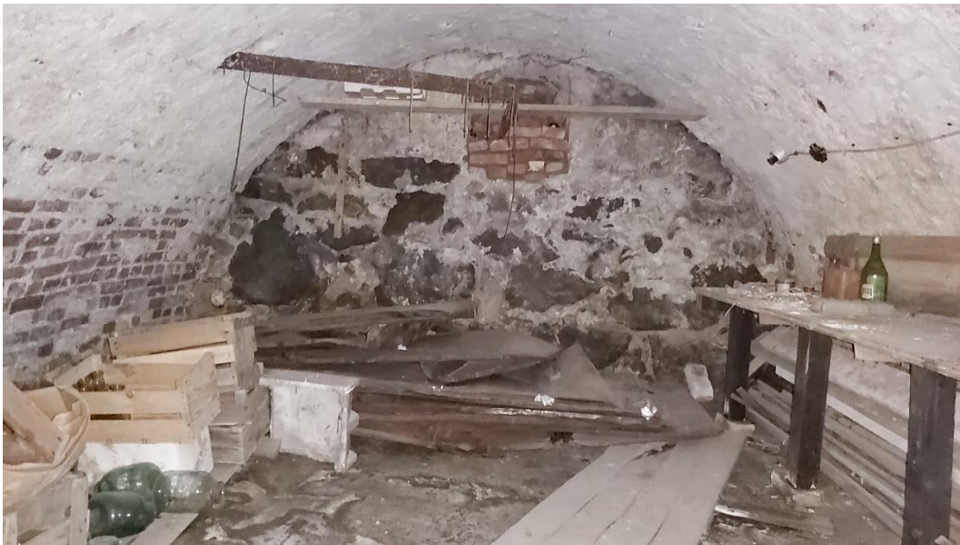
70. «Жилой дом», г. Выборг, ул. Крепостная, д.8. Подвал. Общий вид. Фото 25.05.2021г.
