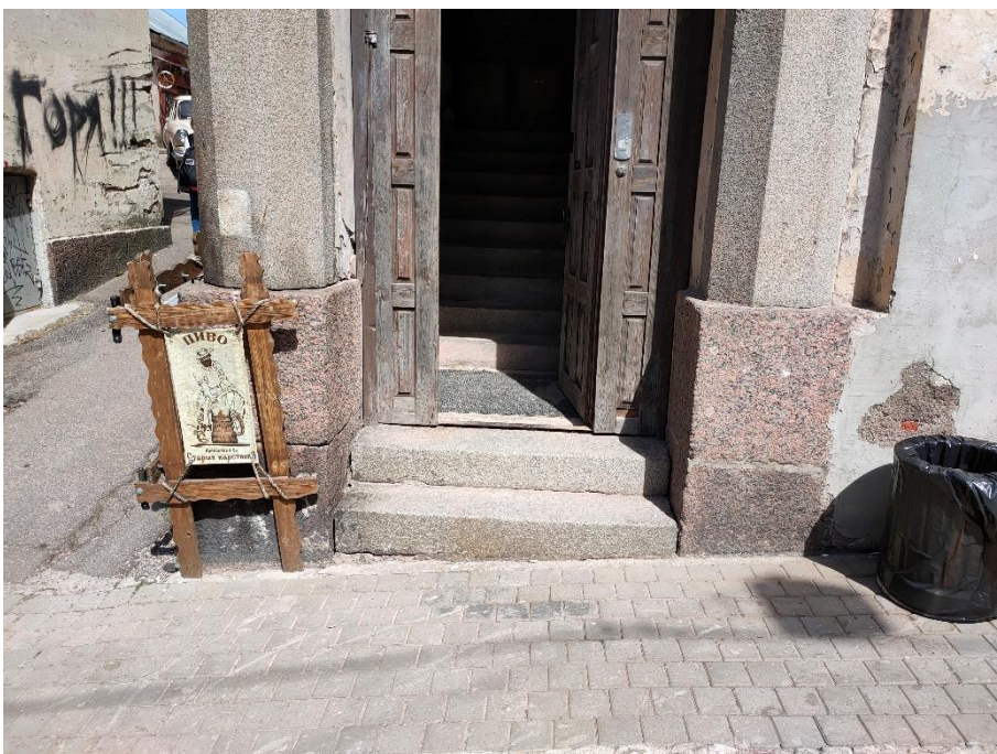
16. «Жилой дом», г. Выборг, ул. Крепостная, д.8. Юго-западный фасад. Фрагмент. Фото 25.05.2021г.
