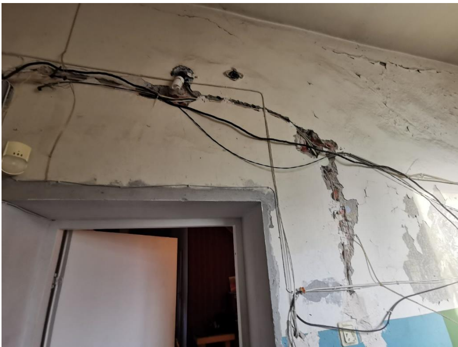
61. «Жилой дом», г. Выборг, ул. Крепостная, д.8. Подъезд №3. Фрагмент. Фото 25.05.2021г.
