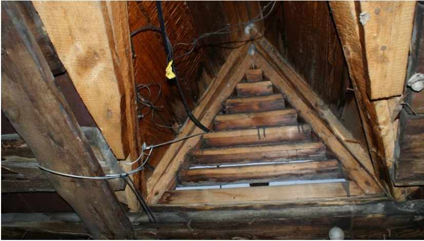
76. «Жилой дом», г. Выборг, ул. Крепостная, д.8. Кровля. Фрагмент. Фото 25.05.2021г.
