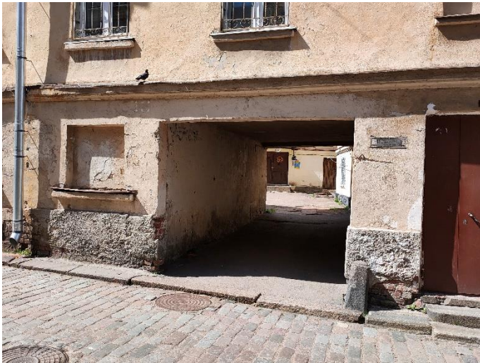
40. «Жилой дом», г. Выборг, ул. Крепостная, д.8. Юго-восточный фасад. Фрагмент. Фото 25.05.2021г.
