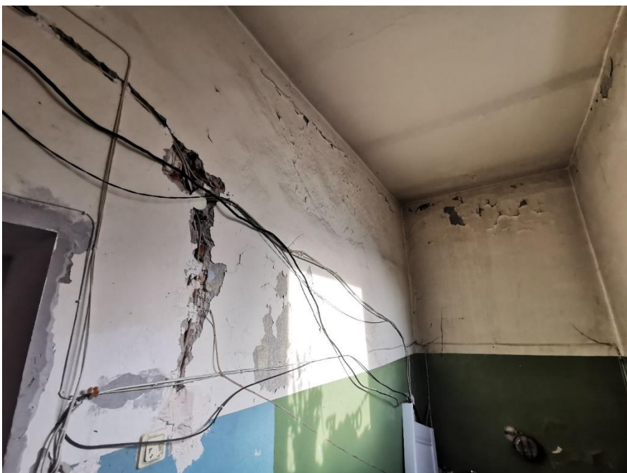
62. «Жилой дом», г. Выборг, ул. Крепостная, д.8. Подъезд №3. Фрагмент. Фото 25.05.2021г.
