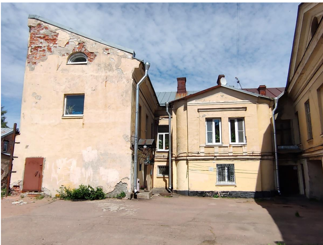
5. «Жилой дом», г. Выборг, ул. Крепостная, д.8. Северо-западный фасад. Общий вид. Фото 25.05.2021г.
