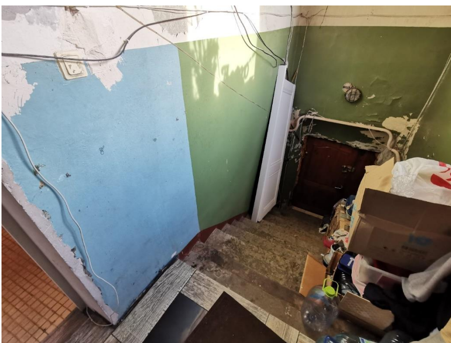
63. «Жилой дом», г. Выборг, ул. Крепостная, д.8. Подъезд №3. Фрагмент. Фото 25.05.2021г.
