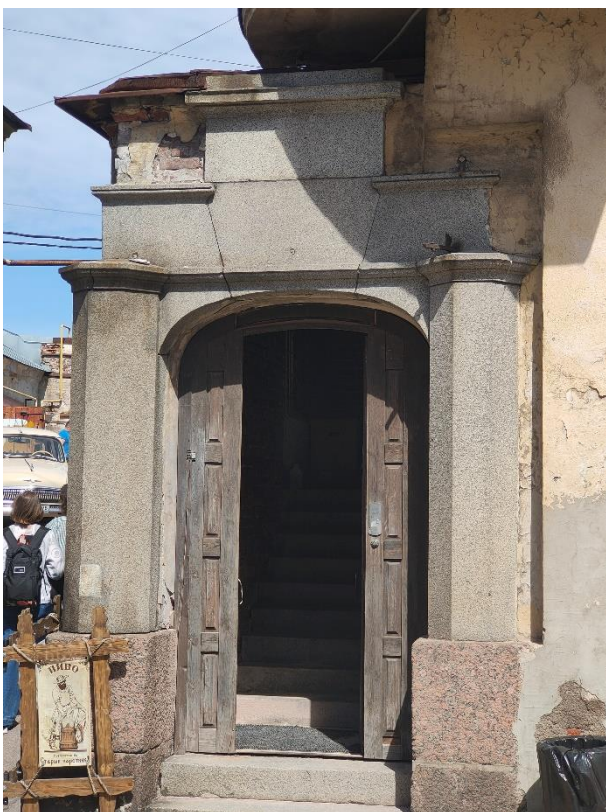
14. «Жилой дом», г. Выборг, ул. Крепостная, д.8. Юго-западный фасад. Фрагмент. Фото 25.05.2021г.
