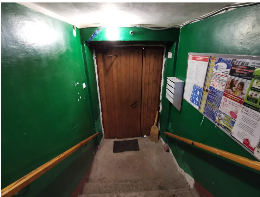
50. «Жилой дом», г. Выборг, ул. Крепостная, д.8. Подъезд №1. Фрагмент. Фото 25.05.2021г.
