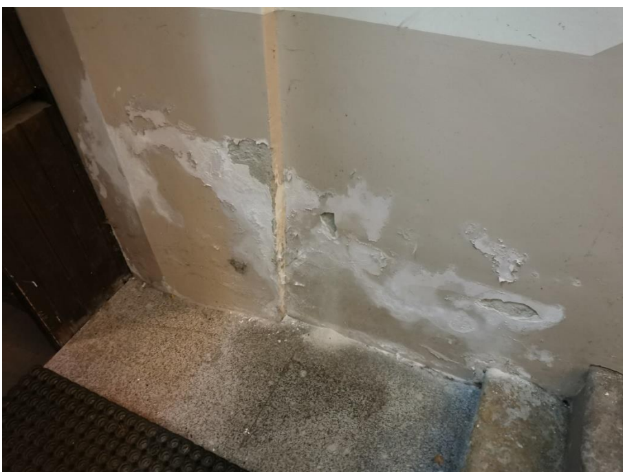
66. «Жилой дом», г. Выборг, ул. Крепостная, д.8. Подъезд №4. Фрагмент. Фото 25.05.2021г.
