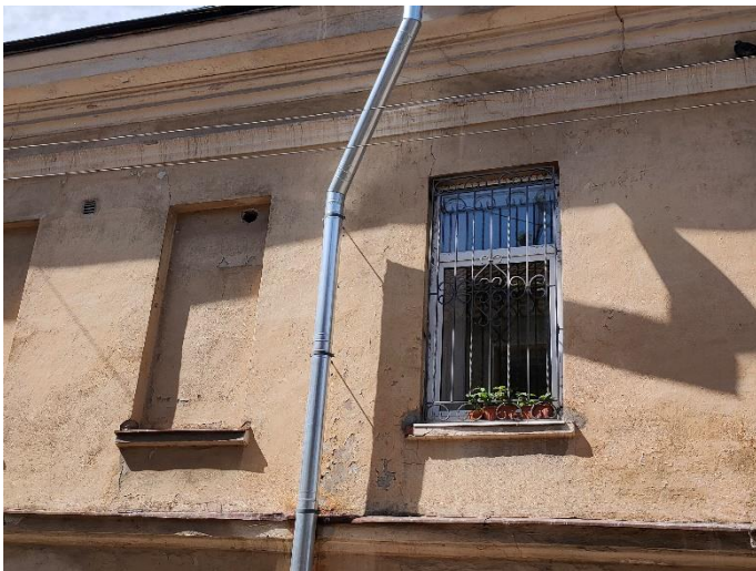
43. «Жилой дом», г. Выборг, ул. Крепостная, д.8. Юго-восточный фасад. Фрагмент. Фото 25.05.2021г.
