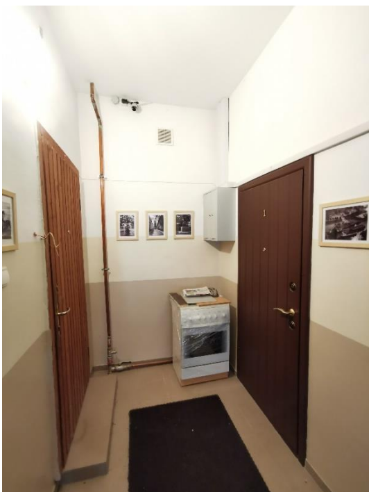
67. «Жилой дом», г. Выборг, ул. Крепостная, д.8. Подъезд №4. Фрагмент. Фото 25.05.2021г.
