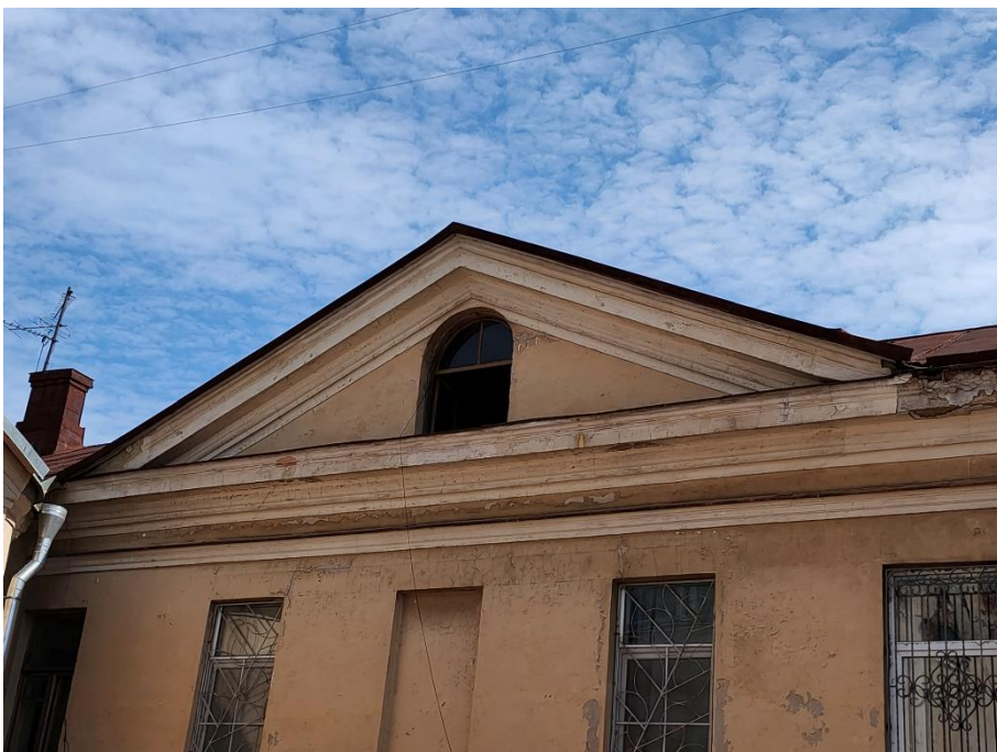
32. «Жилой дом», г. Выборг, ул. Крепостная, д.8. Северо-западный фасад. Фрагмент. Фото 25.05.2021г.
