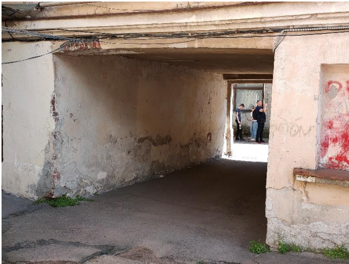
34. «Жилой дом», г. Выборг, ул. Крепостная, д.8. Северо-западный фасад. Фрагмент. Фото 25.05.2021г.
