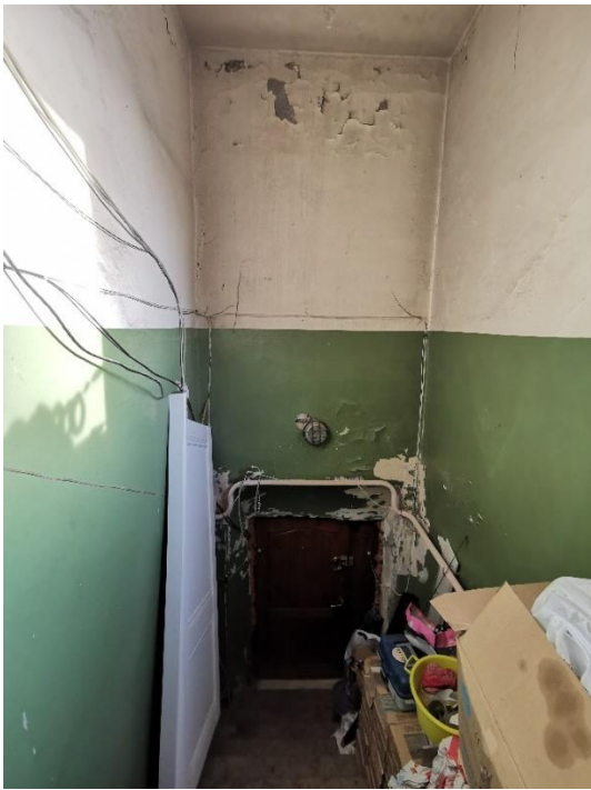
59. «Жилой дом», г. Выборг, ул. Крепостная, д.8. Подъезд №3. Фрагмент. Фото 25.05.2021г.
