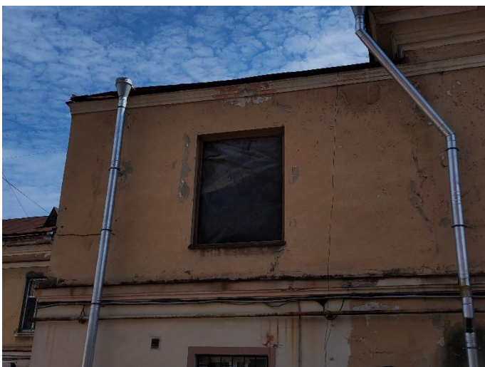
27. «Жилой дом», г. Выборг, ул. Крепостная, д.8. Северо-западный фасад. Фрагмент. Фото 25.05.2021г.
