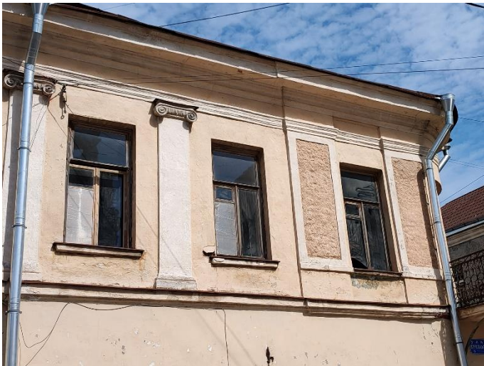
11. «Жилой дом», г. Выборг, ул. Крепостная, д.8. Юго-западный фасад. Фрагмент. Фото 25.05.2021г.
