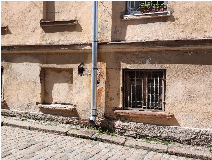
42. «Жилой дом», г. Выборг, ул. Крепостная, д.8. Юго-восточный фасад. Фрагмент. Фото 25.05.2021г.
