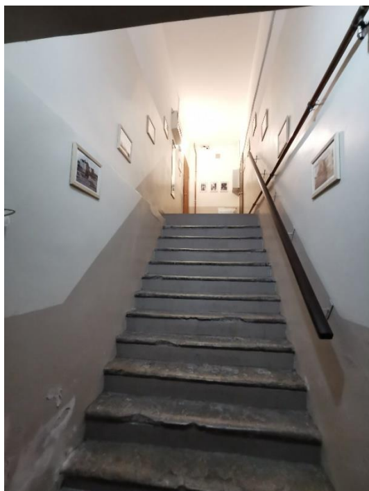
68. «Жилой дом», г. Выборг, ул. Крепостная, д.8. Подъезд №4. Фрагмент. Фото 25.05.2021г.
