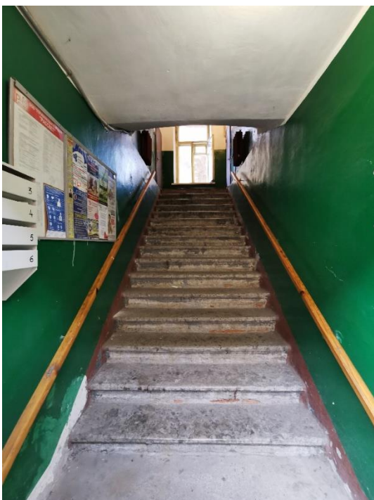
48. «Жилой дом», г. Выборг, ул. Крепостная, д.8. Подъезд №1. Общий вид. Фото 25.05.2021г.
