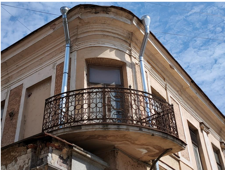
19. «Жилой дом», г. Выборг, ул. Крепостная, д.8. Юго-западный фасад. Фрагмент. Фото 25.05.2021г.
