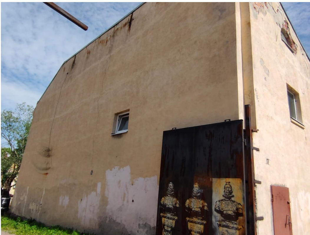
6. «Жилой дом», г. Выборг, ул. Крепостная, д.8. Северо-западный фасад. Общий вид. Фото 25.05.2021г.
