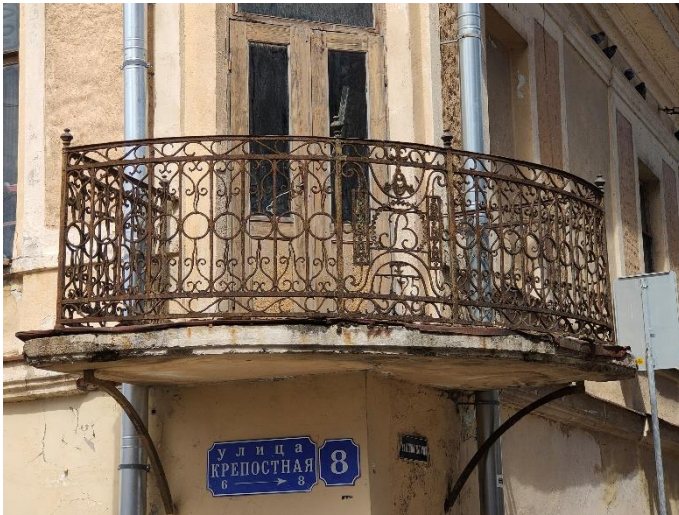
46. «Жилой дом», г. Выборг, ул. Крепостная, д.8. Юго-восточный фасад. Фрагмент. Фото 25.05.2021г.
