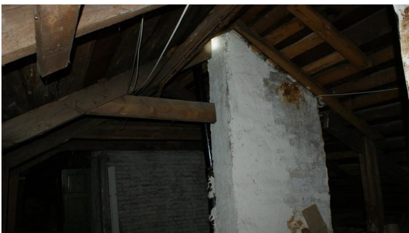
80. «Жилой дом», г. Выборг, ул. Крепостная, д.8. Кровля. Фрагмент. Фото 25.05.2021г.
