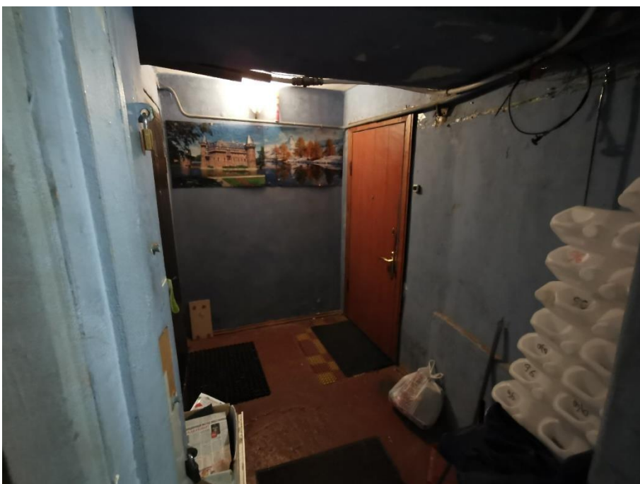
54. «Жилой дом», г. Выборг, ул. Крепостная, д.8. Подъезд №2. Общий вид. Фото 25.05.2021г.
