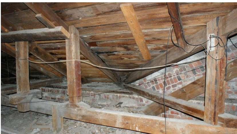
79. «Жилой дом», г. Выборг, ул. Крепостная, д.8. Кровля. Фрагмент. Фото 25.05.2021г.
