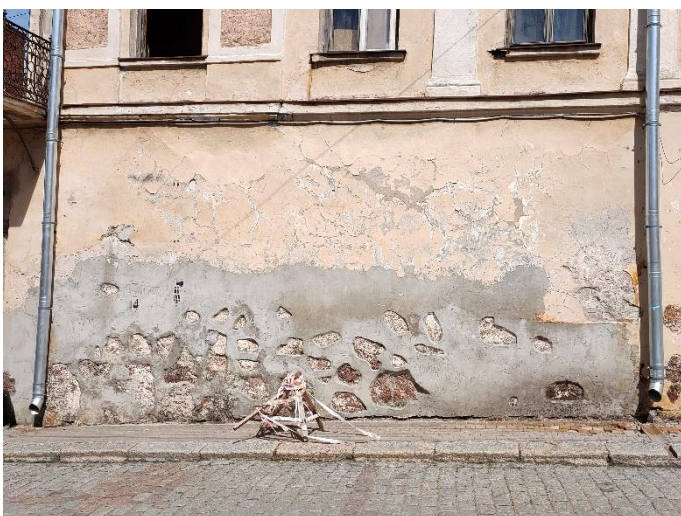
13. «Жилой дом», г. Выборг, ул. Крепостная, д.8. Юго-западный фасад. Фрагмент. Фото 25.05.2021г.
