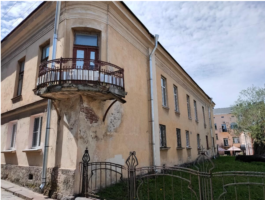
7. «Жилой дом», г. Выборг, ул. Крепостная, д.8. Северо-восточный фасад. Общий вид. Фото 25.05.2021г.
