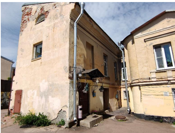
36. «Жилой дом», г. Выборг, ул. Крепостная, д.8. Северо-западный фасад. Фрагмент. Фото 25.05.2021г.
