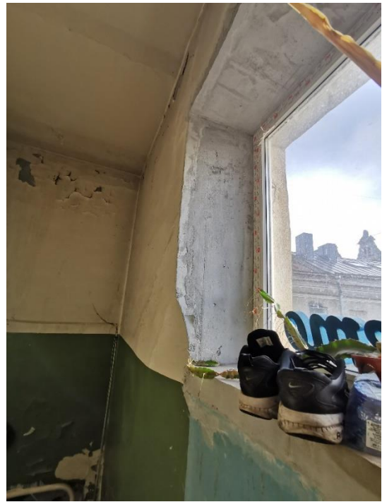
60. «Жилой дом», г. Выборг, ул. Крепостная, д.8. Подъезд №3. Фрагмент. Фото 25.05.2021г.
