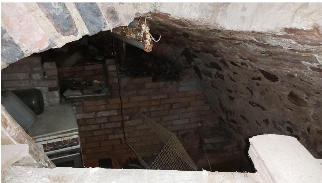
72. «Жилой дом», г. Выборг, ул. Крепостная, д.8. Подвал. Фрагмент. Фото 25.05.2021г.
