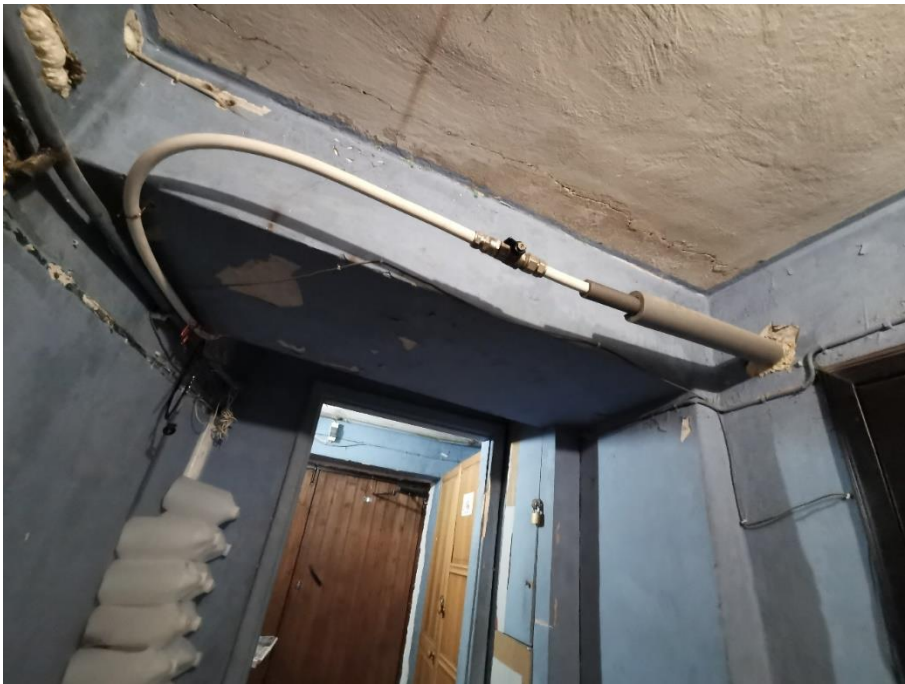
55. «Жилой дом», г. Выборг, ул. Крепостная, д.8. Подъезд №2. Фрагмент. Фото 25.05.2021г.
