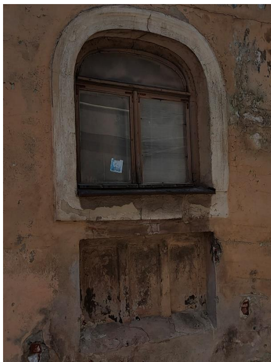
24. «Жилой дом», г. Выборг, ул. Крепостная, д.8. Северо-западный фасад. Фрагмент. Фото 25.05.2021г.
