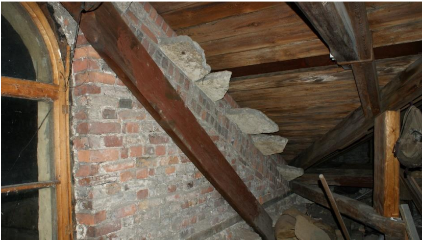
77. «Жилой дом», г. Выборг, ул. Крепостная, д.8. Кровля. Фрагмент. Фото 25.05.2021г.
