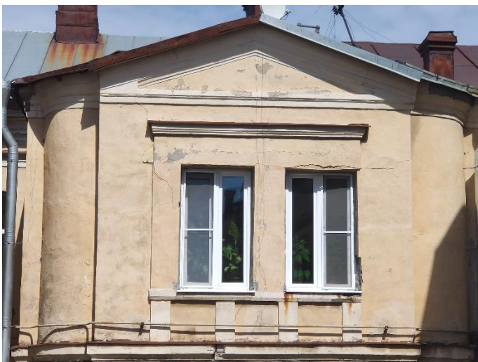
35. «Жилой дом», г. Выборг, ул. Крепостная, д.8. Северо-западный фасад. Фрагмент. Фото 25.05.2021г.
