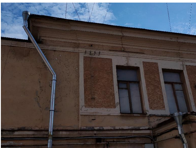
28. «Жилой дом», г. Выборг, ул. Крепостная, д.8. Северо-западный фасад. Фрагмент. Фото 25.05.2021г.
