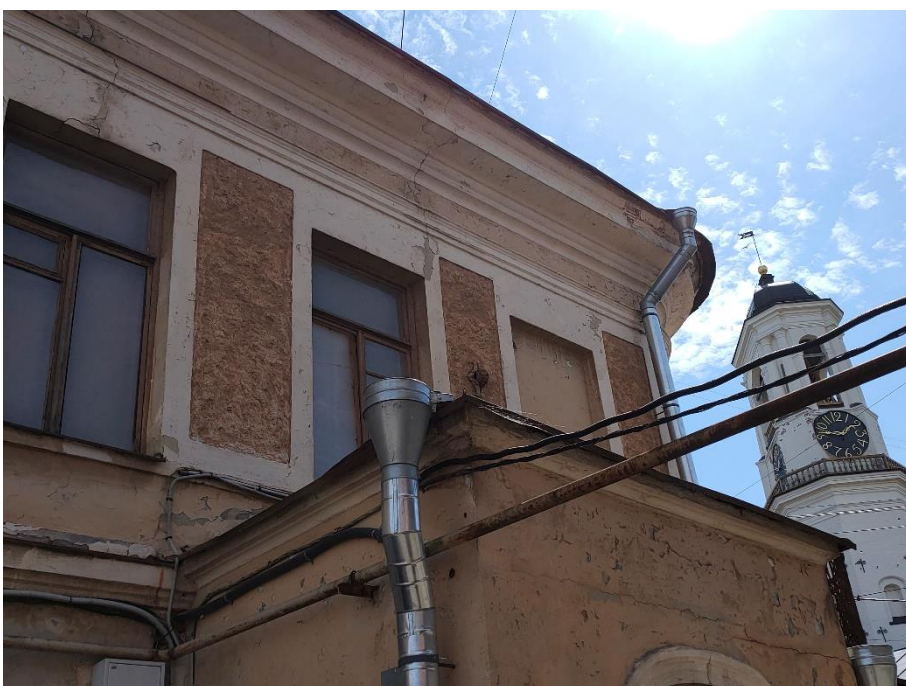
25. «Жилой дом», г. Выборг, ул. Крепостная, д.8. Северо-западный фасад. Фрагмент. Фото 25.05.2021г.
