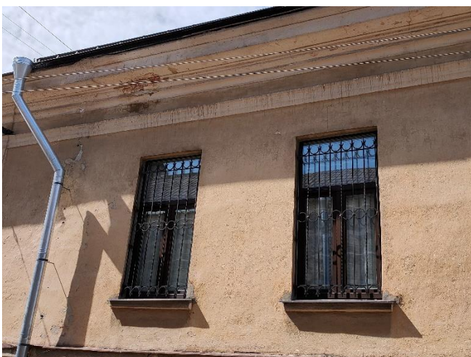
44. «Жилой дом», г. Выборг, ул. Крепостная, д.8. Юго-восточный фасад. Фрагмент. Фото 25.05.2021г.
