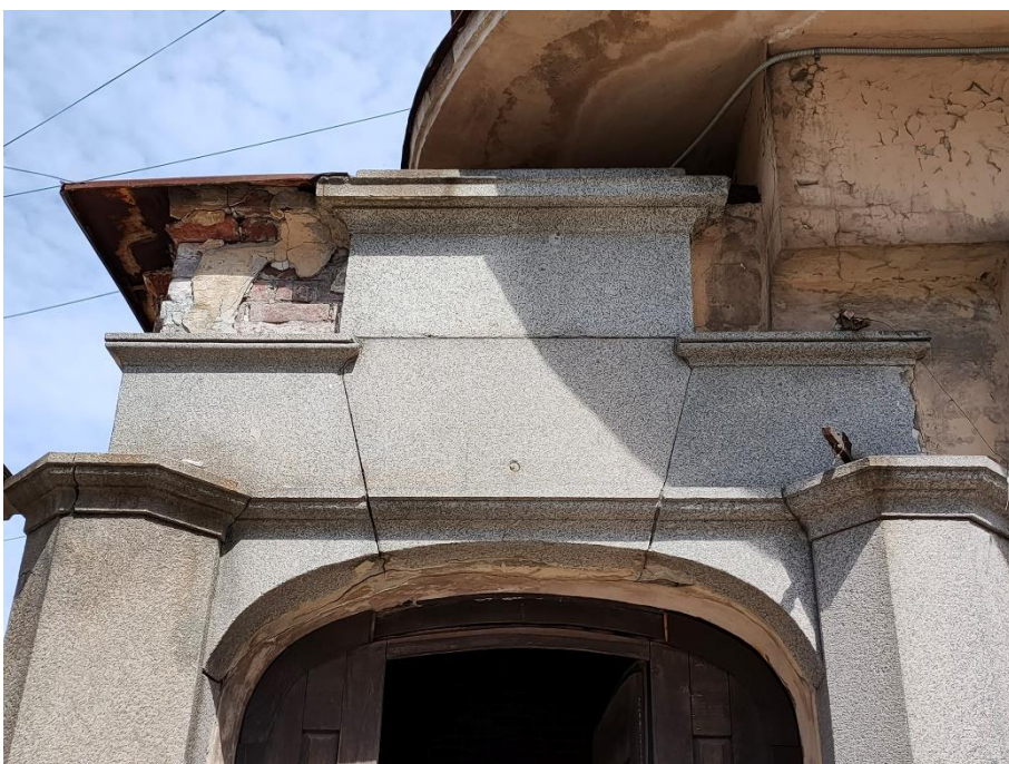
15. «Жилой дом», г. Выборг, ул. Крепостная, д.8. Юго-западный фасад. Фрагмент. Фото 25.05.2021г.
