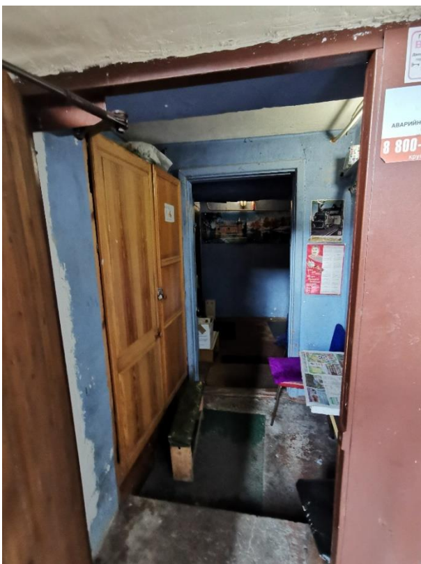
53. «Жилой дом», г. Выборг, ул. Крепостная, д.8. Подъезд №2. Общий вид. Фото 25.05.2021г.
