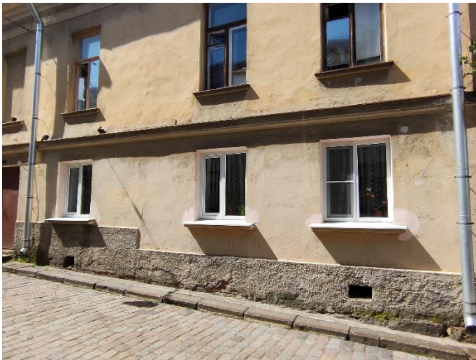
39. «Жилой дом», г. Выборг, ул. Крепостная, д.8. Юго-восточный фасад. Фрагмент. Фото 25.05.2021г.
