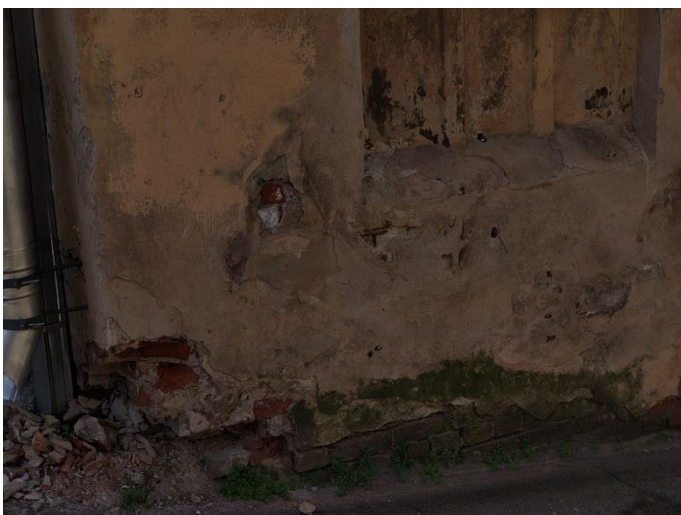
26. «Жилой дом», г. Выборг, ул. Крепостная, д.8. Северо-западный фасад. Фрагмент. Фото 25.05.2021г.
