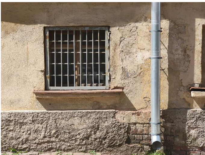
41. «Жилой дом», г. Выборг, ул. Крепостная, д.8. Юго-восточный фасад. Фрагмент. Фото 25.05.2021г.
