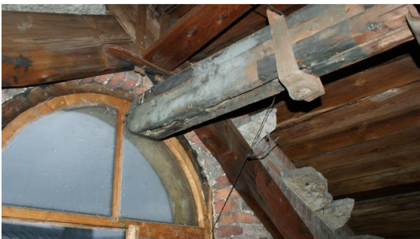
81. «Жилой дом», г. Выборг, ул. Крепостная, д.8. Кровля. Фрагмент. Фото 25.05.2021г.
