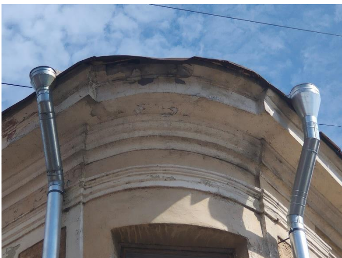
21. «Жилой дом», г. Выборг, ул. Крепостная, д.8. Юго-западный фасад. Фрагмент. Фото 25.05.2021г.
