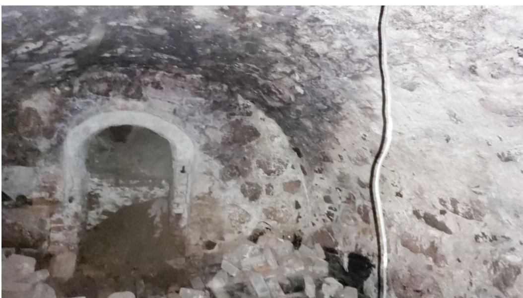
73. «Жилой дом», г. Выборг, ул. Крепостная, д.8. Подвал. Фрагмент. Фото 25.05.2021г.
